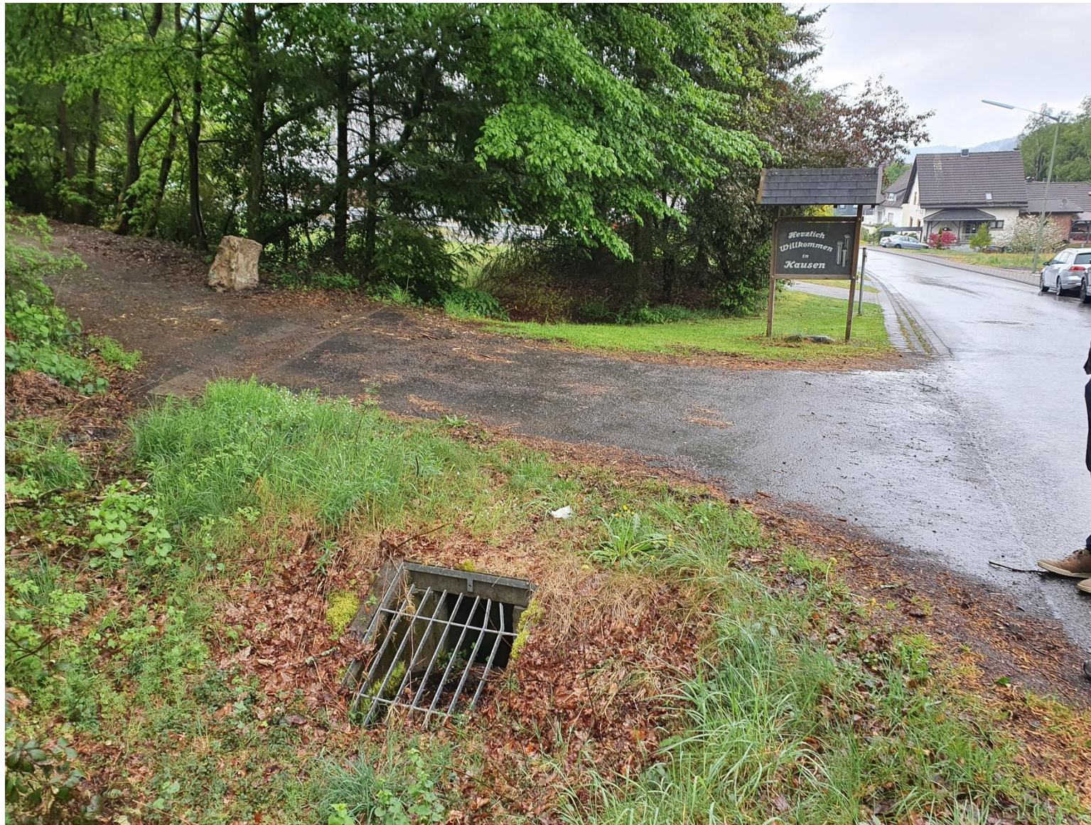
Basisanalyse: Ortsbegehung Kausen – östlicher Ortseingang Austraße/Abschlag im Weg aus Außengebiete/Einlauf Richtung Gewässer
