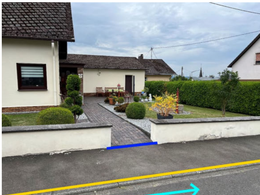
Abbildung 79: Notfließweg "Im Kochbrunnen" mit Fließrichtung (hellblau), Objektschutzmaßnahmen (blau) und Bordanlagen (gelb)
