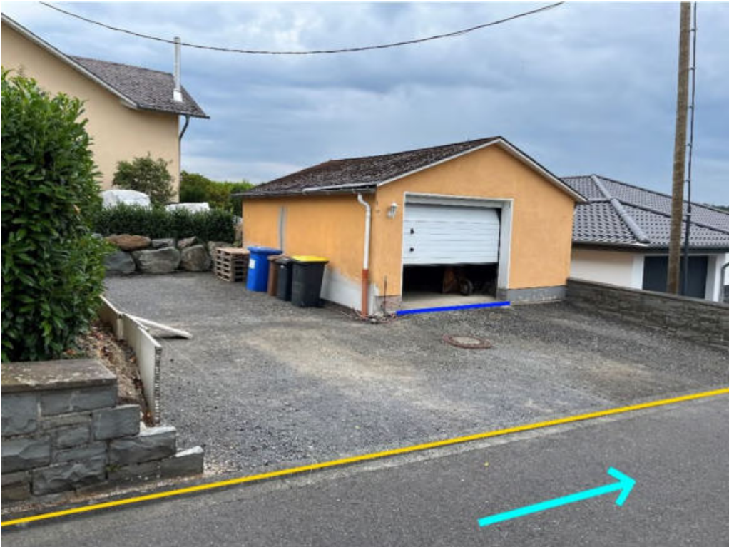
Abbildung 86: Notfließweg "Im Kochbrunnen" mit Fließrichtung (hellblau), Objektschutzmaßnahmen (blau) und Bordanlagen (gelb)
