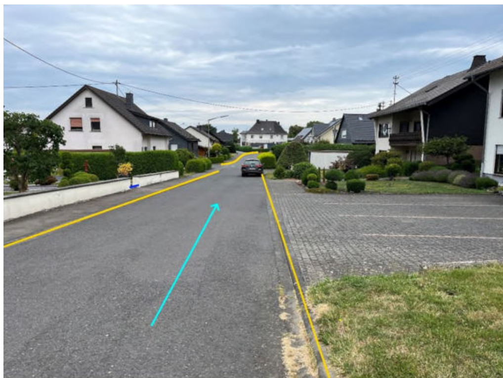
Abbildung 77: Notfließweg "Im Kochbrunnen" mit Fließrichtung (hellblau), Objektschutzmaßnahmen (blau) und Bordanlagen (gelb)
