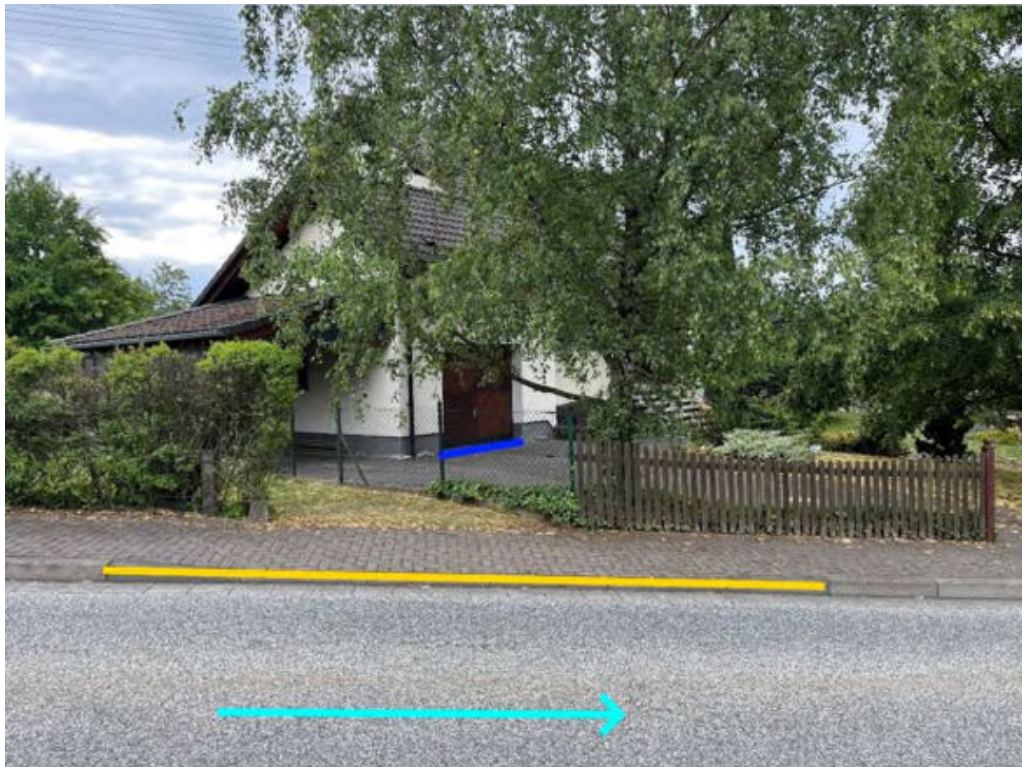
Abbildung 47: Notfließweg "Betzdorfer Straße" mit Fließrichtung (hellblau), Objektschutzmaßnahmen (blau) und Bordanlagen (gelb)
