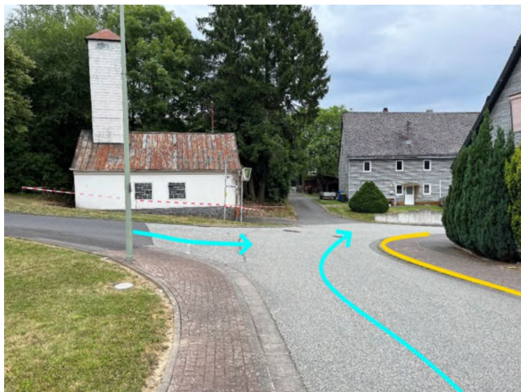
Abbildung 129: Notfließweg „Laystraße" mit Fließrichtung (hellblau), Bordanlagen (gelb) und Kreuzung mit „Im Kochbrunnen“
