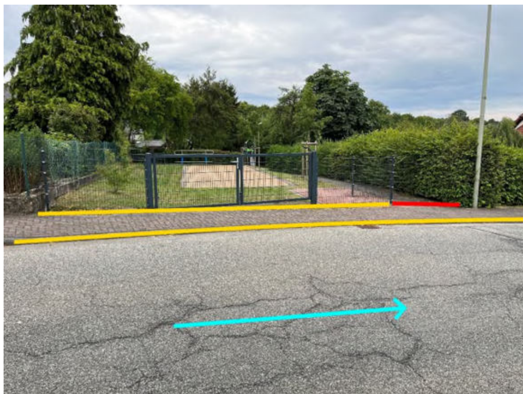
Abbildung 60: Notfließweg "Betzdorfer Straße" mit Fließrichtung (hellblau), mobiler Hochwasserschutz im Straßenraum (rot) und Bordanlagen (gelb)
