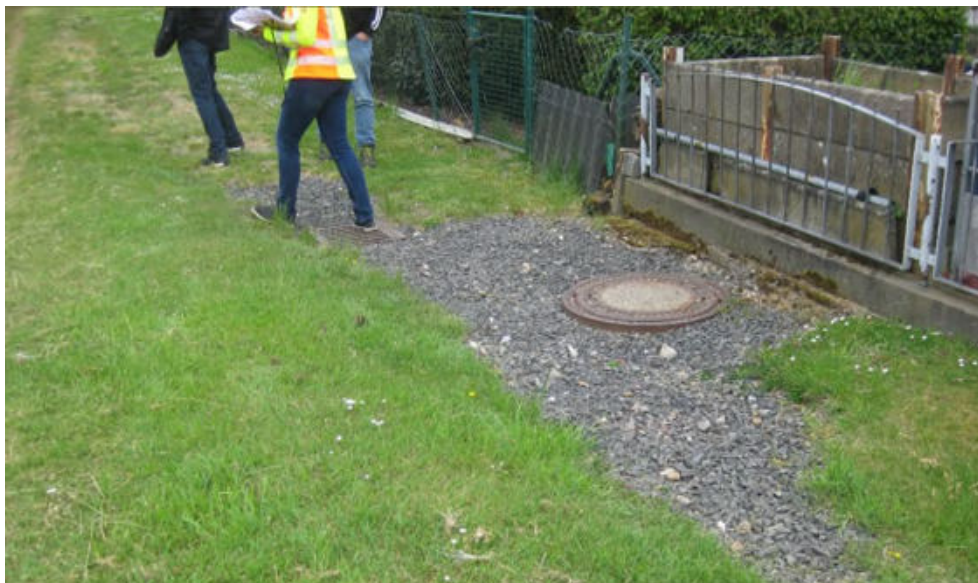
Abbildung 21: Rosenheim, Kanal nördlich „Im Kochbrunnen“: Gefahrenpunkt 5.9
