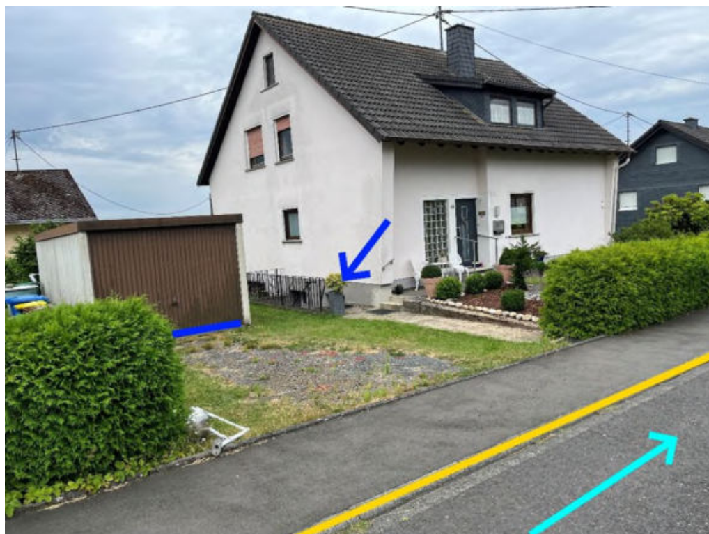
Abbildung 81: Notfließweg "Im Kochbrunnen" mit Fließrichtung (hellblau), Objektschutzmaßnahmen (blau) und Bordanlagen (gelb)
