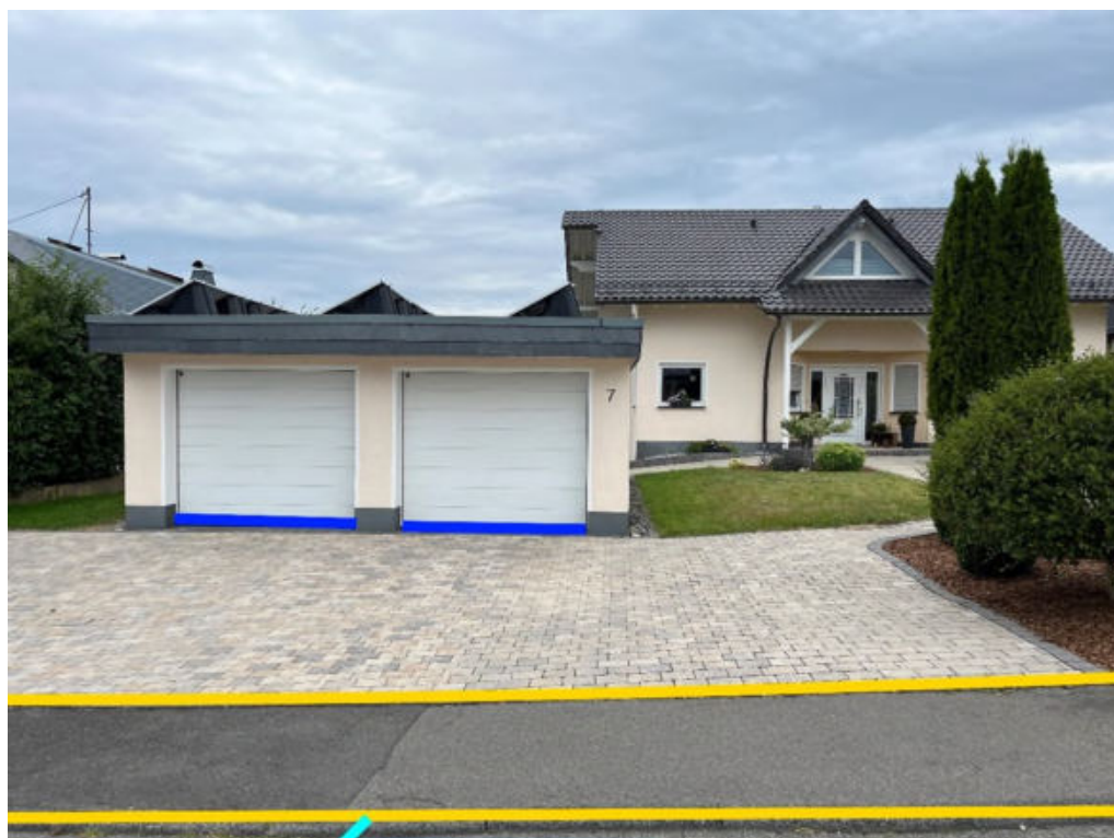
Abbildung 89: Notfließweg "Im Kochbrunnen" mit Fließrichtung (hellblau), Objektschutzmaßnahmen (blau) und Bordanlagen (gelb)
