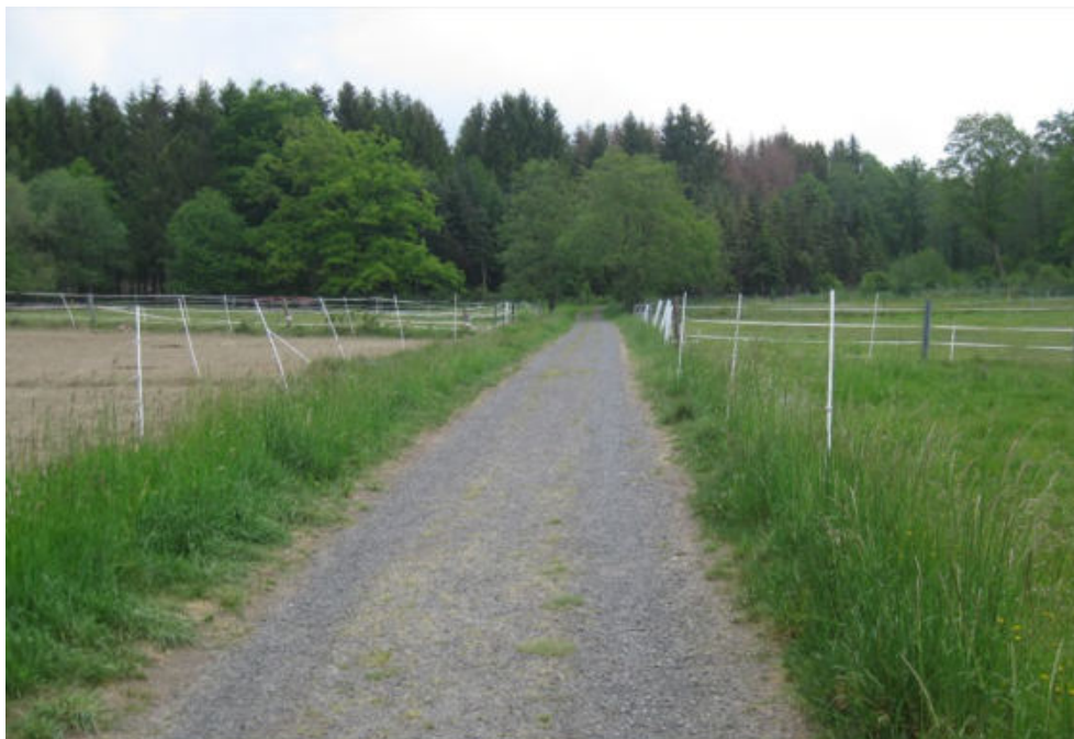
Abbildung 27: Rosenheim, nord-östliches Außengebiet „Im Acker“; Gefahrenpunkte 5.3 und 5.10
