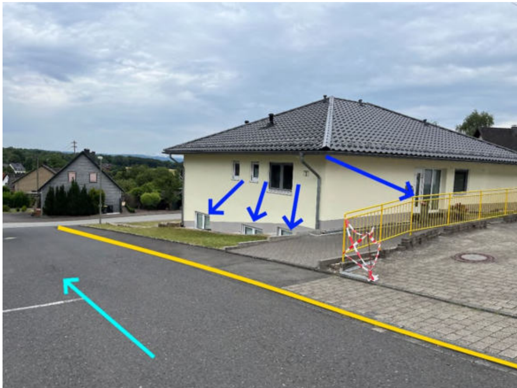
Abbildung 94: Notfließweg "Im Kochbrunnen" mit Fließrichtung (hellblau), Objektschutzmaßnahmen (blau) und Bordanlagen (gelb)
