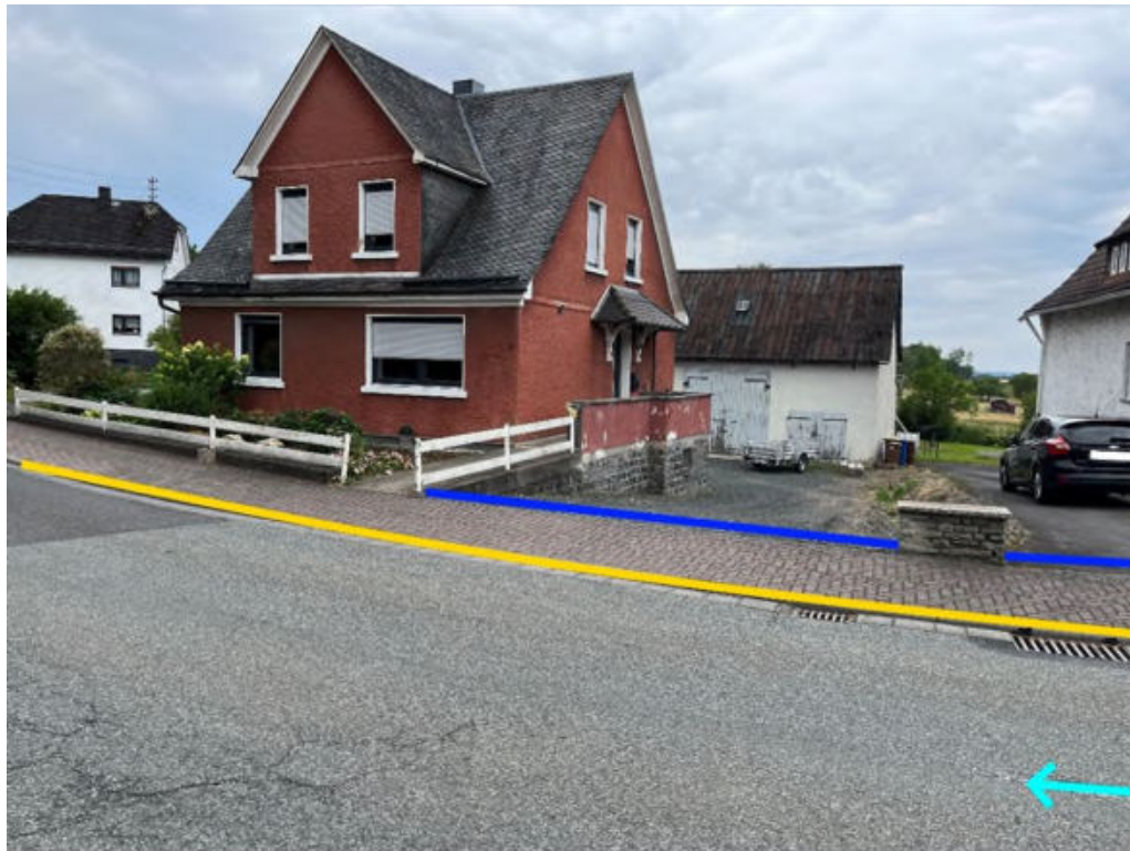
Abbildung 75: Notfließweg "Betzdorfer Straße" mit Fließrichtung (hellblau), Objektschutzmaßnahmen (blau) und Bordanlagen (gelb)
