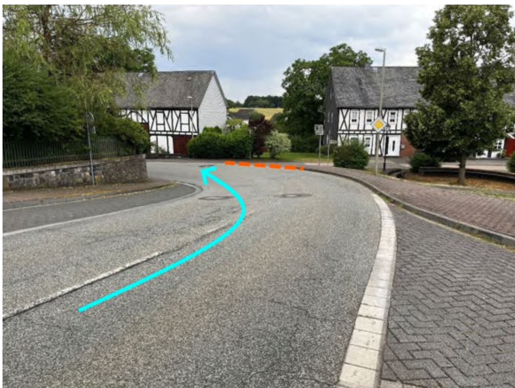
Abbildung 66: Notfließweg "Betzdorfer Straße" mit Fließrichtung (hellblau) und Aufwallung (orange)
