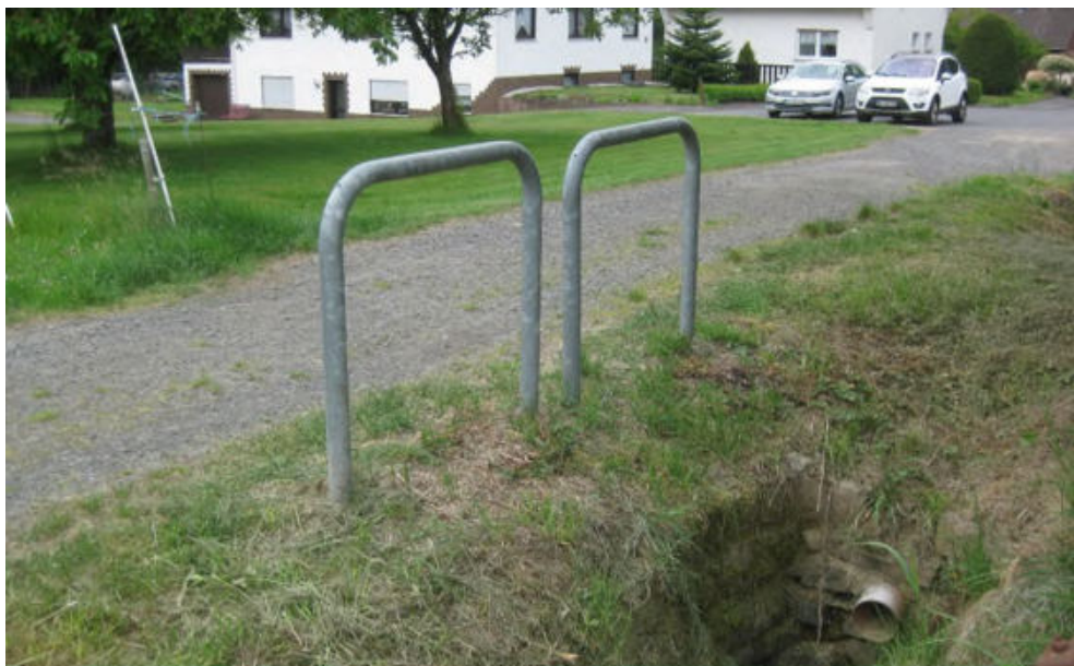
Abbildung 30: Rosenheim, nord-östliches Außengebiet/Bebauung „Im Acker“; Gefahrenpunkte 5.3 und 5.10
