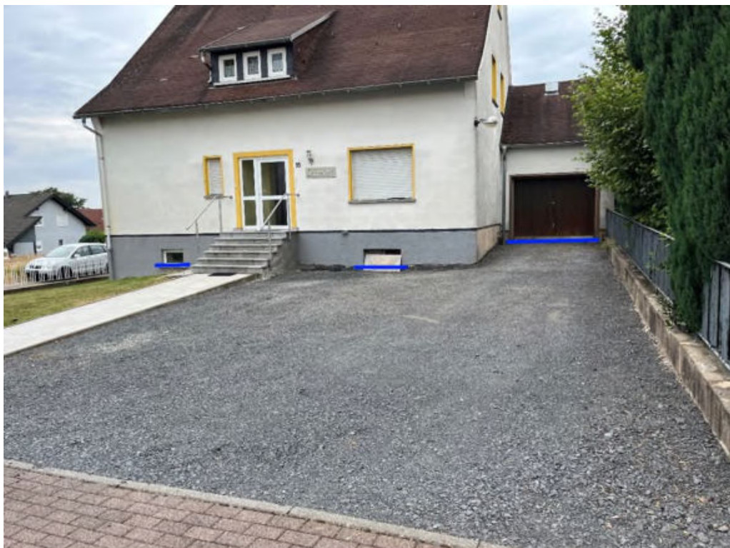
Abbildung 99: Notfließweg „Laystraße“ mit Objektschutzmaßnahmen (blau)
