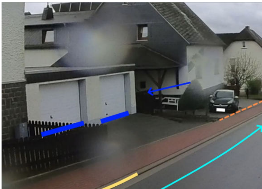
Abbildung 146: Notfließweg „Bergstraße“ mit Fließrichtung (hellblau) , Aufwallung (orange), Bordanlagen (gelb) und Objektschutzmaßnahmen (blau)
