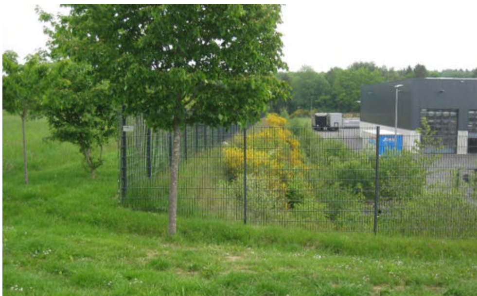
Abbildung 40: Rosenheim; RRB auf Gelände Fa. Hombach
