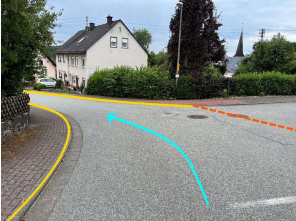
Abbildung 117: Notfließweg „Laystraße“ mit Fließrichtung (hellblau), Aufwallung (orange) und Bordanlagen (gelb)
