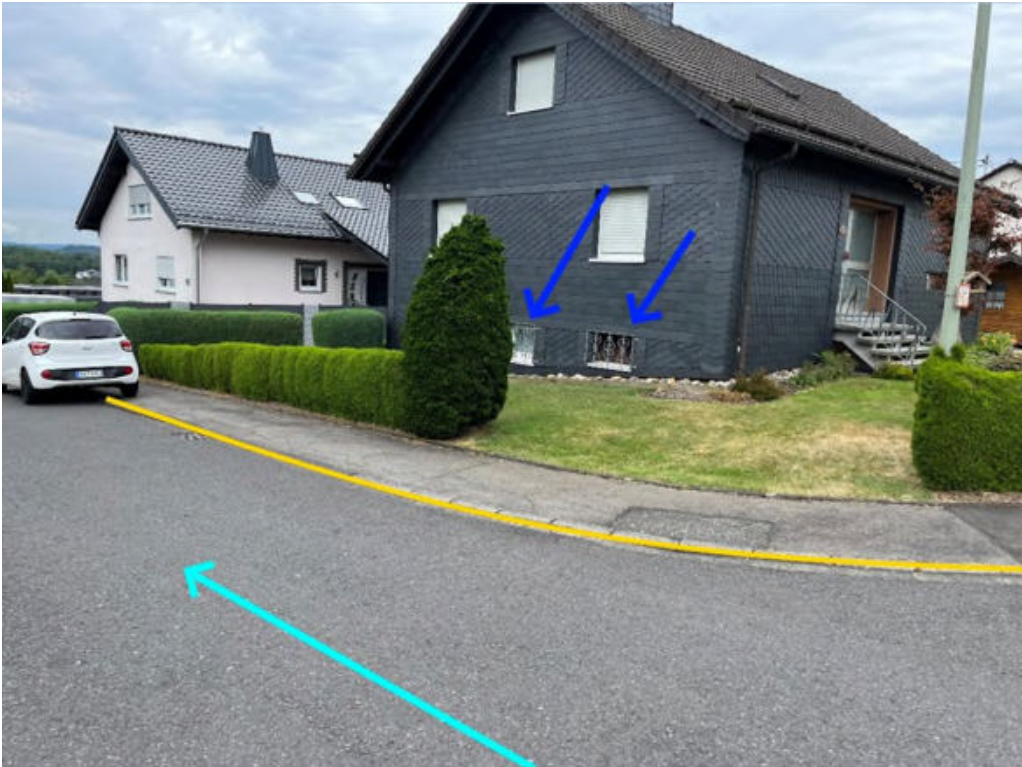
Abbildung 84: Notfließweg "Im Kochbrunnen" mit Fließrichtung (hellblau), Objektschutzmaßnahmen (blau) und Bordanlagen (gelb)
