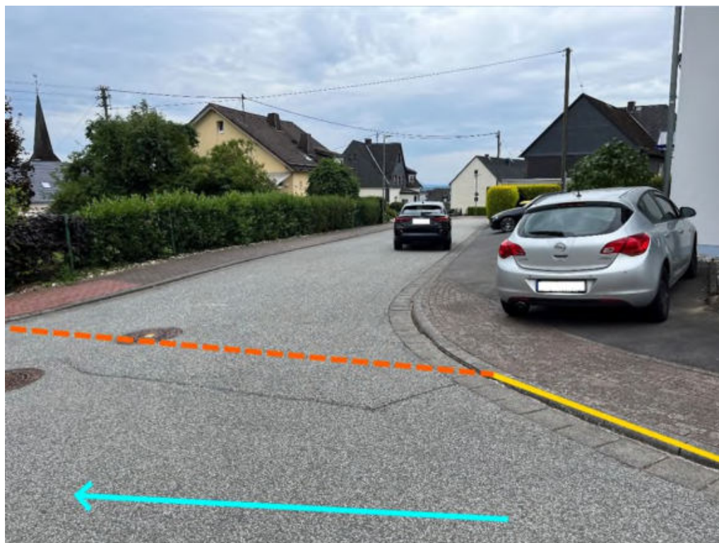
Abbildung 118: Notfließweg „Laystraße" mit Fließrichtung (hellblau), Aufwallung (orange) und Bordanlagen (gelb)
