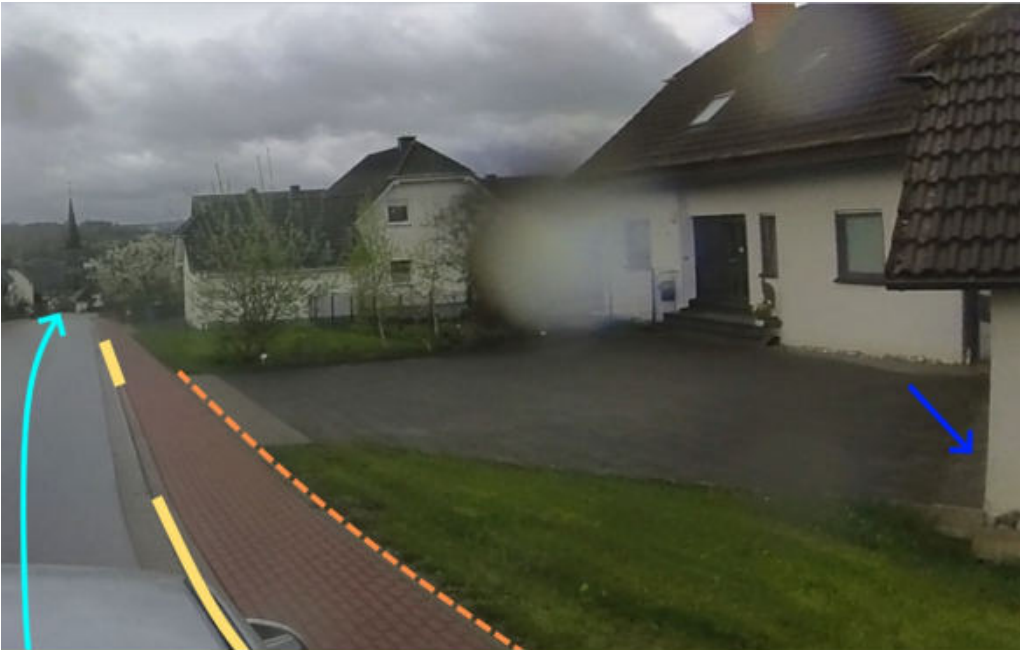
Abbildung 140: Notfließweg „Bergstraße“ mit Fließrichtung (hellblau), Aufwallung (orange), Objektschutzmaßnahmen (blau) und Bordanlagen (gelb)
