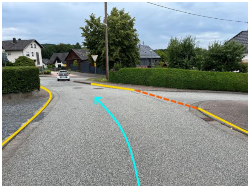
Abbildung 133: Notfließweg „Laystraße“ mit Fließrichtung (hellblau), Aufwallung (orange) und Bordanlagen (gelb)
