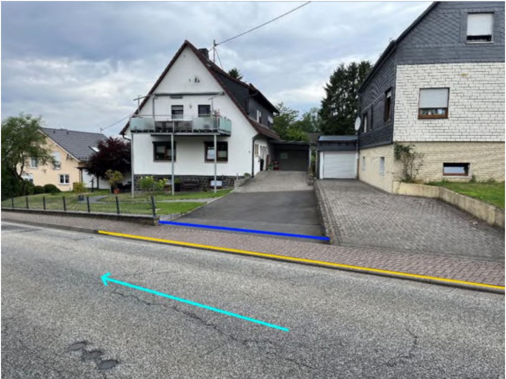
Abbildung 49: Notfließweg "Betzdorfer Straße" mit Fließrichtung (hellblau), Objektschutzmaßnahmen (blau) und Bordanlagen (gelb)
