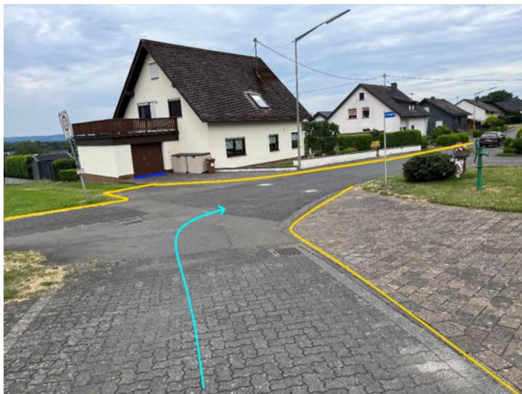
Abbildung 76: Notfließweg "Im Kochbrunnen" mit Fließrichtung (hellblau), Objektschutzmaßnahmen (blau) und Bordanlagen (gelb)
