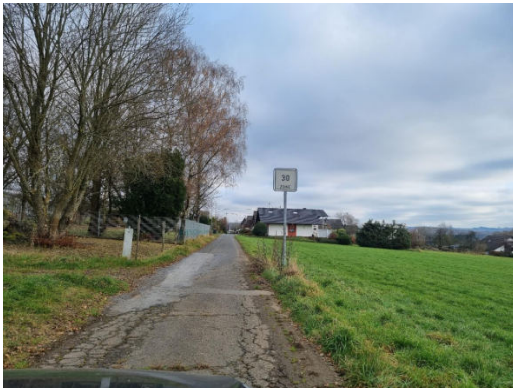
Abbildung 24: Nauroth, Senke im Weg, Verlängerung Löhweise; Gefahrenpunkt 6.9
