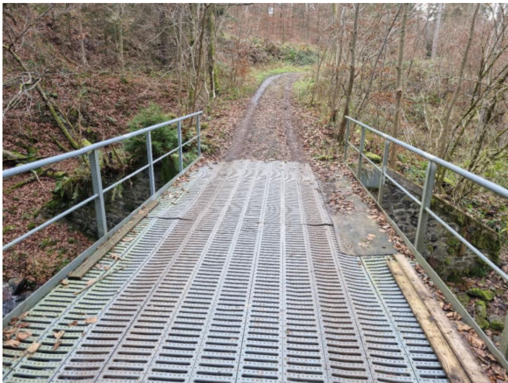
Abbildung 6 Nauroth, Brücke über die Kleine Nister im Bereich Jägerwiese; Gefahrenpunkt 6.6
