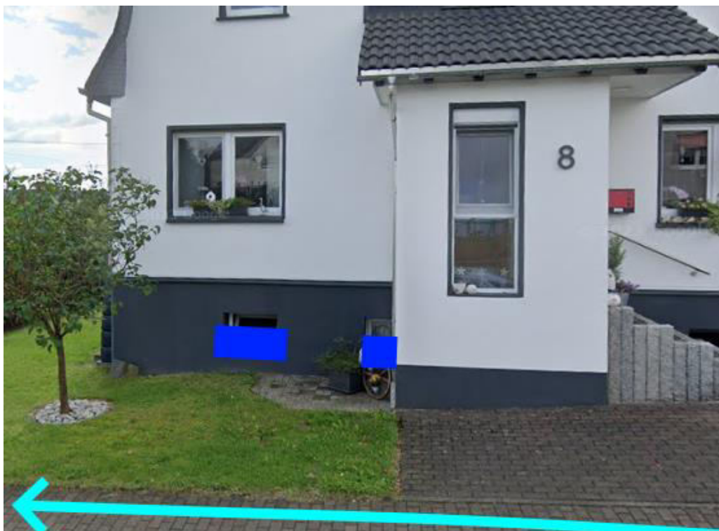
Abbildung 50: Notabflussweg "Bad Marienberger Straße" mit Fließrichtung (hellblau) und Objektschutzmaßnahmen (dunkelblau)
