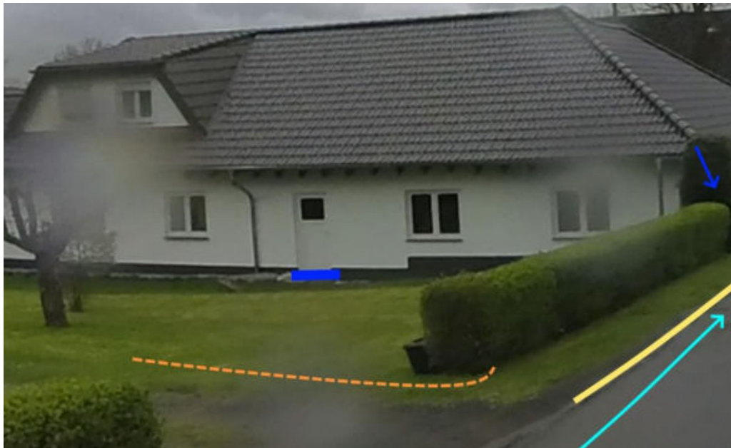
Abbildung 120: Notabflussweg "Niederndorfer Straße" mit Fließrichtung (hellblau), Aufwallung (orange), Objektschutzmaßnahmen (blau) und Bordanlage (gelb)
