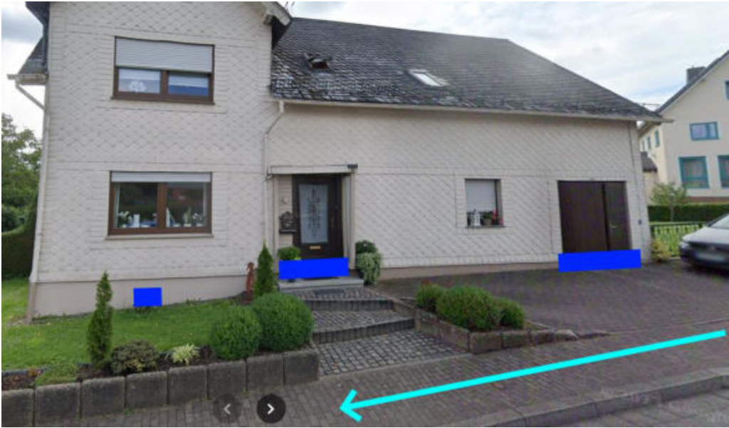
Abbildung 47: Notabflussweg "Bad Marienberger Straße" mit Fließrichtung (hellblau), Objektschutzmaßnahme (dunkelblau) und Bordanlage (gelb)
