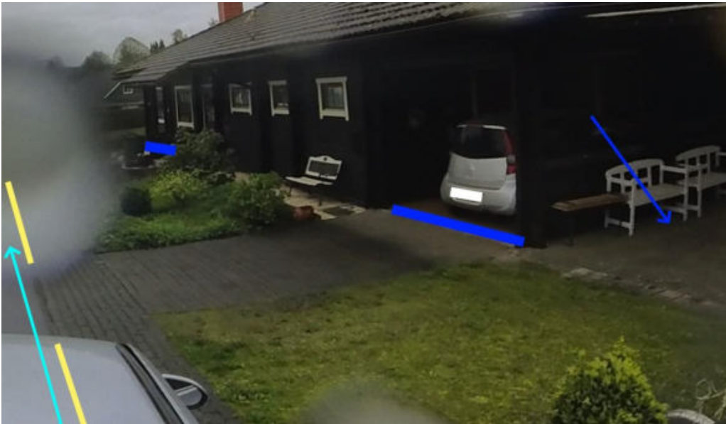
Abbildung 117: Notabflussweg "Niederndorfer Straße" mit Fließrichtung (hellblau), Objektschutzmaßnahmen (blau) und Bordanlage (gelb)
