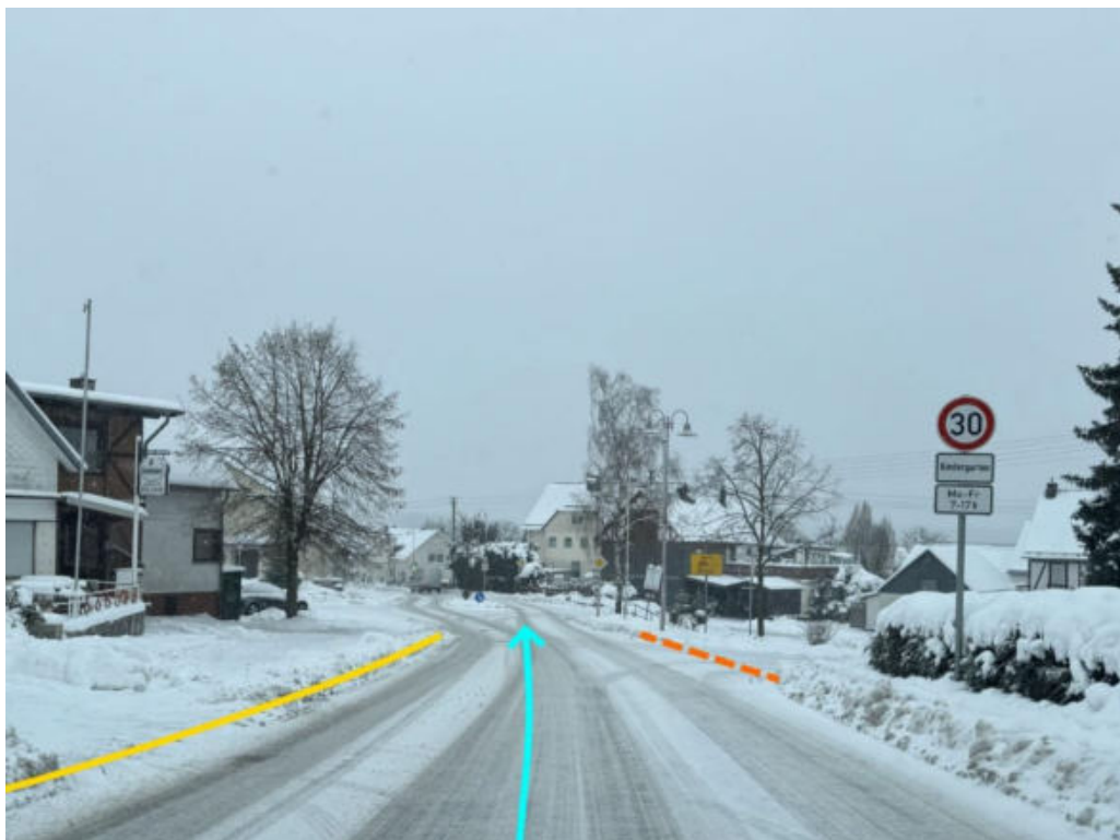
Abbildung 36: Notabflussweg "Bad Marienberger Straße" mit Fließrichtung (hellblau), Aufwallung (orange) und Bordanlage (gelb)
