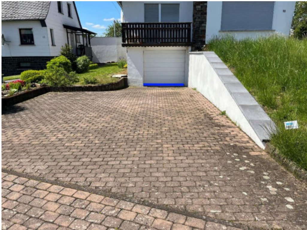
Abbildung 82: Notabflussweg "Zur Jägerwiese" mit Objektschutzmaßnahme (dunkelblau)
