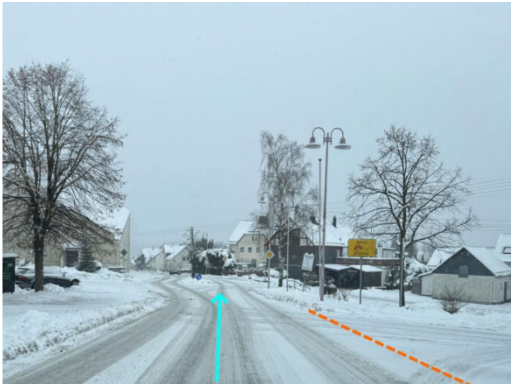
Abbildung 37: Notabflussweg "Bad Marienberger Straße" mit Fließrichtung (hellblau), Objektschutzmaßnahme (dunkelblau) und Bordanlage (gelb)
