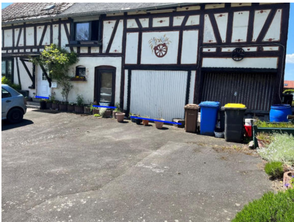
Abbildung 73: Notabflussweg "Hachenburger Straße" mit Objektschutzmaßnahme (dunkelblau)
