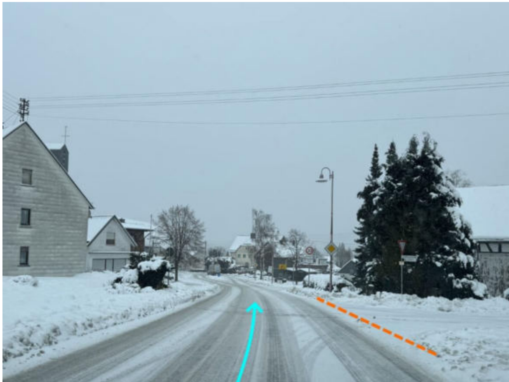
Abbildung 35: Notabflussweg "Bad Marienberger Straße" mit Fließrichtung (hellblau), Objektschutzmaßnahme (dunkelblau) und Bordanlage (gelb)
