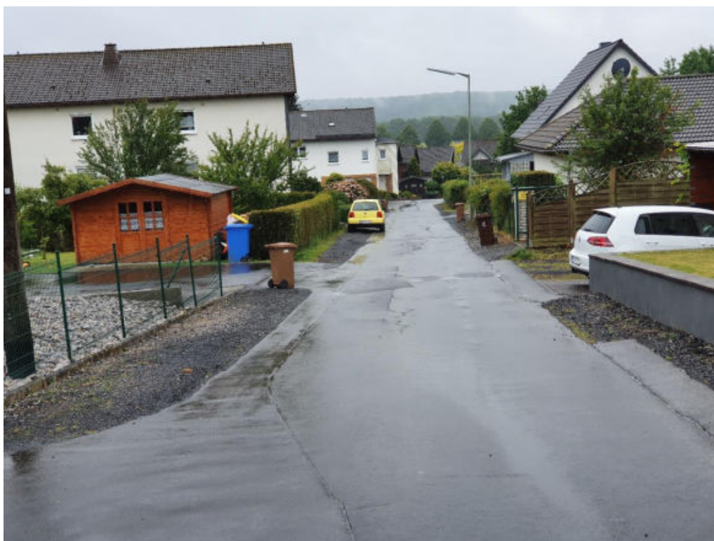
Abbildung 10: Nauroth, Mittelstraße/Südstraße; Gefahrenpunkt 6.2
