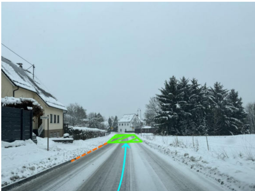
Abbildung 44: Notabflussweg "Bad Marienberger Straße" mit Fließrichtung (hellblau), Aufwallung (orange) und Bordanlage (gelb)
