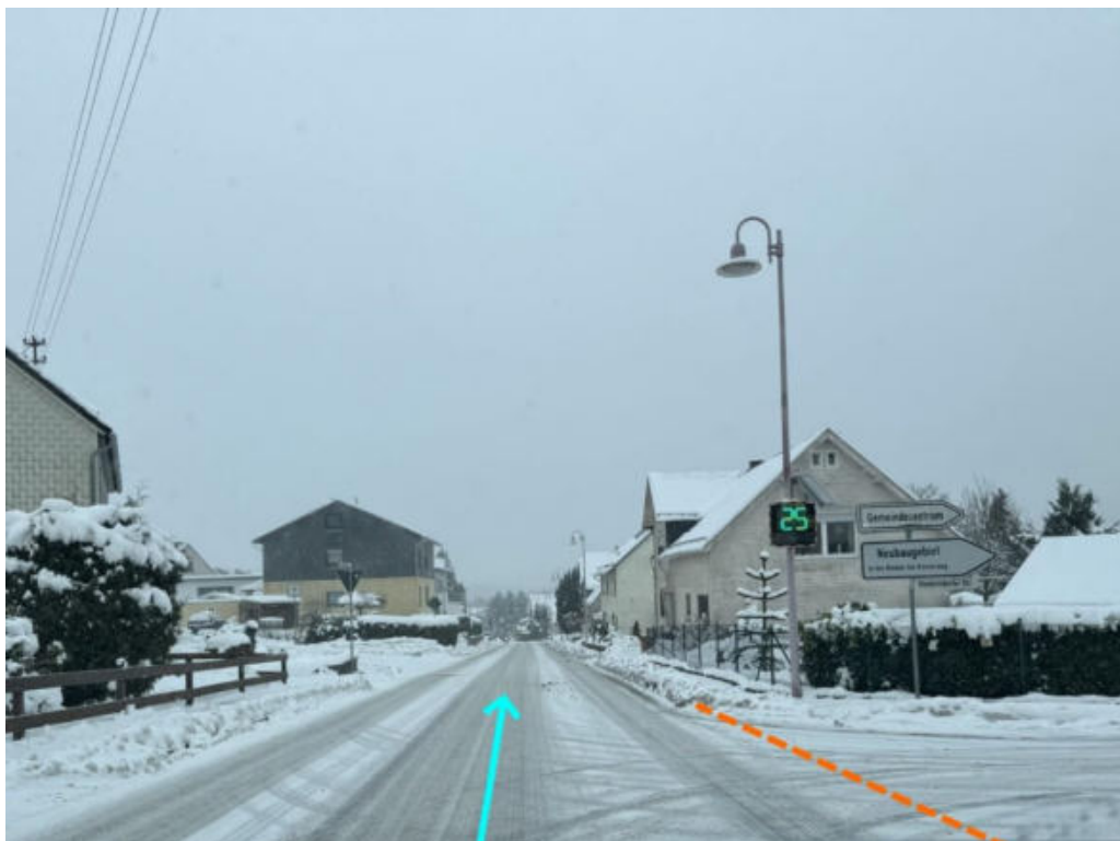
Abbildung 40: Notabflussweg "Bad Marienberger Straße" mit Fließrichtung (hellblau), Objektschutzmaßnahme (dunkelblau) und Bordanlage (gelb)
