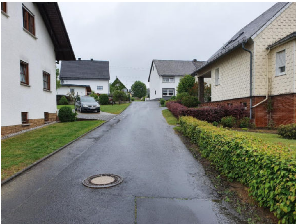
Abbildung 9: Nauroth, Mittelstraße/Südstraße; Gefahrenpunkt 6.2
