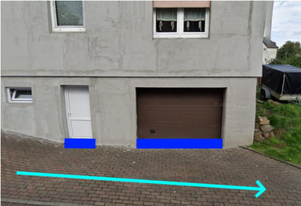
Abbildung 51: Notabflussweg "Bad Marienberger Straße" mit Fließrichtung (hellblau) und Objektschutzmaßnahmen (dunkelblau)
