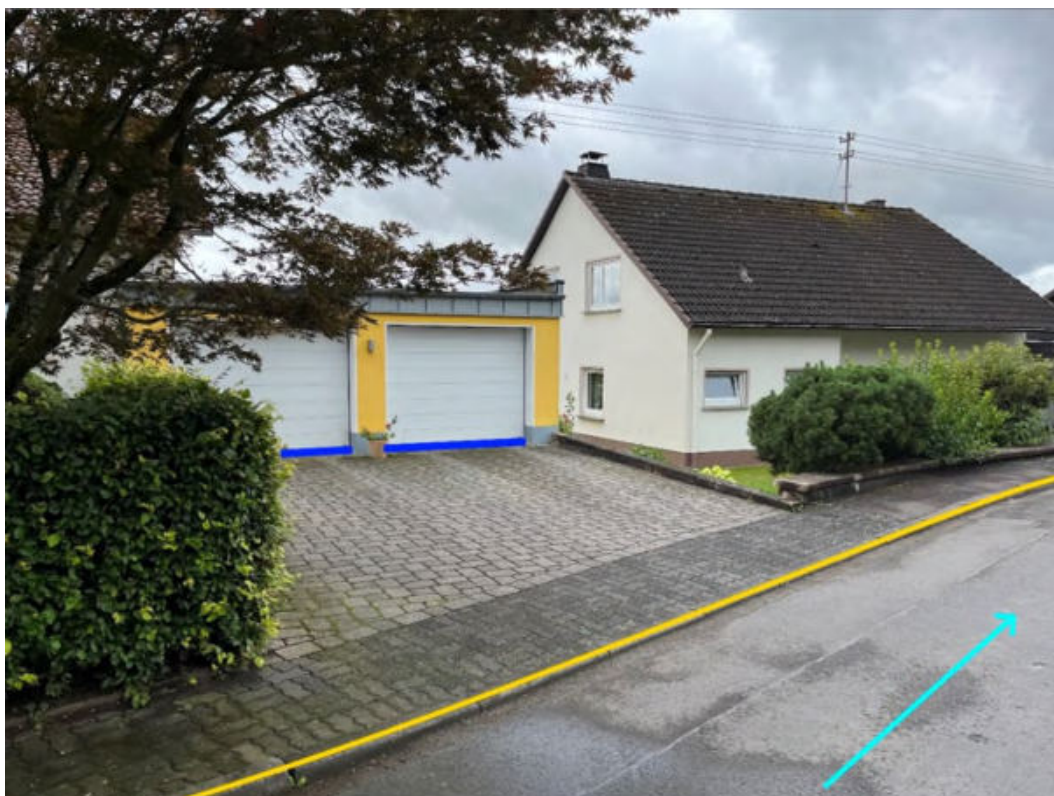
Abbildung 115: Notabflussweg "Lärchenweg" mit Fließrichtung (hellblau), Objektschutzmaßnahmen (blau) und Bordanlagen (gelb)
