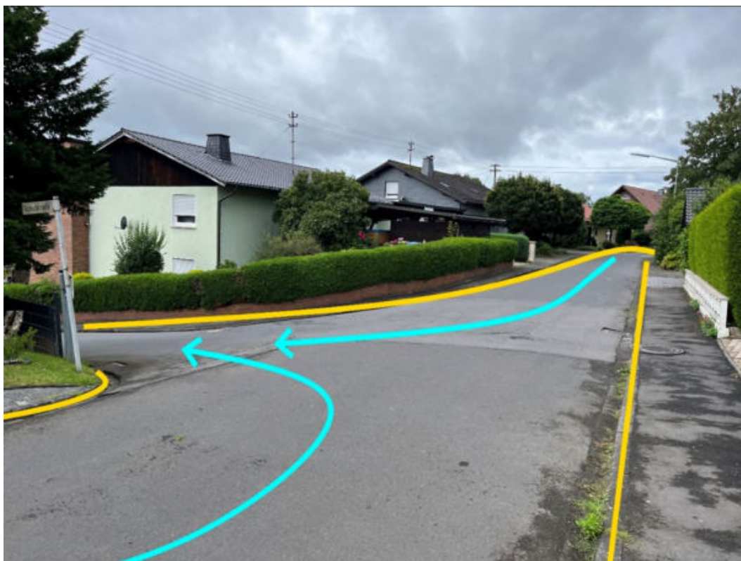
Abbildung 123: Notabflussweg "Lärchenweg" mit Fließrichtung (hellblau) und Bordanlagen (gelb)
