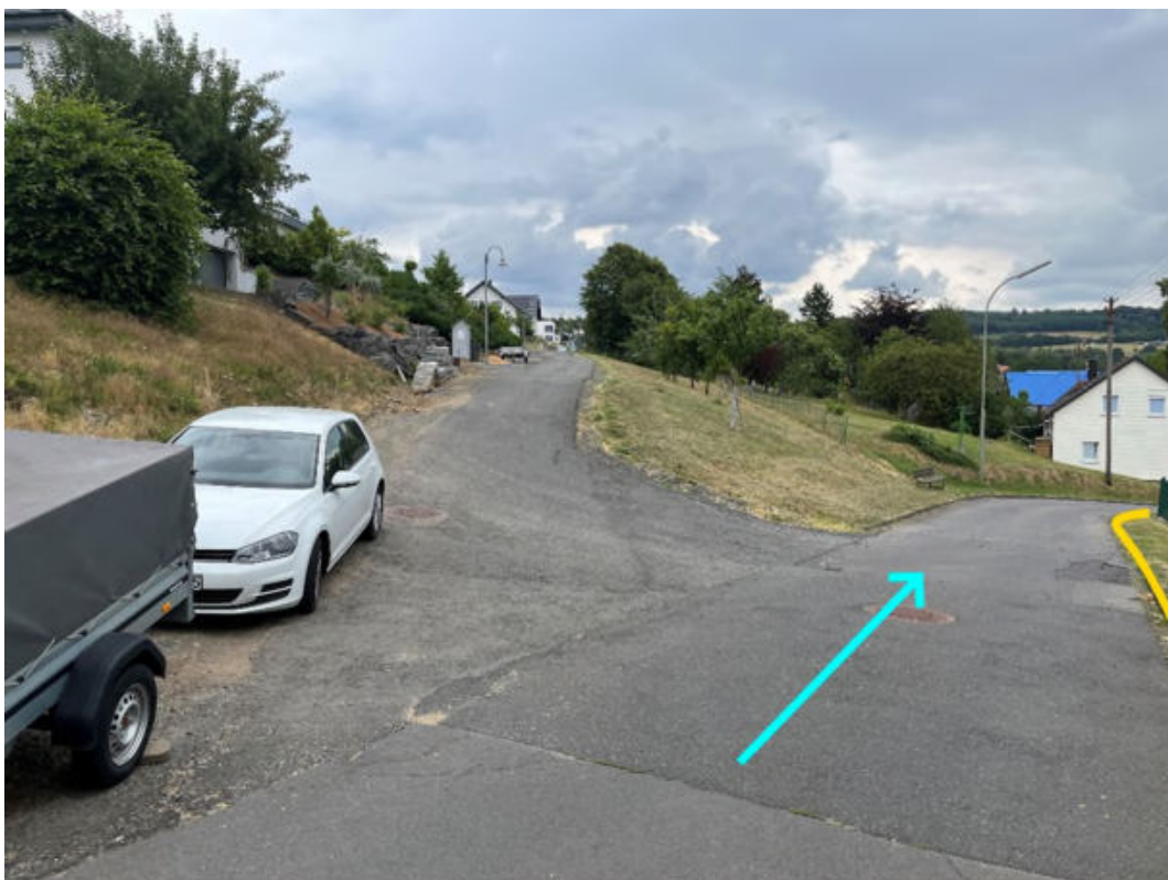
Abbildung 75: Notabflussweg "Zum Steinerother Kopf" mit Fließrichtung (hellblau) und Bordanlagen (gelb)
