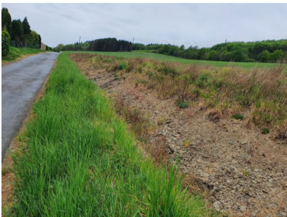
Abbildung 39: Graben oberhalb Oberbergstraße Gefahrenpunkt 10.11
