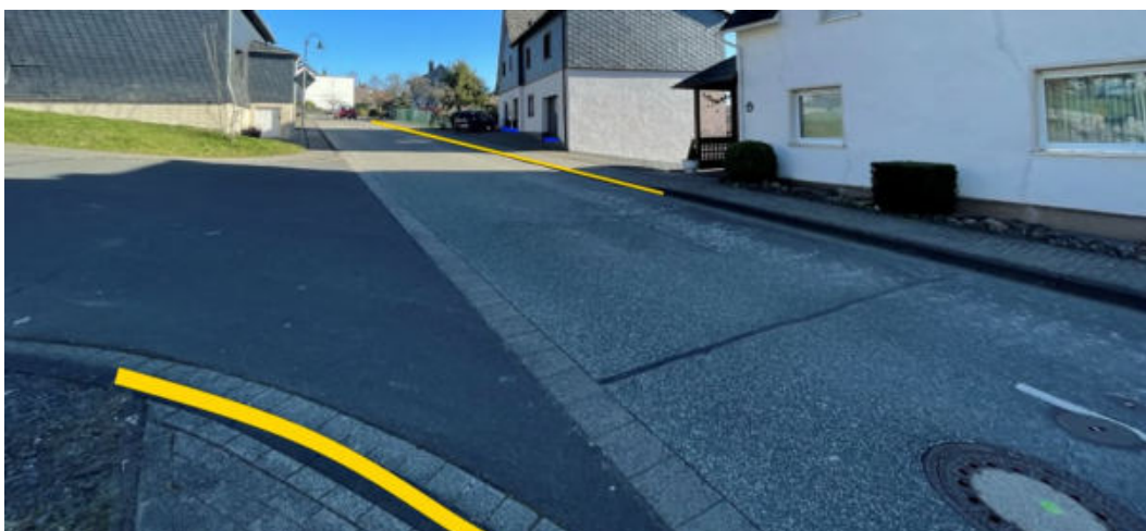
Abbildung 57: Notabflussweg "Oberbergstraße" mit Bordanlagen (gelb)
