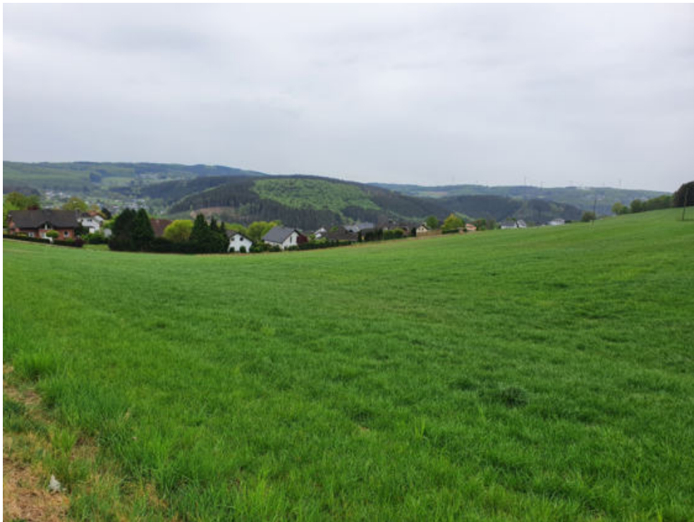
Abbildung 8: nördliches Außengebiet, Gefahrenpunkt 10.7
