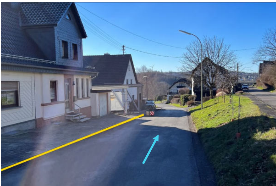
Abbildung 97: Notabflussweg "Talstraße" mit Fließrichtung (hellblau) und Bordanlagen (gelb)
