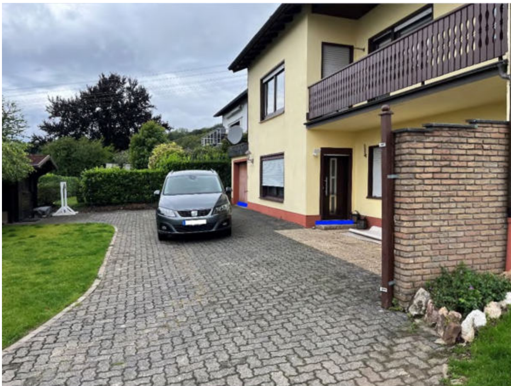
Abbildung 106: Notabflussweg "Auf der Höhe" mit Objektschutzmaßnahmen (blau)
