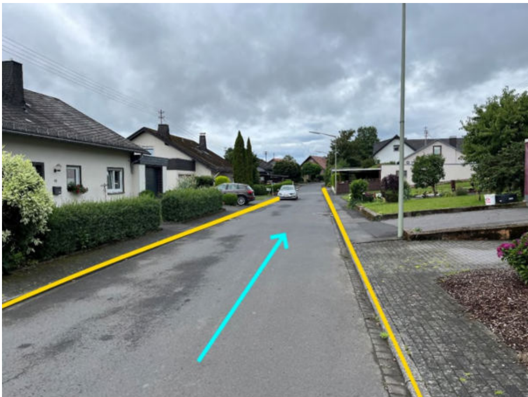
Abbildung 118: Notabflussweg "Lärchenweg" mit Fließrichtung (hellblau) und Bordanlagen (gelb)
