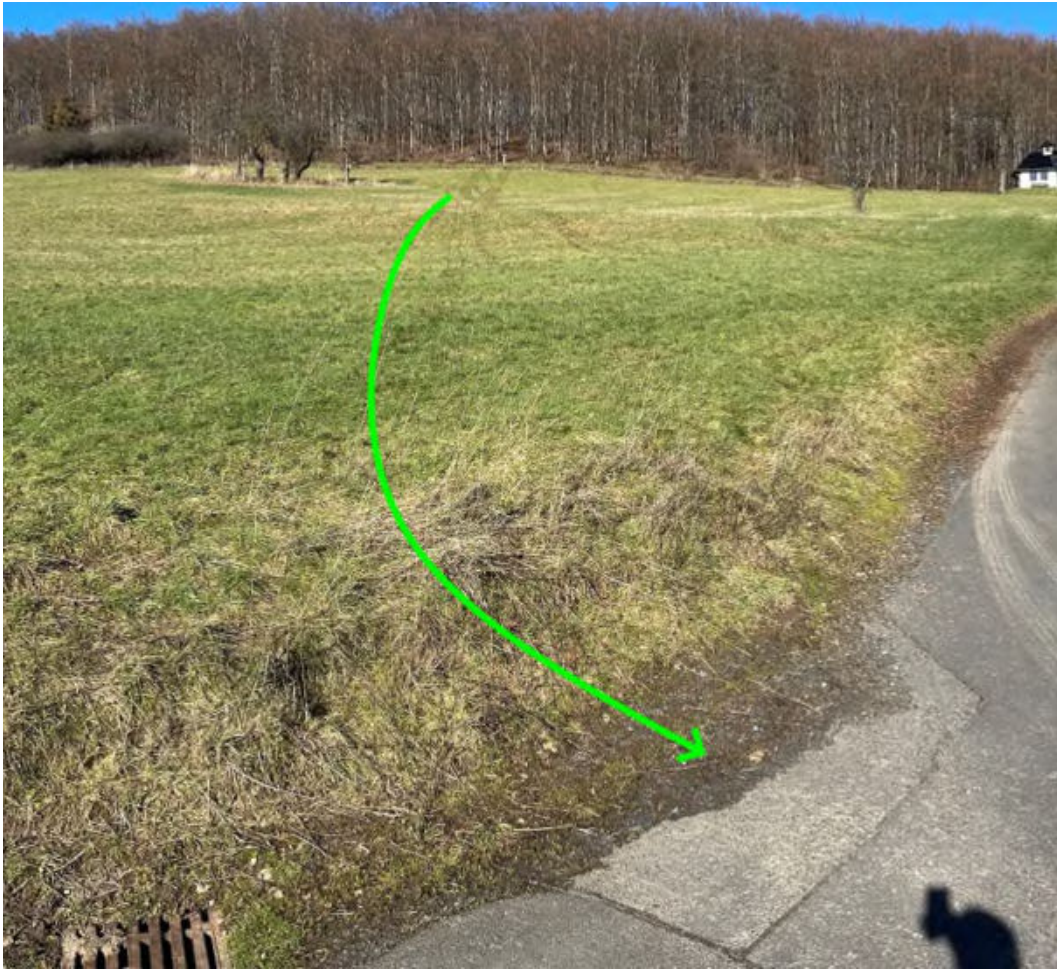
Abbildung 61: Notfließweg "Poststraße" mit Entwässerung über Wiesenfläche (grün)
