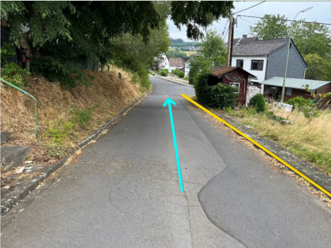
Abbildung 82: Notabflussweg "Zum Steinerother Kopf" mit Fließrichtung (hellblau) und Bordanlagen (gelb)
