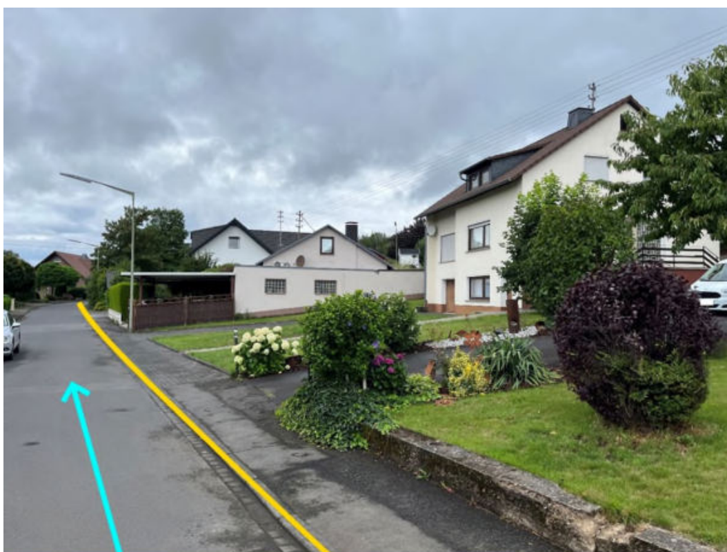
Abbildung 120: Notabflussweg "Lärchenweg" mit Fließrichtung (hellblau) und Bordanlagen (gelb)
