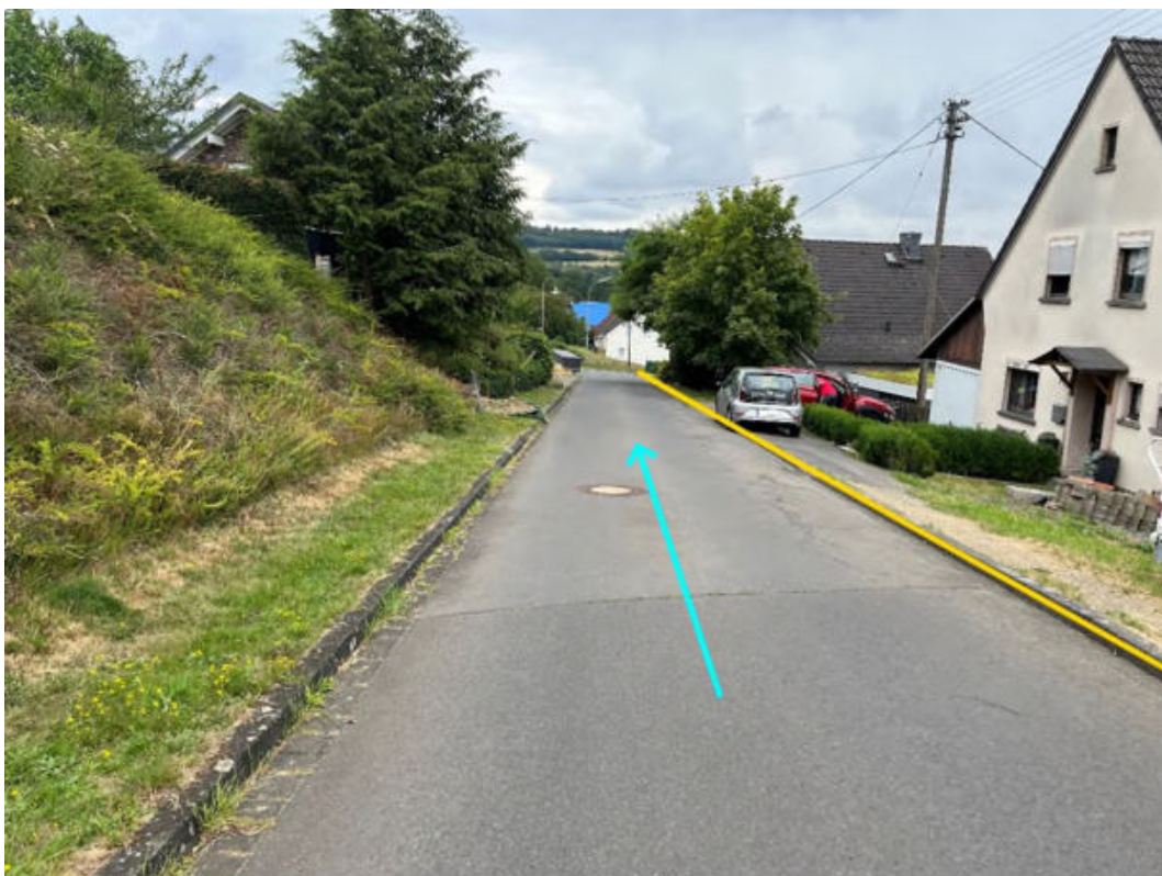
Abbildung 71: Notabflussweg "Zum Steinerother Kopf" mit Fließrichtung (hellblau) und Bordanlagen (gelb)
