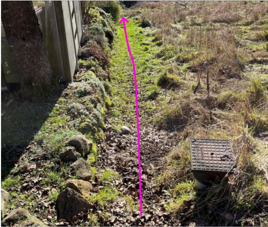
Abbildung 63: Notabflussweg "Poststraße" mit natürlicher Entwässerungsrinne (lila)
