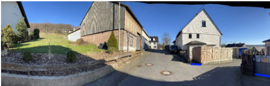
Abbildung 67: Notabflussweg "Poststraße" mit Objektschutzmaßnahmen
