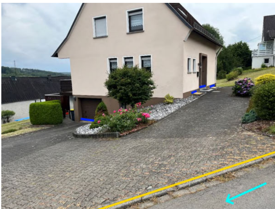
Abbildung 79: Notabflussweg "Zum Steinerother Kopf" mit Fließrichtung (hellblau), Objektschutzmaßnahmen (blau) und Bordanlagen (gelb)
