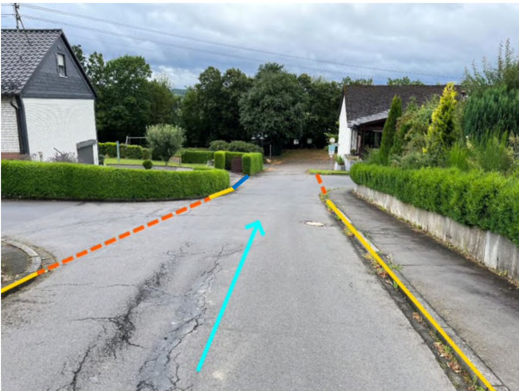
Abbildung 133: Notabflussweg "Schulstraße" mit Fließrichtung (hellblau), Aufwallungen (orange), Objektschutzmaßnahmen (blau) und Bordanlagen (gelb)
