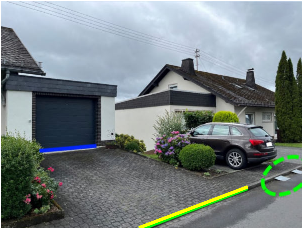
Abbildung 121: Notabflussweg "Lärchenweg" mit Objektschutzmaßnahmen (blau), Instandhaltung der Entwässerungseinrichtungen (grün) und Bordanlagen (gelb)
