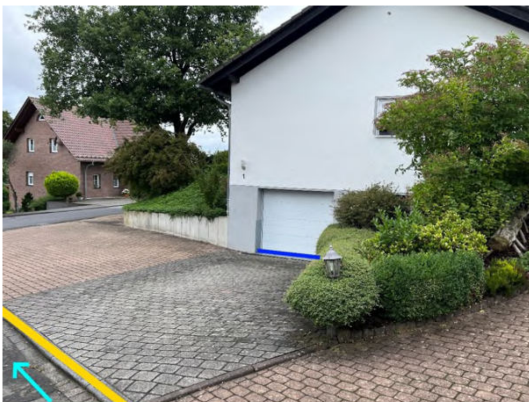
Abbildung 111: Notabflussweg "Auf der Höhe" mit Fließrichtung (hellblau), Objektschutzmaßnahmen (blau) und Bordanlagen (gelb)
