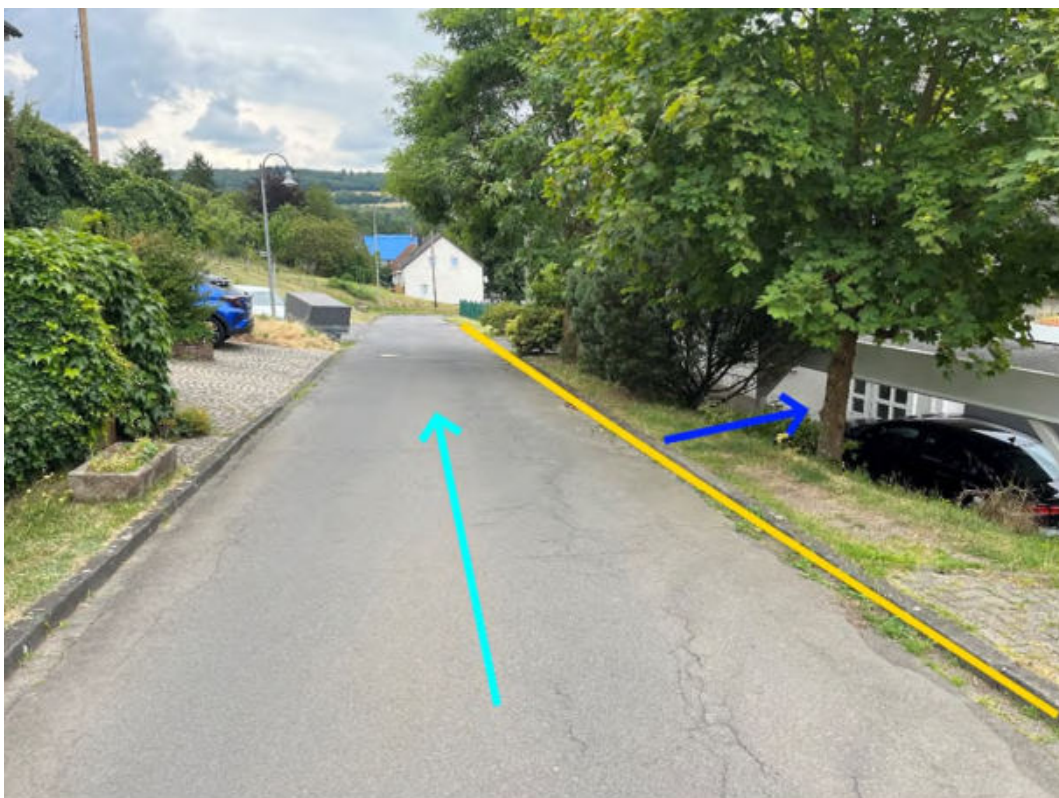
Abbildung 73: Notabflussweg "Zum Steinerother Kopf" mit Fließrichtung (hellblau), Objektschutzmaßnahmen (blau) und Bordanlagen (gelb)
