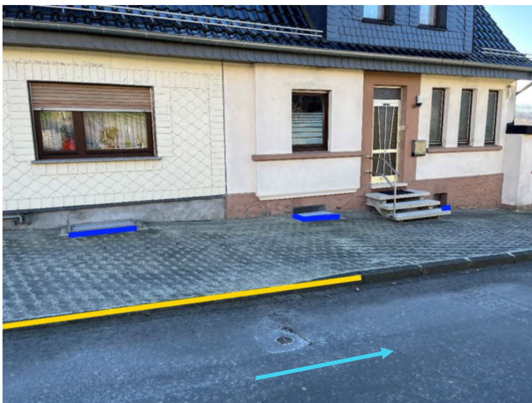
Abbildung 97: Notabflussweg "Talstraße" mit Fließrichtung (hellblau) und Bordanlagen (gelb)
