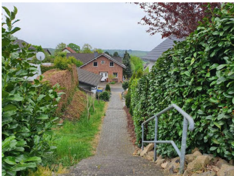
Abbildung 41: Zulauf aus Außengebiet auf Oberbergstraße Gefahrenpunkt 10.11
