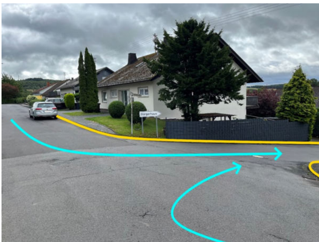
Abbildung 124: Notabflussweg "Lärchenweg" mit Fließrichtung (hellblau) und Bordanlagen (gelb)
