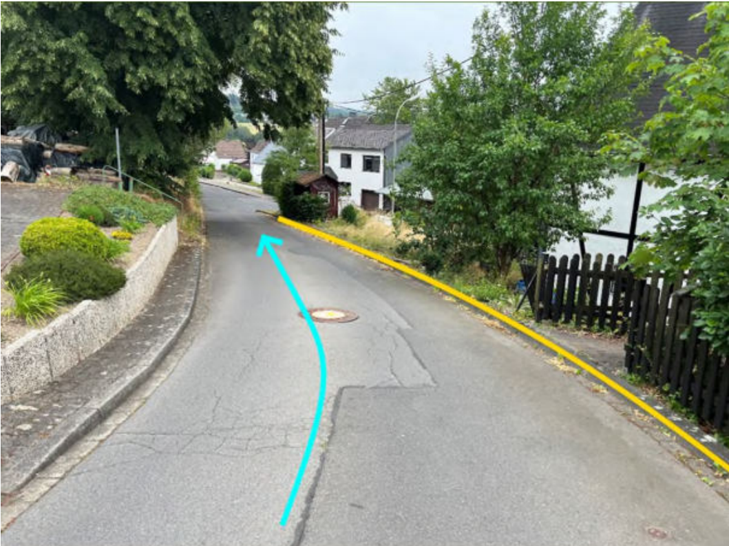
Abbildung 80: Notabflussweg "Zum Steinerother Kopf" mit Fließrichtung (hellblau) und Bordanlagen (gelb)
