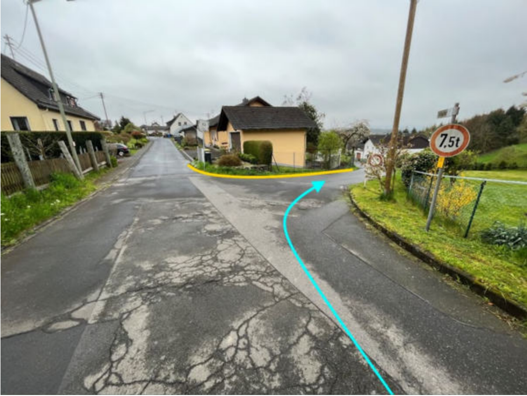
Abbildung 248: Notabflussweg "Limbacher Straße" mit Fließrichtung (hellblau) und Bordanlagen (gelb)
