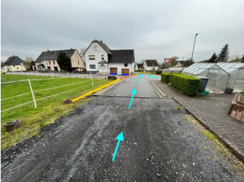
Abbildung 33: Notabflussweg "Bindweider Straße" mit Fließrichtung (hellblau), Objektschutzmaßnahmen (dunkelblau), Aufwallung (orange) und Bordanlagen (gelb)
