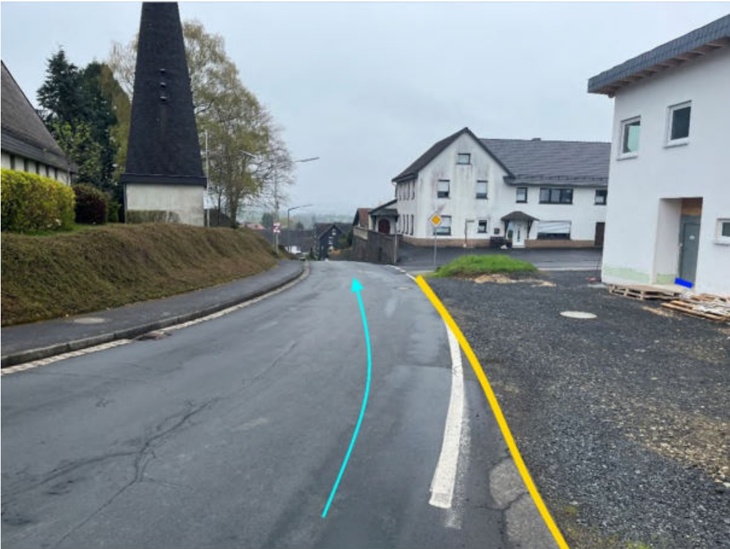
Abbildung 180: Notabflussweg "Hauptstraße" mit Fließrichtung (hellblau) und Bordanlagen (gelb)
