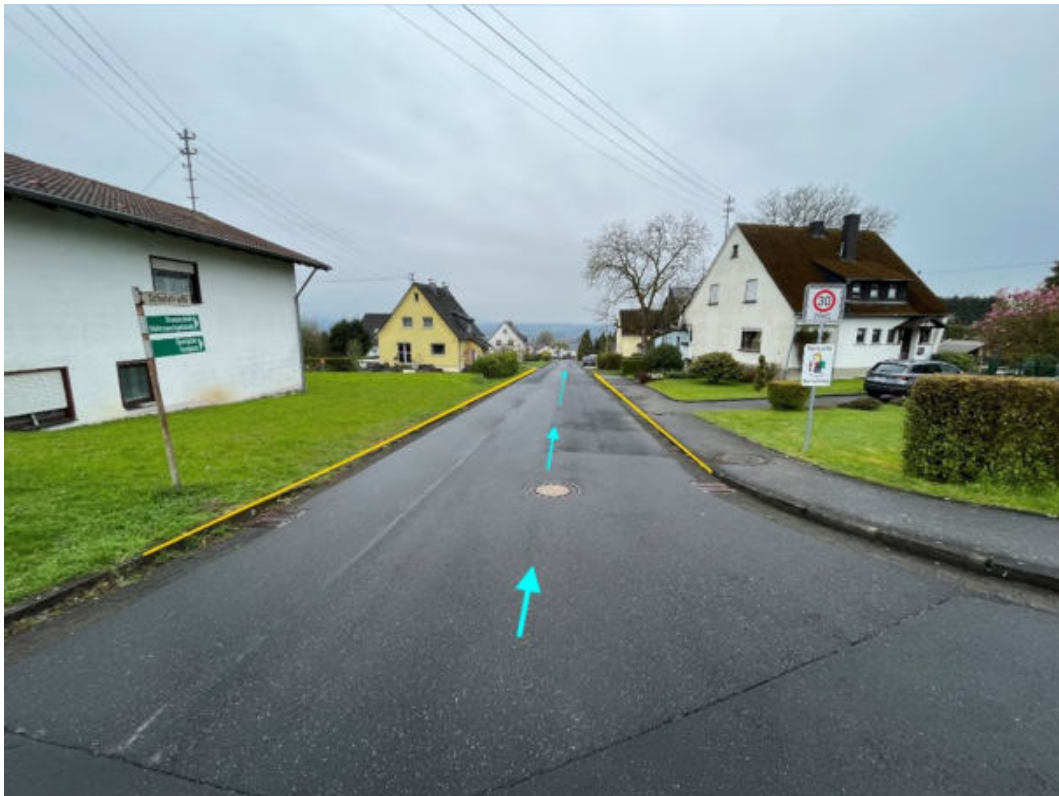
Abbildung 99: Notabflussweg "Schulstraße" mit Fließrichtung (hellblau) und Bordanlagen (gelb)
