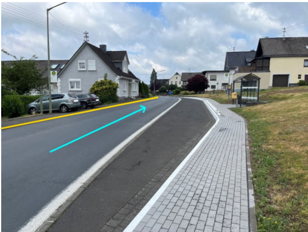
Abbildung 119: Notabflussweg "Hauptstraße" mit Fließrichtung (hellblau) und Bordanlagen (gelb)
