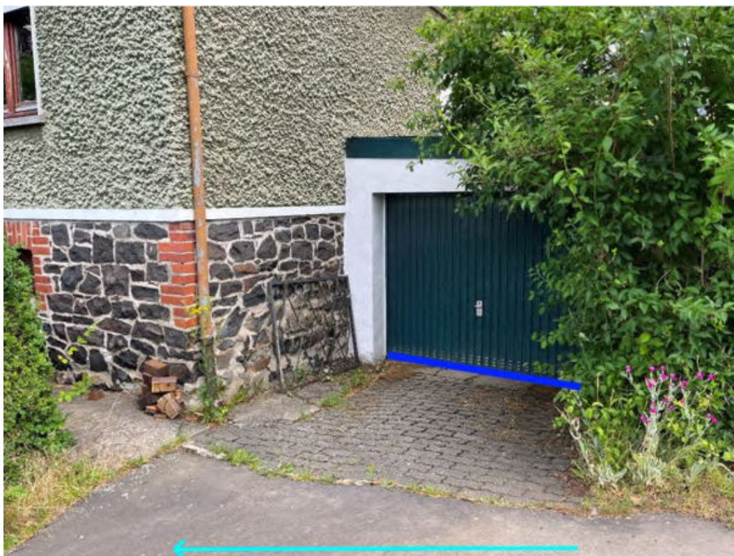
Abbildung 229: Notabflussweg "Krämerweg" mit Objektschutzmaßnahmen (dunkelblau)
