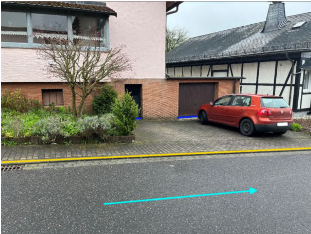
Abbildung 233: Notabflussweg " Limbacher Straße " mit Fließrichtung (hellblau), Objektschutzmaßnahmen (dunkelblau) und Bordanlagen (gelb)
