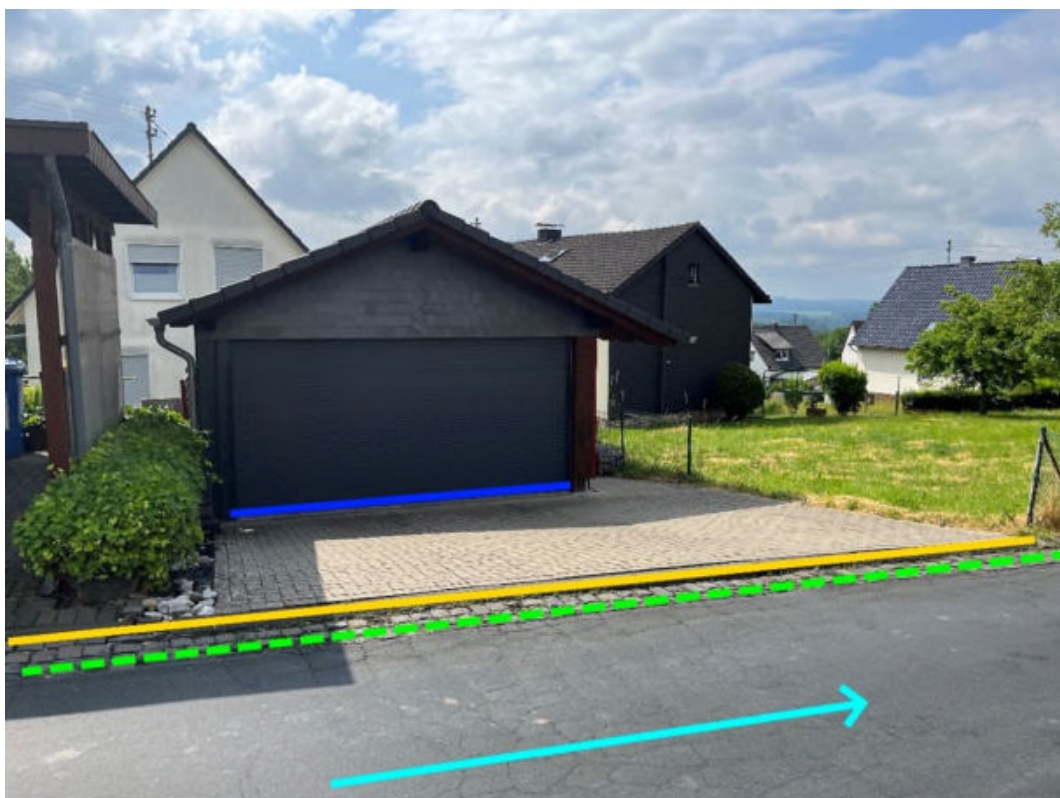
Abbildung 169: Notabflussweg "Hauptstraße" mit Fließrichtung (hellblau), Objektschutzmaßnahmen (dunkelblau), Instandsetzung der Entwässerungseinrichtung (hellgrün) und Bordanlagen (gelb)
