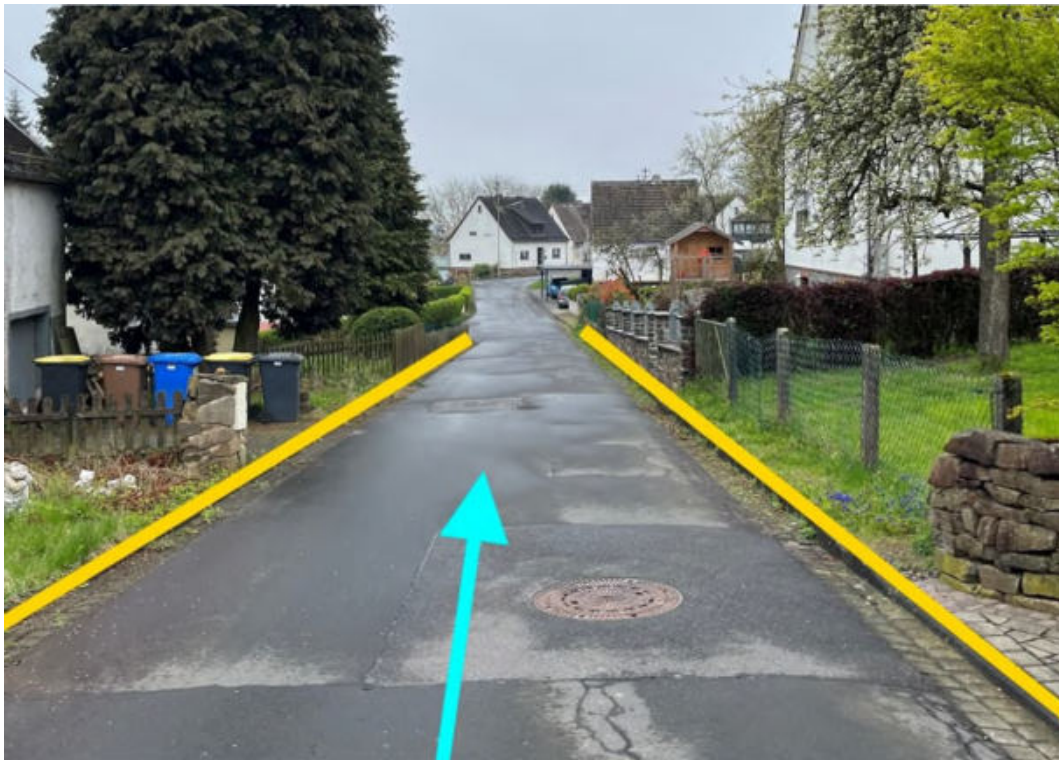
Abbildung 241: Notabflussweg "Limbacher Straße" mit Fließrichtung (hellblau) und Bordanlagen (gelb)
