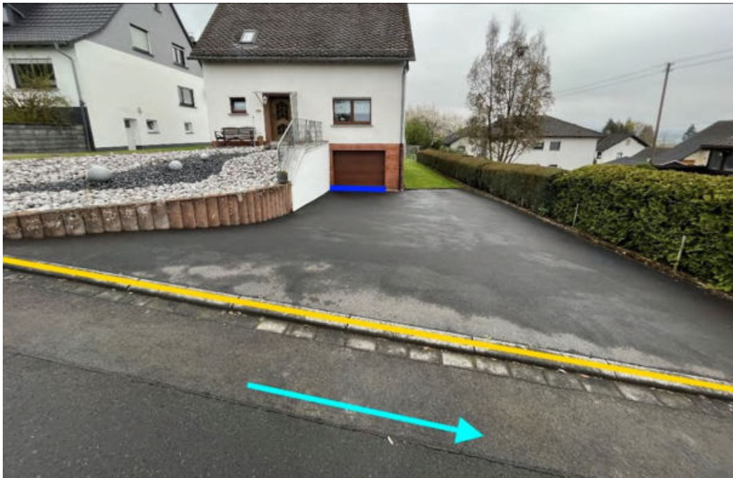
Abbildung 191: Notabflussweg "Rosenweg" mit Fließrichtung (hellblau), Objektschutzmaßnahmen (dunkelblau) und Bordanlagen (gelb)
