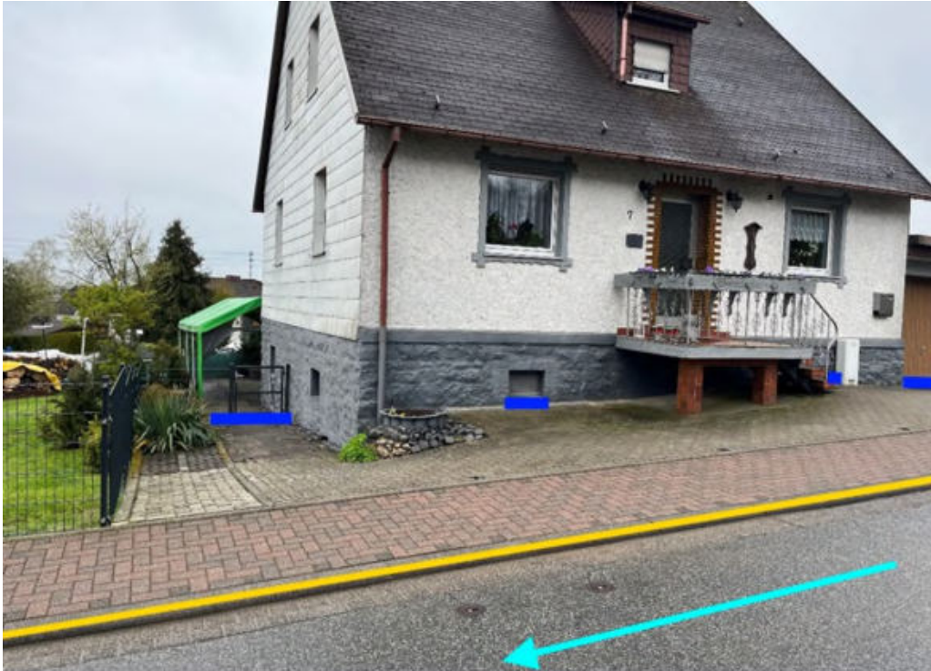
Abbildung 30: Notabflussweg "Bindweider Straße" mit Fließrichtung (hellblau), Objektschutzmaßnahmen (dunkelblau) und Bordanlagen (gelb)
