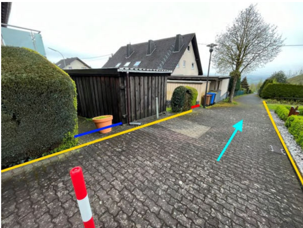
Abbildung 194: Notabflussweg "Rosenweg" mit Fließrichtung (hellblau), Objektschutzmaßnahmen (dunkelblau), mobilem Hochwasserschutz (rot) und Bordanlagen (gelb)
