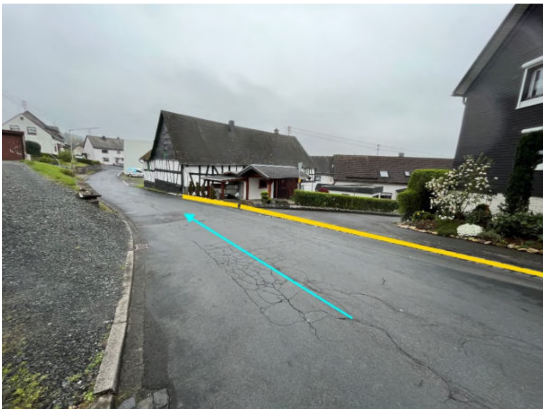
Abbildung 183: Notabflussweg "Hauptstraße" mit Fließrichtung (hellblau) und Bordanlagen (gelb)
