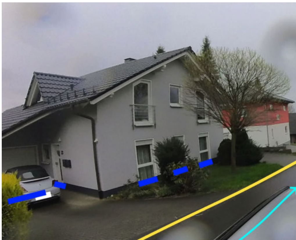
Abbildung 272: Notabflussweg "Südhang" mit Fließrichtung (hellblau), Objektschutzmaßnahmen (dunkelblau) und Bordanlagen (gelb)
