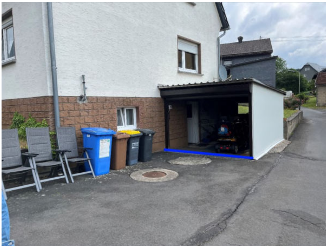
Abbildung 176: Notabflussweg "Hauptstraße" mit Objektschutzmaßnahmen (dunkelblau)
