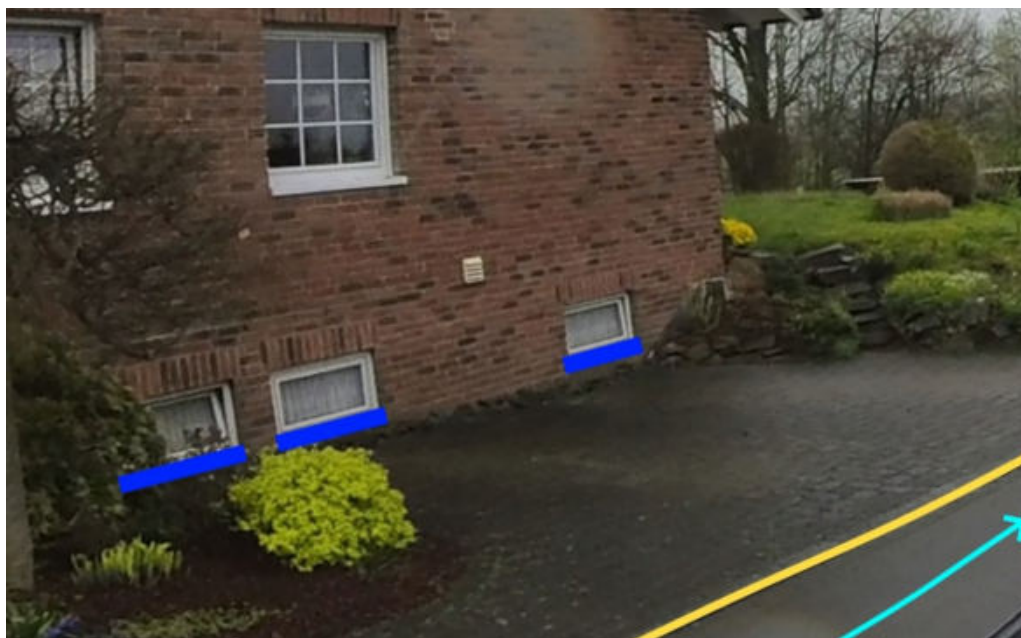
Abbildung 276: Notabflussweg "Südhang" mit Fließrichtung (hellblau), Objektschutzmaßnahmen (dunkelblau) und Bordanlagen (gelb)
