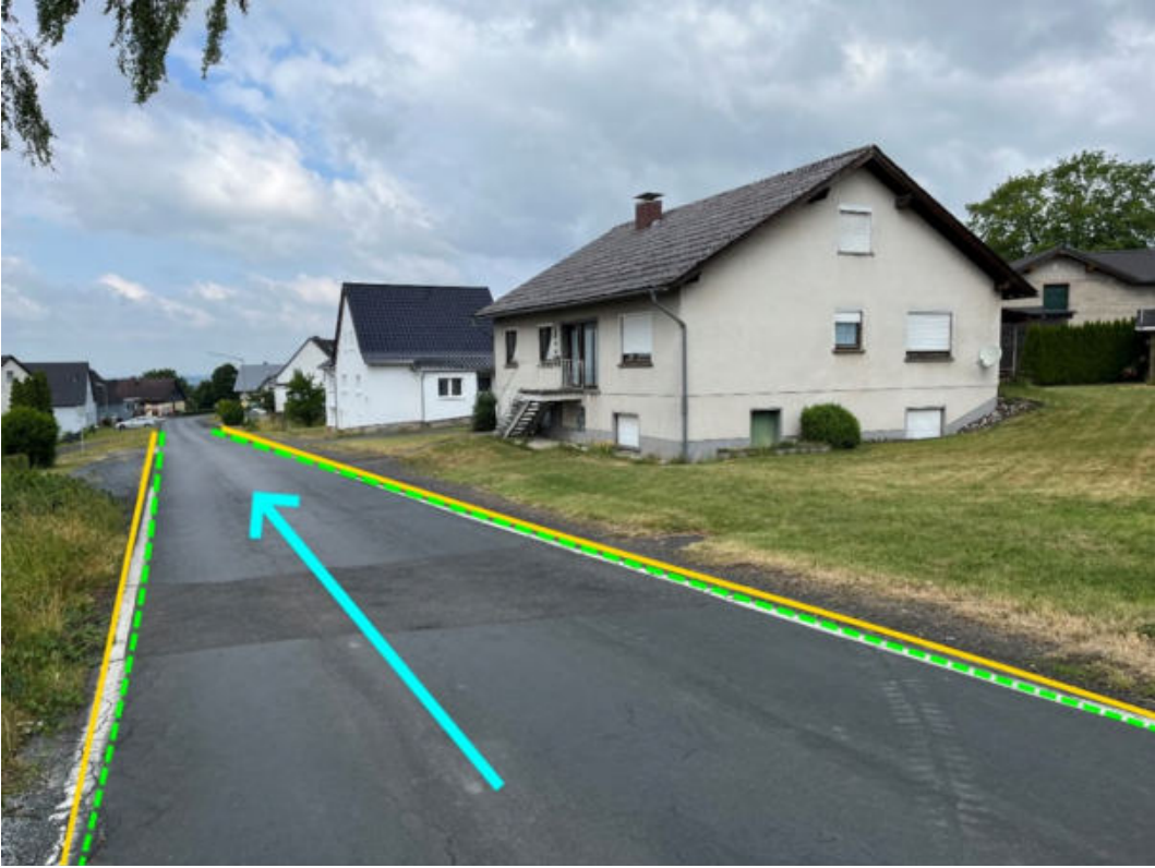
Abbildung 145: Notabflussweg "Hauptstraße" mit Fließrichtung (hellblau), Objektschutzmaßnahmen (dunkelblau), Entwässerungseinrichtung (hellgrün) und Bordanlagen (gelb)
