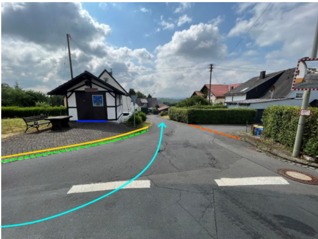
Abbildung 173: Notabflussweg "Hauptstraße" mit Fließrichtung (hellblau), Instandsetzung der Entwässerungseinrichtung (hellgrün), Aufwällung (orange) und Bordanlagen (gelb)
