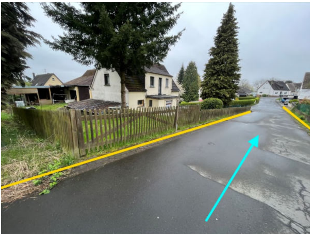
Abbildung 243: Notabflussweg "Limbacher Straße" mit Fließrichtung (hellblau) und Bordanlagen (gelb)
