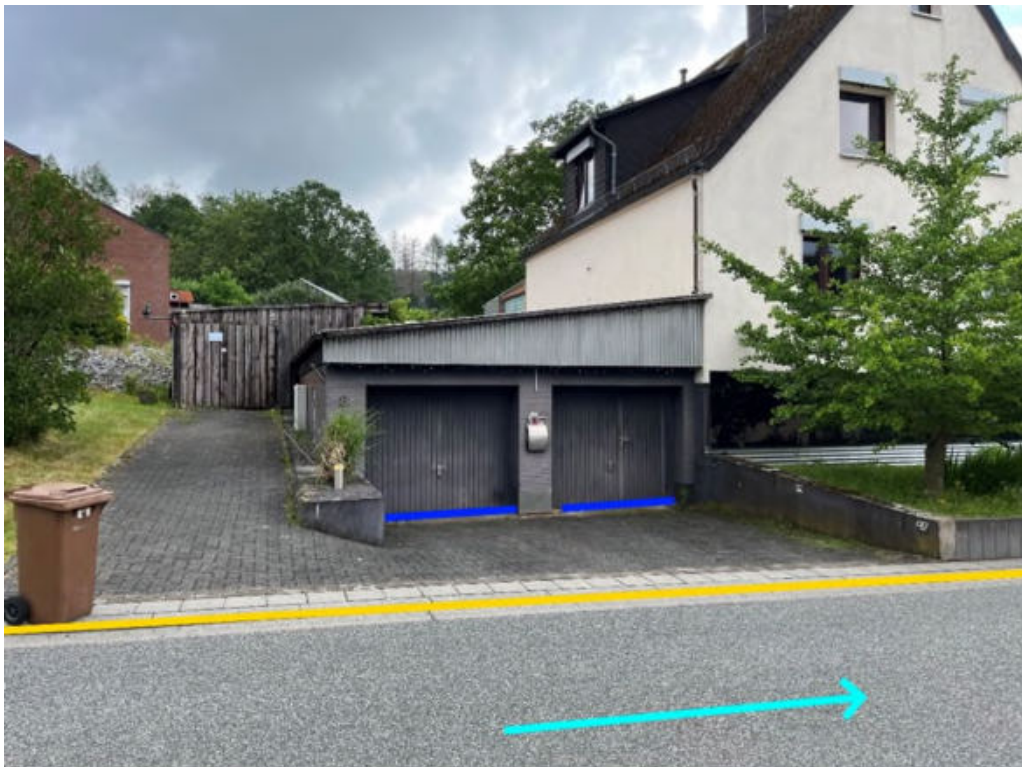
Abbildung 39: Notabflussweg „Bindweider Straße“ mit Fließrichtung (hellblau), Objektschutzmaßnahmen (dunkelblau) und Bordanlagen (gelb)
