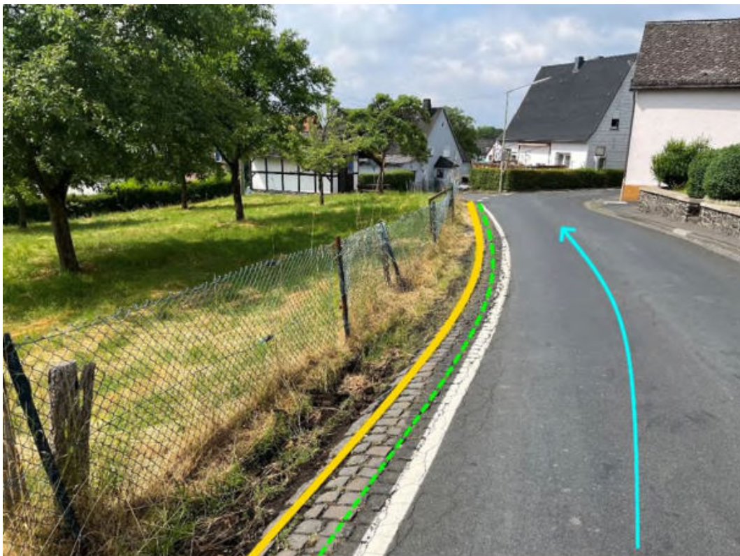
Abbildung 171: Notabflussweg "Hauptstraße" mit Fließrichtung (hellblau), Instandsetzung der Entwässerungseinrichtung (hellgrün) und Bordanlagen (gelb)
