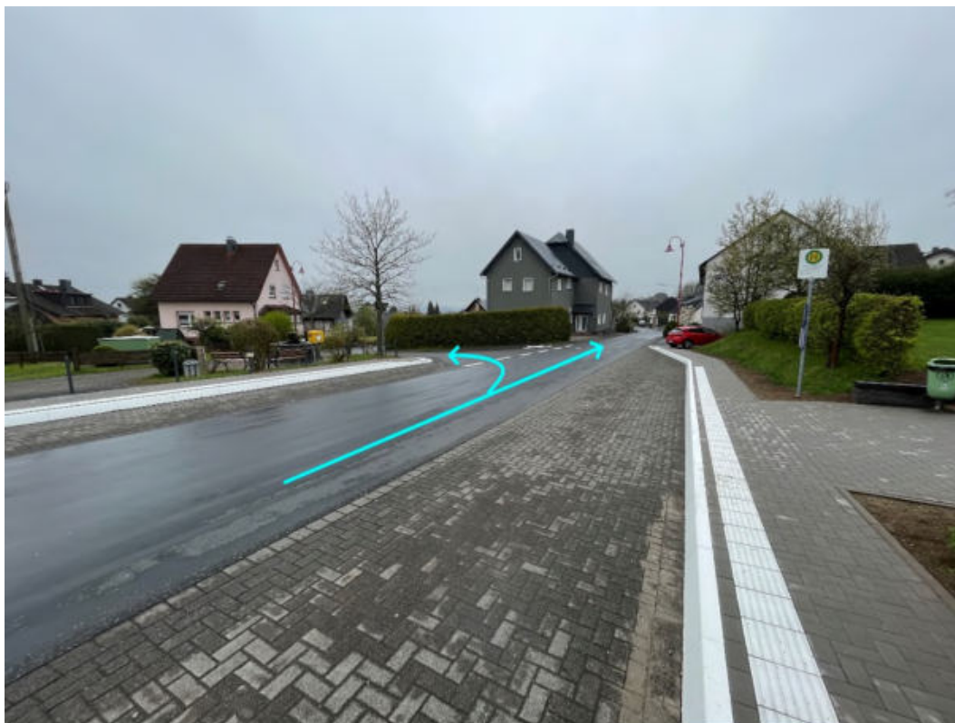
Abbildung 231: Notabflussweg " Limbacher Straße " mit Fließrichtung (hellblau) und Aufwallung (orange)
