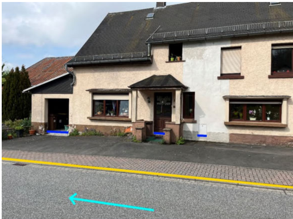
Abbildung 37: Notabflussweg „Bindweider Straße“ mit Fließrichtung (hellblau), Objektschutzmaßnahmen (dunkelblau) und Bordanlagen (gelb)
