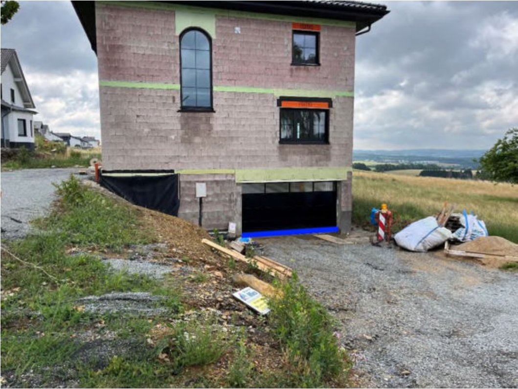
Abbildung 143: Notabflussweg "Hauptstraße" mit Objektschutzmaßnahmen (dunkelblau)
