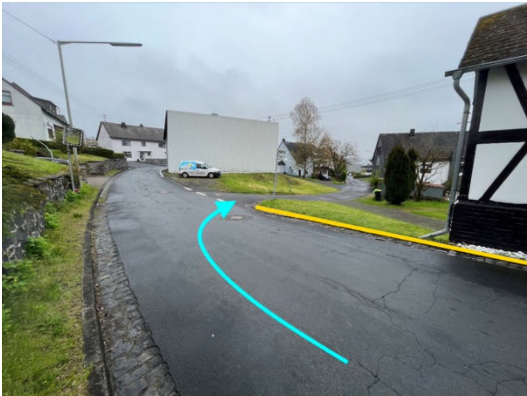
Abbildung 184: Notabflussweg "Hauptstraße" mit Fließrichtung (hellblau) und Bordanlagen (gelb)
