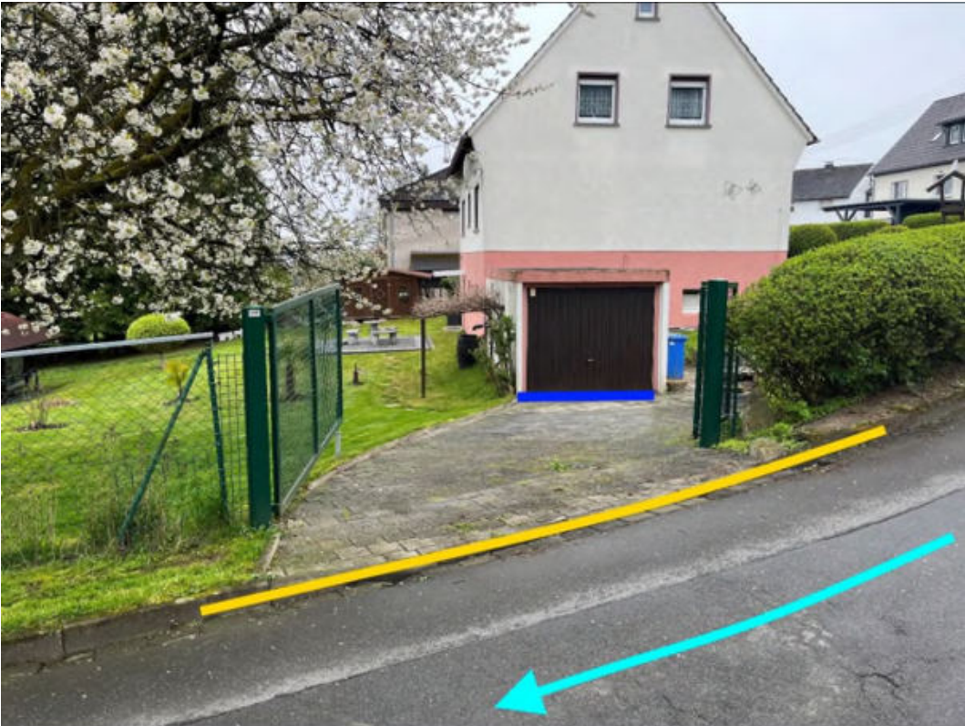
Abbildung 247: Notabflussweg "Limbacher Straße" mit Fließrichtung (hellblau), Objektschutzmaßnahmen (dunkelblau) und Bordanlagen (gelb)
