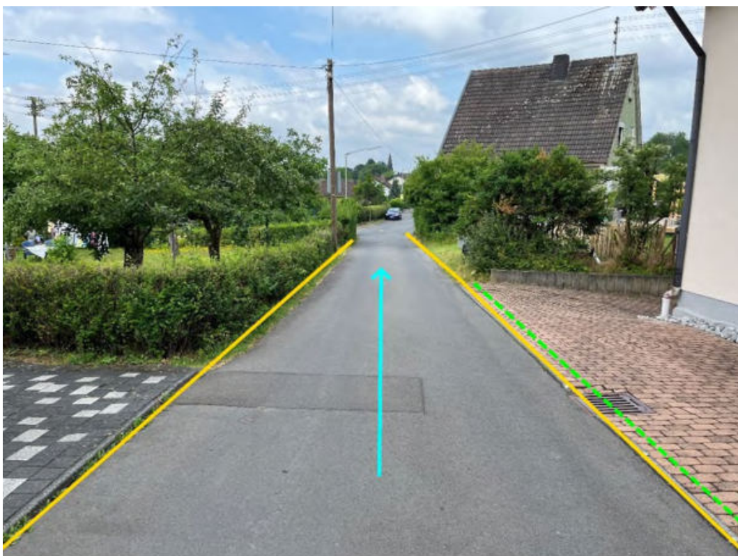
Abbildung 226: Notabflussweg "Krämerweg" mit Fließrichtung (hellblau) und Entwässerungseinrichtung (grün)
