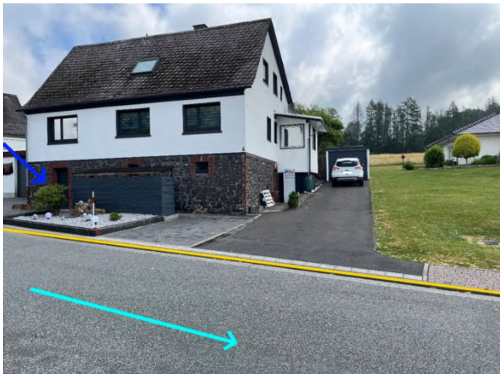
Abbildung 45: Notabflussweg „Bindweider Straße“ mit Fließrichtung (hellblau), Objektschutzmaßnahmen (dunkelblau) und Bordanlagen (gelb)
