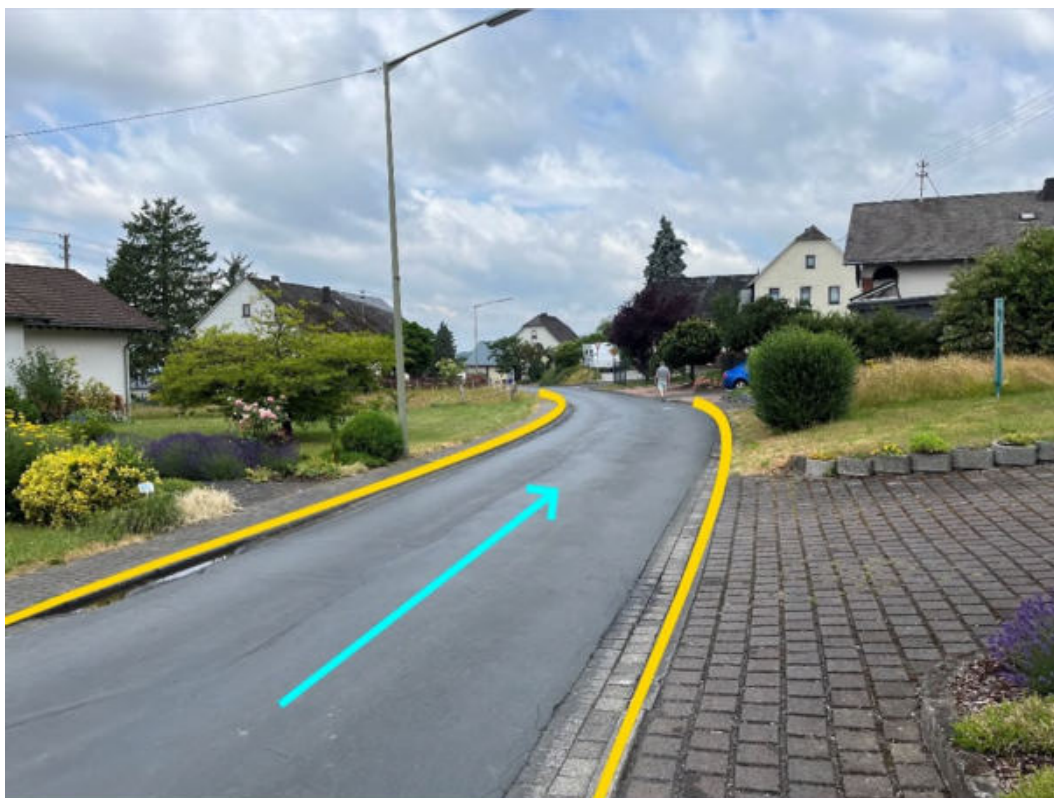
Abbildung 122: Notabflussweg "Hauptstraße" mit Fließrichtung (hellblau) und Bordanlagen (gelb)
