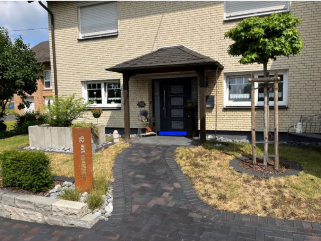
Abbildung 161: Notabflussweg "Hauptstraße" mit Objektschutzmaßnahmen (dunkelblau)
