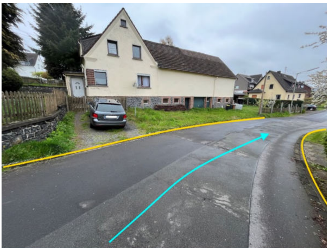
Abbildung 246: Notabflussweg "Limbacher Straße" mit Fließrichtung (hellblau) und Bordanlagen (gelb)
