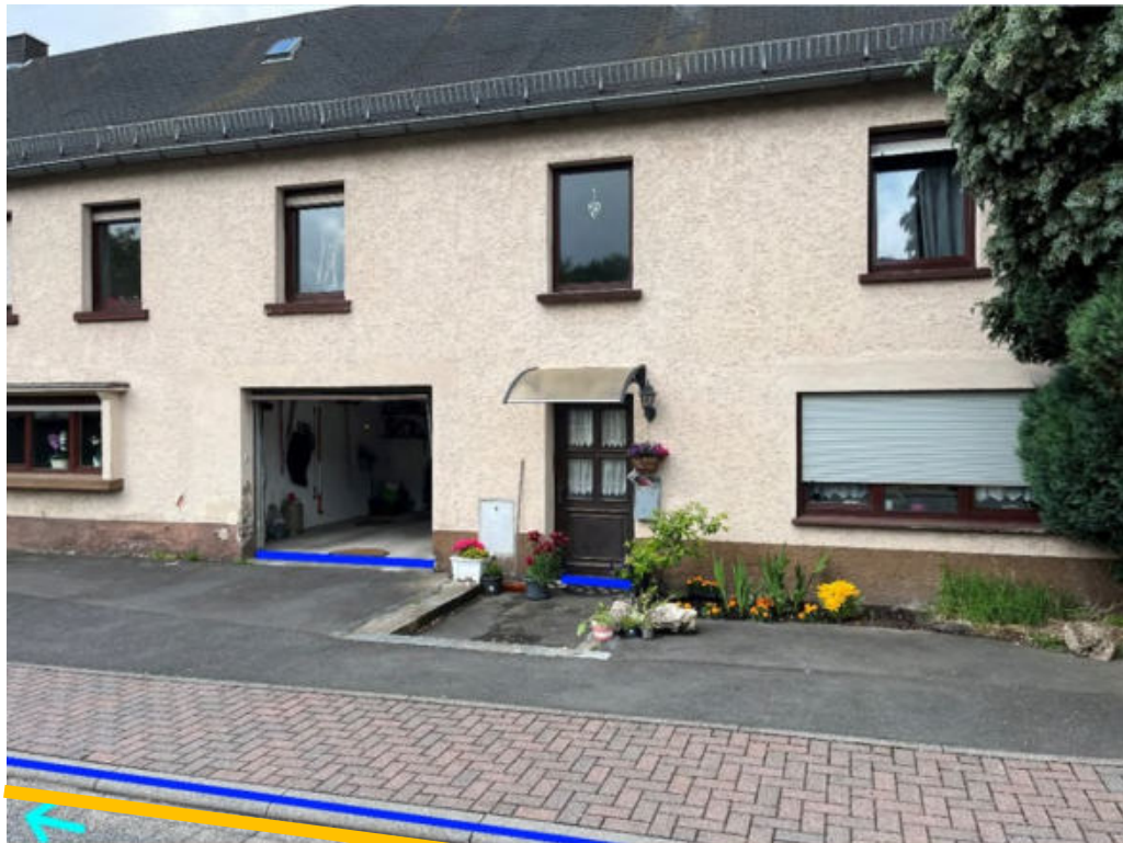
Abbildung 36: Notabflussweg „Bindweider Straße“ mit Fließrichtung (hellblau), Objektschutzmaßnahmen (dunkelblau) und Bordanlagen (gelb)
