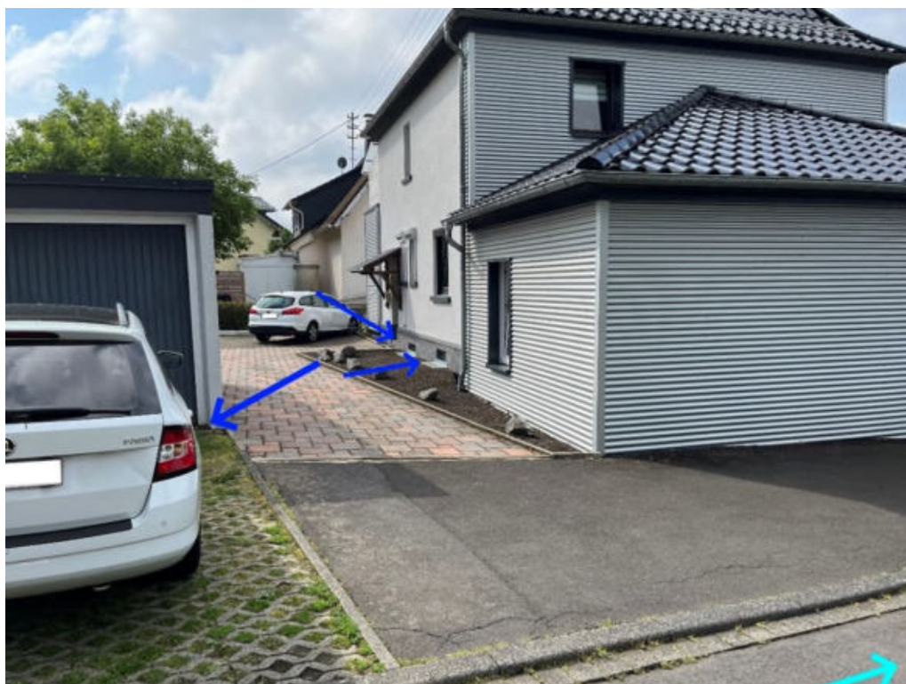
Abbildung 52: Notabflussweg „Poststraße“ mit Objektschutzmaßnahmen (dunkelblau)
