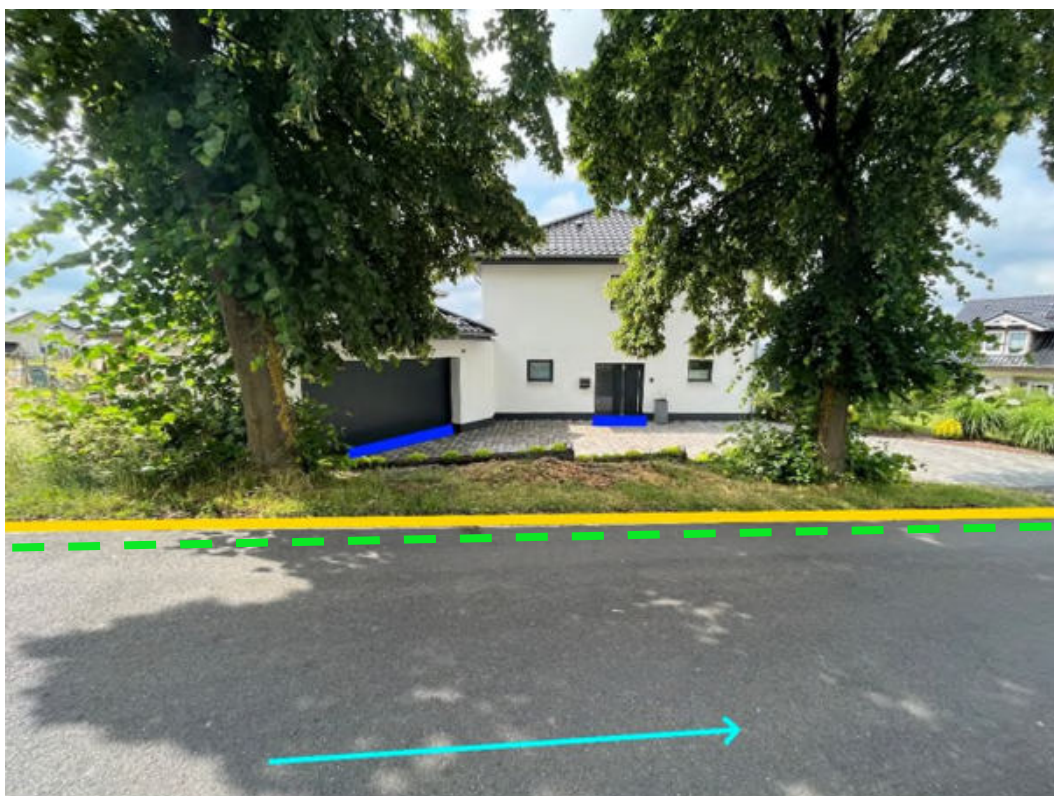
Abbildung 133: Notabflussweg "Hauptstraße" mit Fließrichtung (hellblau), Objektschutzmaßnahmen (dunkelblau), Instandsetzung der Entwässerungseinrichtung (hellgrün) und Bordanlagen (gelb)
