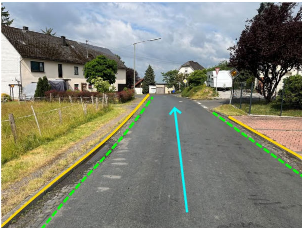
Abbildung 124: Notabflussweg "Hauptstraße" mit Fließrichtung (hellblau), Objektschutzmaßnahmen (dunkelblau) Instandsetzung der Entwässerungseinreichung (grün) und Bordanlagen (gelb)
