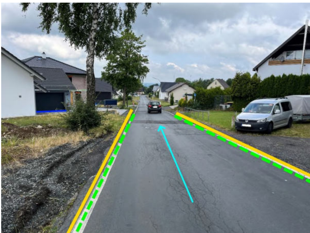
Abbildung 139: Notabflussweg "Hauptstraße" mit Fließrichtung (hellblau), Objektschutzmaßnahmen (dunkelblau), Entwässerungseinrichtung (hellgrün) und Bordanlagen (gelb)
