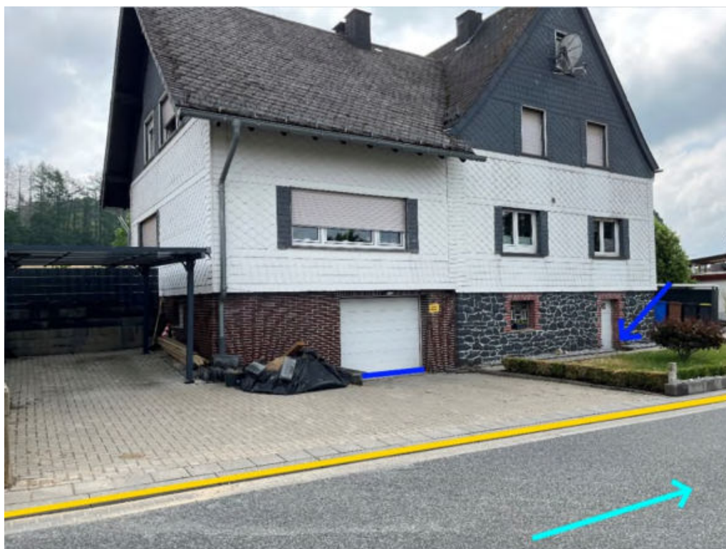
Abbildung 41: Notabflussweg „Bindweider Straße“ mit Fließrichtung (hellblau), Objektschutzmaßnahmen (dunkelblau) und Bordanlagen (gelb)
