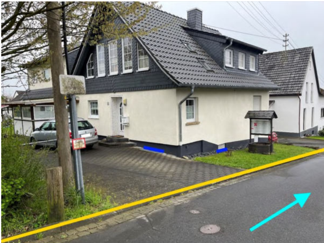
Abbildung 237: Notabflussweg "Limbacher Straße" mit Fließrichtung (hellblau), Objektschutzmaßnahmen (dunkelblau) und Bordanlagen (gelb)
