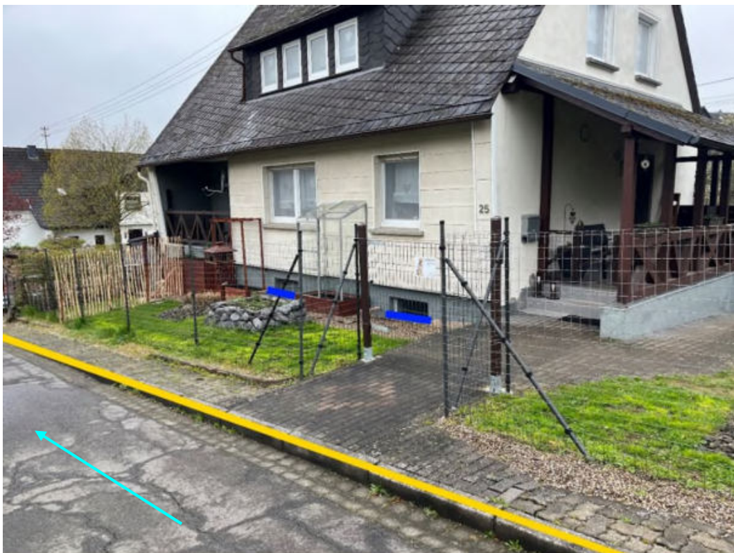
Abbildung 236: Notabflussweg "Limbacher Straße" mit Fließrichtung (hellblau), Objektschutzmaßnahmen (dunkelblau) und Bordanlagen (gelb)
