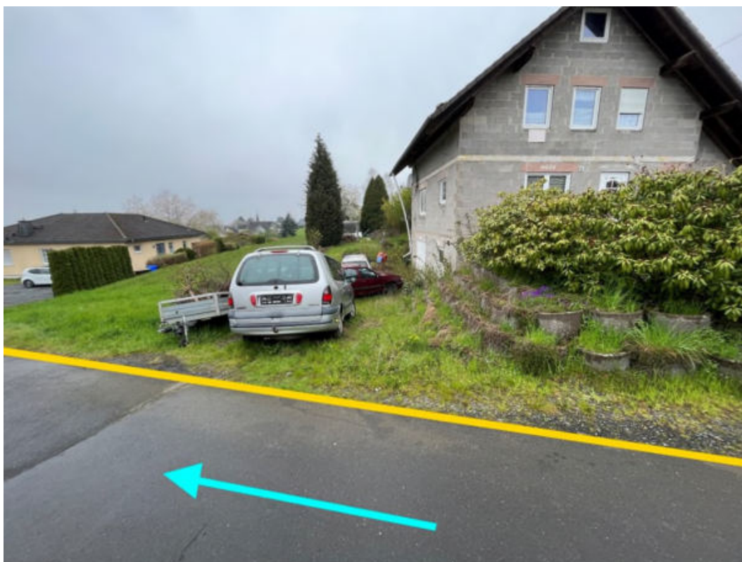
Abbildung 211: Notabflussweg "Höhenstraße" mit Fließrichtung (hellblau) und Bordanlagen (gelb)
