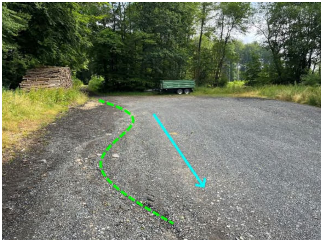
Abbildung 54: Notabflussweg „Poststraße" mit Fließrichtung (hellblau) und Befestigung des Fließweges (grün)
