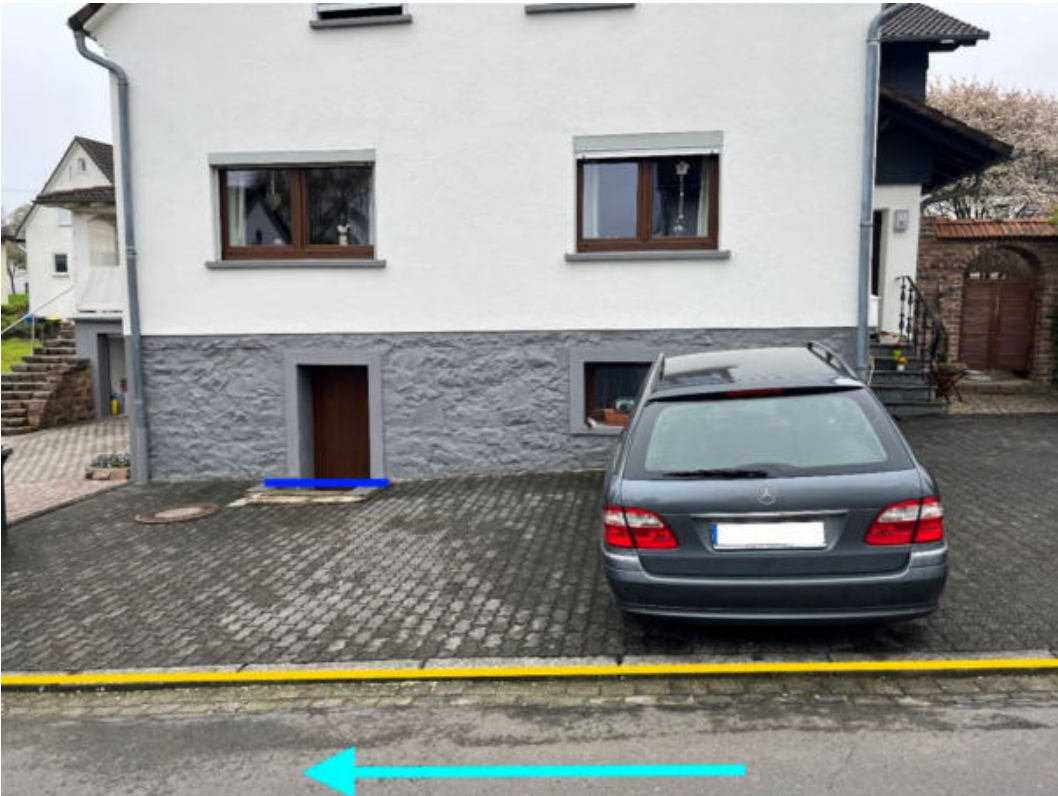
Abbildung 240: Notabflussweg "Limbacher Straße" mit Fließrichtung (hellblau), Objektschutzmaßnahmen (dunkelblau) und Bordanlagen (gelb)
