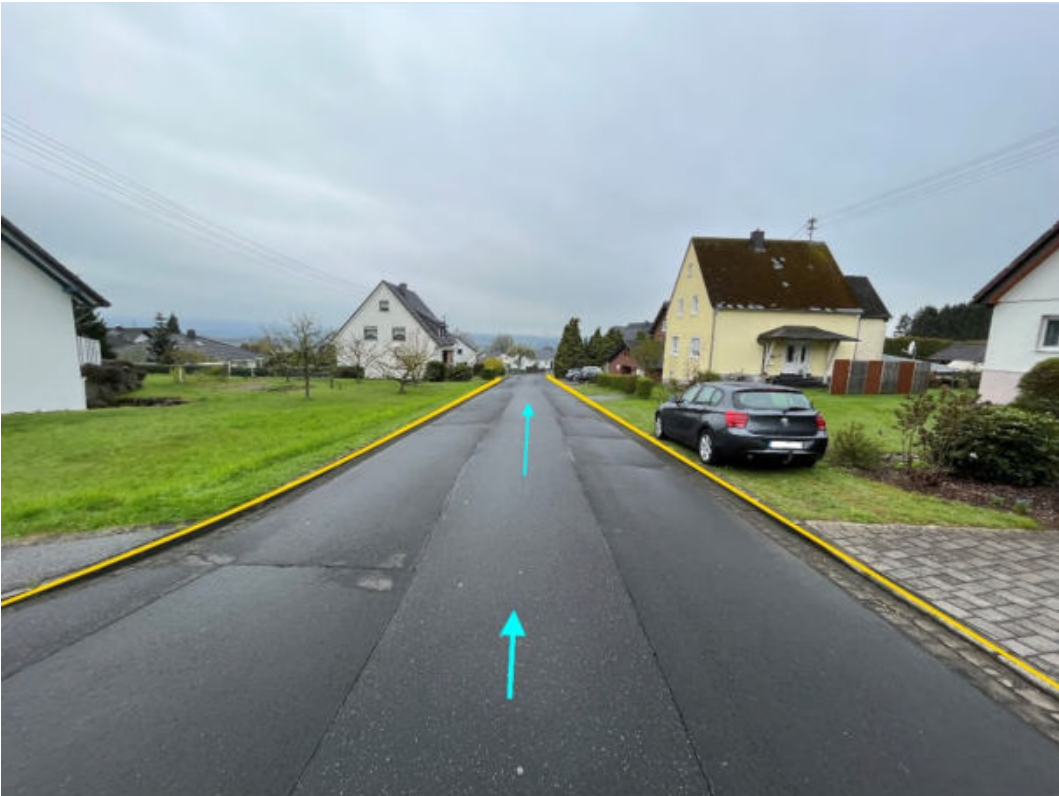
Abbildung 101: Notabflussweg "Schulstraße" mit Fließrichtung (hellblau) und Bordanlagen (gelb)
