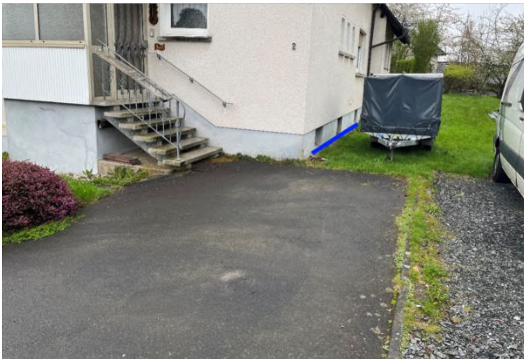
Abbildung 189: Notabflussweg "Rosenweg" mit Objektschutzmaßnahmen (dunkelblau)
