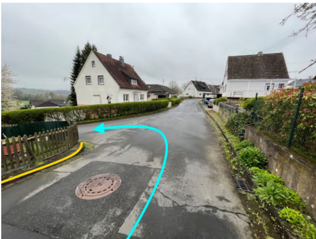
Abbildung 244: Notabflussweg "Limbacher Straße" mit Fließrichtung (hellblau) und Bordanlagen (gelb)
