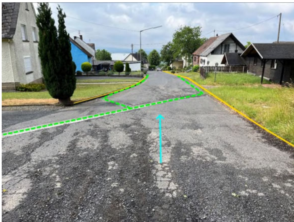
Abbildung 55: Notabflussweg „Poststraße“ mit Fließrichtung (hellblau) und Instandsetzung der Entwässerungseinrichtung (grün)
