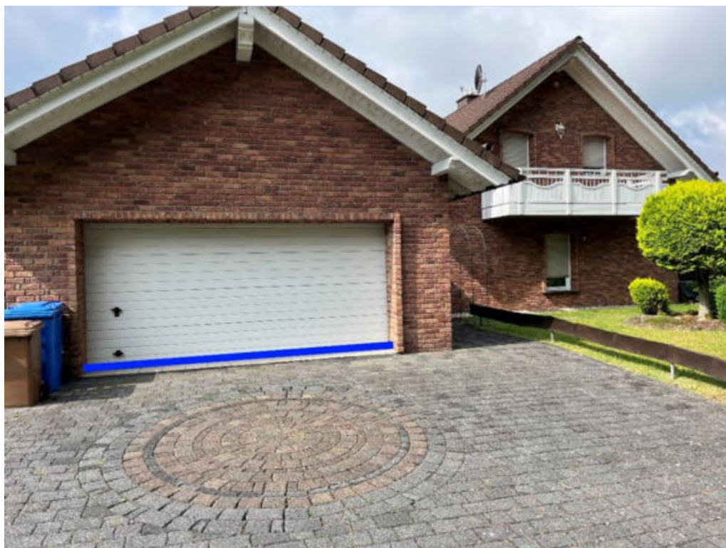
Abbildung 49: Notabflussweg „Poststraße" mit Objektschutzmaßnahmen (dunkelblau)
