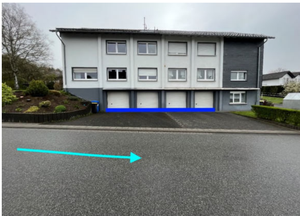
Abbildung 29: Notabflussweg "Bindweider Straße" mit Fließrichtung (hellblau) und Objektschutzmaßnahmen (dunkelblau)
