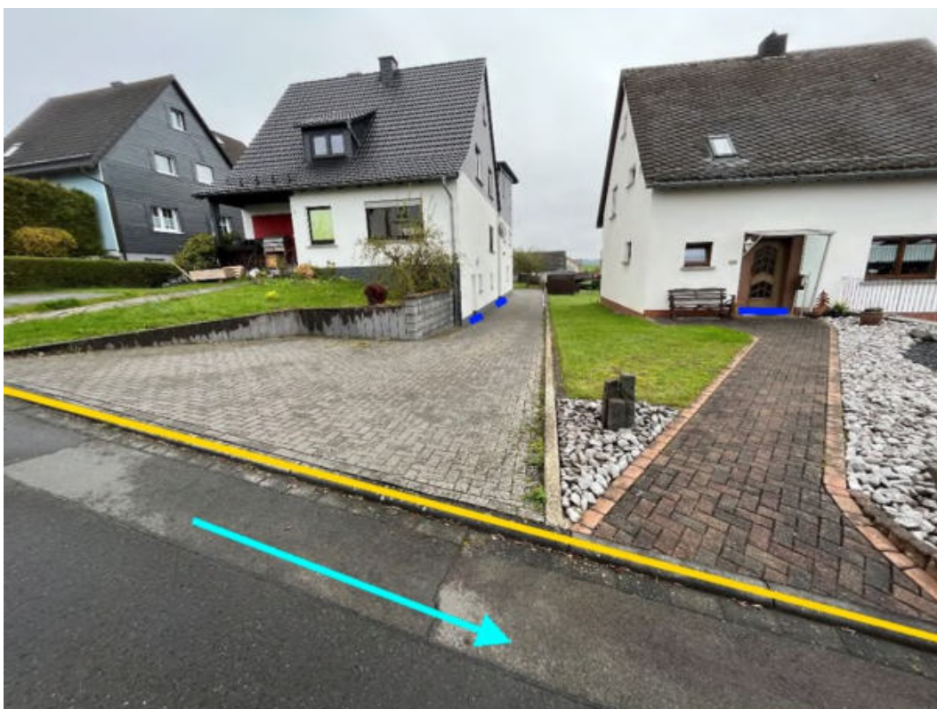
Abbildung 190: Notabflussweg "Rosenweg" mit Fließrichtung (hellblau), Objektschutzmaßnahmen (dunkelblau) und Bordanlagen (gelb)
