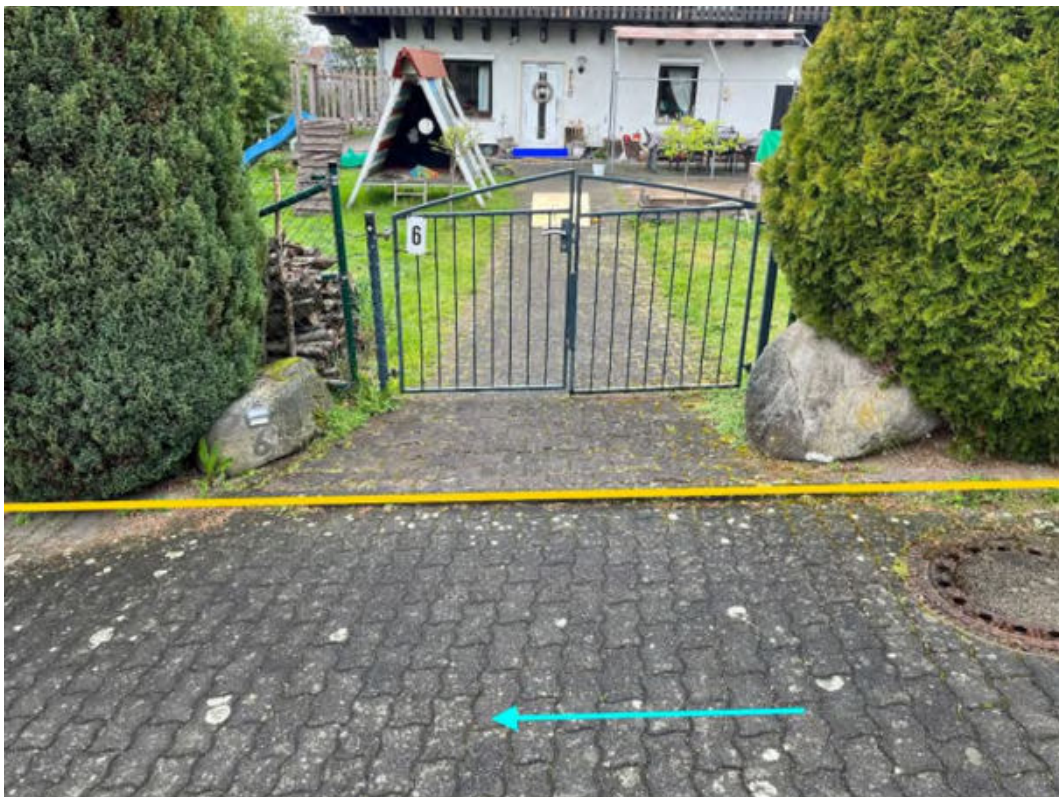
Abbildung 198: Notabflussweg "Rosenweg" mit Fließrichtung (hellblau), Objektschutzmaßnahmen (dunkelblau) und Bordanlagen (gelb)
