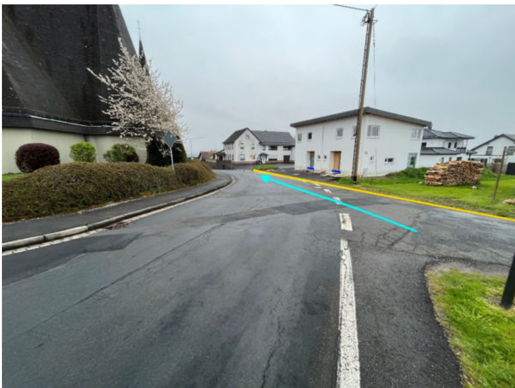
Abbildung 179: Notabflussweg "Hauptstraße" mit Fließrichtung (hellblau) und Bordanlagen (gelb)
