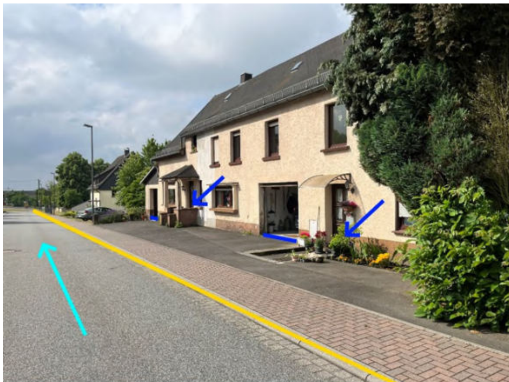
Abbildung 35: Notabflussweg „Bindweider Straße“ mit Fließrichtung (hellblau), Objektschutzmaßnahmen (dunkelblau) und Bordanlagen (gelb)
