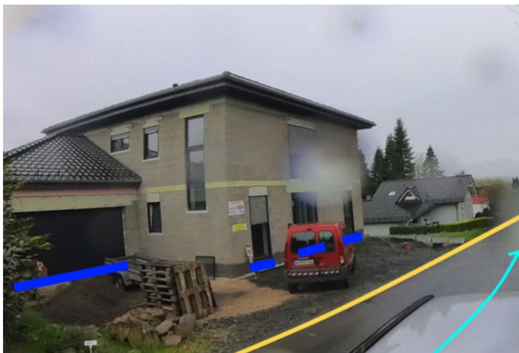
Abbildung 271: Notabflussweg "Südhang" mit Fließrichtung (hellblau), Objektschutzmaßnahmen (dunkelblau) und Bordanlagen (gelb)
