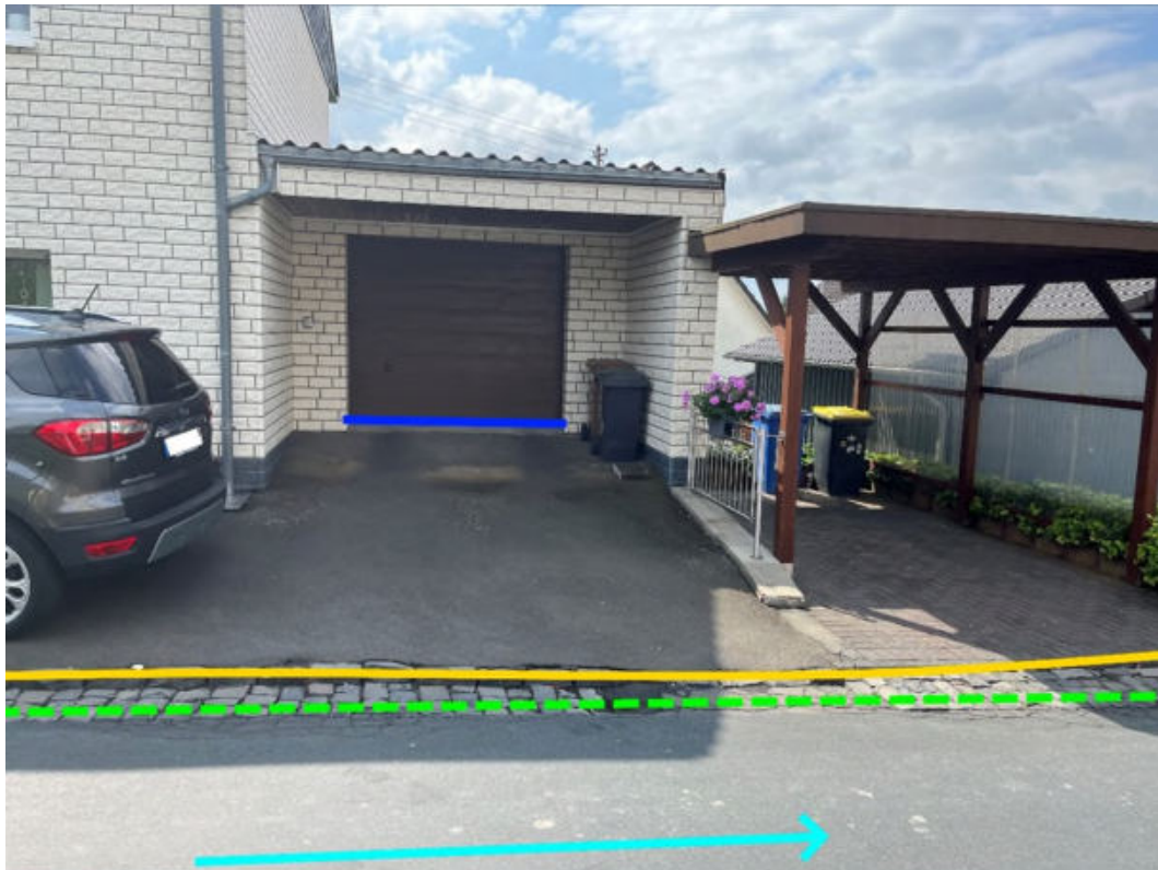
Abbildung 168: Notabflussweg "Hauptstraße" mit Fließrichtung (hellblau), Objektschutzmaßnahmen (dunkelblau), Instandsetzung der Entwässerungseinrichtung (hellgrün) und Bordanlagen (gelb)
