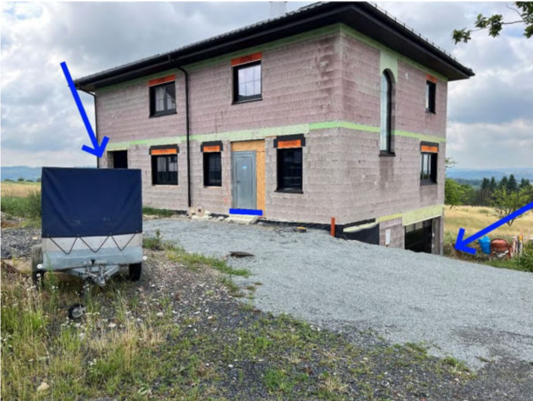
Abbildung 142: Notabflussweg "Hauptstraße" mit Objektschutzmaßnahmen (dunkelblau)
