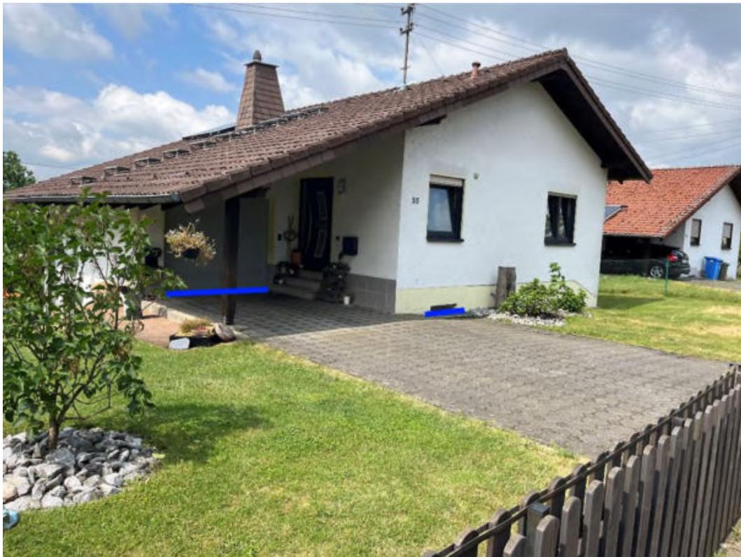
Abbildung 92: Notabflussweg „Hachenburger Straße" mit Objektschutzmaßnahmen (dunkelblau)
