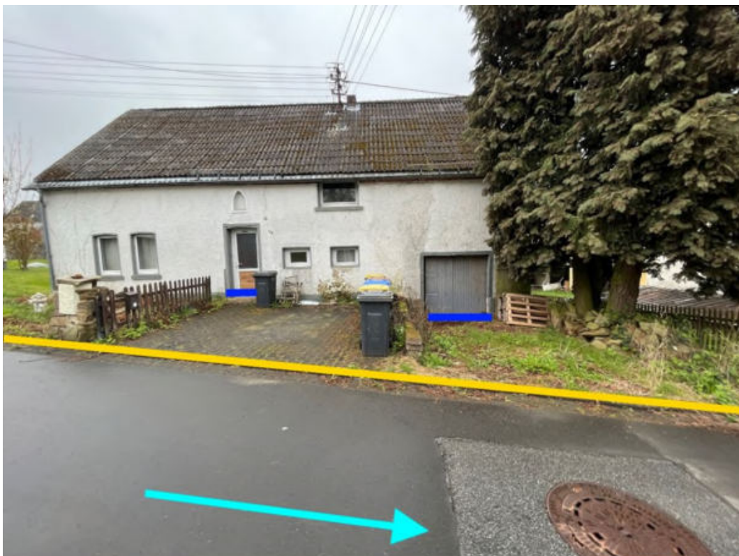
Abbildung 242: Notabflussweg "Limbacher Straße" mit Fließrichtung (hellblau), Objektschutzmaßnahmen (dunkelblau) und Bordanlagen (gelb)
