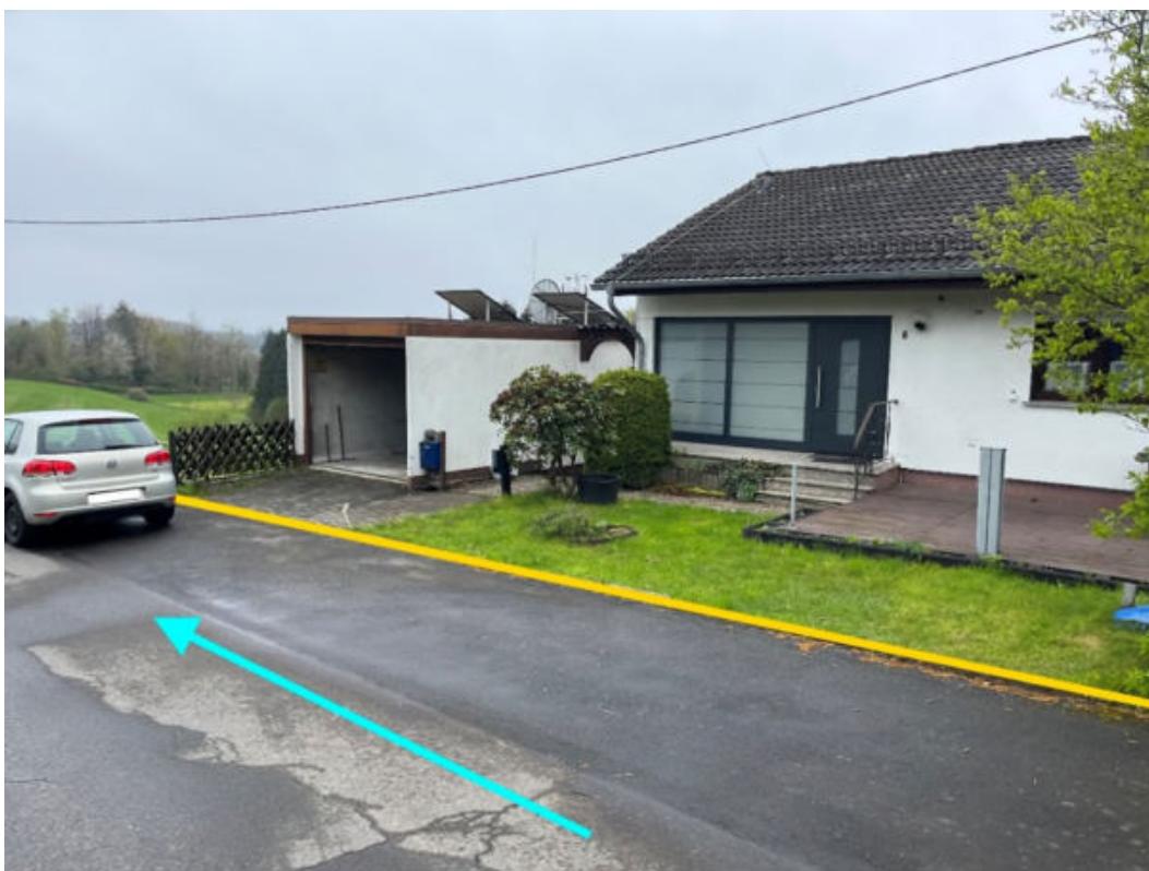
Abbildung 254: Notabflussweg "Limbacher Straße" mit Fließrichtung (hellblau) und Bordanlagen (gelb)
