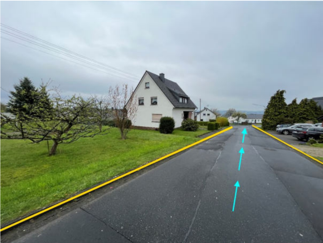
Abbildung 103: Notabflussweg "Schulstraße" mit Fließrichtung (hellblau), Objektschutzmaßnahmen (dunkelblau), Aufwallung (orange) und Bordanlagen (gelb)
