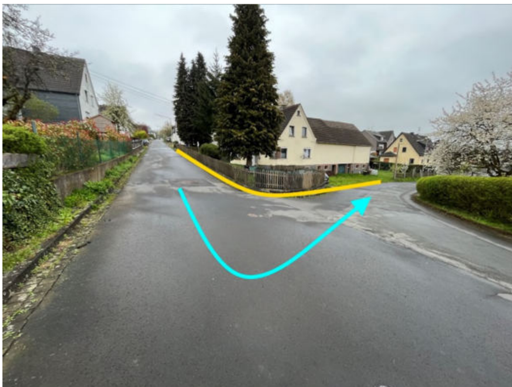
Abbildung 245: Notabflussweg "Limbacher Straße" mit Fließrichtung (hellblau) und Bordanlagen (gelb)
