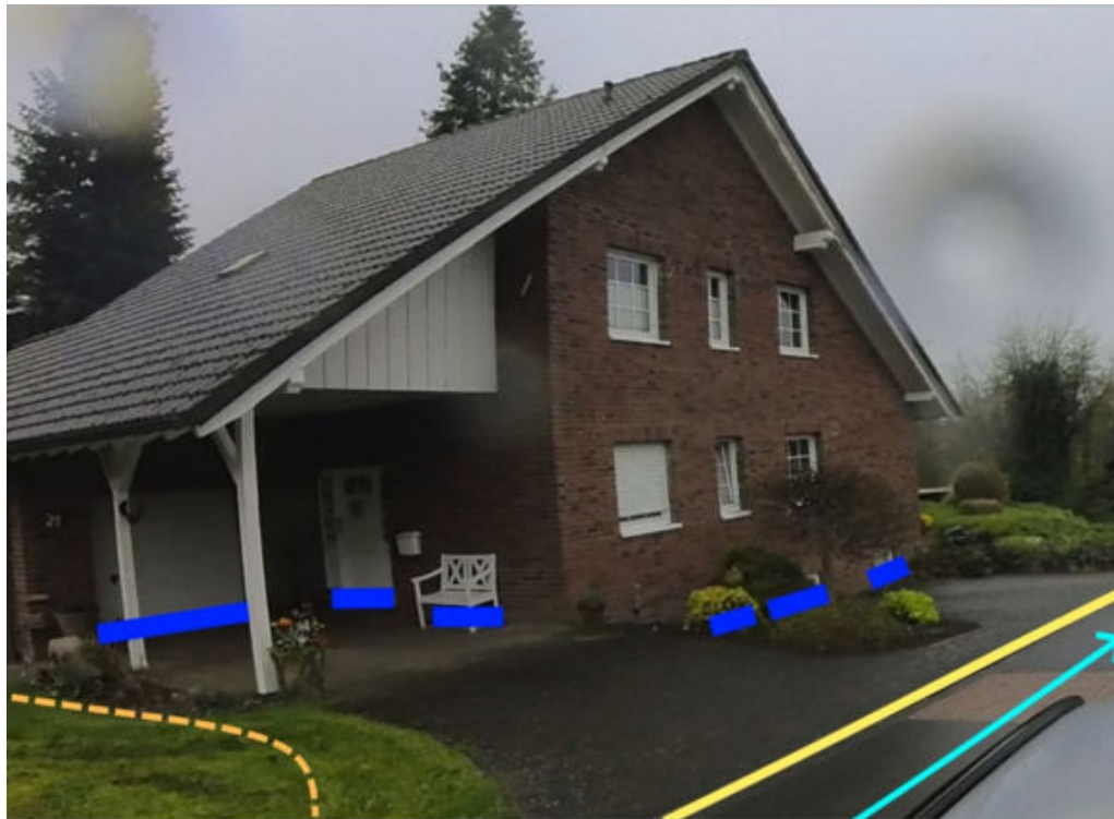
Abbildung 275: Notabflussweg "Südhang" mit Fließrichtung (hellblau), Objektschutzmaßnahmen, (dunkelblau), Aufwallung (orange) und Bordanlagen (gelb)
