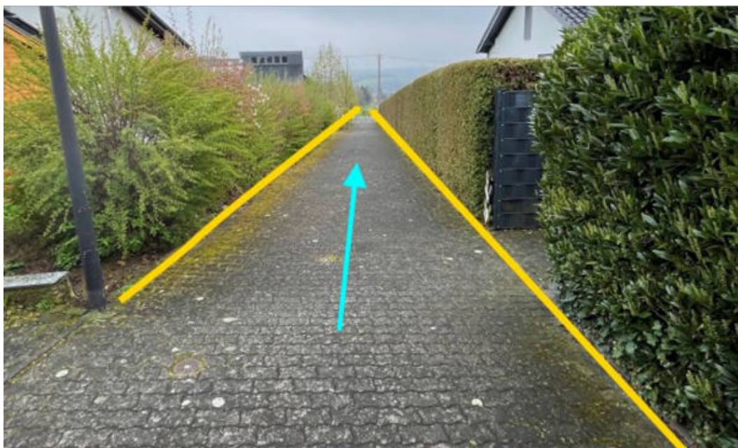
Abbildung 201: Notabflussweg "Rosenweg" mit Fließrichtung (hellblau), Objektschutzmaßnahmen (dunkelblau) und Bordanlagen (gelb)
