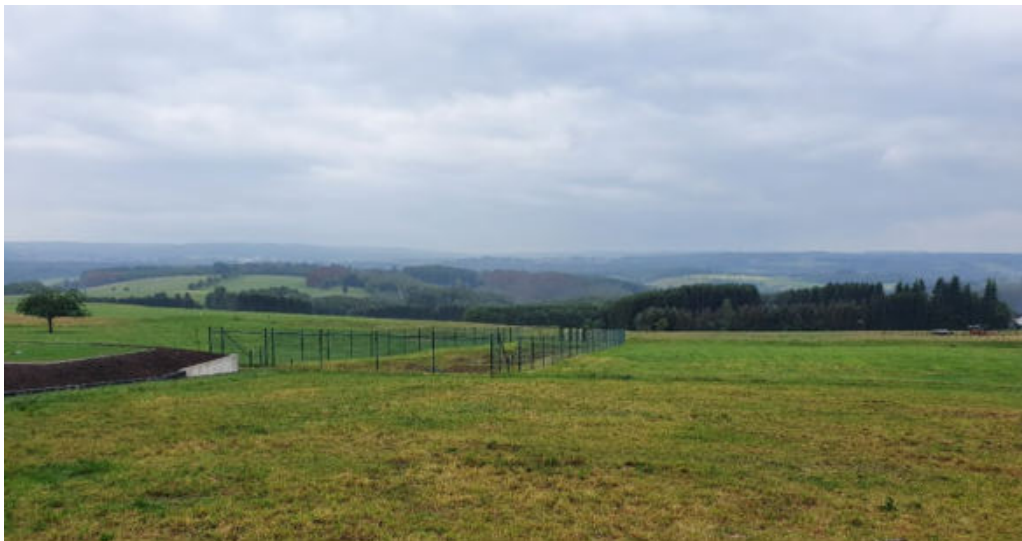
Abbildung 25: Kaskaden im Neubaugebiet zur Aufnahme und Ableitung von Oberflächenwasser
