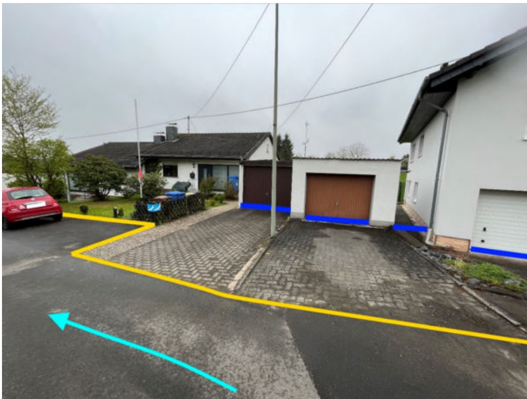
Abbildung 253: Notabflussweg "Limbacher Straße" mit Fließrichtung (hellblau), Objektschutzmaßnahmen (dunkelblau) und Bordanlagen (gelb)
