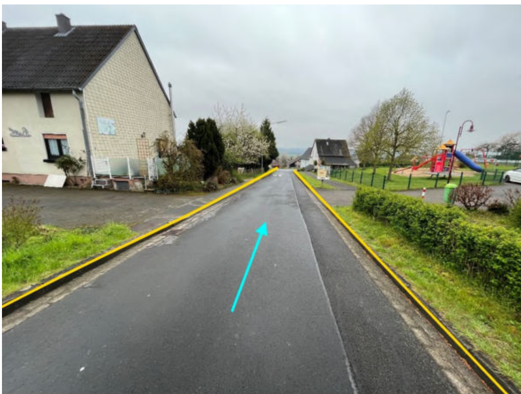
Abbildung 114: Notabflussweg "Schulstraße" mit Fließrichtung (hellblau) und Bordanlagen (gelb)
