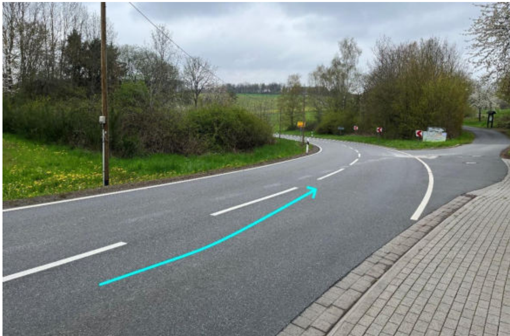
Abbildung 157: Notabflussweg "Wissener Straße" mit Fließrichtung (hellblau)
