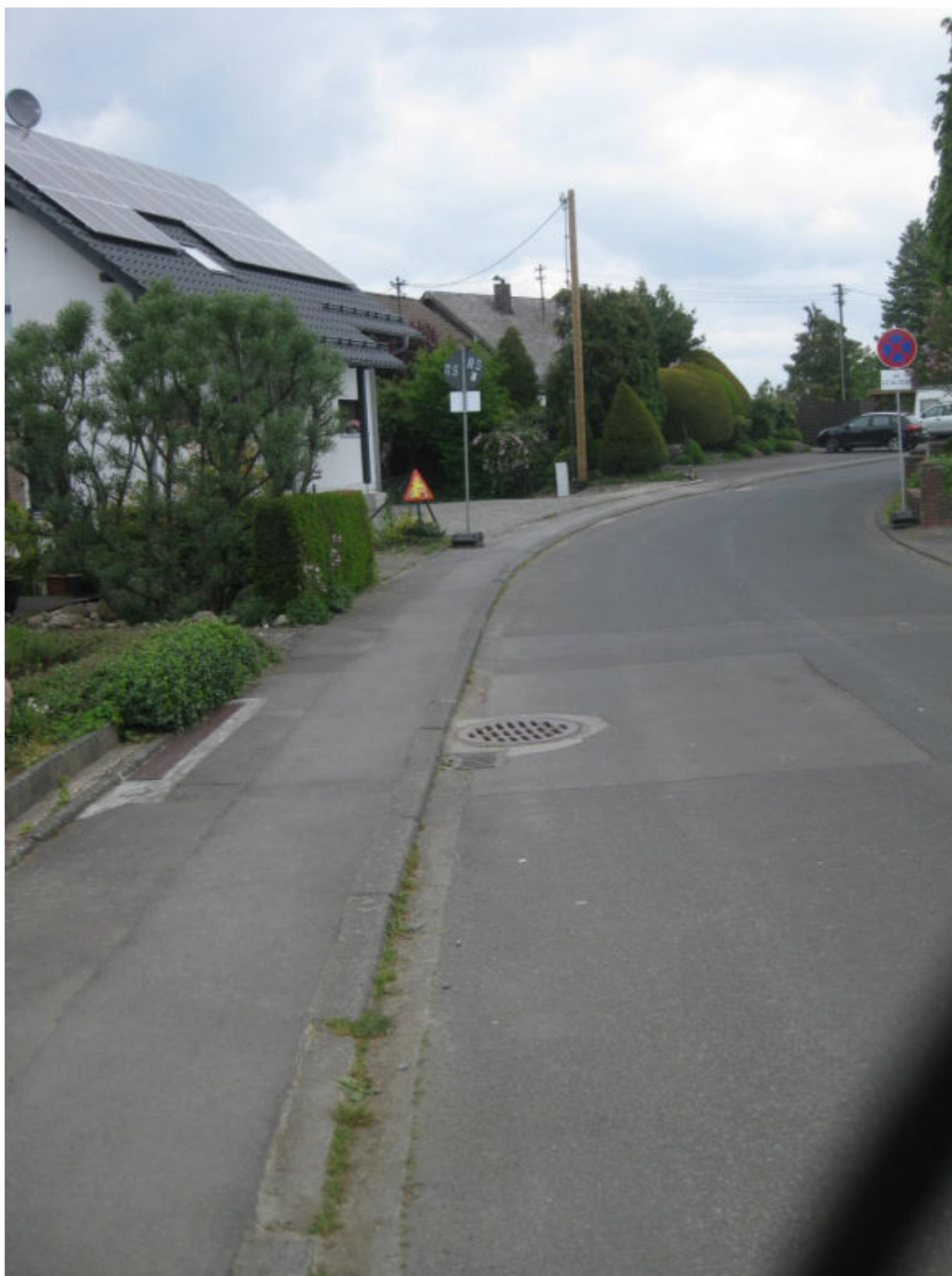
Abbildung 14: Gebhardshain, Einläufe am Tiefpunkt in der Ringstraße (Haus Nr. 25)
