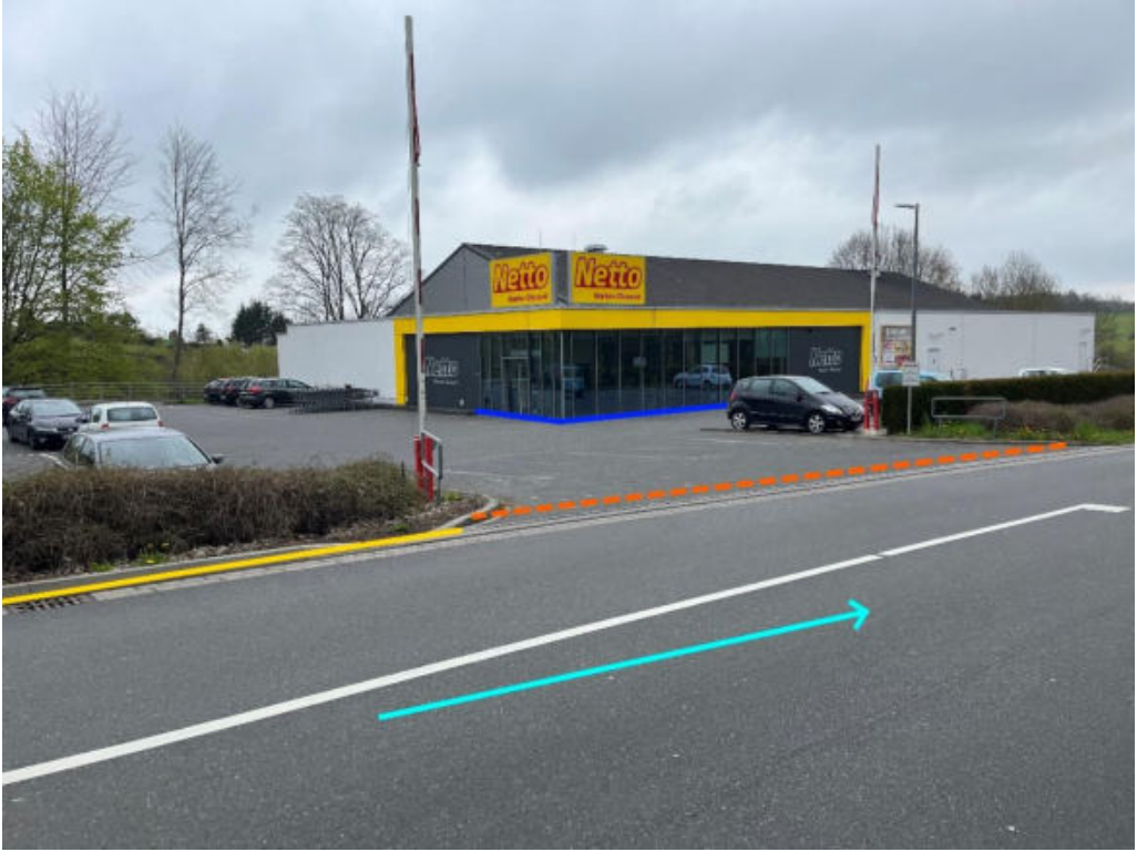
Abbildung 156: Notabflussweg "Wissener Straße" mit Fließrichtung (hellblau), Objektschutzmaßnahmen (dunkelblau), Aufwallung (orange) und Bordanlagen (gelb)
