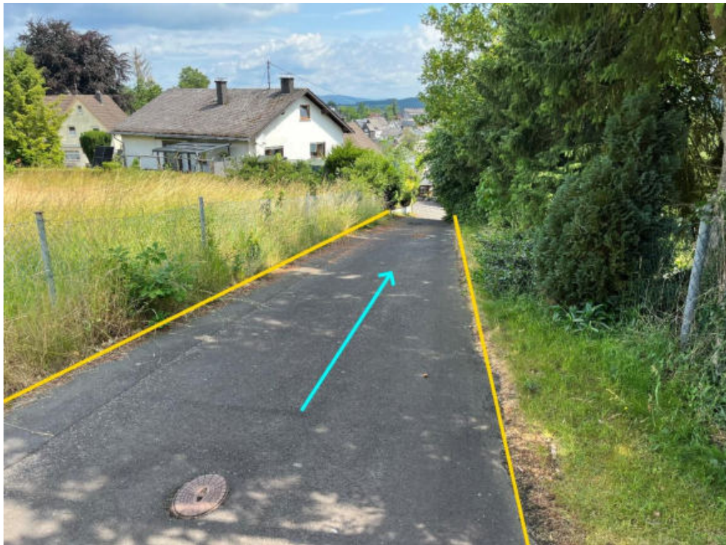
Abbildung 47: Notabflussweg "Tannenweg" mit Fließrichtung (hellblau) und Bordanlagen (gelb)
