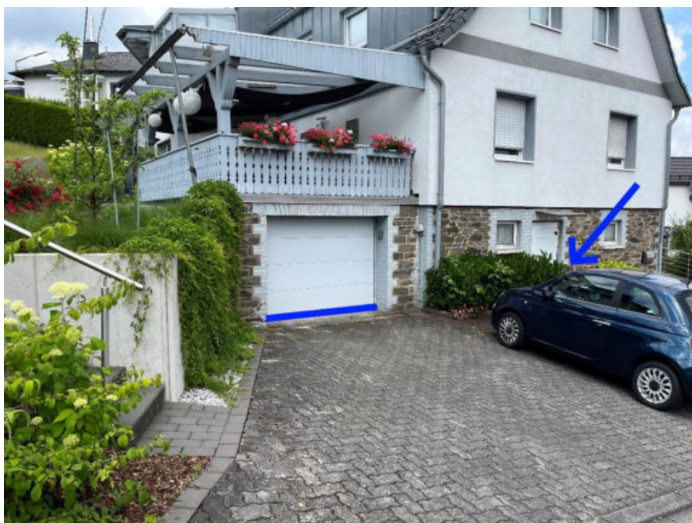
Abbildung 62: Notabflussweg "Tannenweg" mit Objektschutzmaßnahmen (dunkelblau)
