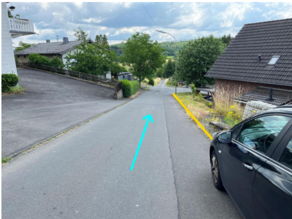
Abbildung 168: Notabflussweg "Schulstraße" mit Fließrichtung (hellblau) und Bordanlagen (gelb)
