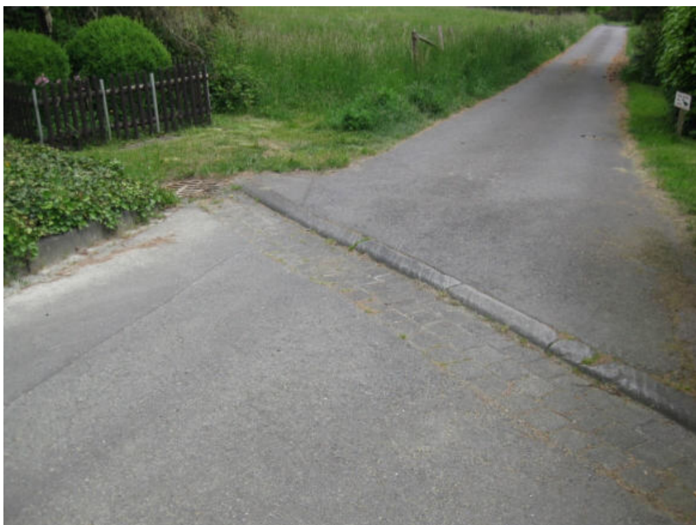
Abbildung 19: Gebhardshain, Rinne und Einlauf in der Verlängerung Schulstraße
