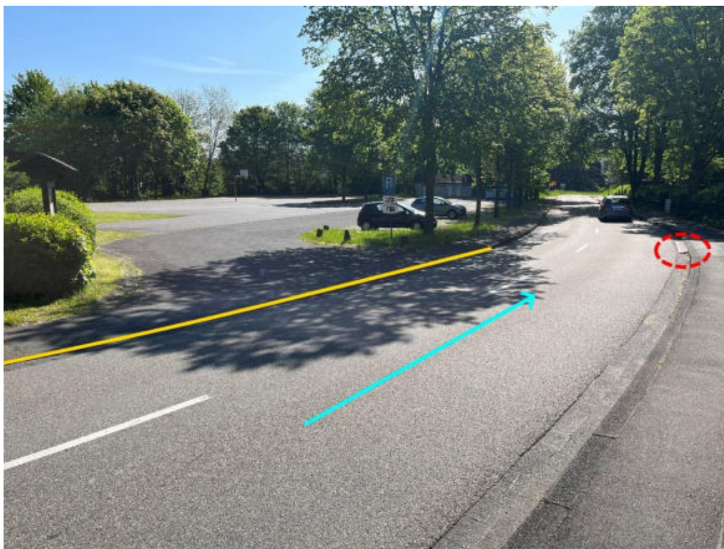
Abbildung 121: Notabflussweg "Steinebacher Straße" mit Fließrichtung (hellblau), Instandhaltung der Entwässerungseinrichtung (rot) und Bordanlagen (gelb)
