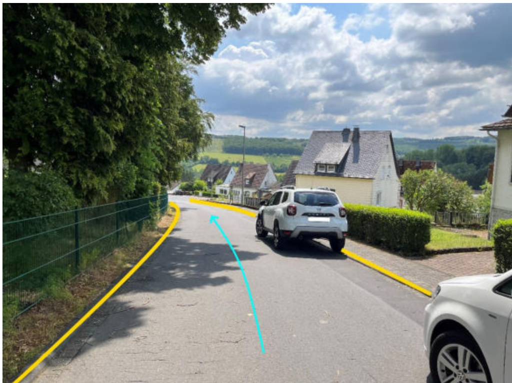
Abbildung 160: Notabflussweg "Schulstraße" mit Fließrichtung (hellblau) und Bordanlagen (gelb)
