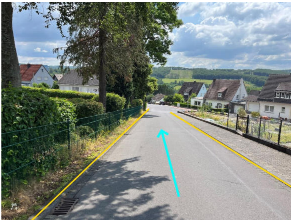
Abbildung 163: Notabflussweg "Schulstraße" mit Fließrichtung (hellblau) und Bordanlagen (gelb)
