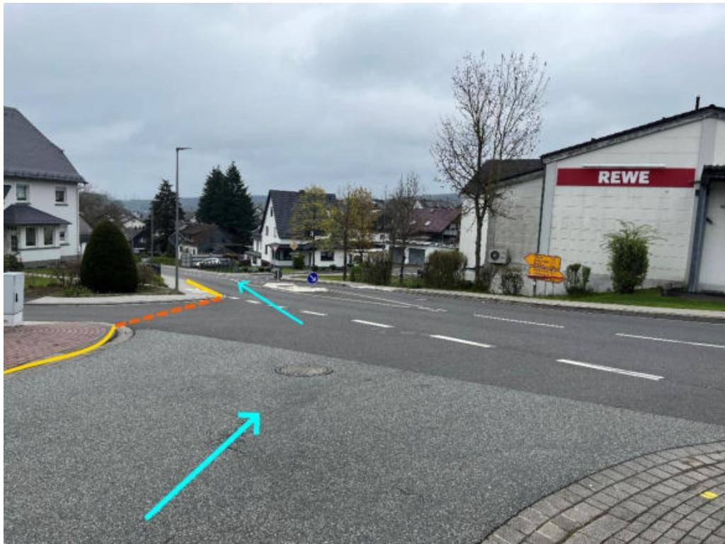
Abbildung 143: Notabflussweg "Grafenstraße" mit Fließrichtung (hellblau), Aufwallung (orange) und Bordanlagen (gelb)
