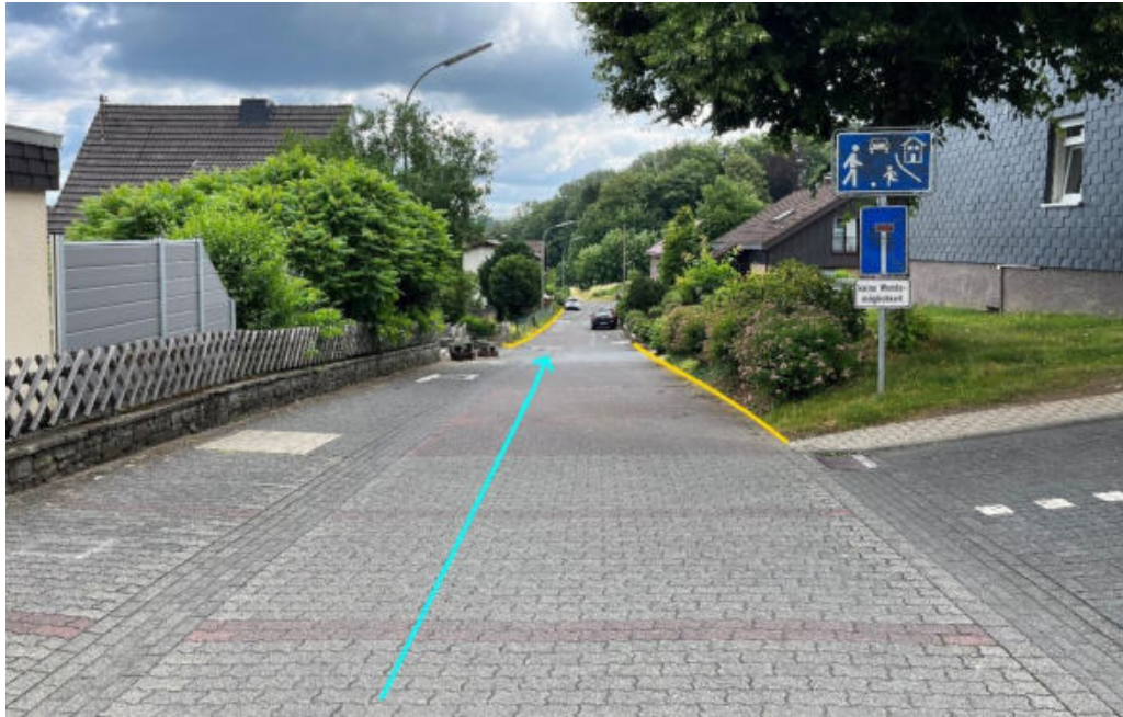
Abbildung 103: Notabflussweg "Steimelsgarten" mit Fließrichtung (hellblau) und Bordanlagen (gelb)
