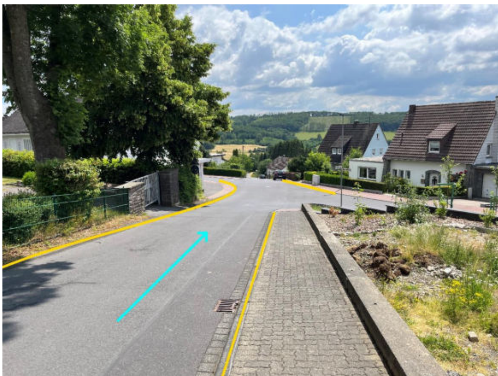
Abbildung 164: Notabflussweg "Schulstraße" mit Fließrichtung (hellblau) und Bordanlagen (gelb)
