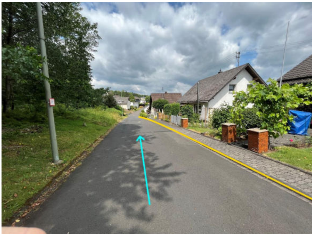
Abbildung 50: Notabflussweg "Tannenweg" mit Fließrichtung (hellblau) und Bordanlagen (gelb)
