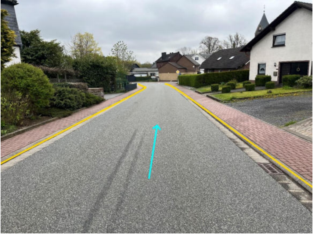
Abbildung 130: Notabflussweg "Liebergstraße" mit Fließrichtung (hellblau) und Bordanlagen (gelb)
