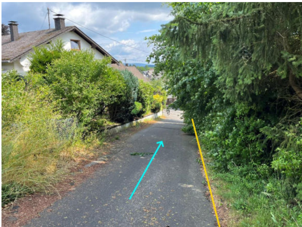
Abbildung 48: Notabflussweg "Tannenweg" mit Fließrichtung (hellblau) und Bordanlagen (gelb)
