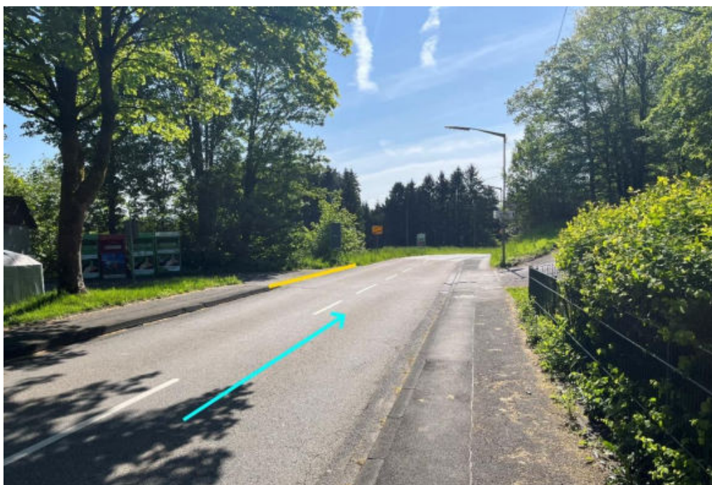
Abbildung 122: Notabflussweg "Steinebacher Straße" mit Fließrichtung (hellblau) und Bordanlagen (gelb)
