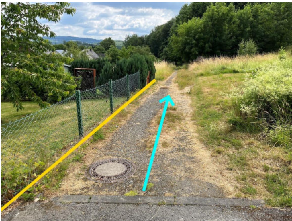
Abbildung 111: Notabflussweg "Steimelsgarten" mit Fließrichtung (hellblau), Bordanlagen (gelb)
