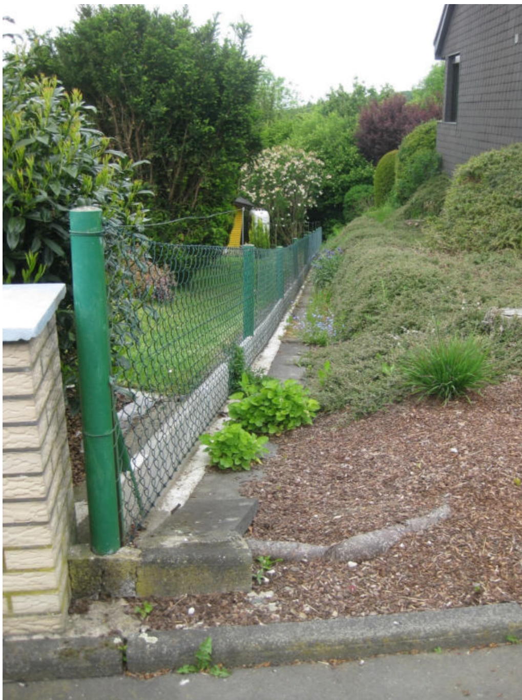
Abbildung 15: natürlicher Fließweg über Grundstück Ringstraße Haus Nr. 25
