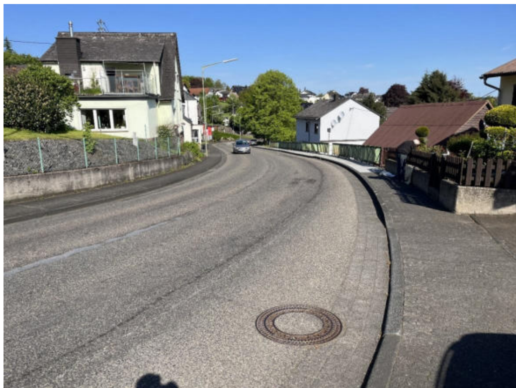
Abbildung 28: Gebhardshain, Fließweg Hachenburger Straße
