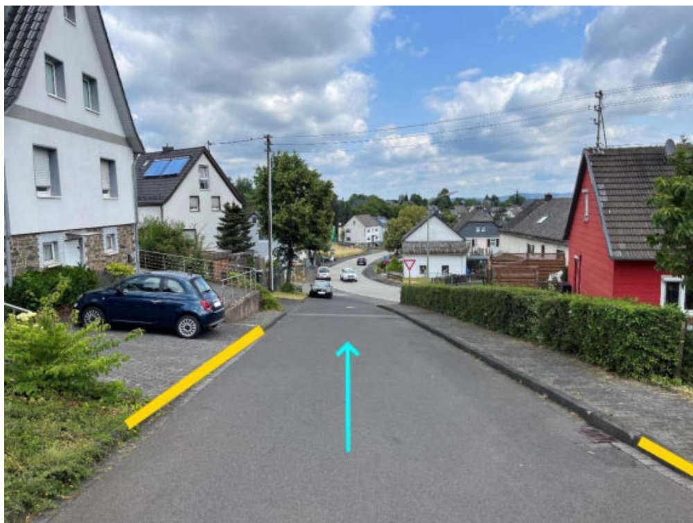
Abbildung 61: Notabflussweg "Tannenweg" mit Fließrichtung (hellblau) und Bordanlagen (gelb)
