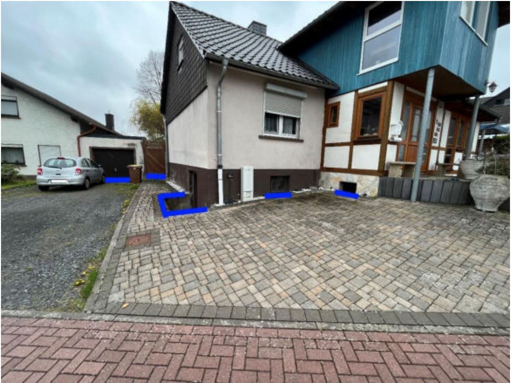
Abbildung 131: Notabflussweg "Liebergstraße" mit Objektschutzmaßnahmen (dunkelblau)
