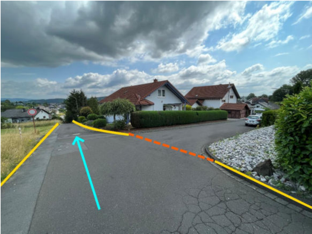
Abbildung 43: Notabflussweg "Tannenweg" mit Fließrichtung (hellblau), Objektschutzmaßnahmen (dunkelblau), Aufwallung (orange) und Bordanlagen (gelb)
