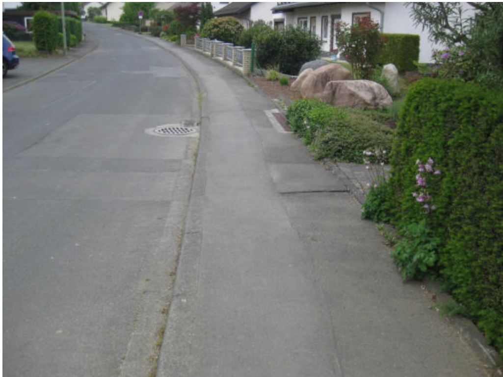
Abbildung 13: Gebhardshain, Tiefpunkt in der Ringstraße
