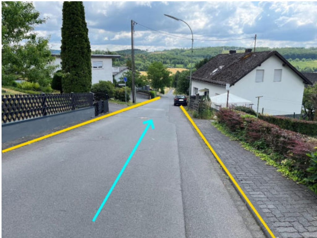
Abbildung 167: Notabflussweg "Schulstraße" mit Fließrichtung (hellblau) und Bordanlagen (gelb)
