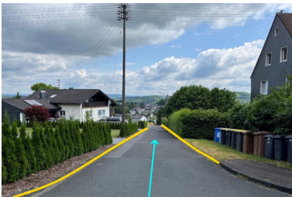
Abbildung 38: Notabflussweg "Tannenweg" mit Fließrichtung (hellblau) und Bordanlagen (gelb)
