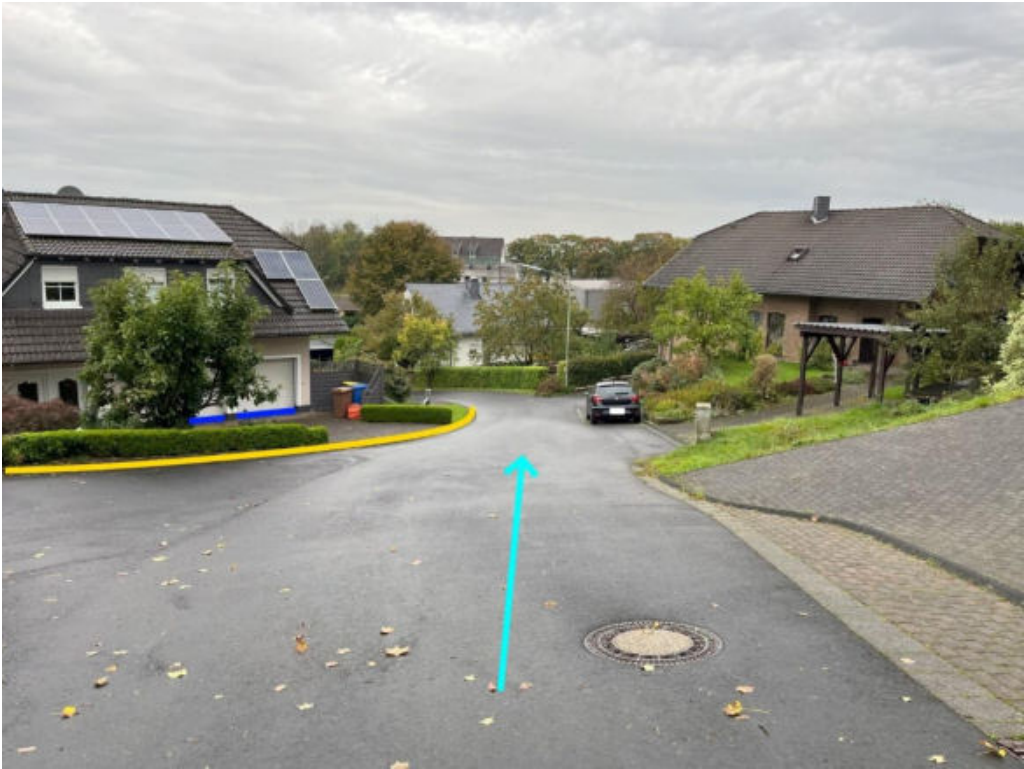
Abbildung 51: Notabflussweg "Auf den Schladen" mit Fließrichtung (hellblau), Bordanlagen (gelb) und Objektschutzmaßnahmen (blau)
