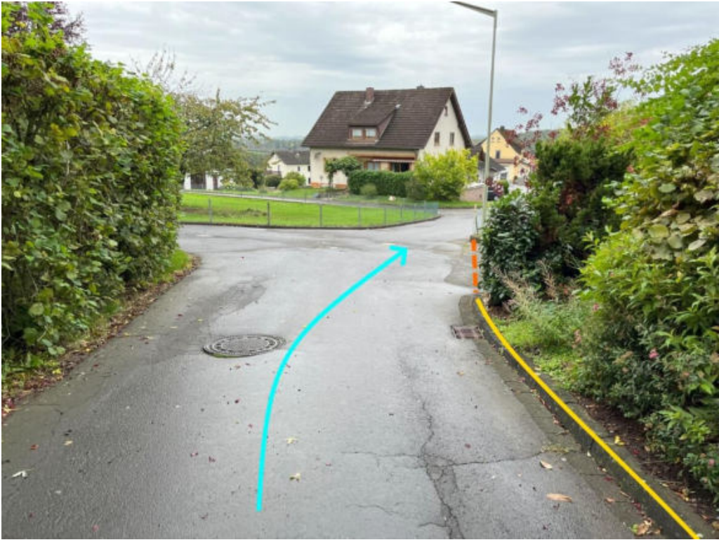
Abbildung 140: Notabflussweg "Nordstraße" mit Fließrichtung (hellblau), Bordanlagen (gelb) und Aufwallung (orange)
