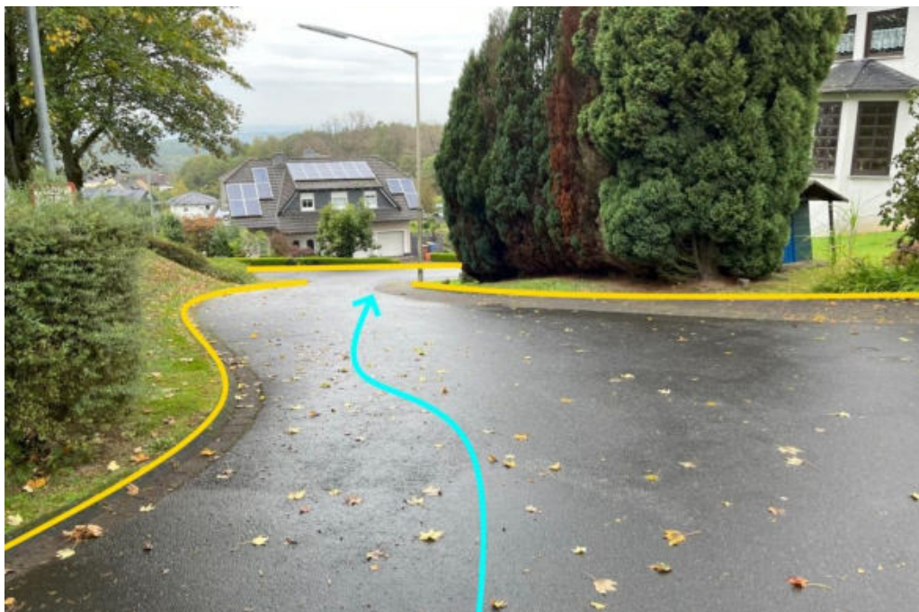
Abbildung 50: Notabflussweg "Auf den Schladen" mit Fließrichtung (hellblau) und Bordanlagen (gelb)
