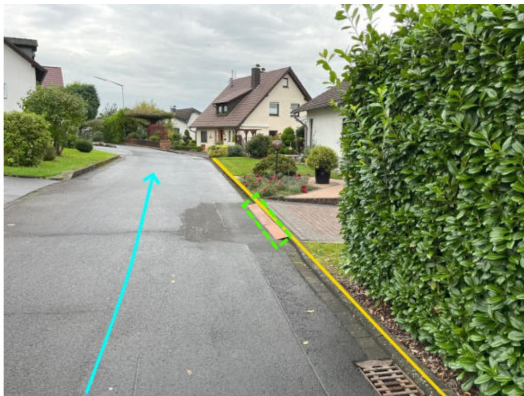
Abbildung 131: Notabflussweg "Nordstraße" mit Fließrichtung (hellblau), Bordanlagen (gelb) und Instandsetzung der Entwässerungseinrichtung (hellgrün)
