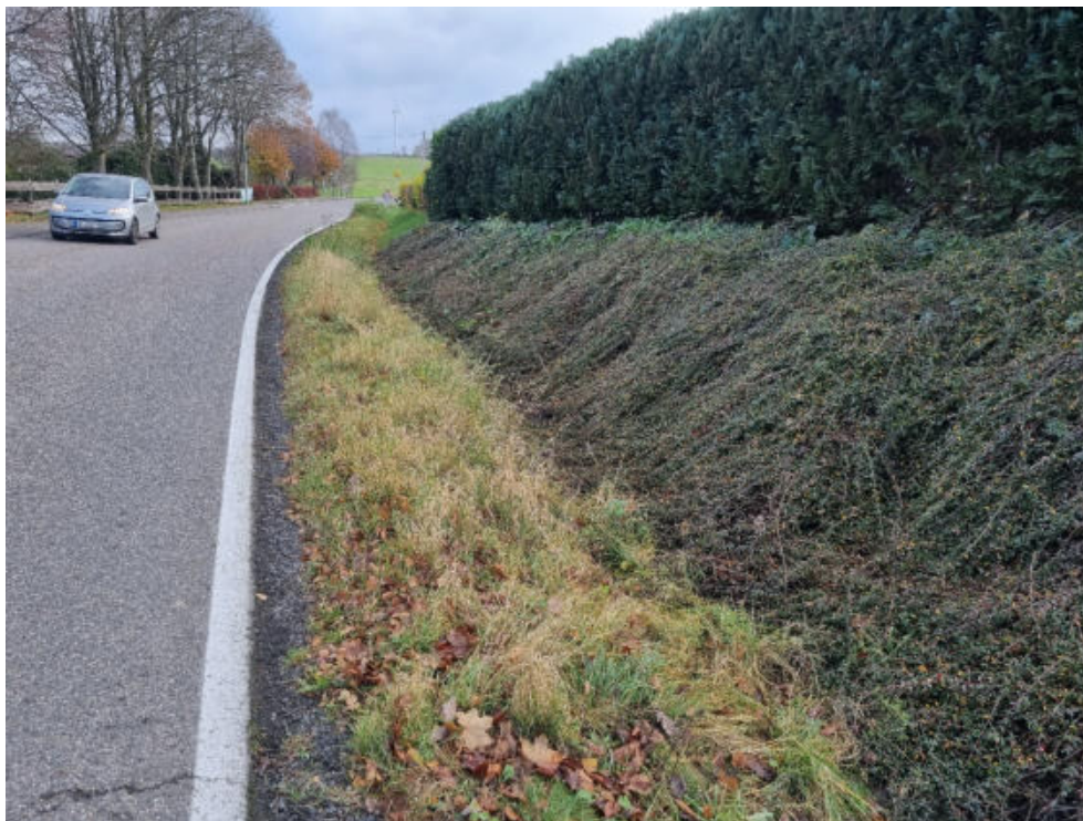
Abbildung 38: Graben mit Einlauf entlang der Hauptstraße; Gefahrenpunkt 2.15
