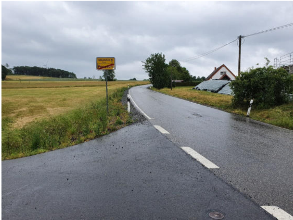
Abbildung 8: Splitt auf Fahrbahn K123; Gefahrenpunkt 2.6
