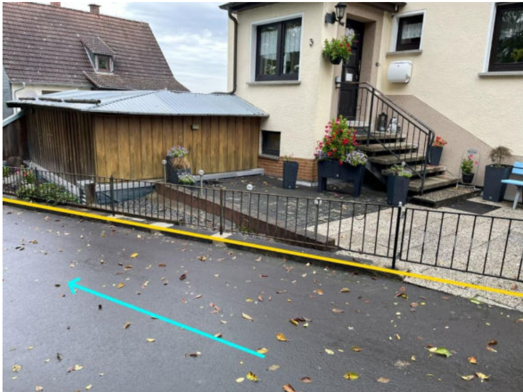
Abbildung 119: Notabflussweg "Löhrstraße" mit Fließrichtung (hellblau), Bordanlagen (gelb) und Instandsetzung der Entwässerungseinrichtung (hellgrün)
