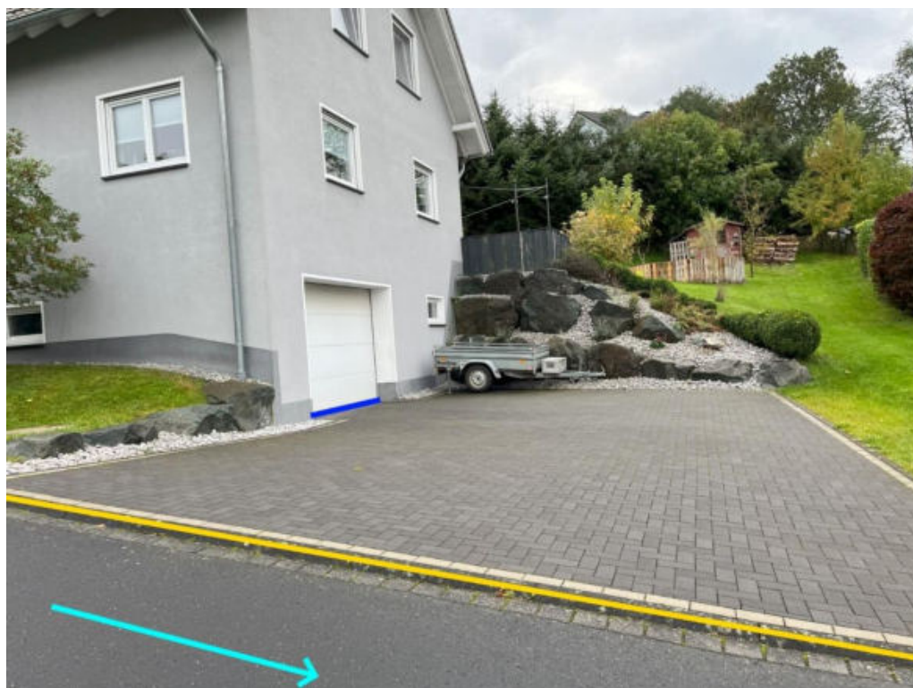
Abbildung 56: Notabflussweg "Auf den Schladen" mit Fließrichtung (hellblau), Bordanlagen (gelb) und Objektschutzmaßnahmen (blau)
