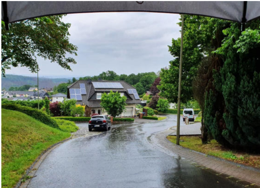
Abbildung 20: Kurvenbereich „Auf den Schladen“/Zulauf von Oberflächenwasser auf Haus Nr. 6; Gefahrenpunkt 2.1
