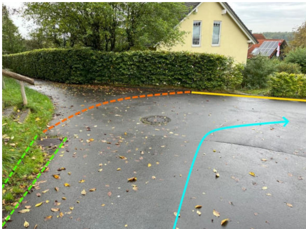
Abbildung 124: Notabflussweg "Löhrstraße" mit Fließrichtung (hellblau), Bordanlagen (gelb), Aufwallung (orange) und Instandsetzung der Entwässerungseinrichtung (hellgrün)
