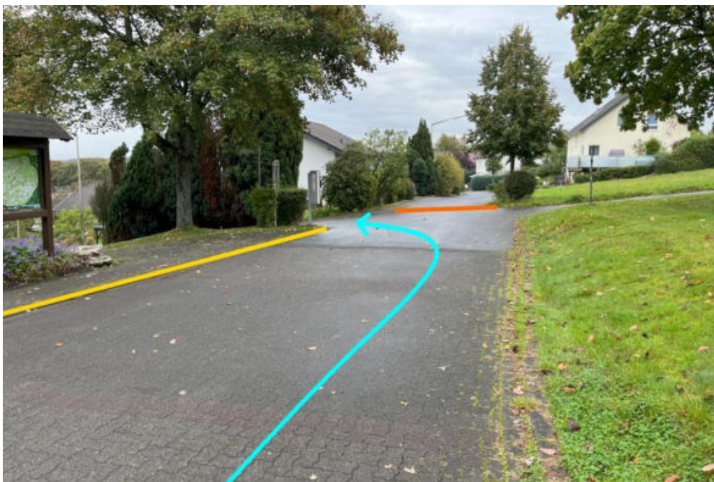
Abbildung 48: Notabflussweg "Feldstraße" mit Fließrichtung (hellblau), Bordanlagen (gelb) und Aufwallung (orange)
