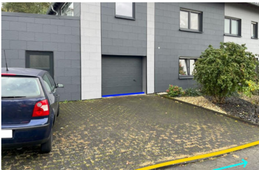
Abbildung 60: Notabflussweg "Auf den Zäunen" mit Fließrichtung (hellblau), Bordanlagen (gelb) und Objektschutzmaßnahmen (blau)
