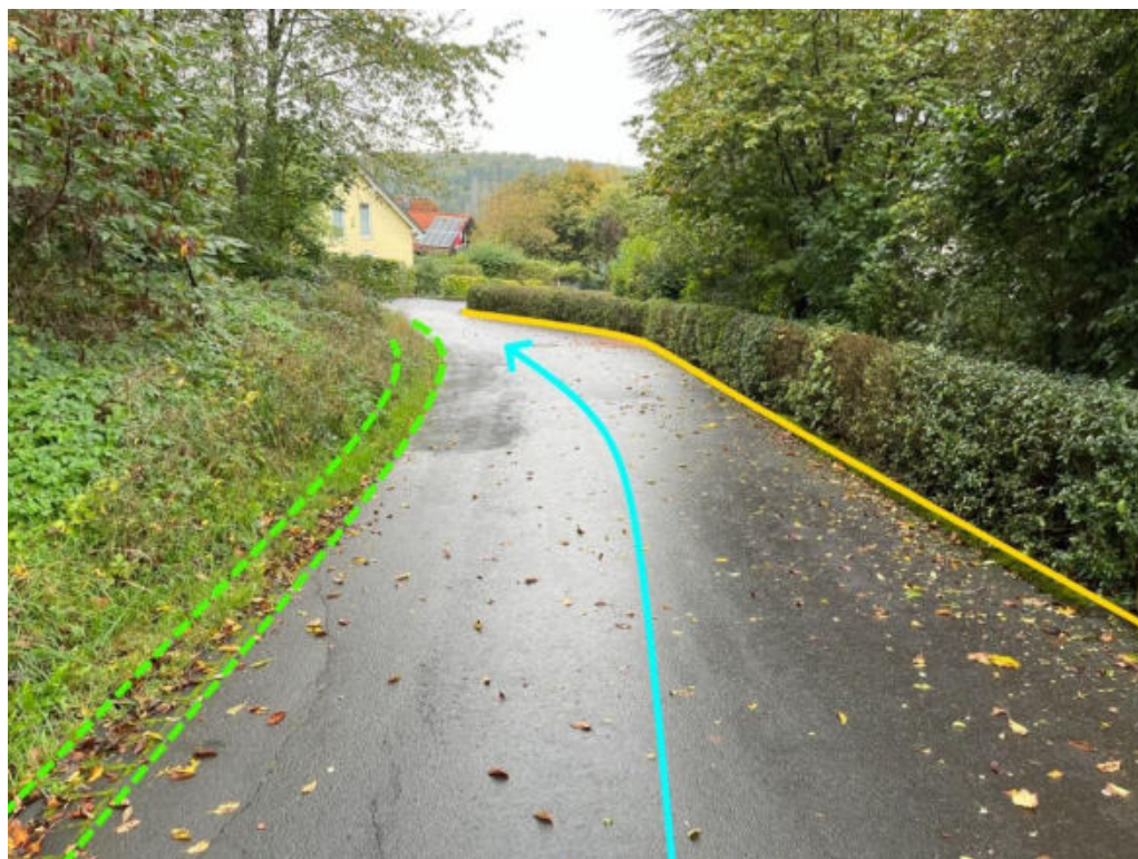
Abbildung 123: Notabflussweg "Löhrstraße" mit Fließrichtung (hellblau), Bordanlagen (gelb) und Instandsetzung der Entwässerungseinrichtung (hellgrün)
