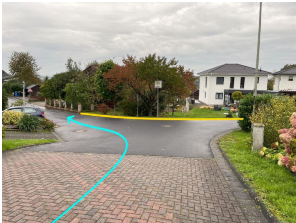
Abbildung 58: Notabflussweg "Auf den Schladen" mit Fließrichtung (hellblau), Bordanlagen (gelb) und Kreuzung mit „Auf den Zäunen“
