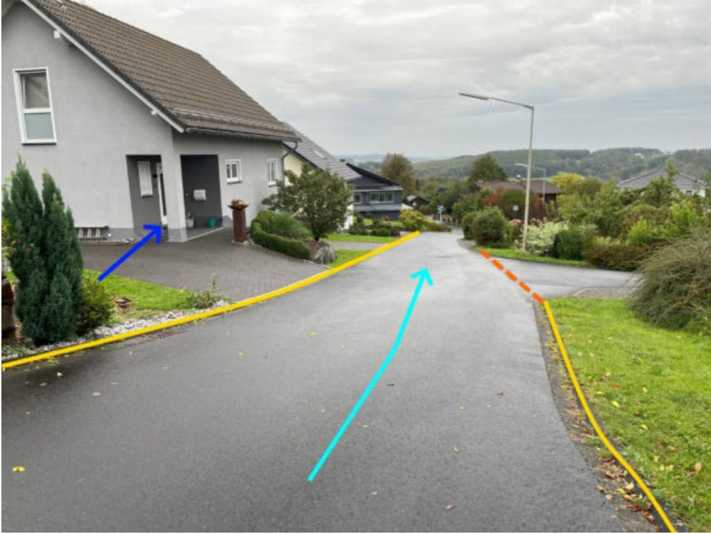
Abbildung 54: Notabflussweg "Auf den Schladen" mit Fließrichtung (hellblau), Bordanlagen (gelb), Aufwallung (orange) und Objektschutzmaßnahmen (blau)
