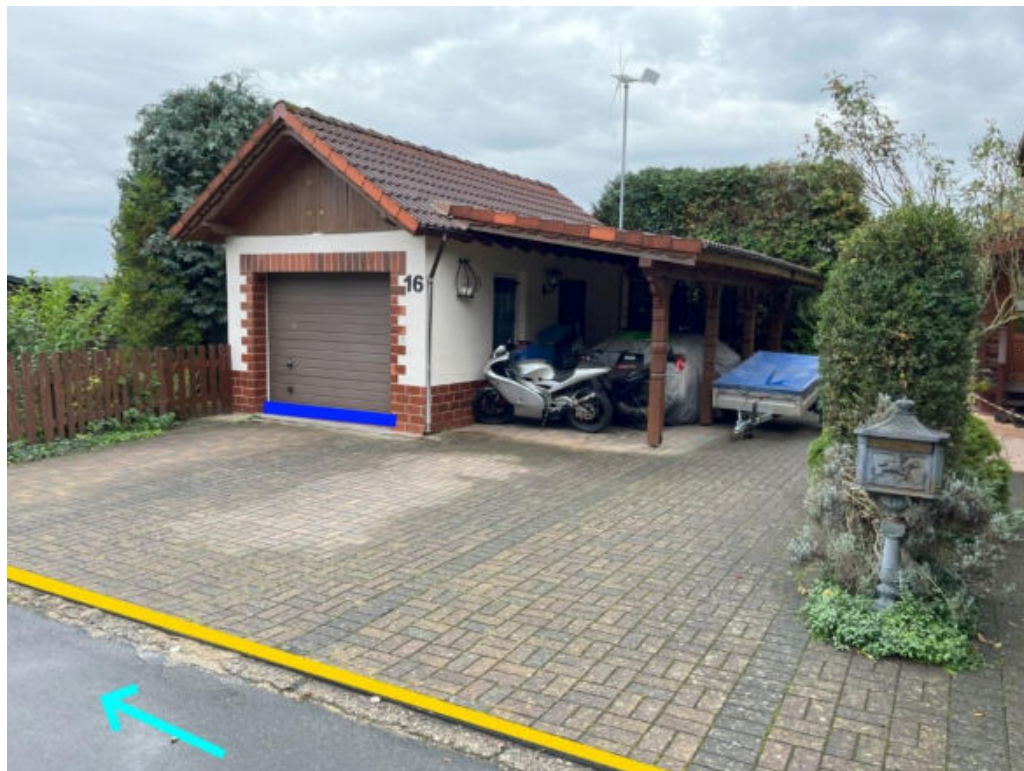
Abbildung 61: Notabflussweg "Auf den Zäunen" mit Fließrichtung (hellblau), Bordanlagen (gelb) und Objektschutzmaßnahmen (blau)
