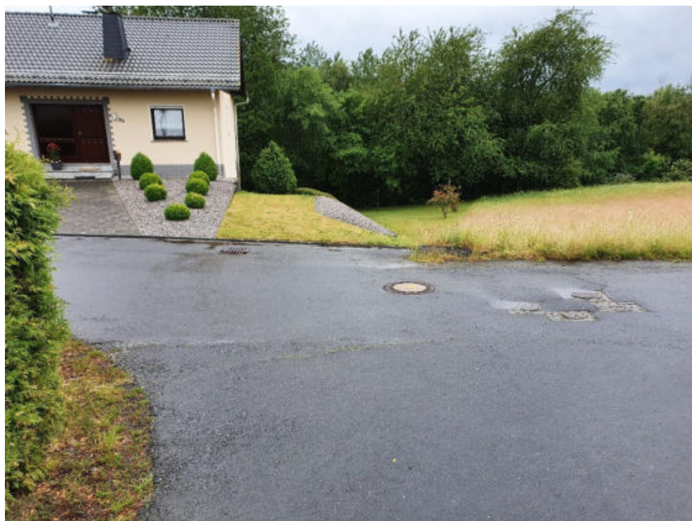
Abbildung 15: Ringstraße mit möglicher Wasseransammlung in der Senke; Gefahrenpunkt 2.2
