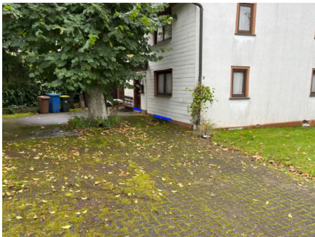
Abbildung 86: Notabflussweg "Hauptstraße" mit Objektschutzmaßnahmen (blau)
