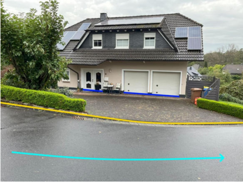
Abbildung 52: Notabflussweg "Auf den Schladen" mit Fließrichtung (hellblau), Bordanlagen (gelb) und Objektschutzmaßnahmen (blau)
