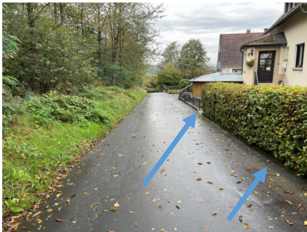
Abbildung 18: Zulauf auf Lohrstr. Nr.3; Gefahrenpunkt 2.4
