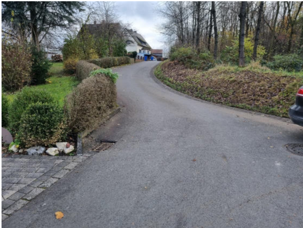
Abbildung 42: Zulauf auf tiefsten Einlauf in der Löhstraße; Gefahrenpunkt 2.16
