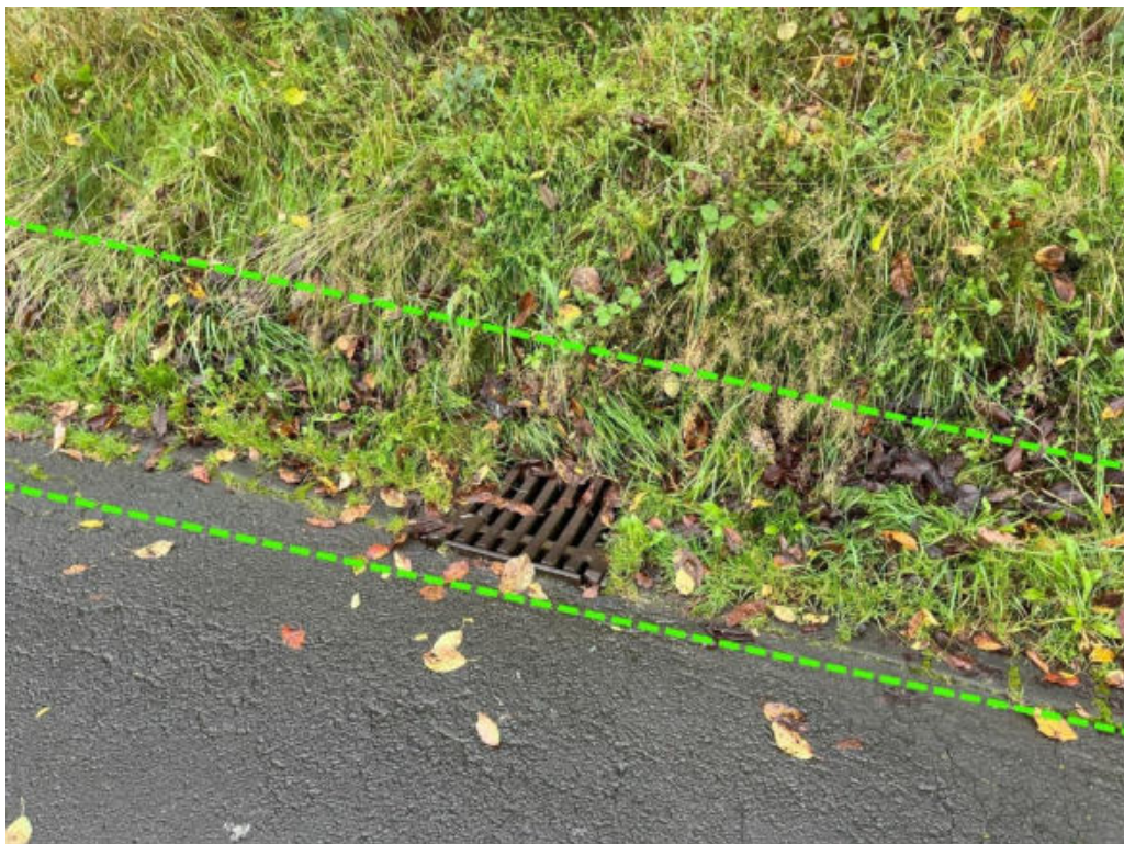
Abbildung 122: Notabflussweg "Löhrstraße" mit Instandsetzung der Entwässerungseinrichtung (hellgrün)
