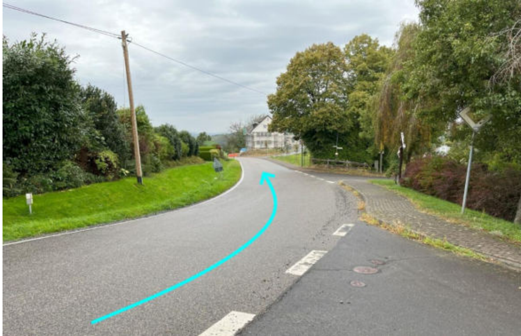
Abbildung 63: Notabflussweg "Hauptstraße" mit Fließrichtung (hellblau)
