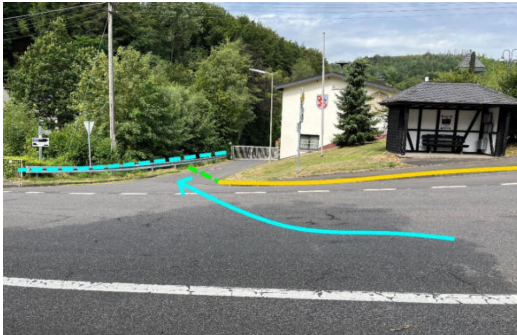
Abbildung 83: Notabflussweg "Steinerother Straße" mit Fließweg (hellblau), Querschlag (hellgrün) und Entwässerung in Bach
