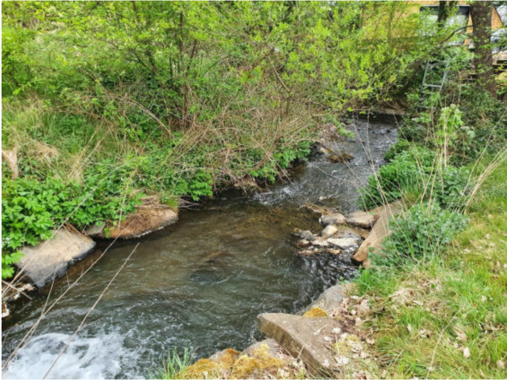
Abbildung 4: Elben, Uferbefestigung Steinebach unterhalb des Durchlasses
