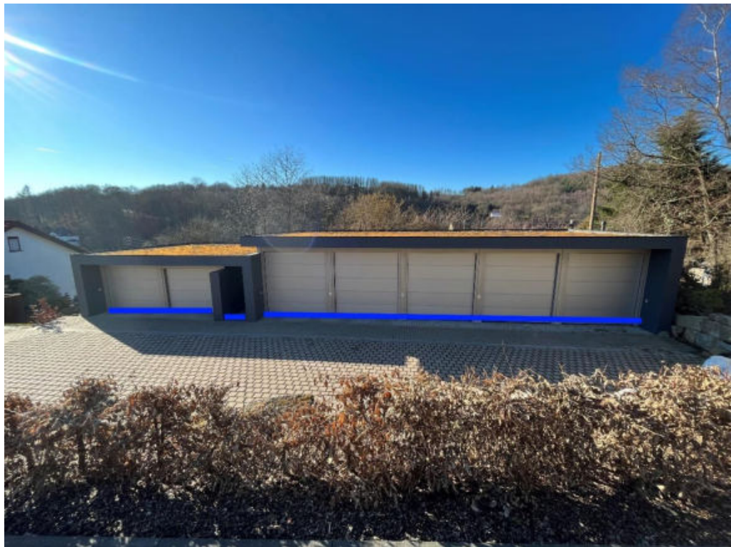
Abbildung 86: Notabflussweg „Petersberg“ mit Objektschutzmaßnahmen (blau)
