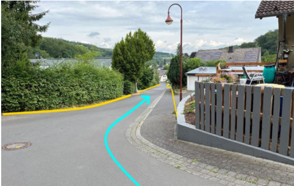
Abbildung 57: Notabflussweg "Waldstraße" mit Fließweg (hellblau), Bordanlagen (gelb) und Übergang in Gartenstraße
