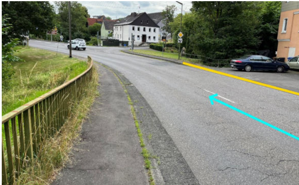
Abbildung 51: Notabflussweg "Bahnhofstraße" mit Fließweg (hellblau) und Bordanlagen (gelb)
