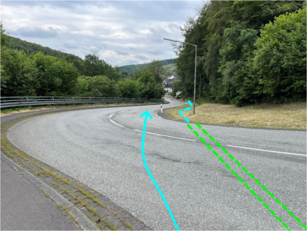
Abbildung 46: Notabflussweg "Bahnhofstraße" mit Fließweg (hellblau) Entwässerungseinrichtung (grün)
