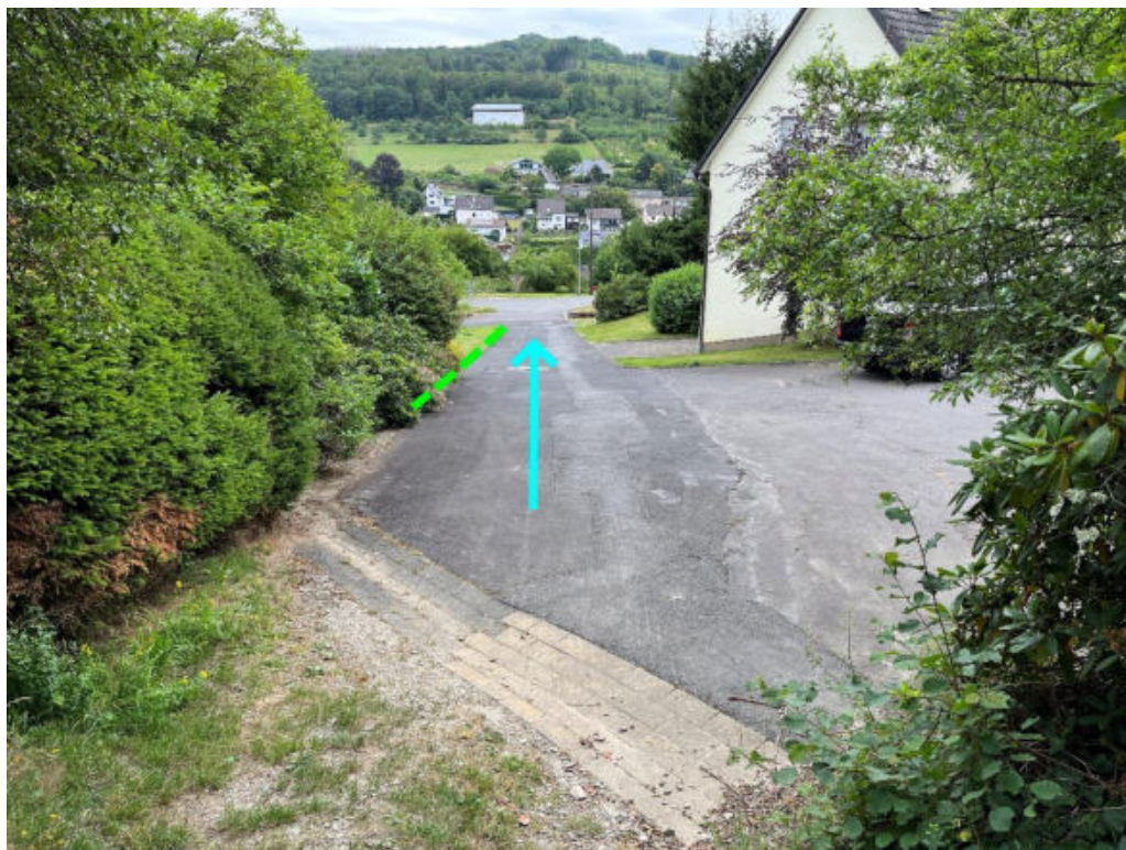
Abbildung 38: Notabflussweg "Bahnhofstraße" mit Fließweg (hellblau) und Entwässerungseinrichtung (gelb)
