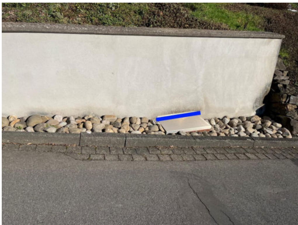
Abbildung 94: Notabflussweg „Petersberg“ mit Objektschutzmaßnahmen (blau)
