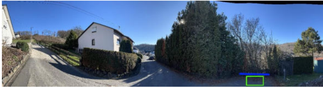
Abbildung 85: Notabflussweg „Petersberg“ mit Straßeneinlauf (grün) und Objektschutzmaßnahmen (blau)
