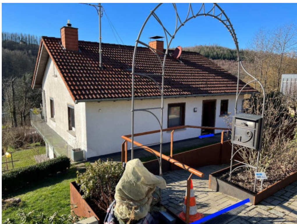
Abbildung 88: Notabflussweg „Petersberg“ mit Objektschutzmaßnahmen (blau)
