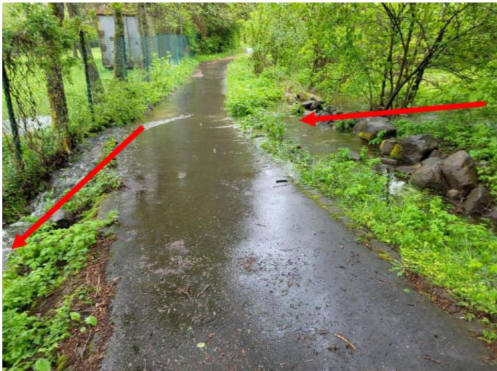
Abbildung 55: Übertritt von Wasser aus dem Graben auf den Fußweg Gefahrenpunkt 8.15
