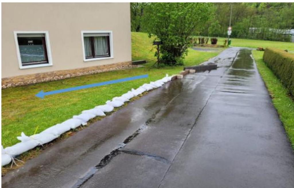
Abbildung 67: Übertritt von Oberflächenwasser auf das Grundstück Waldstraße 28 (hier Objektschutzmaßnahmen) Gefahrenpunkt 8.19
