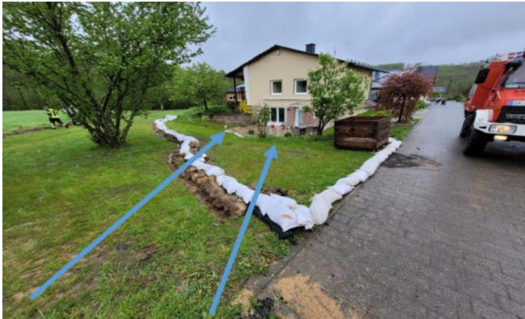
Abbildung 70: Zufluss von Oberflächenwasser auf die Einliegerwohnung der Waldstraße 39. Schutzmaßnahmen in Form von Gräben, Gefahrenpunkt 8.20
