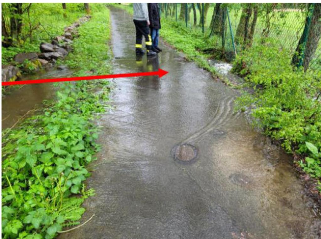
Abbildung 58: Übertritt von Wasser aus dem Graben auf den Fußweg und überlasteter Einlauf am Grabenende, Gefahrenpunkt 8.15
