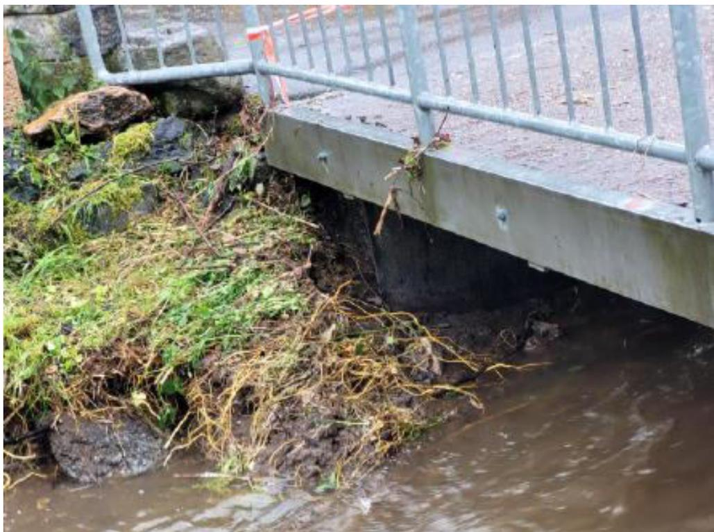
Abbildung 63: Treibgut an Brückenkörper/Verkläusungen, Gefahrenpunkt 8.18
