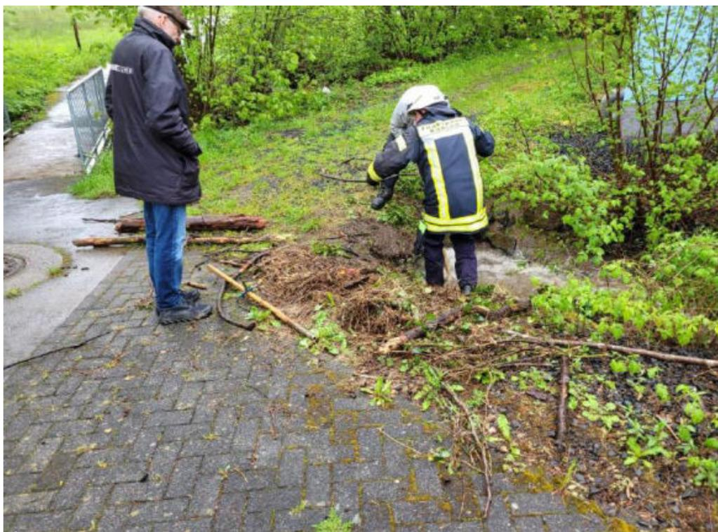
Abbildung 49: Durch Treibgut Verstopfte Verrohrung Gefahrenpunkt 8.14
