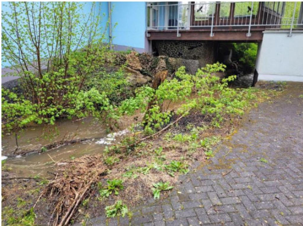
Abbildung 48: Rückstau im Graben am Freibad durch verstopfte Verrohrung
