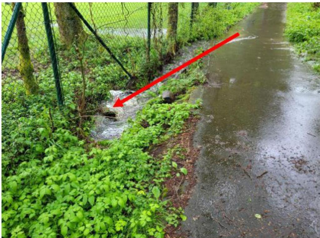
Abbildung 57: Übertritt von Wasser aus dem Graben auf den Fußweg und überlasteter Einlauf am Grabenende, Gefahrenpunkt 8.15
