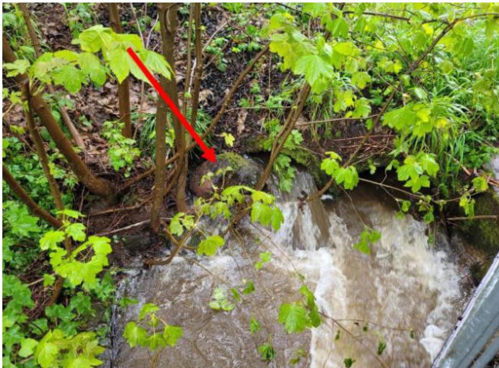
Abbildung 50: Durch Treibgut Verstopfte Verrohrung Gefahrenpunkt 8.14
