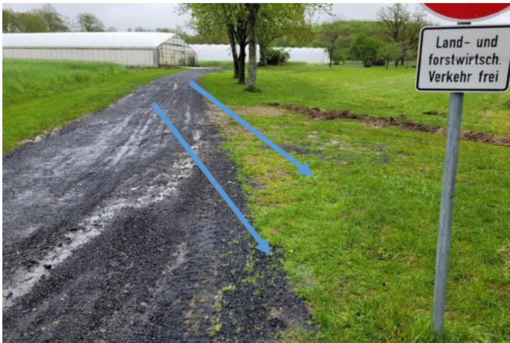
Abbildung 71: Zufluss von Oberflächenwasser auf die Einliegerwohnung der Waldstraße 39. Schutzmaßnahmen in Form von Gräben, Gefahrenpunkt 8.20
