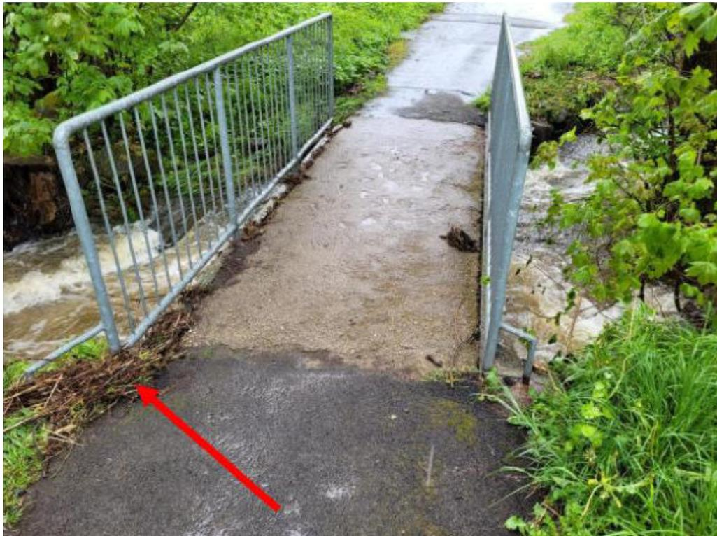
Abbildung 52: Treibgut sammelt sich am Brückengeländer Gefahrenpunkt 8.14
