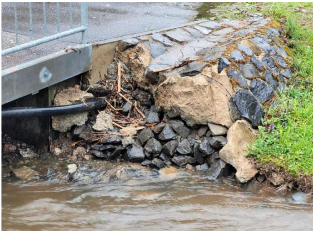
Abbildung 65: Unterspülungen der Brückenaufleger Gefahrenpunkt 8.18
