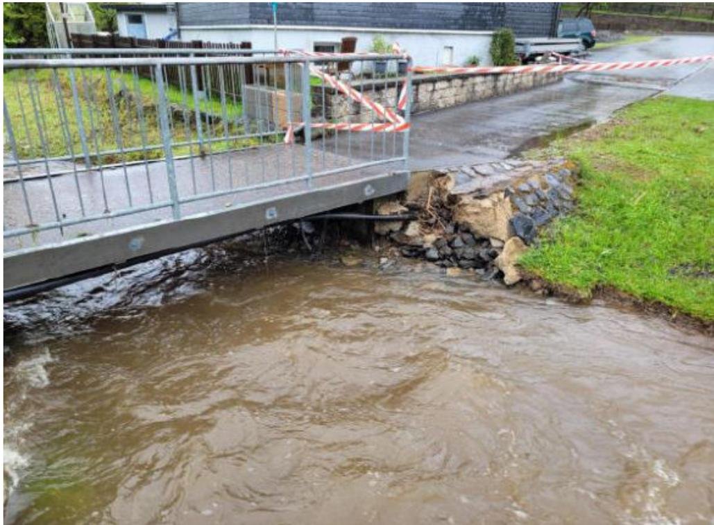
Abbildung 64: Unterspülungen im Uferbereich und im Bereich der Brückenaufleger, Gefahrenpunkt 8.18
