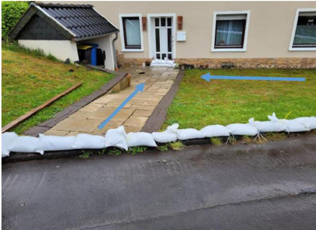
Abbildung 68: Übertritt von Oberflächenwasser auf das Grundstück Waldstraße 28 (hier Objektschutzmaßnahmen) Gefahrenpunkt 8.19
