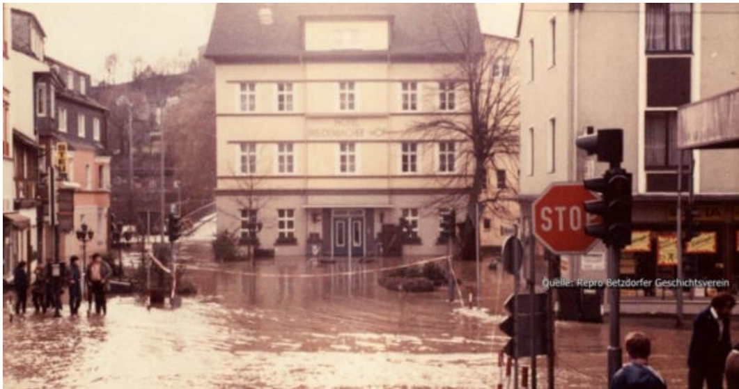
Abbildung 5: Hochwasser an der Sieg 1984 – Betzdorf Breidenbacher Hof ( http://betzdorfer-blick.de/das-jahrhundert-hochwasser/ )
