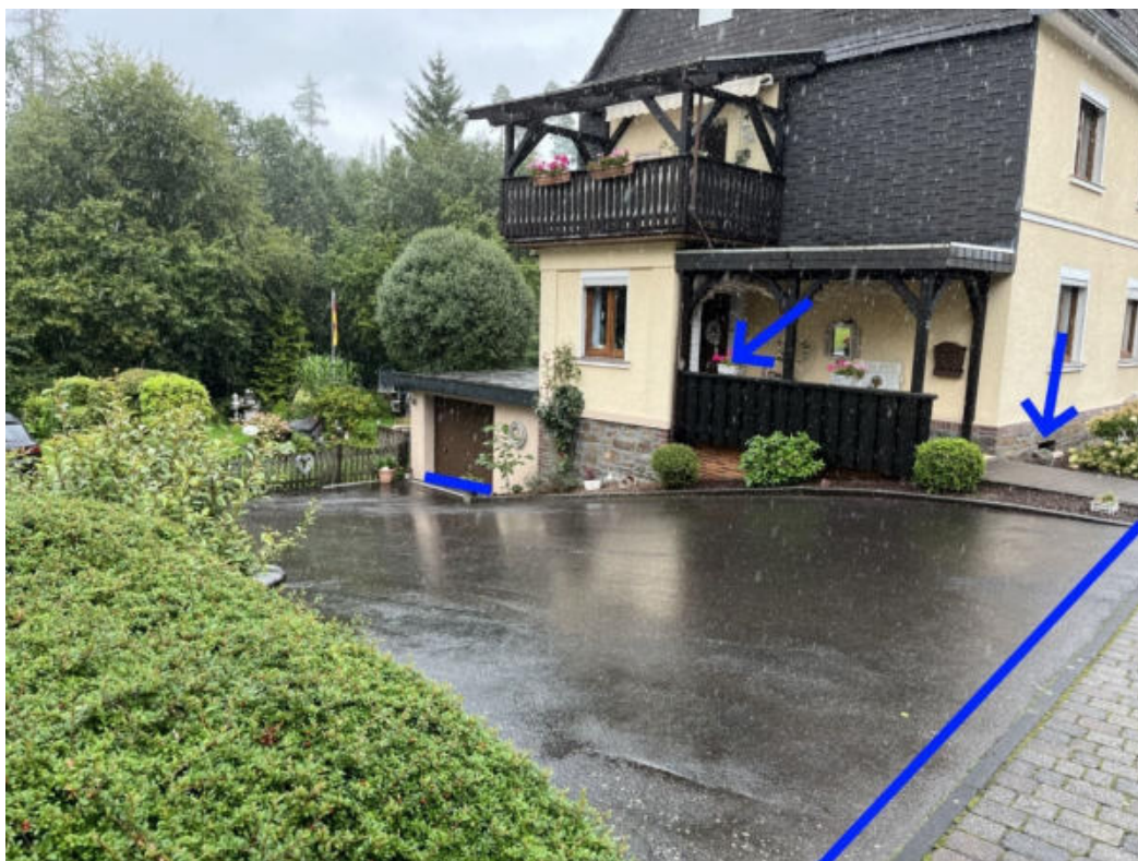
Abbildung 78: Notfließweg "Katzenwinkeler Straße" mit Objektschutzmaßnahmen (blau)
