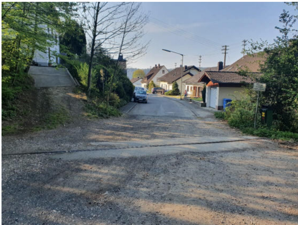
Abbildung 36: Blick Richtung Tiergartenstraße, Gefahrenpunkt 15.10
