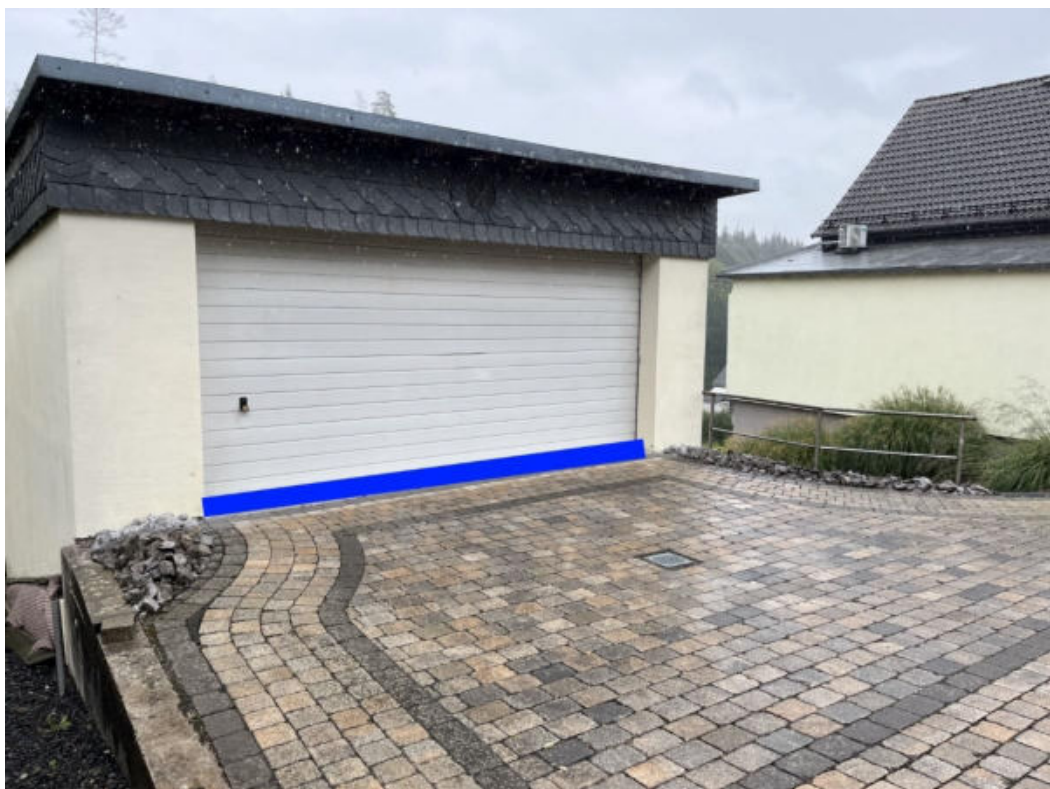
Abbildung 85: Notfließweg "Katzenwinkeler Straße" mit Objektschutzmaßnahmen (blau)
