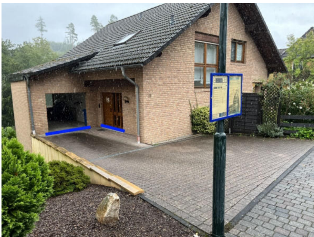
Abbildung 79: Notfließweg "Katzenwinkeler Straße" mit Objektschutzmaßnahmen (blau)
