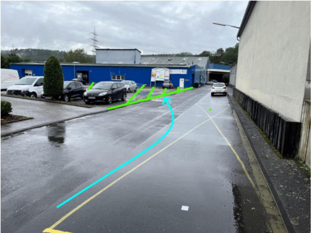
Abbildung 127: Notfließweg "In der Aue" mit Fließweg (hellblau) und Entwässerung in Senke (hellgrün)
