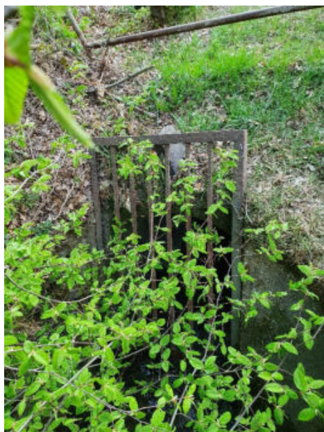
Abbildung 11: Einlaufgitter, Gefahrenpunkt 15.11
