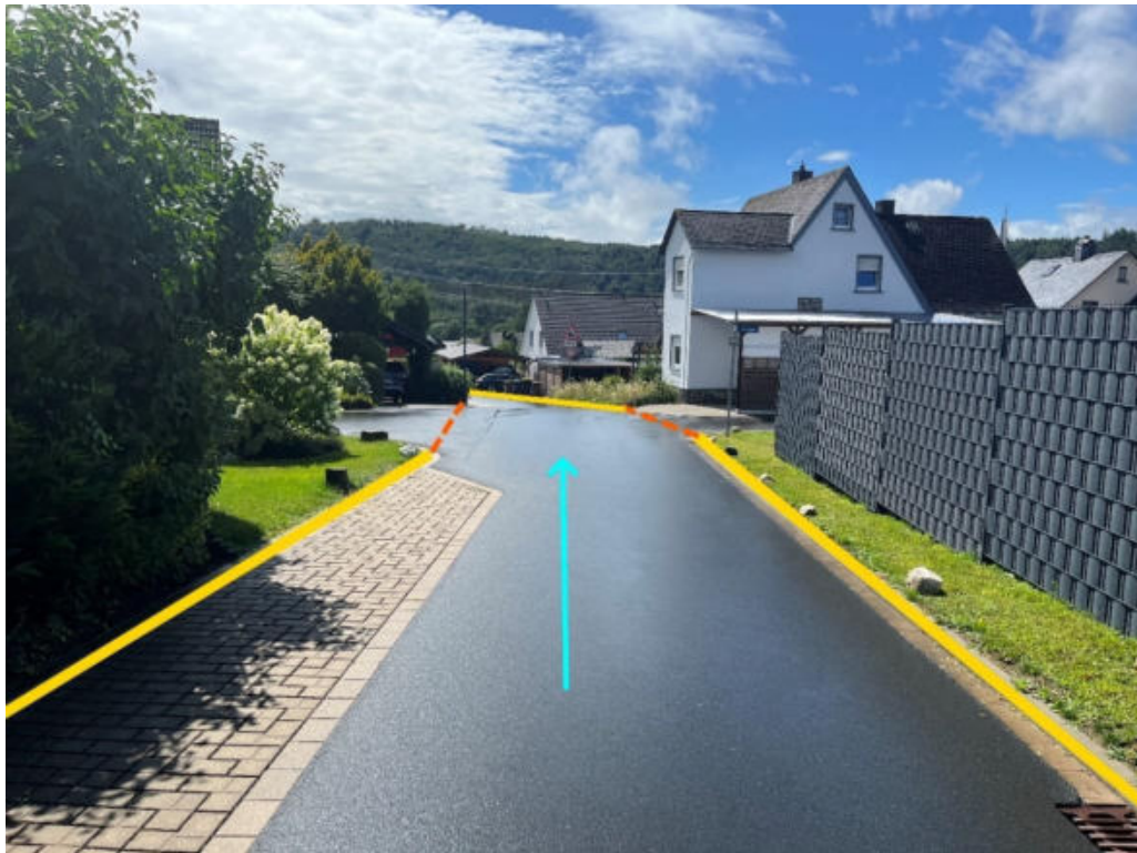
Abbildung 197: Notabflussweg "Brucher Straße" mit Fließrichtung (hellblau), Aufwallung (orange) und Bordanlagen (gelb)
