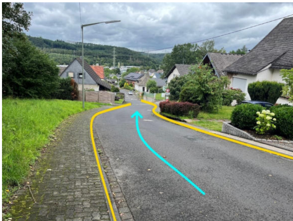
Abbildung 121: Notabflussweg "Waldstraße" mit Fließrichtung (hellblau) und Bordanlagen (gelb)
