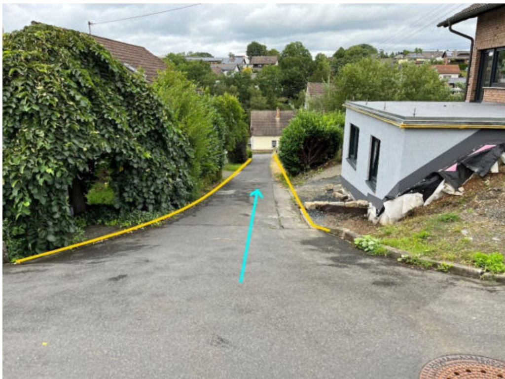
Abbildung 106: Notabflussweg "Hubertusweg" mit Fließrichtung (hellblau) und Bordanlagen (gelb)
