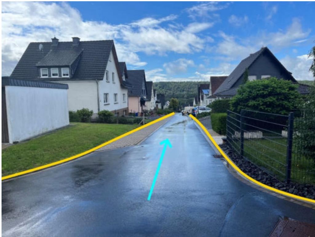
Abbildung 171: Notabflussweg "Brucher Straße" mit Fließrichtung (hellblau) und Bordanlagen (gelb)
