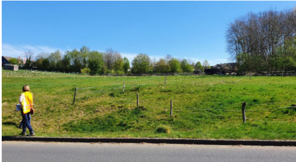
Abbildung 50: Zwei Regenrückhaltebecken östlich der Maximilian-Kolbe-Straße
