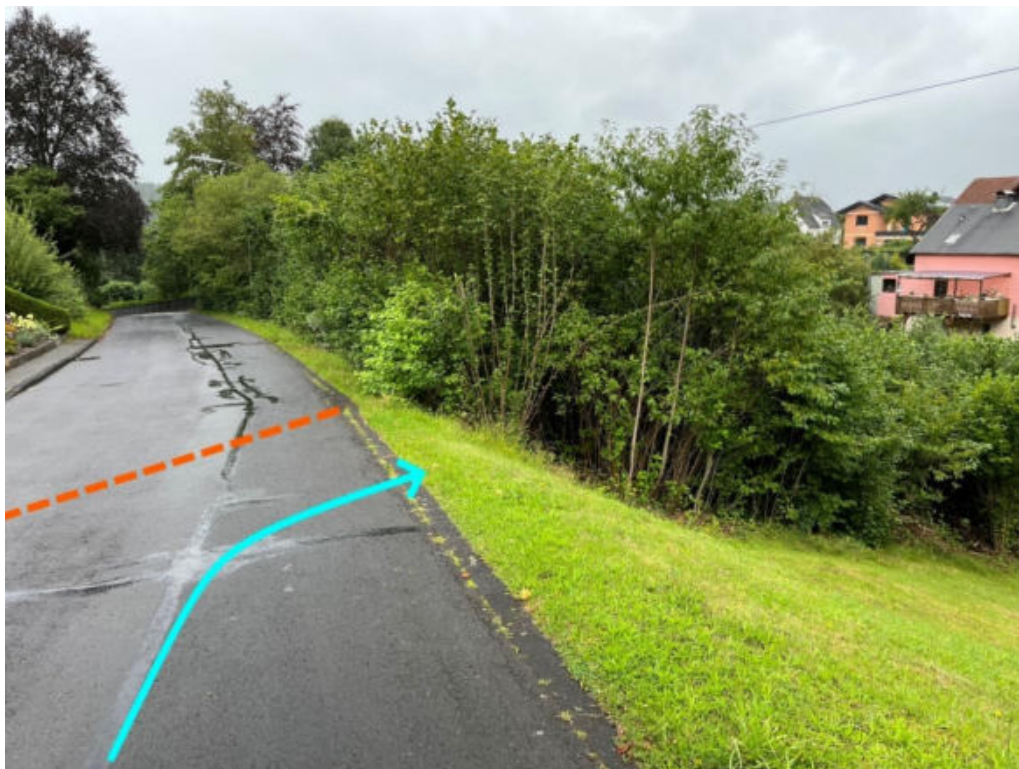
Abbildung 271: Notabflussweg "Schulstraße" mit Fließrichtung (hellblau) und Aufwallung (orange)
