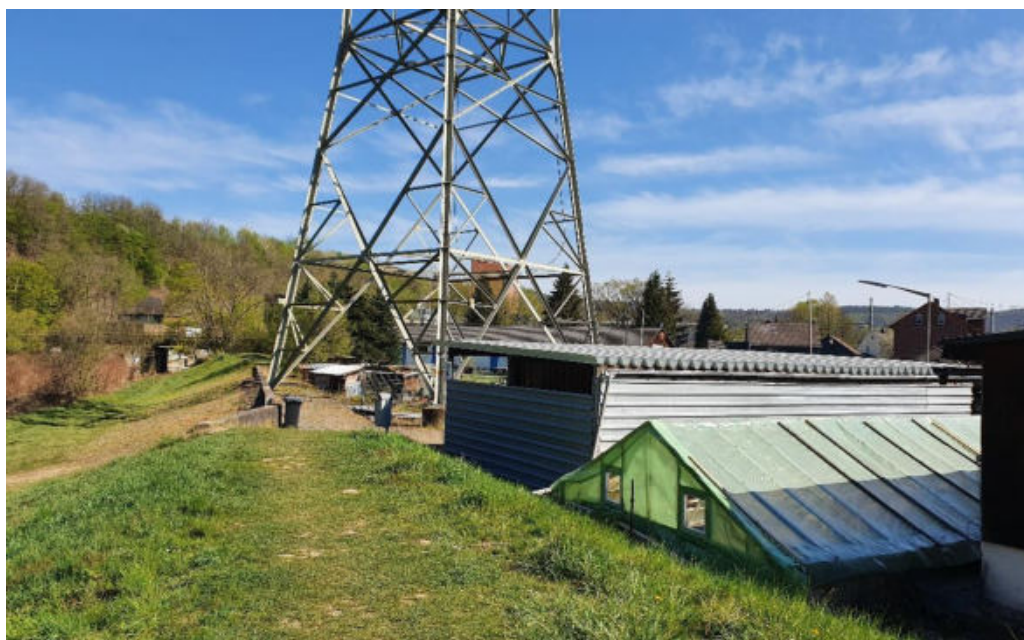
Abbildung 30: Damm im Industriegebiet entlang der Sieg
