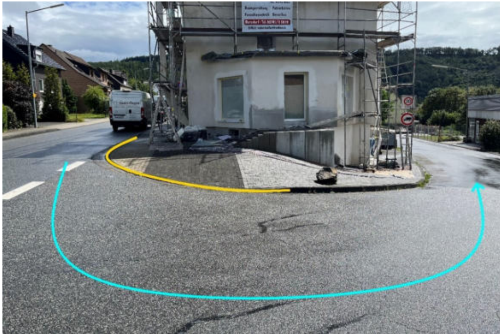
Abbildung 229: Notabflussweg "Josef-Barthel-Straße" mit Fließrichtung (hellblau) und Bordanlagen (gelb)
