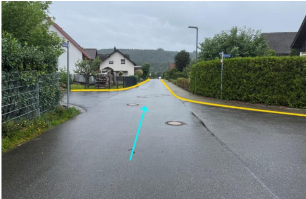
Abbildung 127: Notabflussweg "Gartenstraße" mit Fließrichtung (hellblau) und Bordanlagen (gelb)
