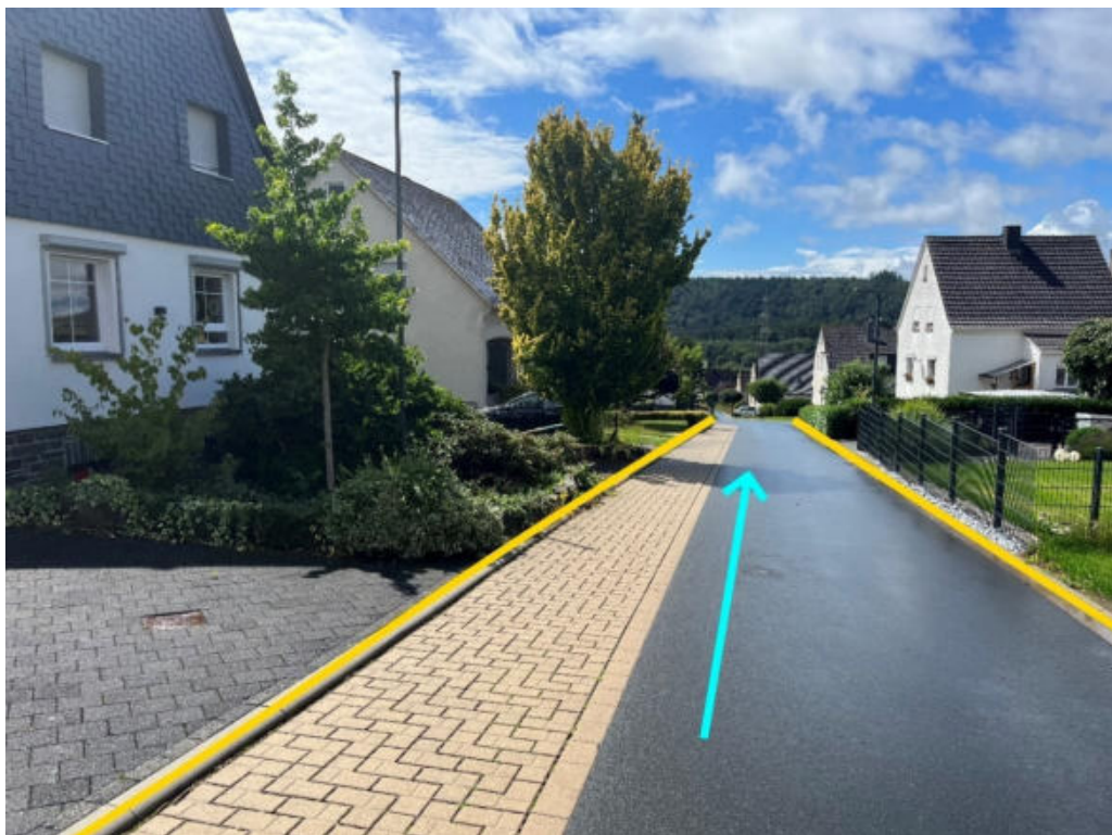
Abbildung 178: Notabflussweg "Brucher Straße" mit Fließrichtung (hellblau) und Bordanlagen (gelb)
