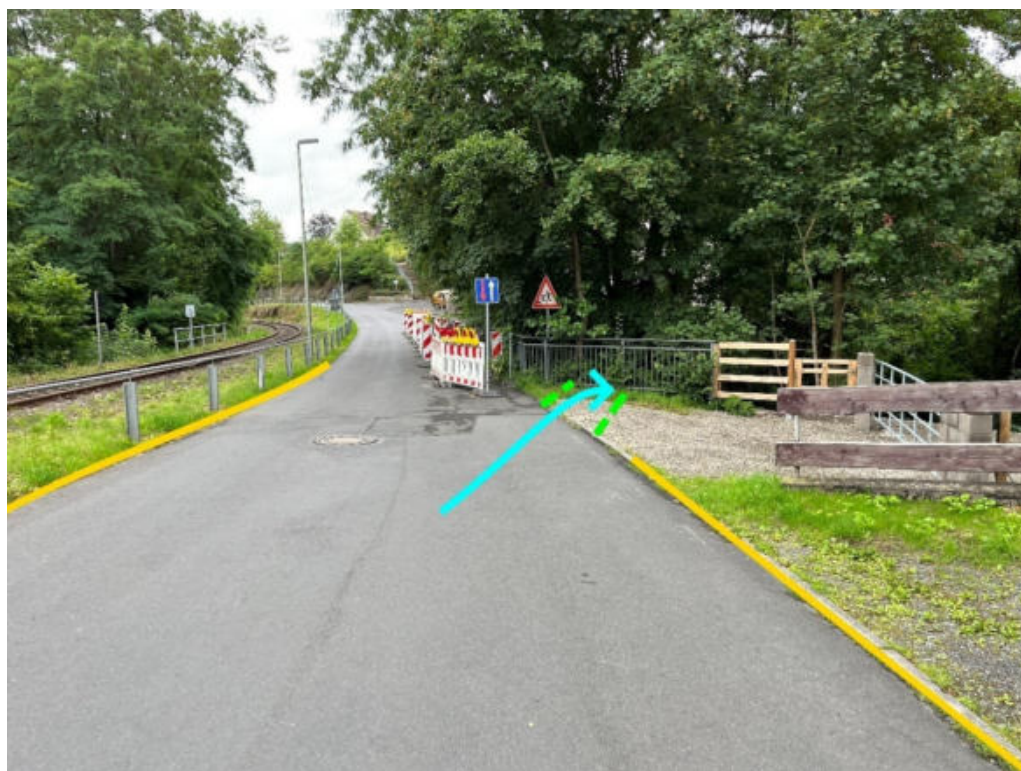
Abbildung 80: Notabflussweg "Am Rundstück" mit Fließrichtung (hellblau) und Entwässerung in Scheuerfelder Bach
