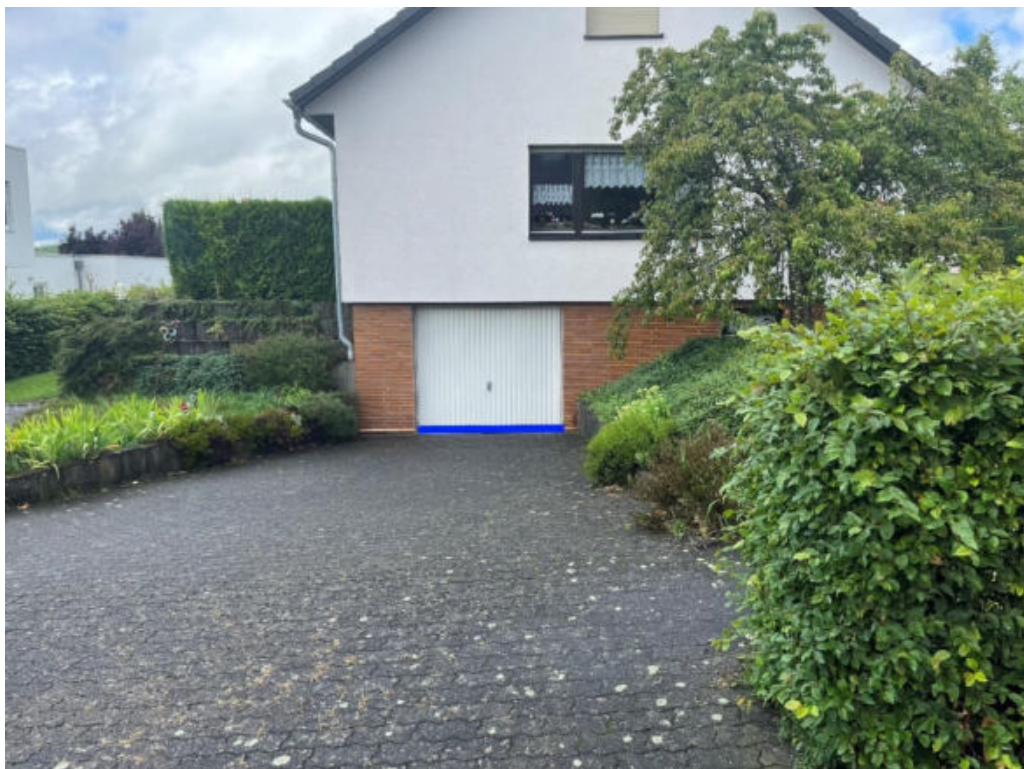
Abbildung 168: Notabflussweg "Brucher Straße" mit Objektschutzmaßnahmen (blau)
