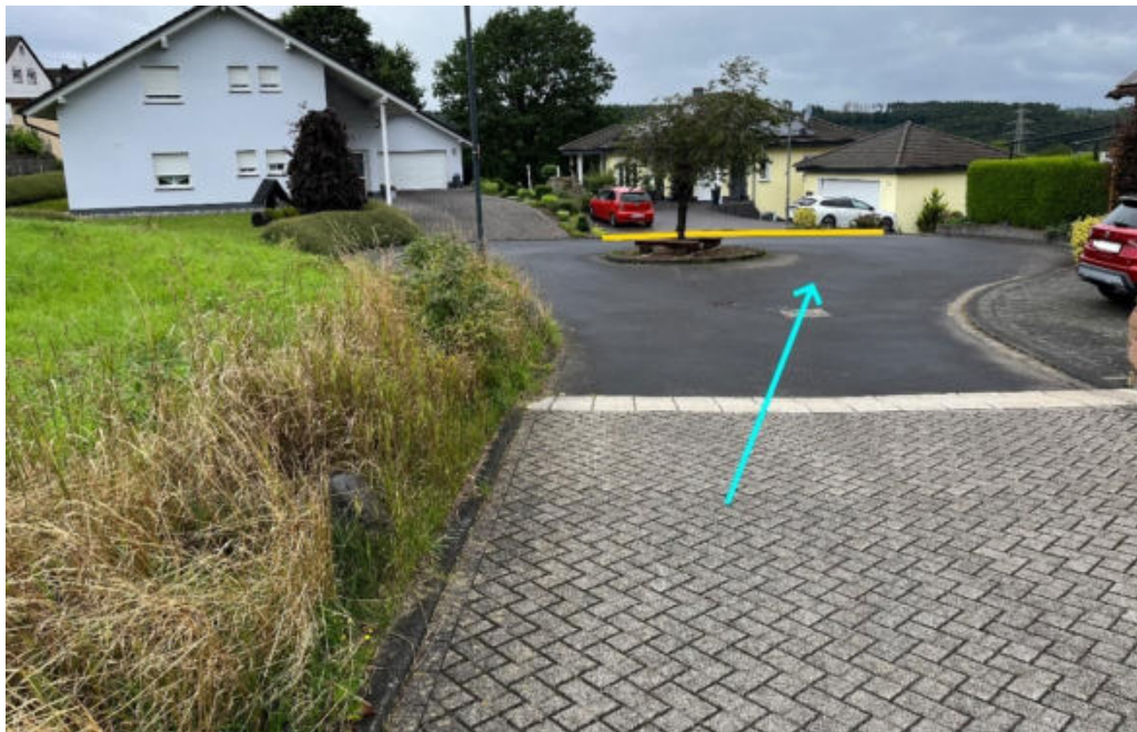
Abbildung 273: Notabflussweg "Im Wäldchen" mit Fließrichtung (hellblau) und Bordanlagen (gelb)
