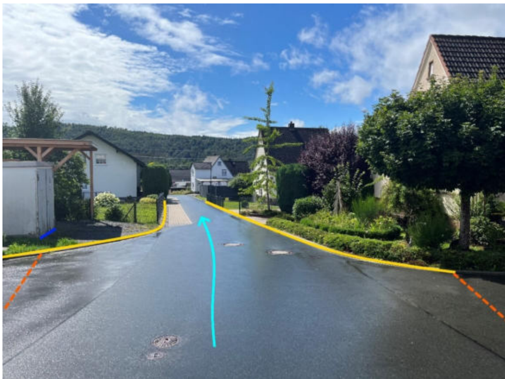
Abbildung 192: Notabflussweg "Brucher Straße" mit Fließrichtung (hellblau), Aufwallung (orange), Objektschutzmaßnahmen (blau) und Bordanlagen (gelb)
