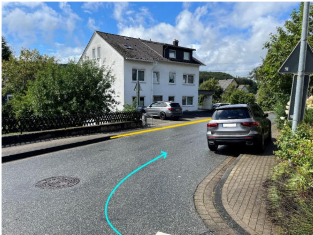
Abbildung 204: Notabflussweg "Brucher Straße" mit Fließrichtung (hellblau) und Bordanlagen (gelb)
