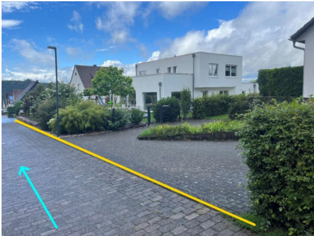
Abbildung 167: Notabflussweg "Brucher Straße" mit Fließrichtung (hellblau) und Bordanlagen (gelb)
