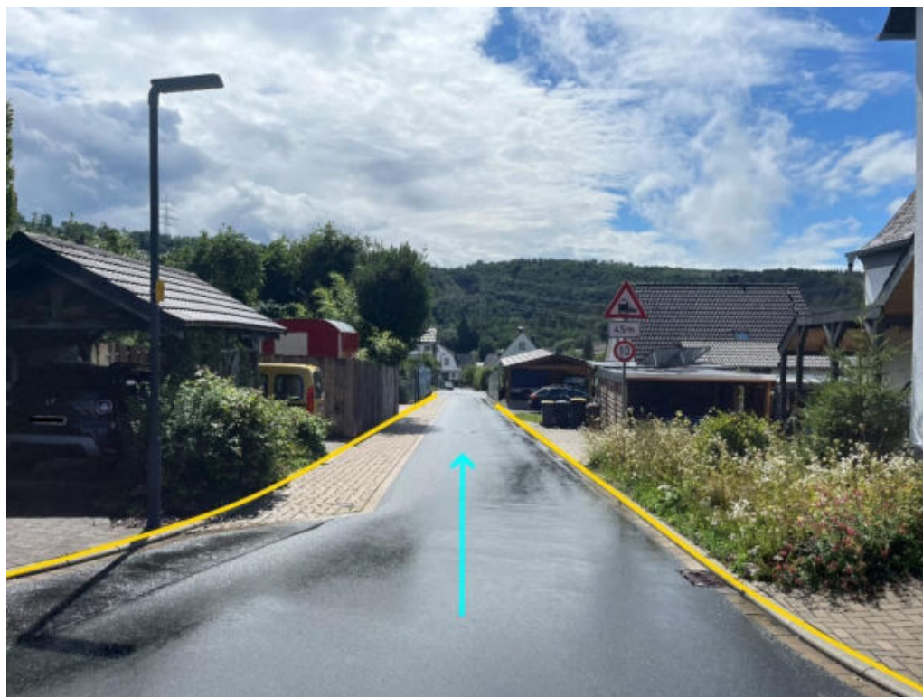
Abbildung 199: Notabflussweg "Brucher Straße" mit Fließrichtung (hellblau) und Bordanlagen (gelb)
