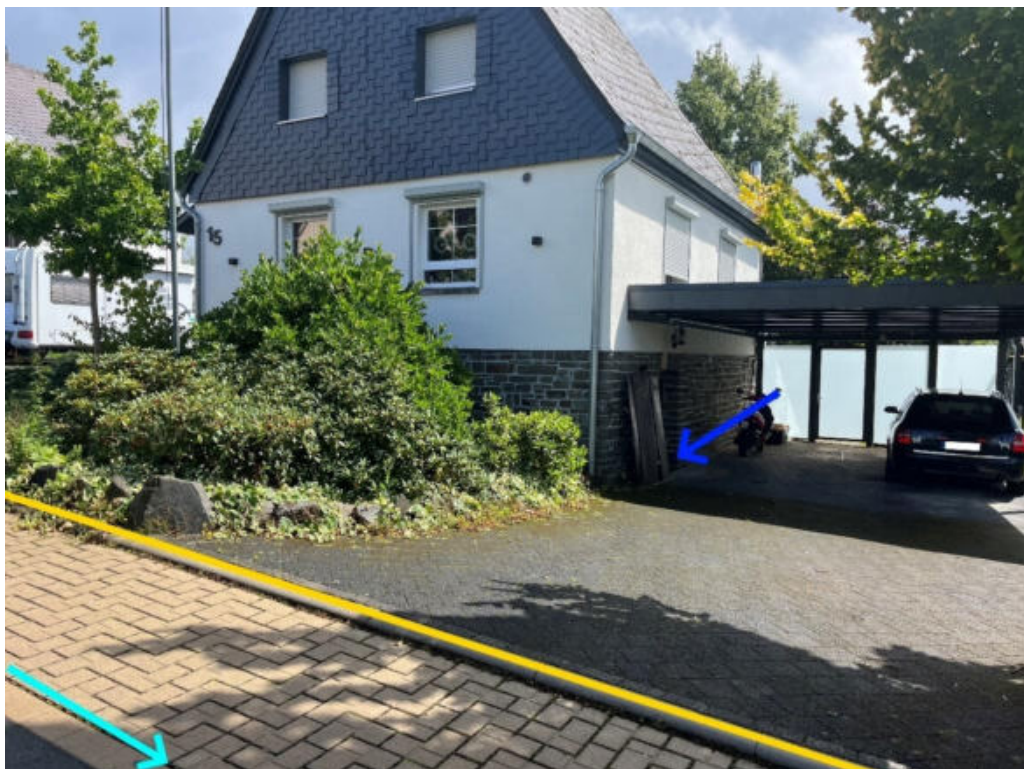
Abbildung 180: Notabflussweg "Brucher Straße" mit Fließrichtung (hellblau), Objektschutzmaßnahmen (blau) und Bordanlagen (gelb)
