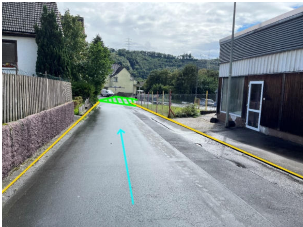
Abbildung 231: Notabflussweg "Josef-Barthel-Straße" mit Fließrichtung (hellblau), Senke (hellgrün) und Bordanlagen (gelb)
