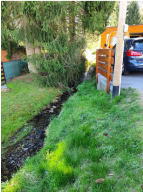
Abbildung 17: Scheuerfelder Bach parallel zur Industriestraße, Gefahrenpunkt 17.1
