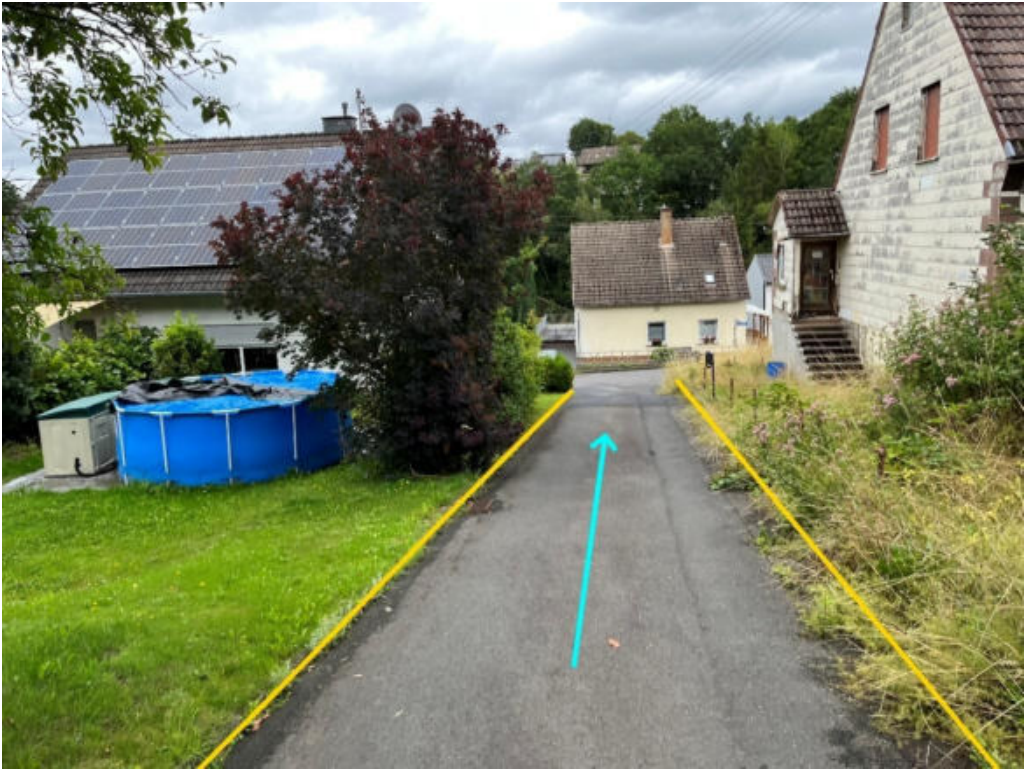
Abbildung 109: Notabflussweg "Hubertusweg" mit Fließrichtung (hellblau) und Bordanlagen (gelb)
