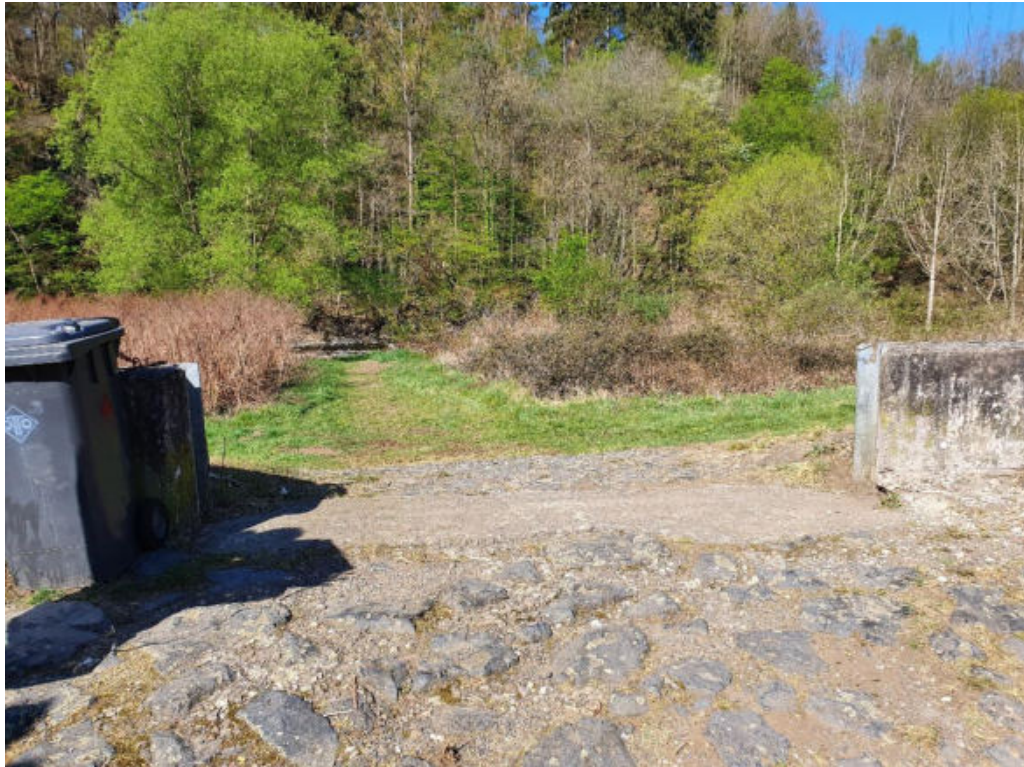
Abbildung 31: Damm im Industriegebiet entlang der Sieg
