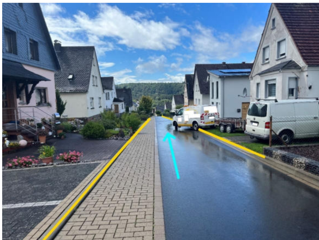
Abbildung 174: Notabflussweg "Brucher Straße" mit Fließrichtung (hellblau) und Bordanlagen (gelb)
