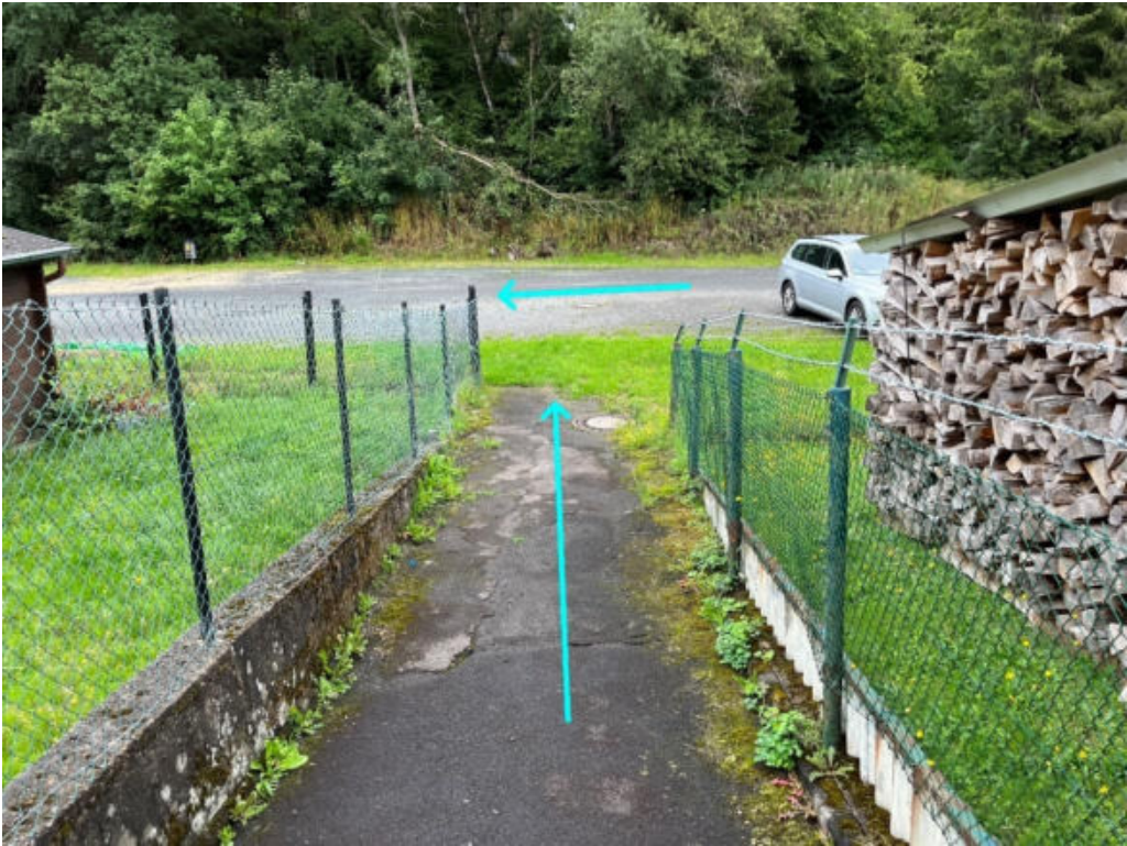
Abbildung 114: Notabflussweg "Hubertusweg" mit Fließrichtung (hellblau)
