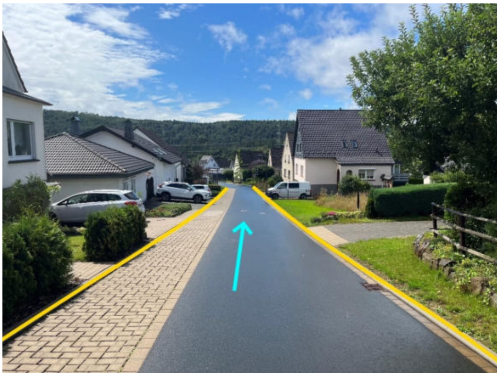
Abbildung 186: Notabflussweg "Brucher Straße" mit Fließrichtung (hellblau) und Bordanlagen (gelb)
