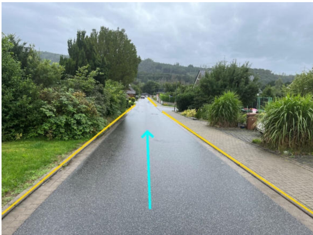
Abbildung 144: Notabflussweg "Gartenstraße" mit Fließrichtung (hellblau) und Bordanlagen (gelb)
