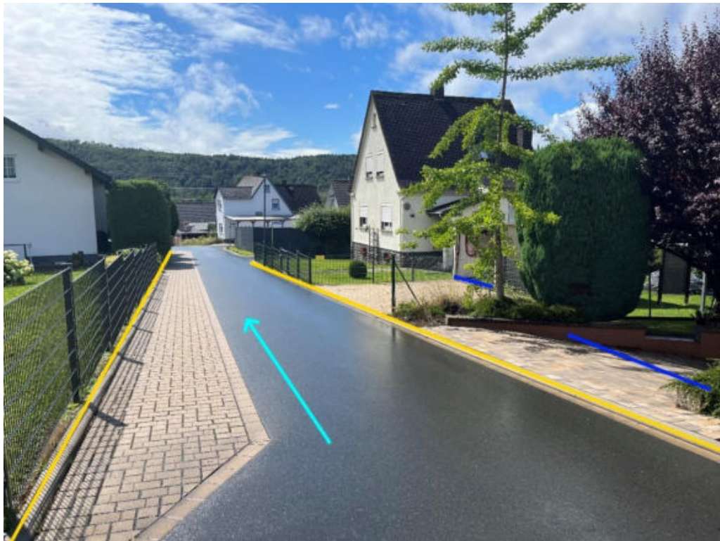
Abbildung 193: Notabflussweg "Brucher Straße" mit Fließrichtung (hellblau), Objektschutzmaßnahmen (blau) und Bordanlagen (gelb)
