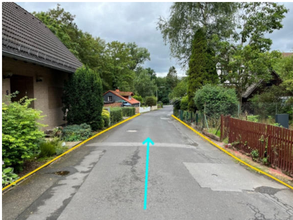
Abbildung 90: Notabflussweg "Kupferkaute" mit Fließrichtung (hellblau) und Bordanlagen (gelb)
