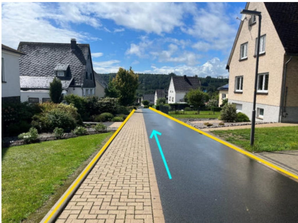
Abbildung 176: Notabflussweg "Brucher Straße" mit Fließrichtung (hellblau) und Bordanlagen (gelb)
