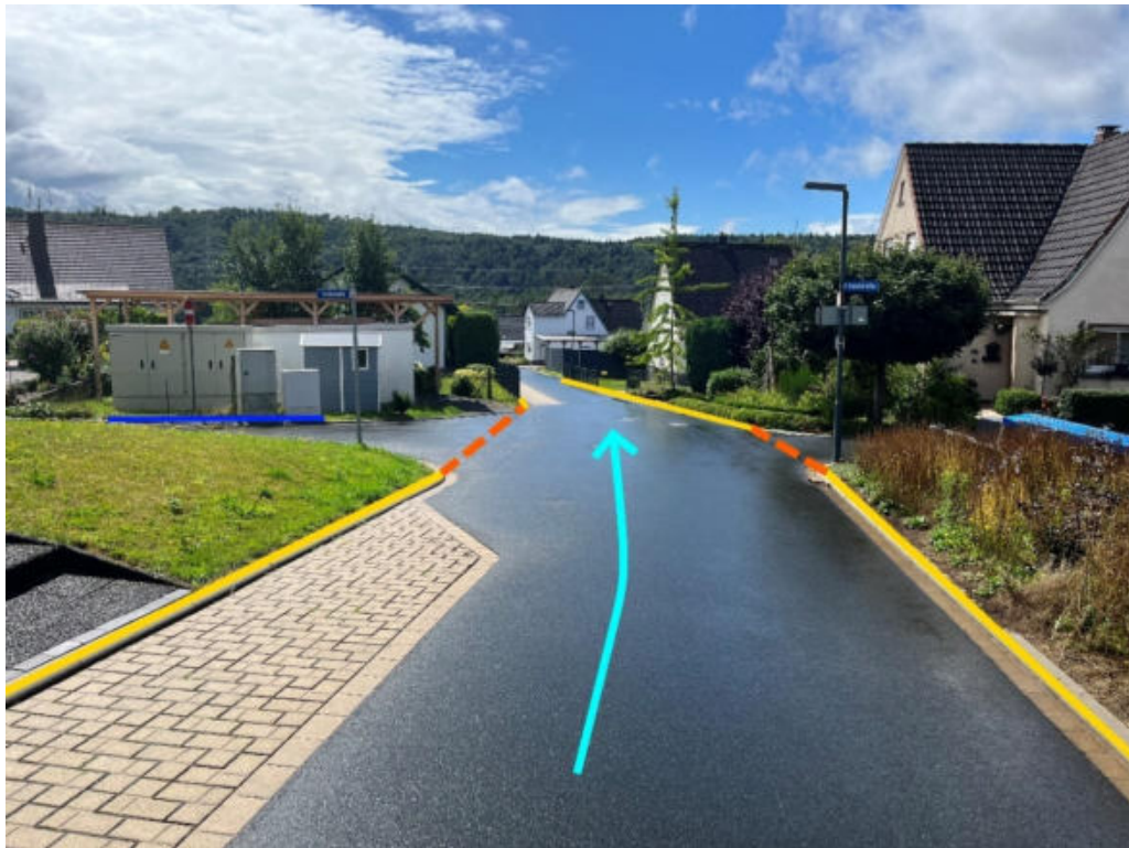
Abbildung 191: Notabflussweg "Brucher Straße" mit Fließrichtung (hellblau), Aufwallung (orange), Objektschutzmaßnahmen (blau) und Bordanlagen (gelb)
