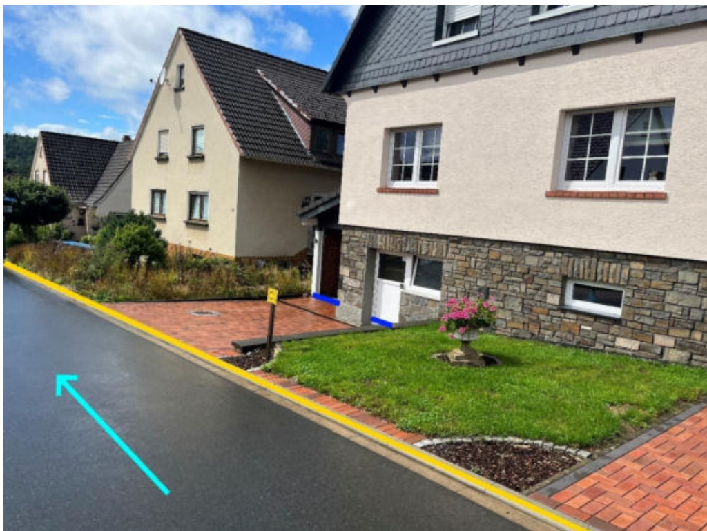
Abbildung 190: Notabflussweg "Brucher Straße" mit Fließrichtung (hellblau), Objektschutzmaßnahmen (blau) und Bordanlagen (gelb)
