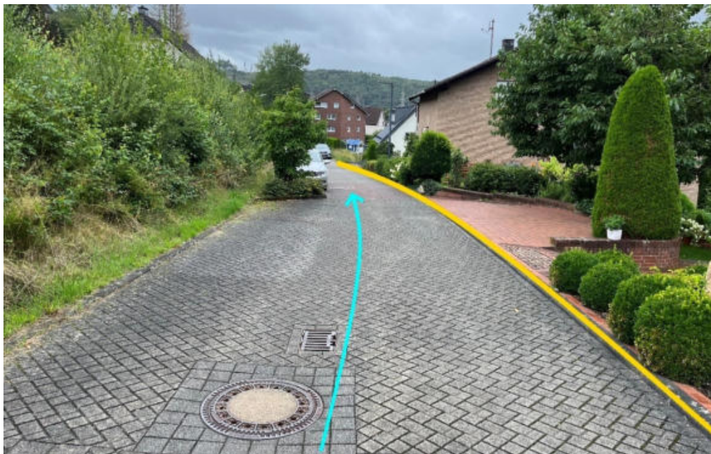
Abbildung 280: Notabflussweg "Hofwiesenstraße" mit Fließrichtung (hellblau) und Bordanlagen (gelb)
