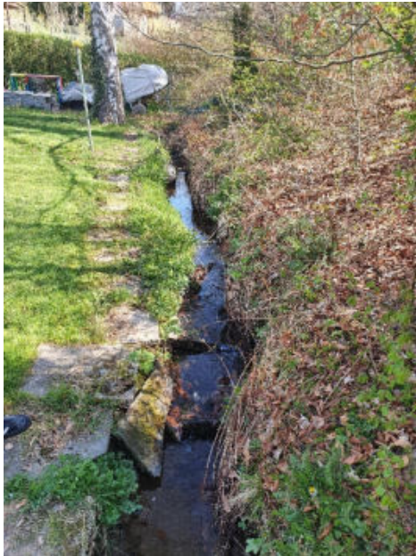
Abbildung 23: Bereich Durchlass des Scheuerfelder Baches an der Mittelstraße/Bahnhofsstraße, Gefahrenpunkt 17.3
