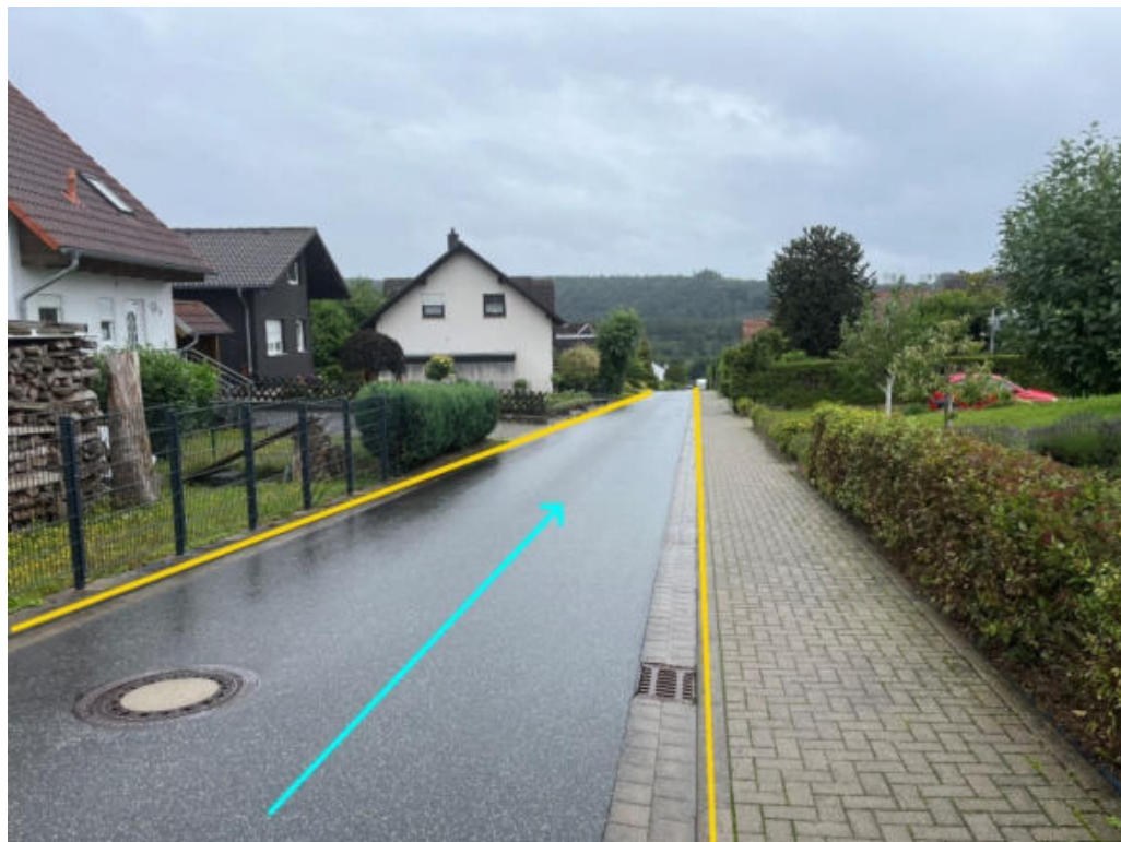
Abbildung 129: Notabflussweg "Gartenstraße" mit Fließrichtung (hellblau) und Bordanlagen (gelb)
