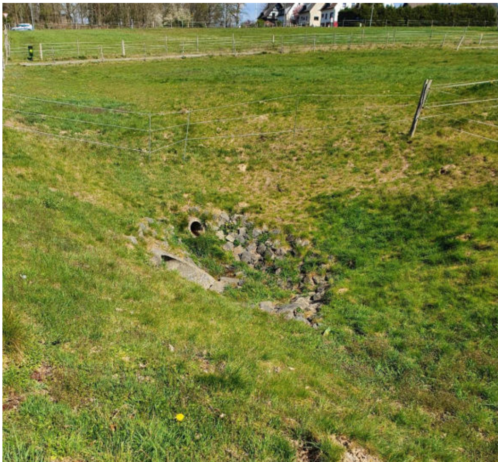
Abbildung 51: Einlauf in Regenrückhaltebecken östlich der Maximilian-Kolbe-Straße
