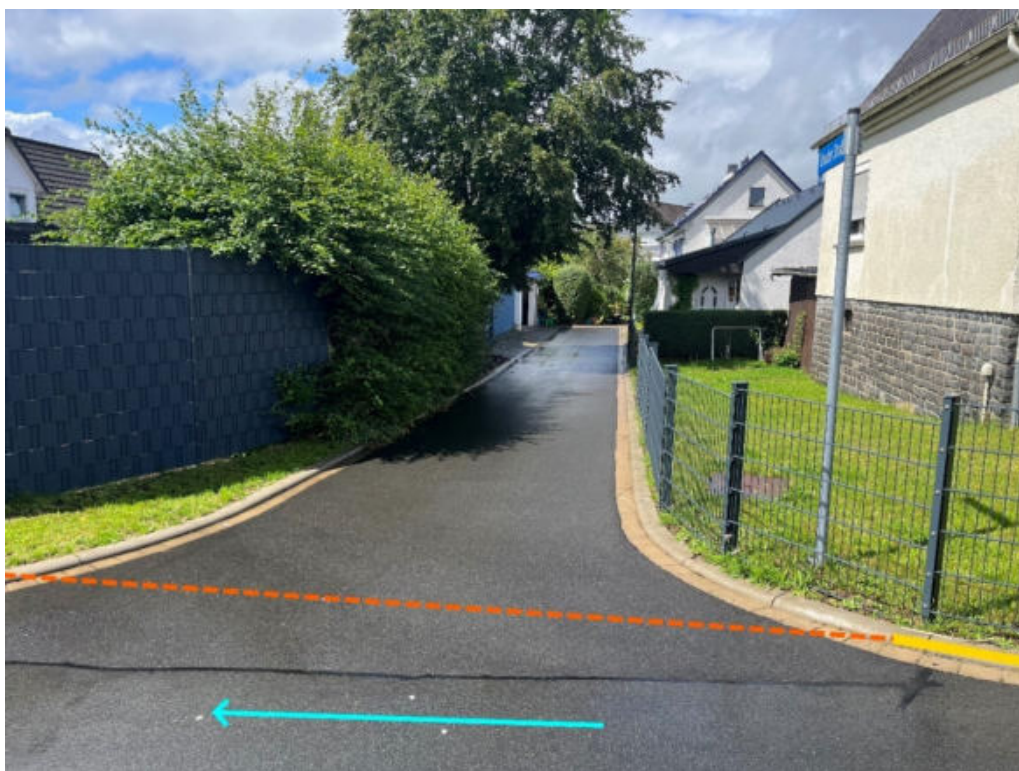
Abbildung 196: Notabflussweg "Brucher Straße" mit Fließrichtung (hellblau) und Aufwallung (orange)
