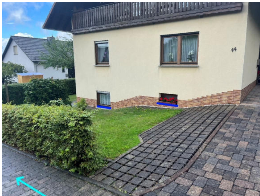
Abbildung 165: Notabflussweg "Brucher Straße" mit Fließrichtung (hellblau) und Bordanlagen (gelb)
