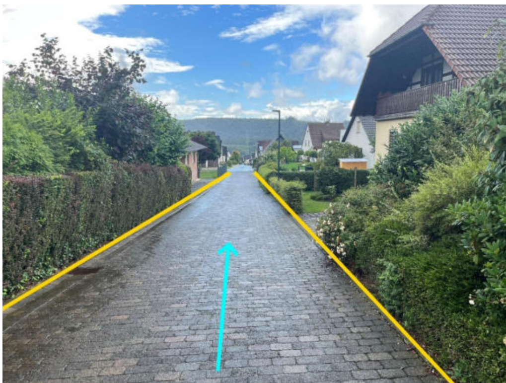
Abbildung 164: Notabflussweg "Brucher Straße" mit Fließrichtung (hellblau) und Bordanlagen (gelb)
