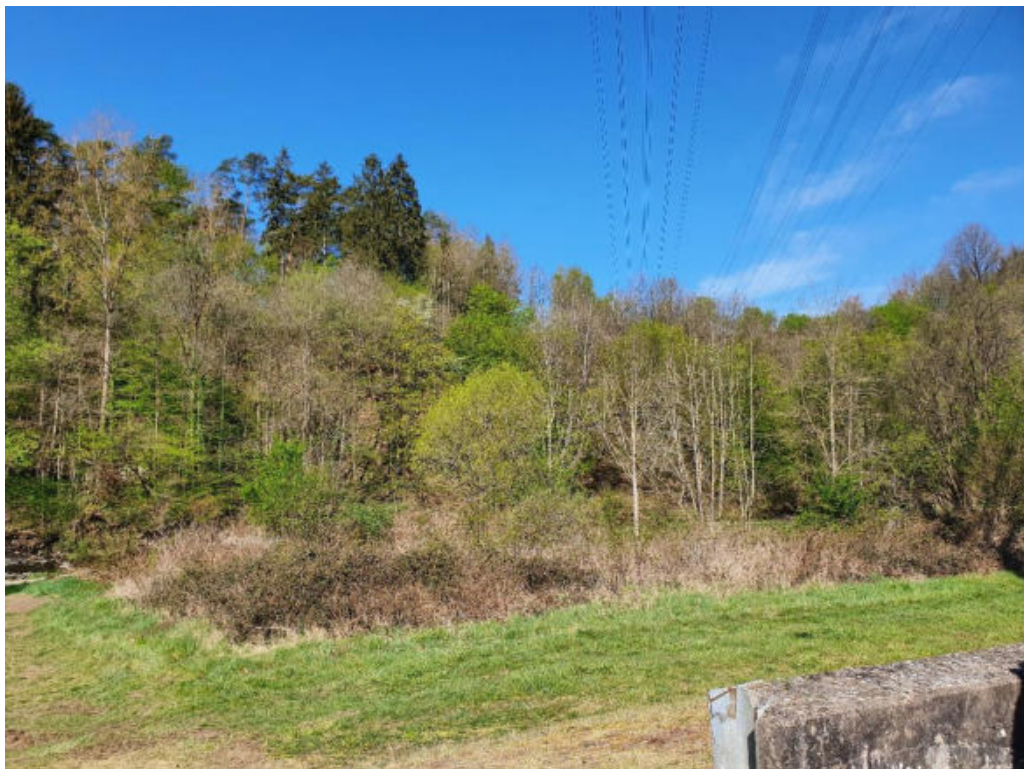
Abbildung 32: Damm im Industriegebiet entlang der Sieg
