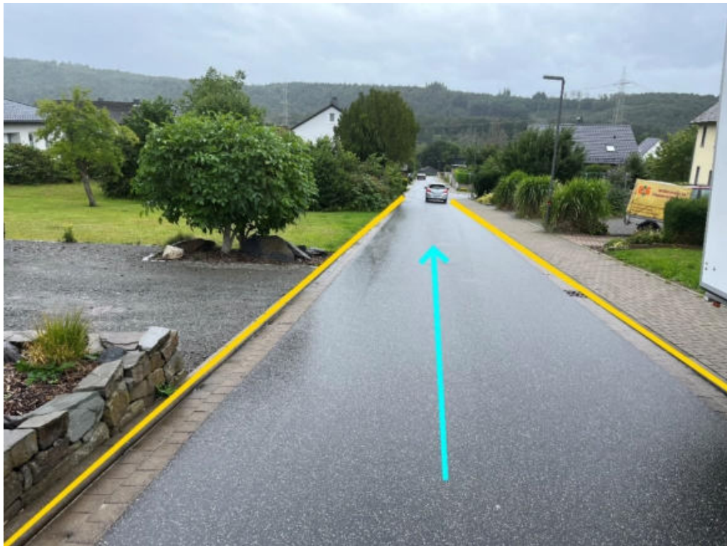
Abbildung 143: Notabflussweg "Gartenstraße" mit Fließrichtung (hellblau) und Bordanlagen (gelb)
