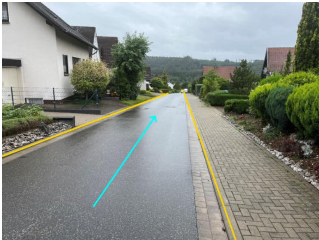
Abbildung 131: Notabflussweg "Gartenstraße" mit Fließrichtung (hellblau) und Bordanlagen (gelb)
