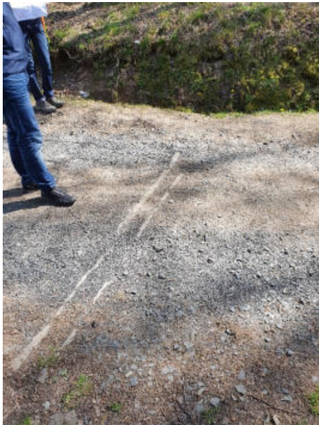
Abbildung 46: Weg mit Graben ab Enklave Scheuerfeld, östlich der Waldstraße mit zugesetzter Querrinne
