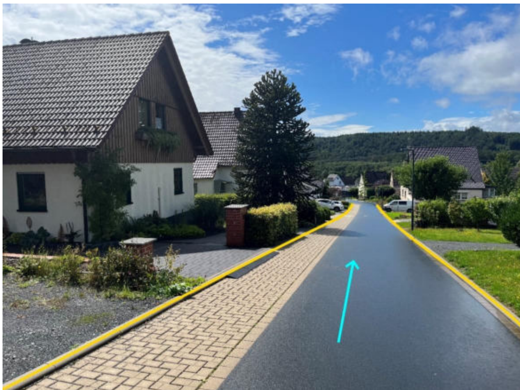
Abbildung 184: Notabflussweg "Brucher Straße" mit Fließrichtung (hellblau) und Bordanlagen (gelb)
