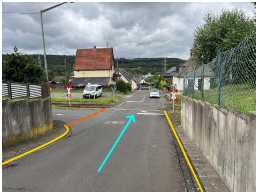
Abbildung 124: Notabflussweg "Waldstraße" mit Fließrichtung (hellblau), Aufwallung (orange) und Bordanlagen (gelb)
