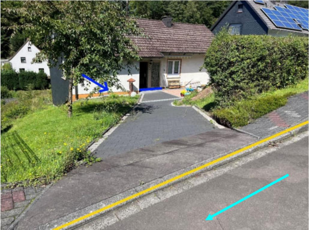
Abbildung 108: Notabflussweg "An der Brache" mit Fließrichtung (hellblau), Bordanlagen (gelb) und Objektschutzmaßnahmen (blau)
