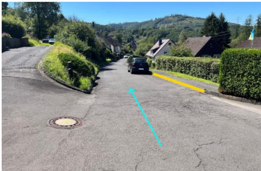
Abbildung 106: Notabflussweg "An der Brache" mit Fließrichtung (hellblau) und Bordanlagen (gelb)
