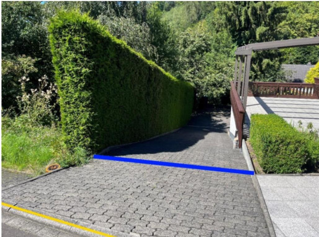
Abbildung 112: Notabflussweg "An der Brache" mit Bordanlagen (gelb) und Objektschutzmaßnahmen (blau)
