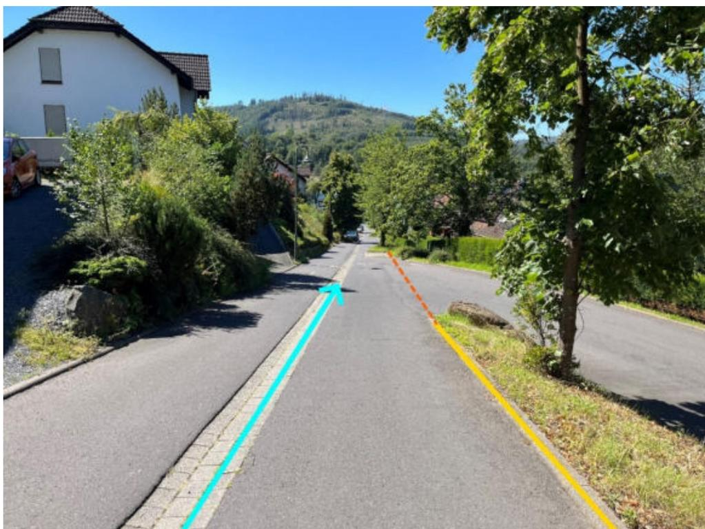
Abbildung 87: Notabflussweg "Am Brandhahn" mit Fließrichtung (hellblau), Bordanlagen (gelb) und Aufwallung (orange)
