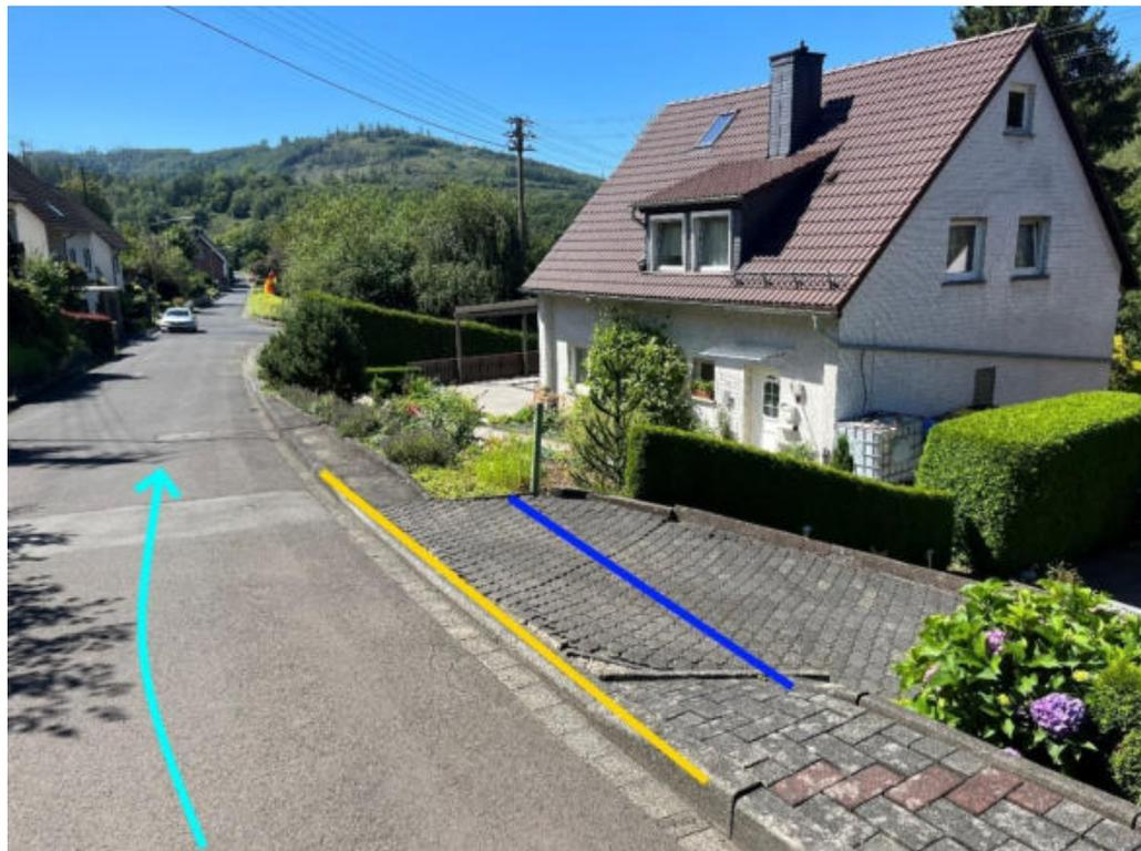
Abbildung 110: Notabflussweg "An der Brache" mit Fließrichtung (hellblau), Bordanlagen (gelb) und Objektschutzmaßnahmen (blau)
