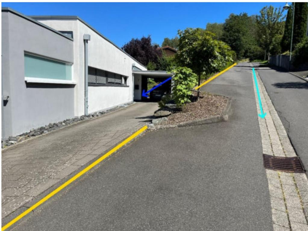
Abbildung 86: Notabflussweg "Am Brandhahn" mit Fließrichtung (hellblau), Bordanlagen (gelb) und Objektschutzmaßnahmen (blau)
