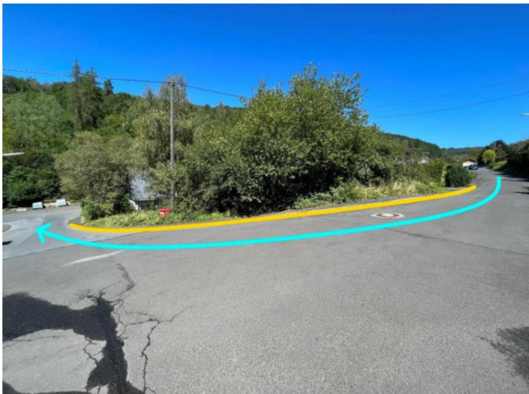
Abbildung 113: Notabflussweg "An der Brache" mit Fließrichtung (hellblau) und Bordanlagen (gelb)
