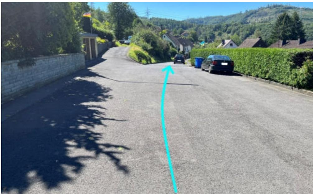
Abbildung 105: Notabflussweg "An der Brache" mit Fließrichtung (hellblau)
