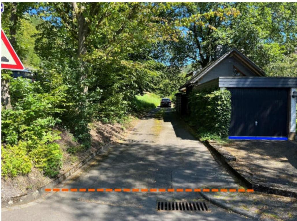
Abbildung 117: Notabflussweg "An der Brache" mit Fließrichtung (hellblau), Aufwallung (orange) und Objektschutzmaßnahmen (blau)
