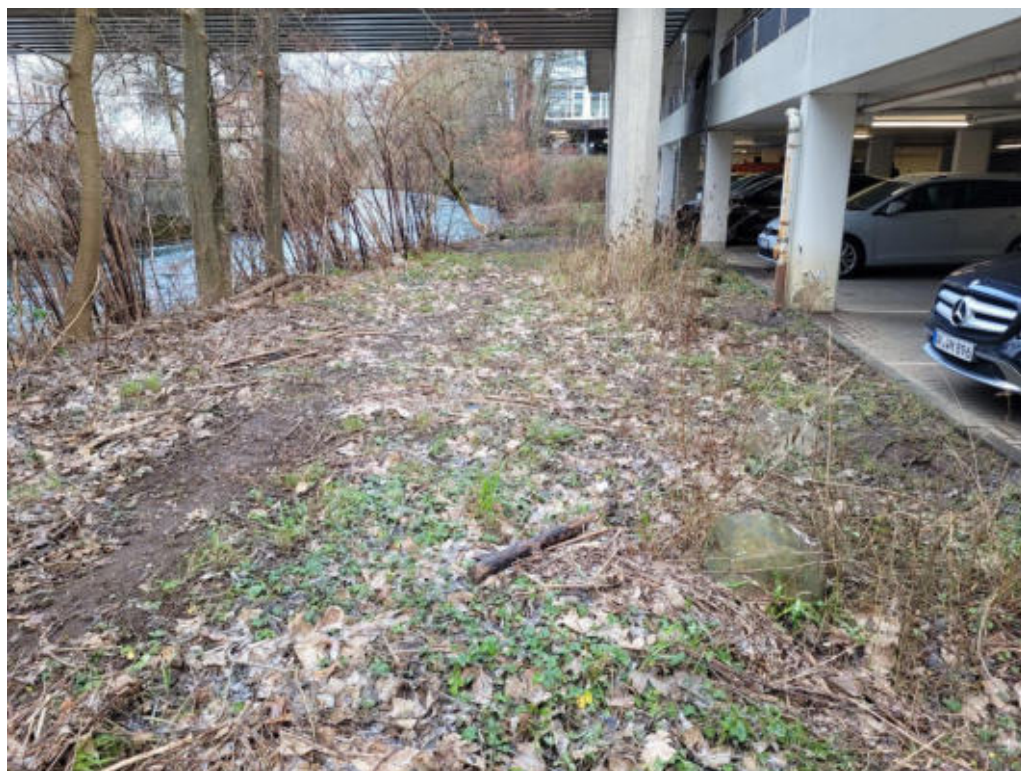
Abbildung 19: Betzdorf, Tiefgarage, flutbar, Vorrichtung für mobilen Hochwasserschutz
