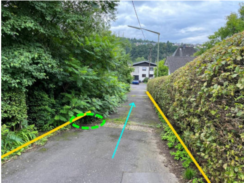
Abbildung 650: Notabflussweg „Martin-Luther-Straße“ mit Fließweg (hellblau), Instandhaltung der Entwässerungseinrichtung (hellgrün) und Bordanlage (gelb)
