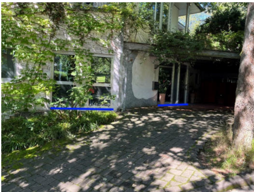
Abbildung 413: Notabflussweg „Allensteiner Straße“ mit Objektschutzmaßnahmen (blau)
