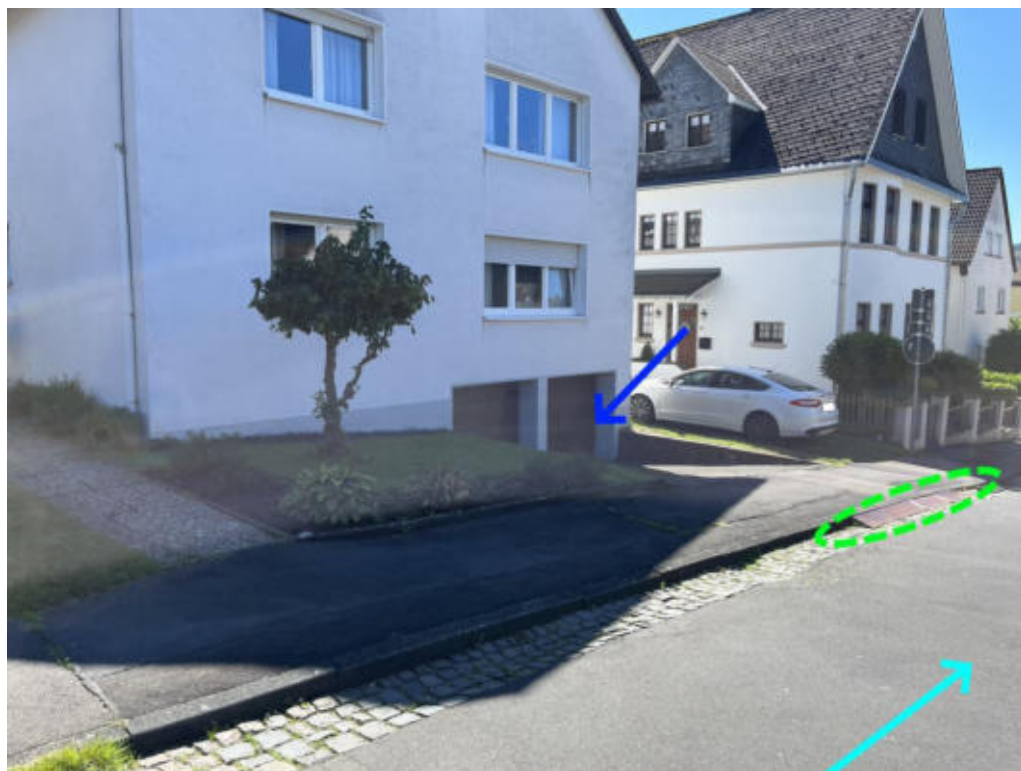
Abbildung 512: Notabflussweg „Bergstraße“ mit Fließweg (hellblau), Objektschutzmaßnahmen (blau) und Instandsetzung der Entwässerungseinrichtung (grün)
