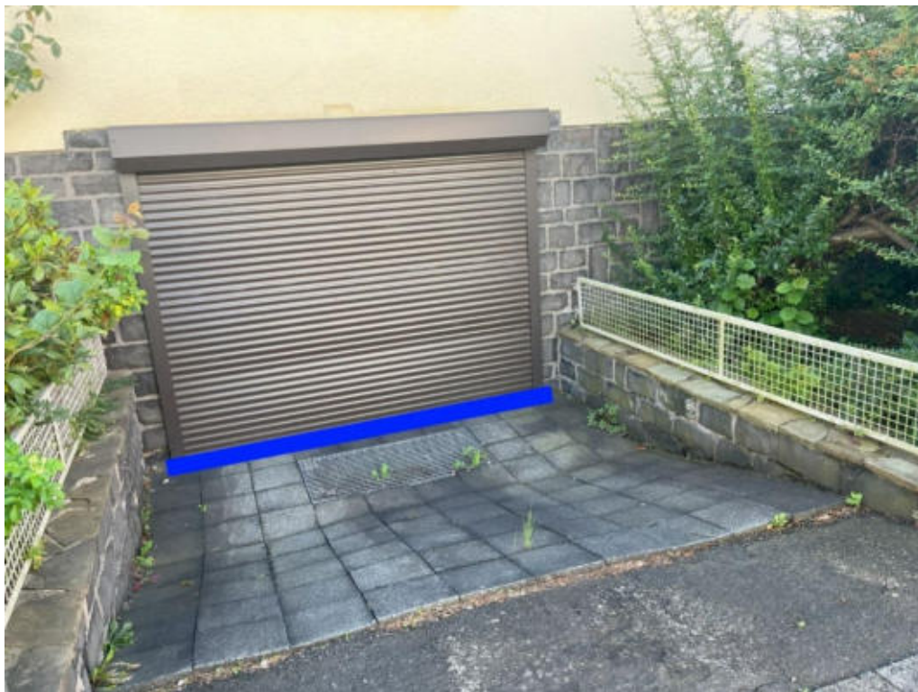
Abbildung 490: Notabflussweg „Schützenstraße“ mit Objektschutzmaßnahmen (blau)
