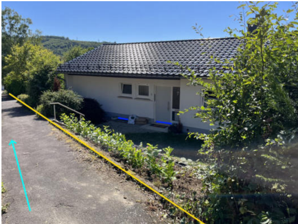
Abbildung 592: Notabflussweg „Breslauer Straße“ mit Fließweg (hellblau), Objektschutzmaßnahmen (blau) und Bordanlage (gelb)
