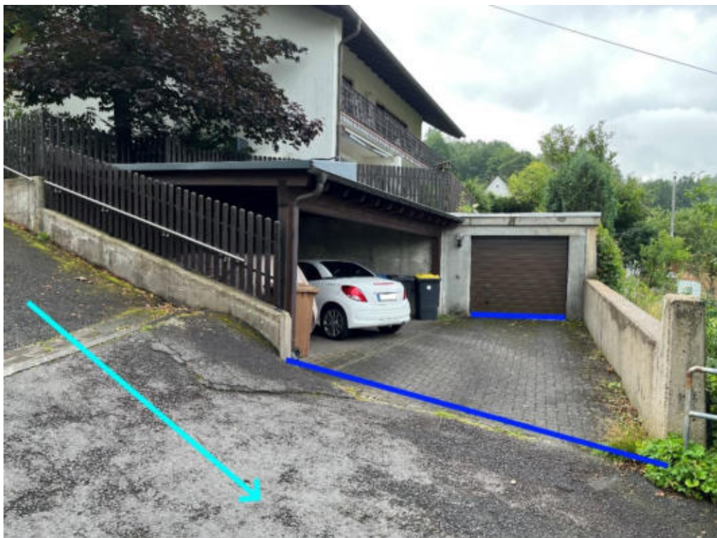
Abbildung 151: Notabflussweg "Starenweg" mit Fließweg (hellblau) und Objektschutzmaßnahmen (blau)
