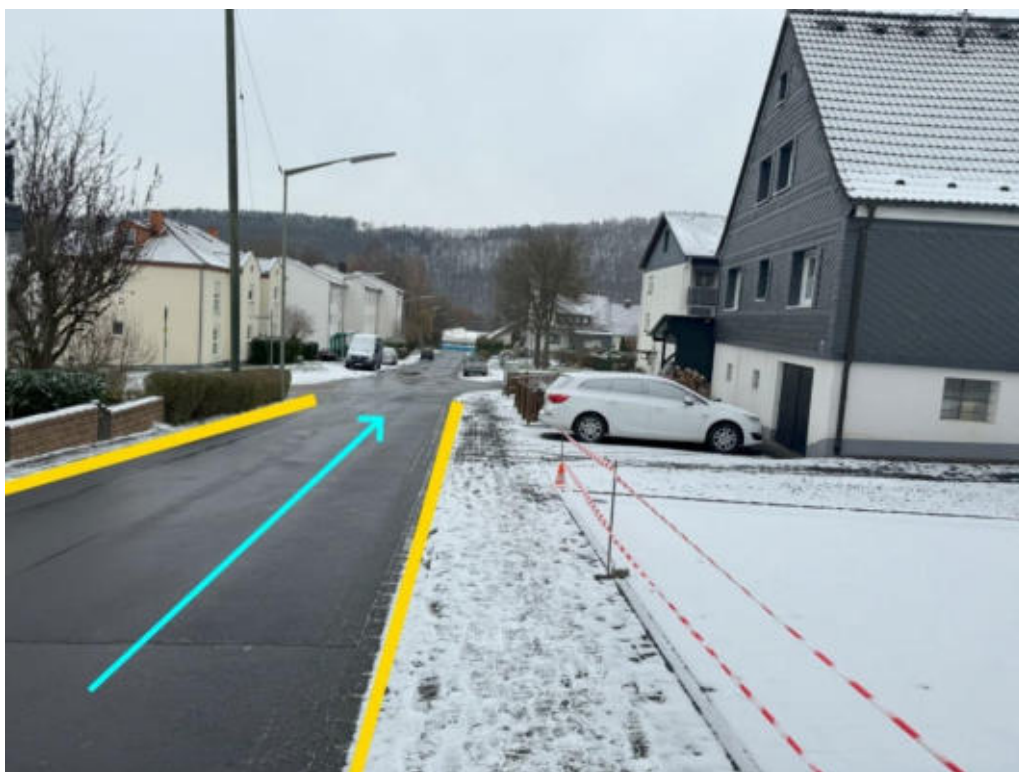
Abbildung 371: Notabflussweg „Theresenstraße“ mit Fließweg (hellblau) und Bordanlage (gelb)
