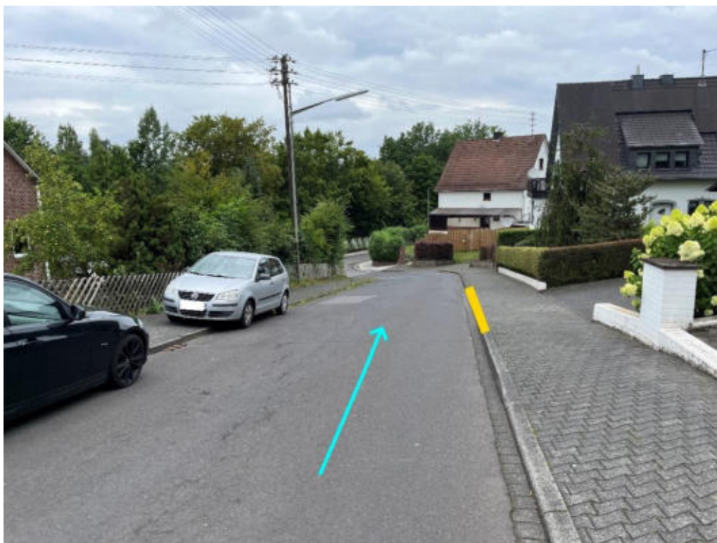
Abbildung 656: Notabflussweg „Martin-Luther-Straße“ mit Fließweg (hellblau) und Bordanlage (gelb)
