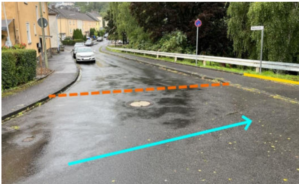
Abbildung 71: Notabflussweg "Weiherstraße" mit Fließweg (hellblau), Aufwallung (orange) und Kreuzung mit „Im Steilhang“
