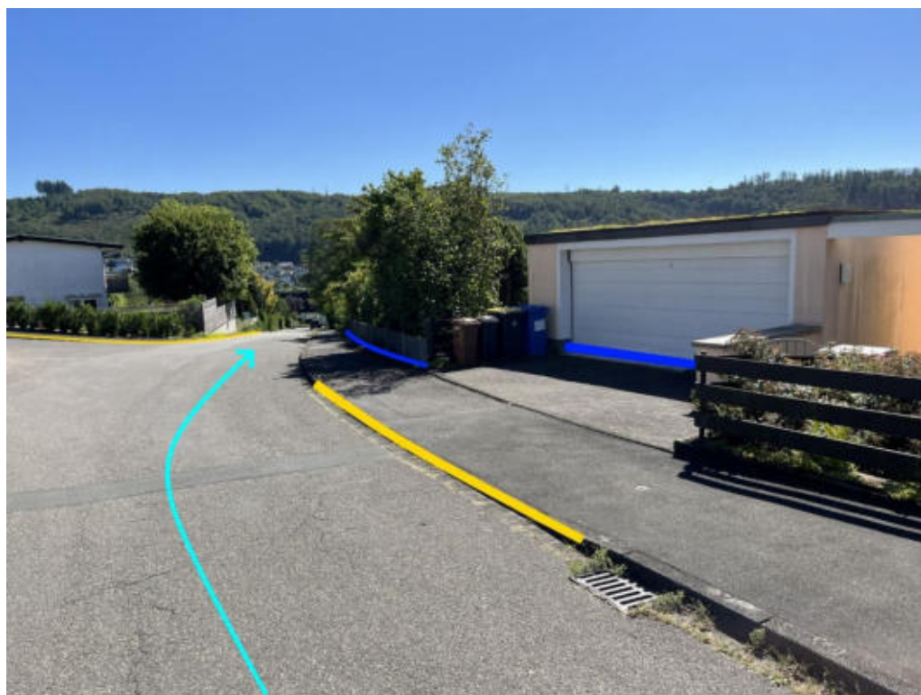
Abbildung 589: Notabflussweg „Breslauer Straße“ mit Fließweg (hellblau), Objektschutzmaßnahmen (blau) und Bordanlage (gelb)
