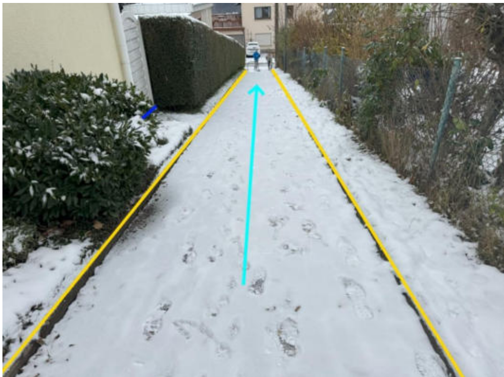
Abbildung 267: Notabflussweg „Erlenweg“ mit Fließweg (hellblau), Objektschutzmaßnahmen (blau) und Bordanlage (gelb)
