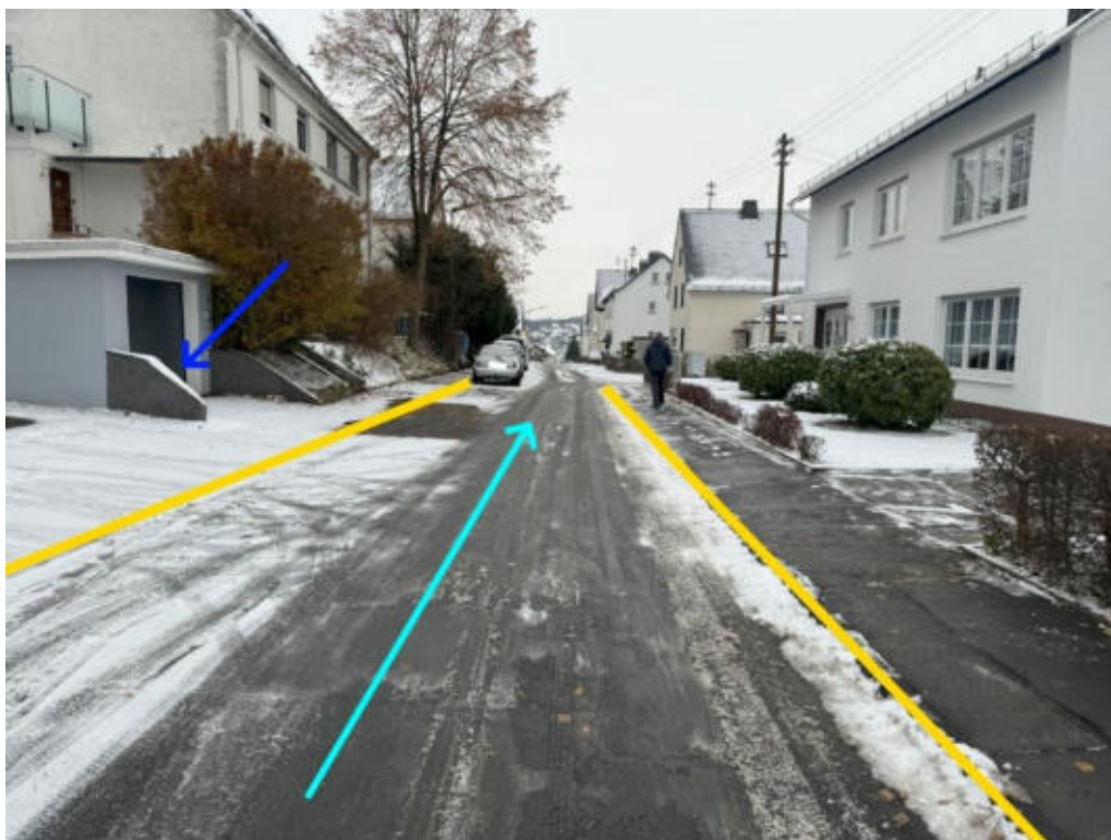
Abbildung 272: Notabflussweg „Lindenstraße“ mit Fließweg (hellblau), Objektschutzmaßnahmen (blau) und Bordanlage (gelb)
