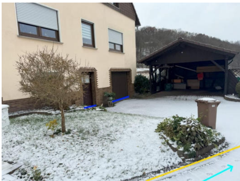
Abbildung 362: Notabflussweg „In der Gasse“ mit Fließweg (hellblau), Objektschutzmaßnahmen (blau) und Bordanlage (gelb)
