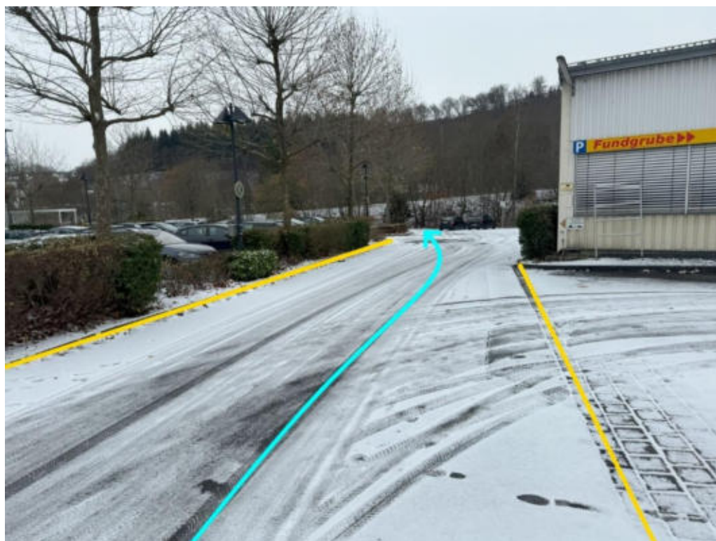
Abbildung 397: Notabflussweg „Industriestraße“ mit Fließweg (hellblau) und Bordanlage (gelb)
