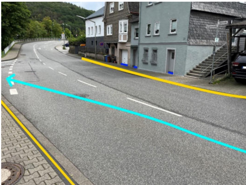
Abbildung 189: Notabflussweg „Rainstraße“ mit Fließweg (hellblau), Objektschutzmaßnahmen (blau) und Bordanlage (gelb)
