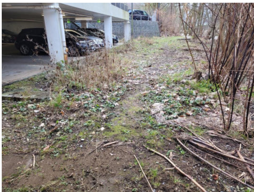
Abbildung 20: Betzdorf, Tiefgarage, flutbar, Vorrichtung für mobilen Hochwasserschutz
