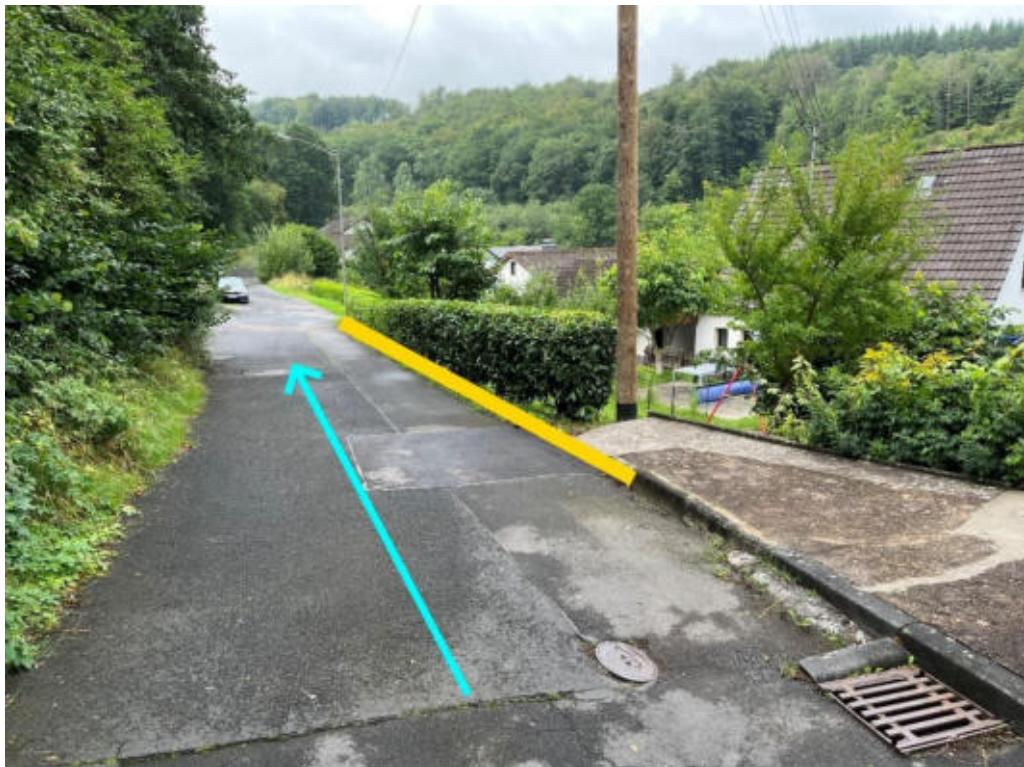
Abbildung 109: Notabflussweg "Zum Eisweiher" mit Fließweg (hellblau) und Bordanlage (gelb)
