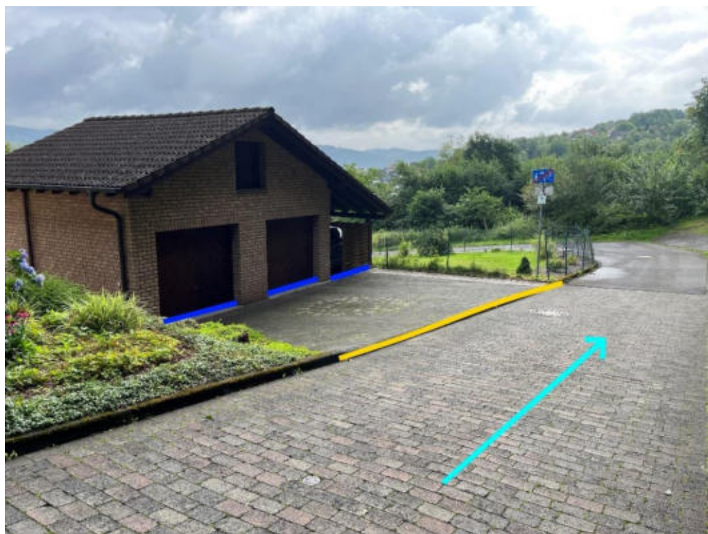
Abbildung 203: Notabflussweg „Pestalozzistraße“ mit Fließweg (hellblau), Objektschutzmaßnahmen (blau) und Bordanlage (gelb)
