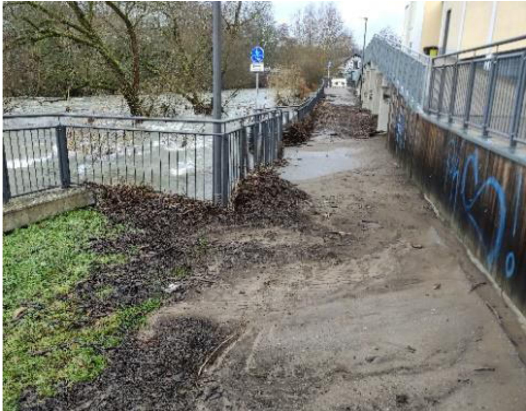
Abbildung 11: Betzdorf, Radweg an Tiefgarage
