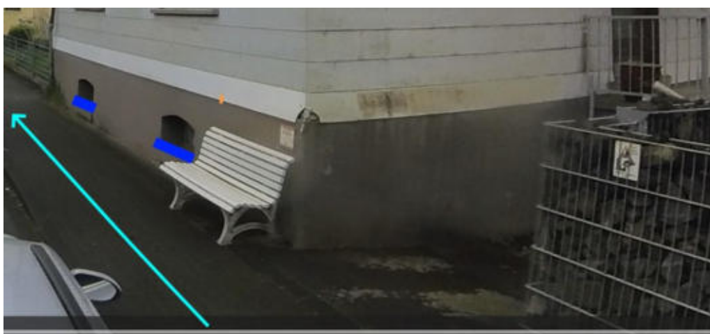
Abbildung 684: Notabflussweg „Eisenbahnstraße“ mit Fließweg (hellblau) und Objektschutzmaßnahmen (blau)
