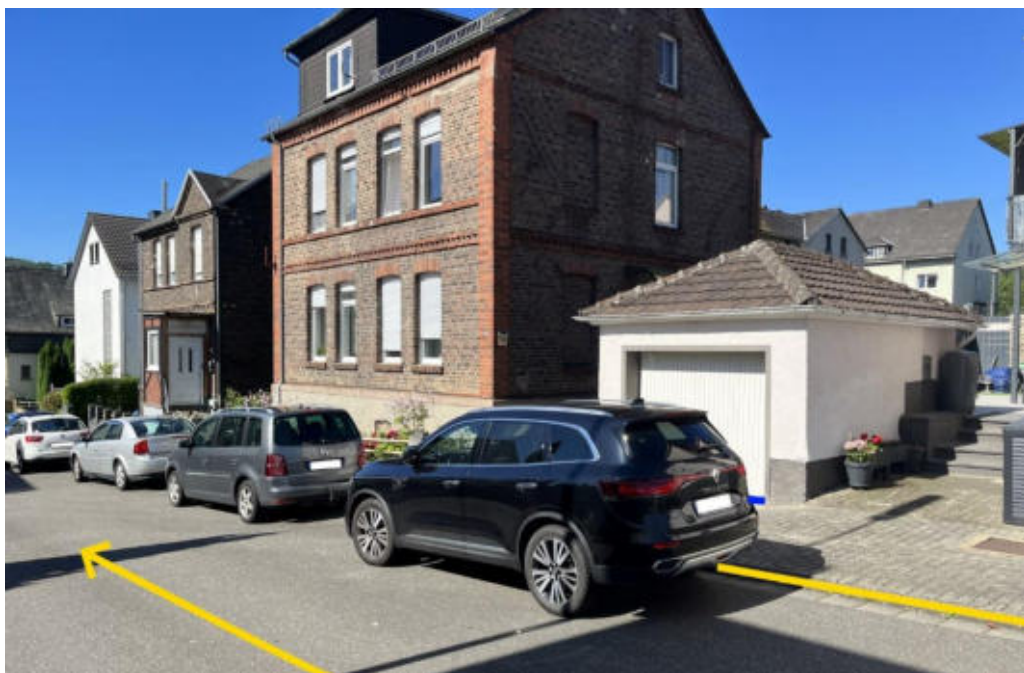
Abbildung 525: Notabflussweg „Schulstraße“ mit Fließweg (hellblau), Objektschutzmaßnahmen (blau) und Bordanlage (gelb)
