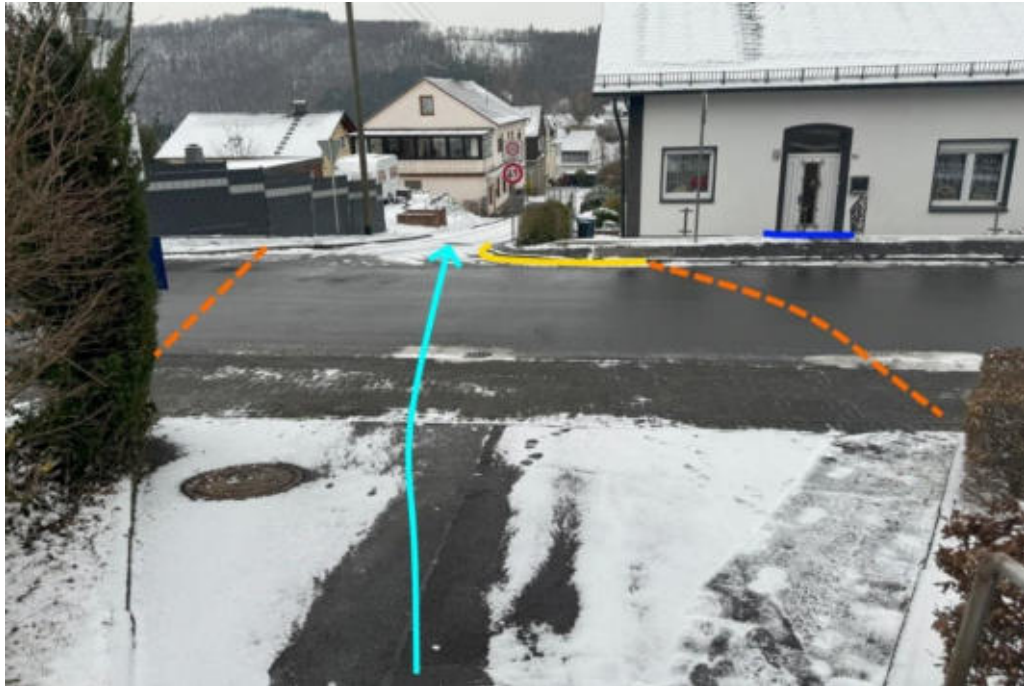
Abbildung 282: Notabflussweg „Klosterweg“ mit Fließweg (hellblau), Objektschutzmaßnahmen (blau), Aufwallung (orange) und Bordanlage (gelb)
