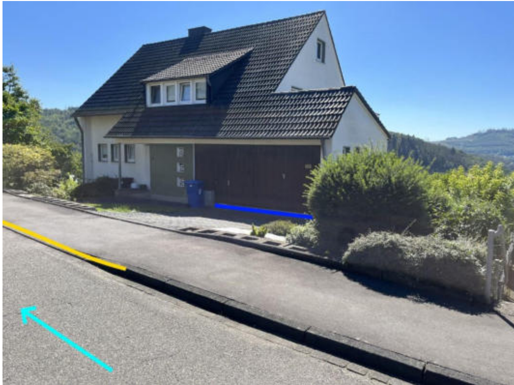
Abbildung 586: Notabflussweg „Breslauer Straße“ mit Fließweg (hellblau), Objektschutzmaßnahmen (blau) und Bordanlage (gelb)
