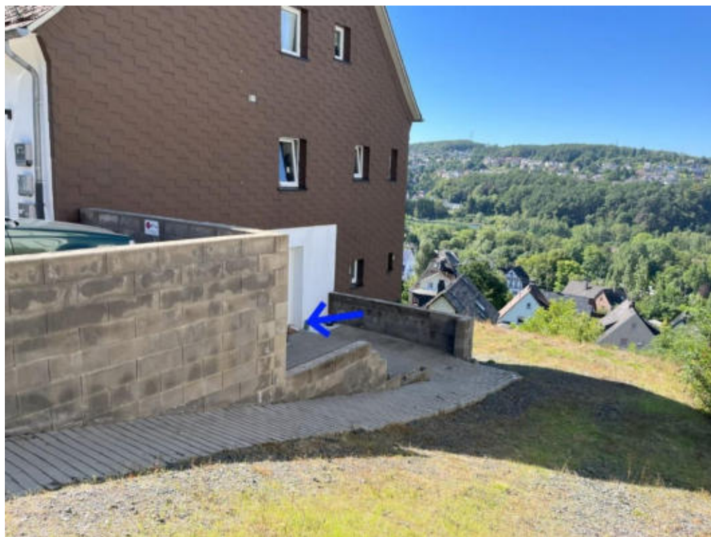
Abbildung 424: Notabflussweg „Nizzaweg“ mit Objektschutzmaßnahmen (blau)
