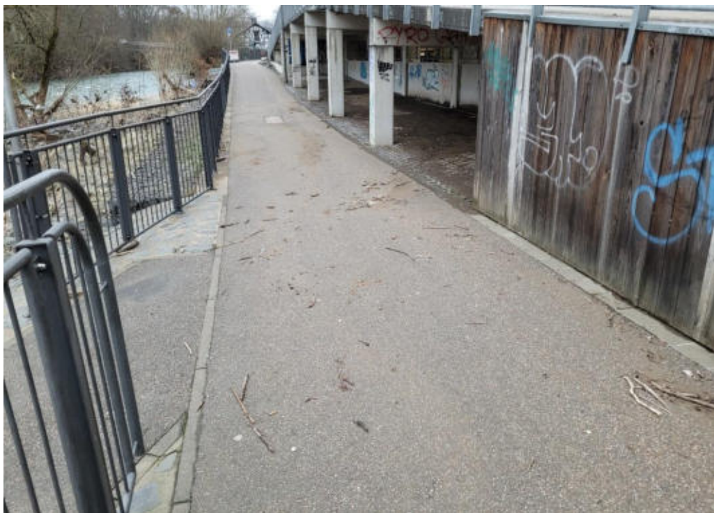
Abbildung 12: Betzdorf, Radweg an Tiefgarage
