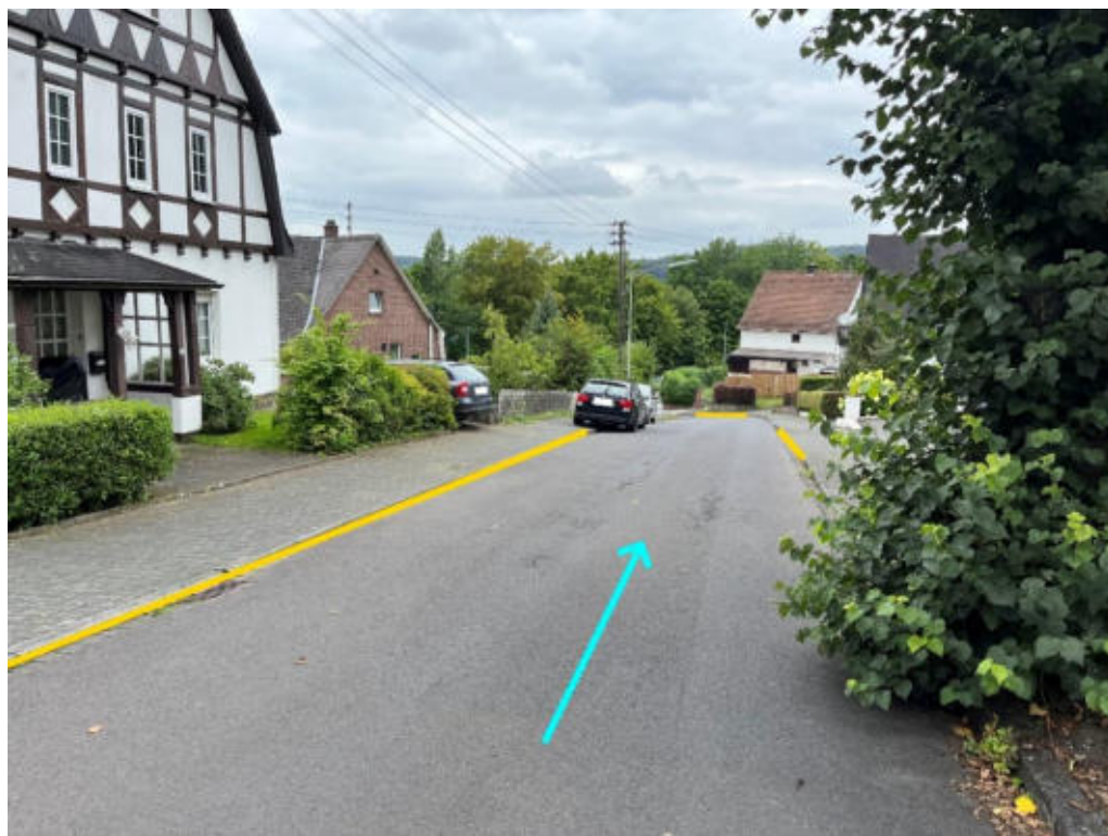
Abbildung 654: Notabflussweg „Martin-Luther-Straße“ mit Fließweg (hellblau) und Bordanlage (gelb)
