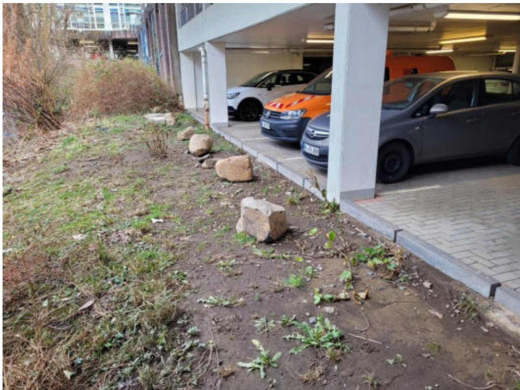
Abbildung 22: Betzdorf, Tiefgarage, flutbar, Vorrichtung für mobilen Hochwasserschutz
