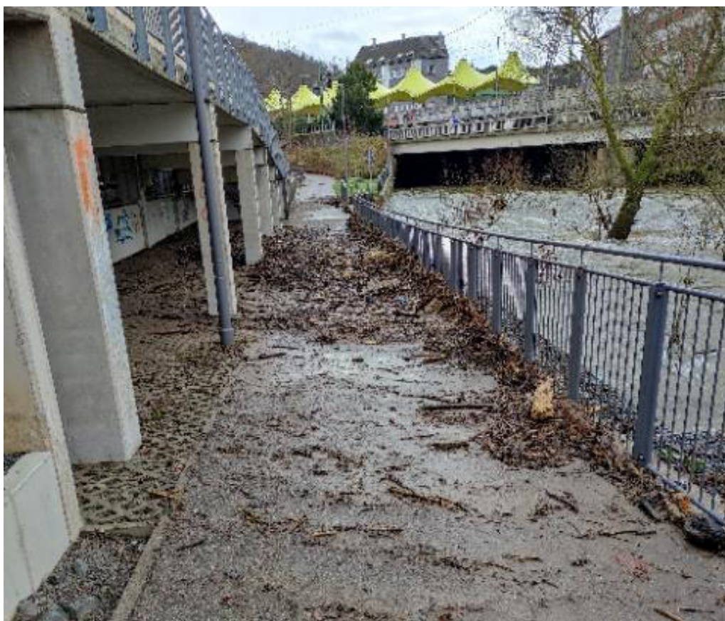
Abbildung 16: Betzdorf, Radweg an Tiefgarage
