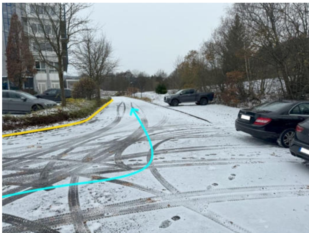
Abbildung 399: Notabflussweg „Industriestraße“ mit Fließweg (hellblau) und Bordanlage (gelb)
