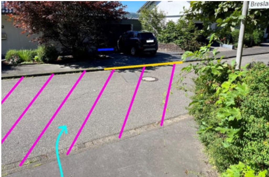
Abbildung 416: Notabflussweg „Allensteiner Straße“ mit Fließweg (hellblau), Objektschutzmaßnahmen (blau), Bordanlage (gelb), Senke (lila) und Kreuzung mit Breslauer Straße
