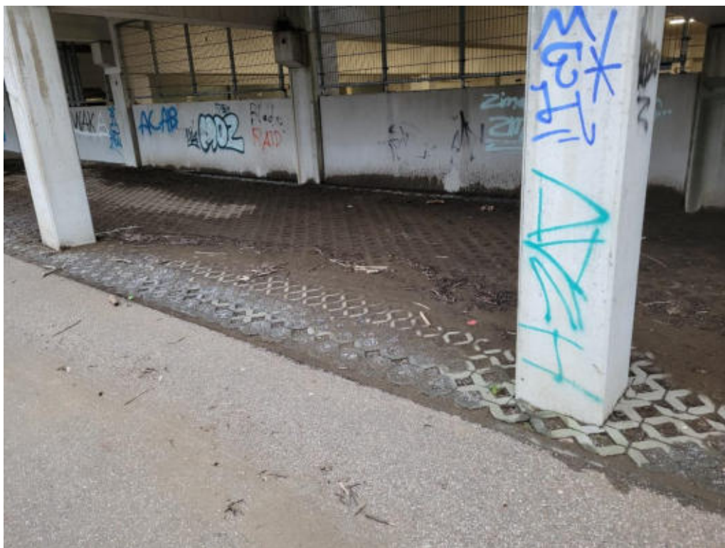
Abbildung 15: Betzdorf, Radweg an Tiefgarage
