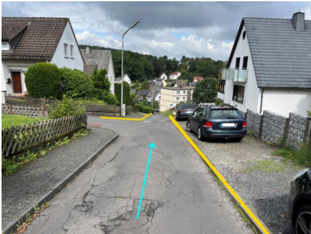
Abbildung 162: Notabflussweg "Mühlenweg" mit Fließweg (hellblau) und Bordanlage (gelb)
