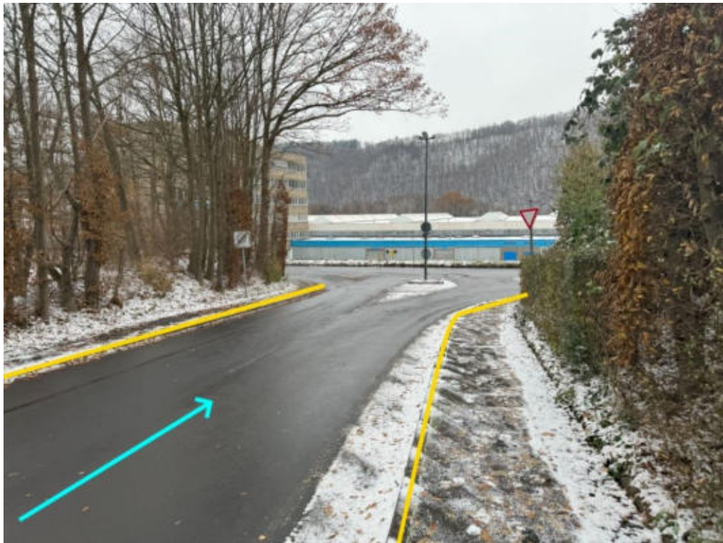
Abbildung 378: Notabflussweg „Theresenstraße“ mit Fließweg (hellblau) und Bordanlage (gelb)
