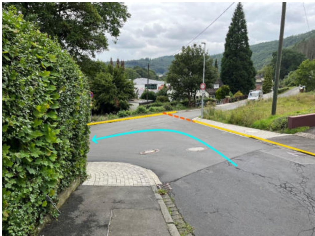
Abbildung 625: Notabflussweg „Jung-Stilling-Straße“ mit Fließweg (hellblau), Aufwallung (orange) und Bordanlage (gelb)
