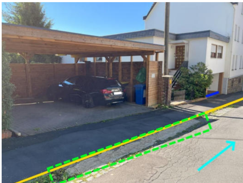
Abbildung 443: Notabflussweg „Brunnenstraße“ mit Fließweg (hellblau), Instandsetzung der Entwässerungseinrichtung (hellgrün), Objektschutzmaßnahme (blau) und Bordanlage (gelb)
