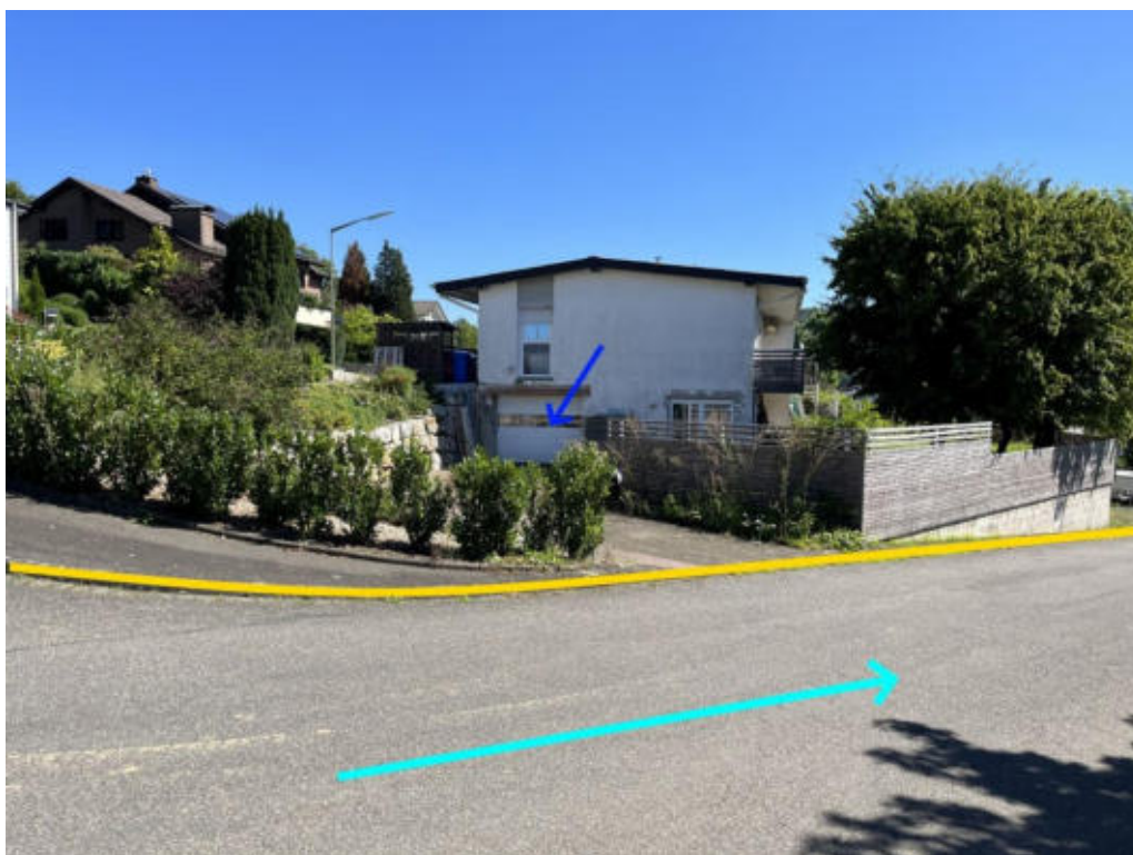
Abbildung 591: Notabflussweg „Breslauer Straße“ mit Fließweg (hellblau), Objektschutzmaßnahmen (blau) und Bordanlage (gelb)
