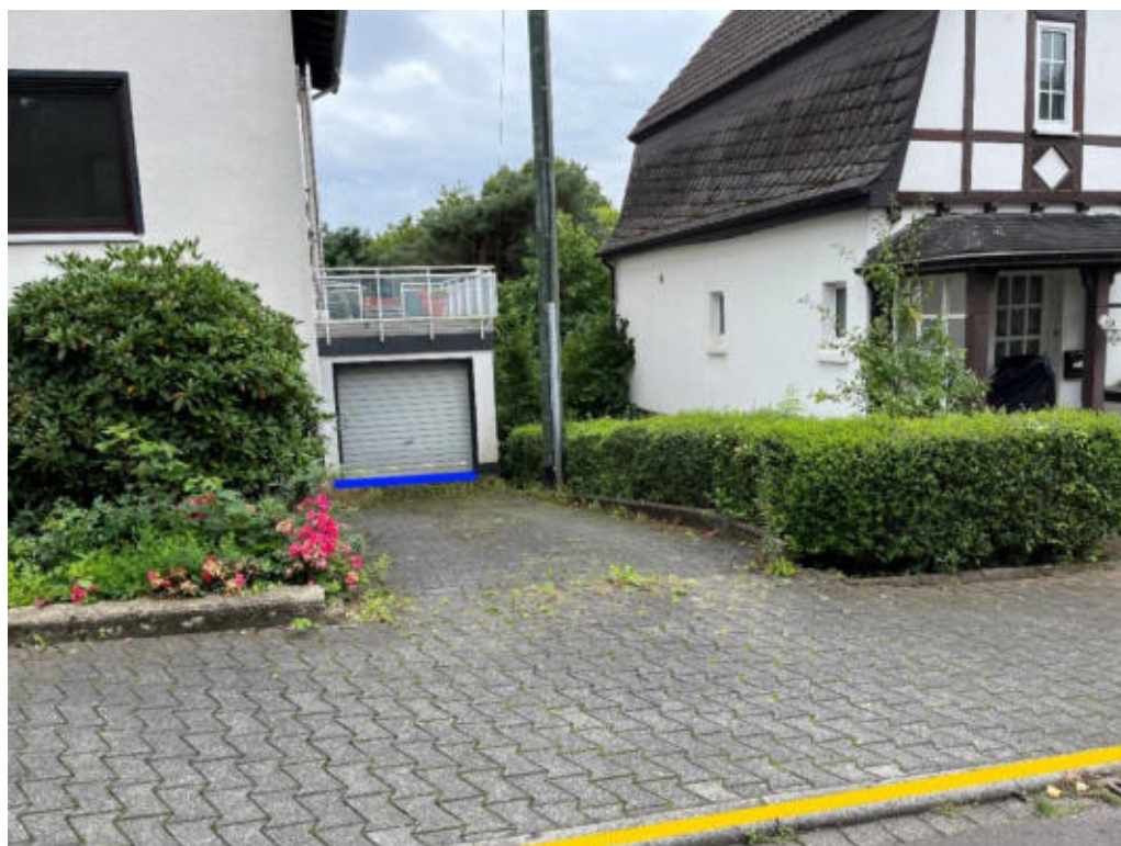
Abbildung 655: Notabflussweg „Martin-Luther-Straße“ mit Fließweg (hellblau) und Bordanlage (gelb)
