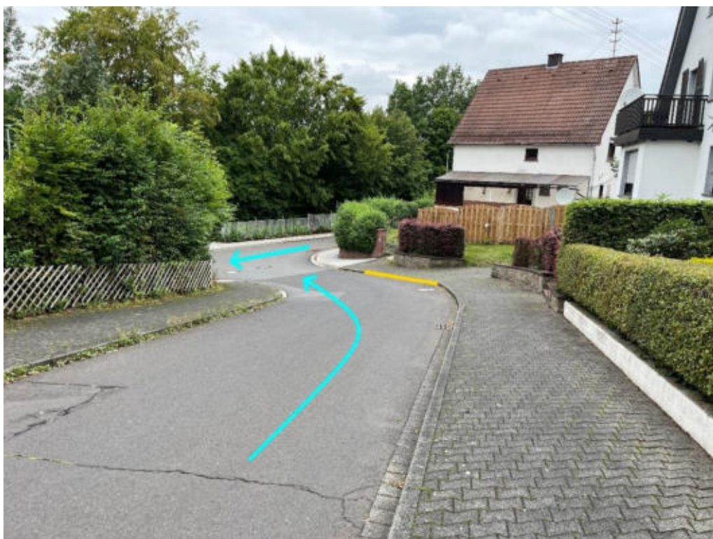
Abbildung 657: Notabflussweg „Martin-Luther-Straße“ mit Fließweg (hellblau) und Bordanlage (gelb)
