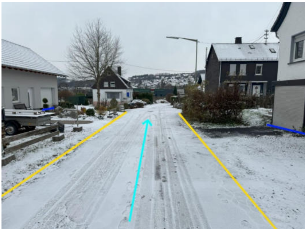
Abbildung 357: Notabflussweg „In der Gasse“ mit Fließweg (hellblau), Objektschutzmaßnahmen (blau) und Bordanlage (gelb)
