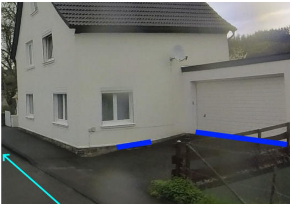
Abbildung 755: Notabflussweg „Ketteler Straße“ mit Fließweg (hellblau) und Objektschutzmaßnahmen (blau)
