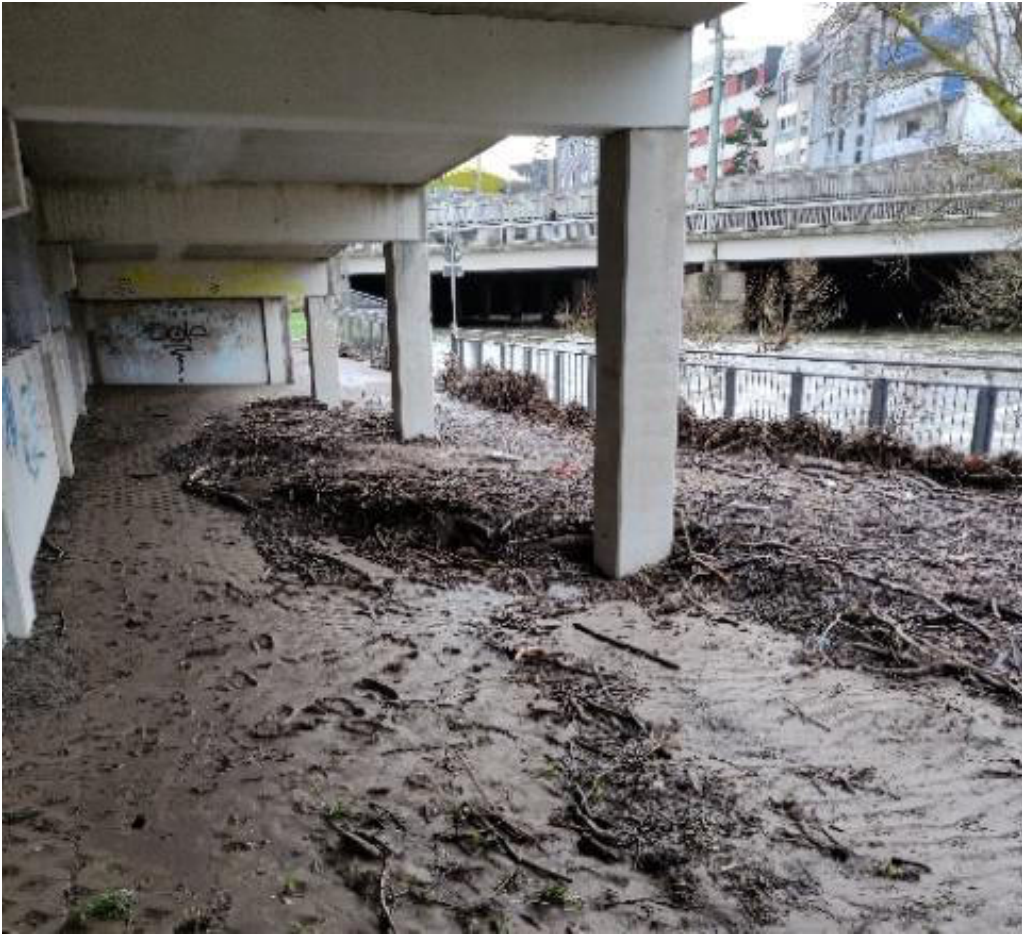
Abbildung 13: Betzdorf, Radweg und Tiefgarage
