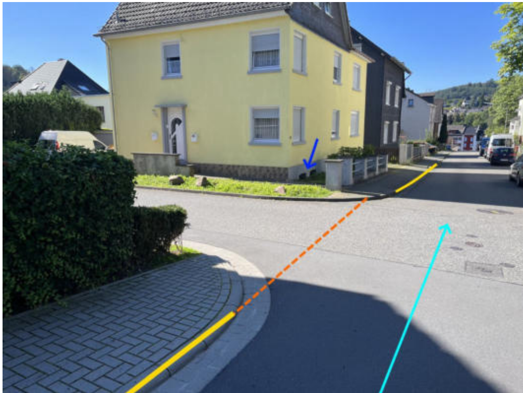
Abbildung 556: Notabflussweg „Bismarckstraße“ mit Fließweg (hellblau), Objektschutzmaßnahmen (blau), Bordanlage (gelb) und Aufwallung (orange)
