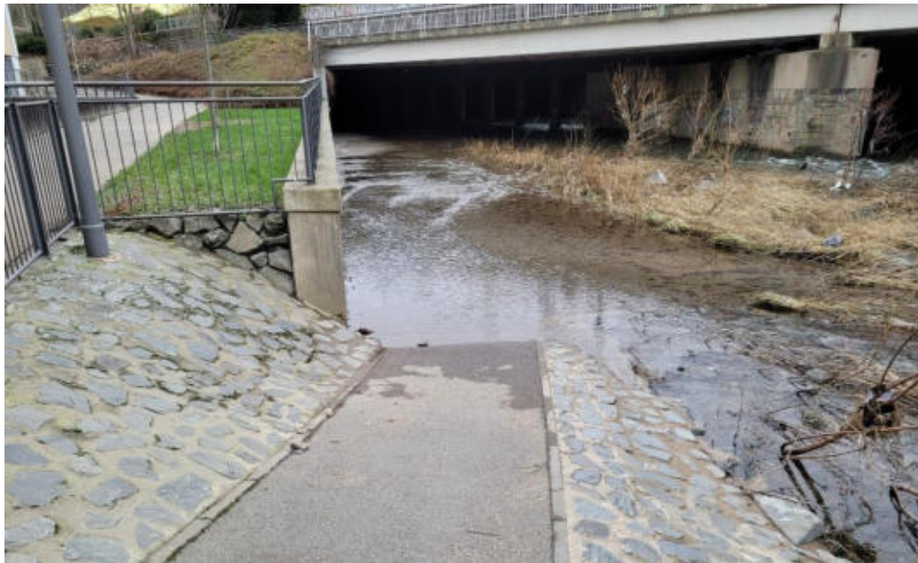
Abbildung 17: Betzdorf, Radweg an Tiefgarage
