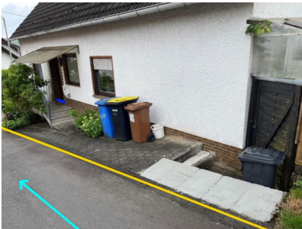
Abbildung 208: Notabflussweg „Pestalozzistraße“ mit Fließweg (hellblau), Objektschutzmaßnahmen (blau) und Bordanlage (gelb)
