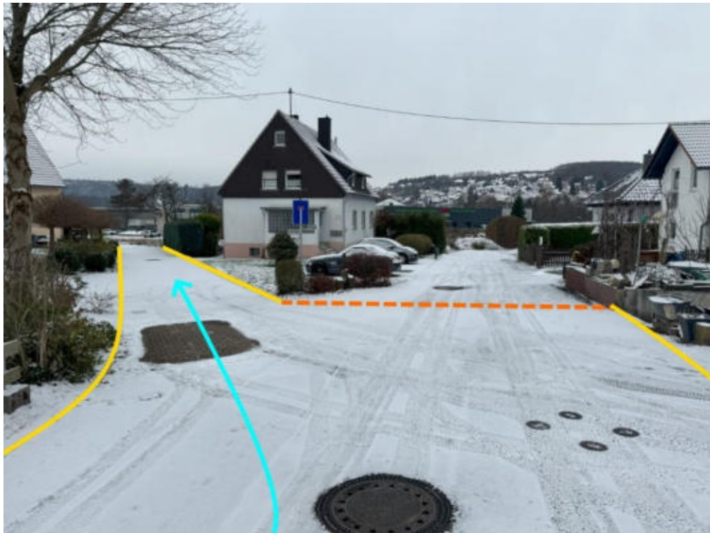
Abbildung 358: Notabflussweg „In der Gasse“ mit Fließweg (hellblau), Aufwallung (orange) und Bordanlage (gelb)
