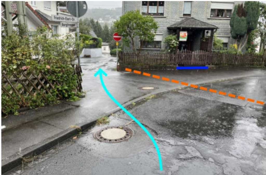
Abbildung 86: Notabflussweg "Friedrich-Ebert-Straße" mit Fließweg (hellblau), Objektschutzmaßnahmen (blau), Aufwallung (orange) und Kreuzung mit Burggasse
