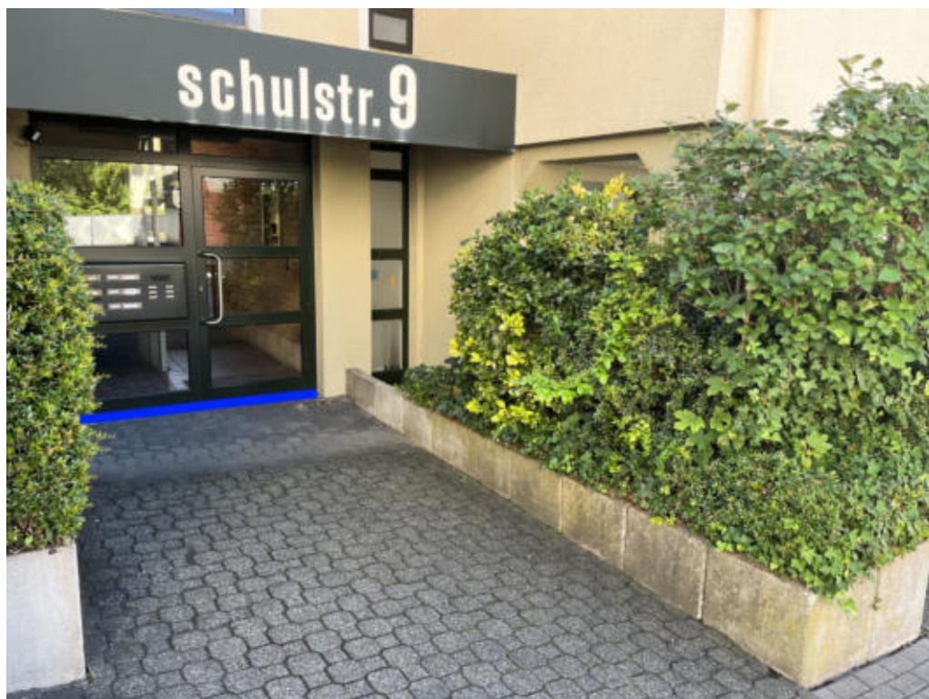
Abbildung 535: Notabflussweg „Schulstraße“ mit Objektschutzmaßnahmen (blau)
