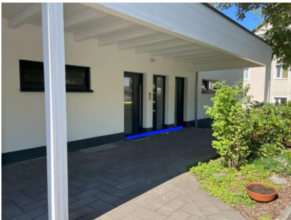
Abbildung 423: Notabflussweg „Nizzaweg“ mit Objektschutzmaßnahmen (blau)
