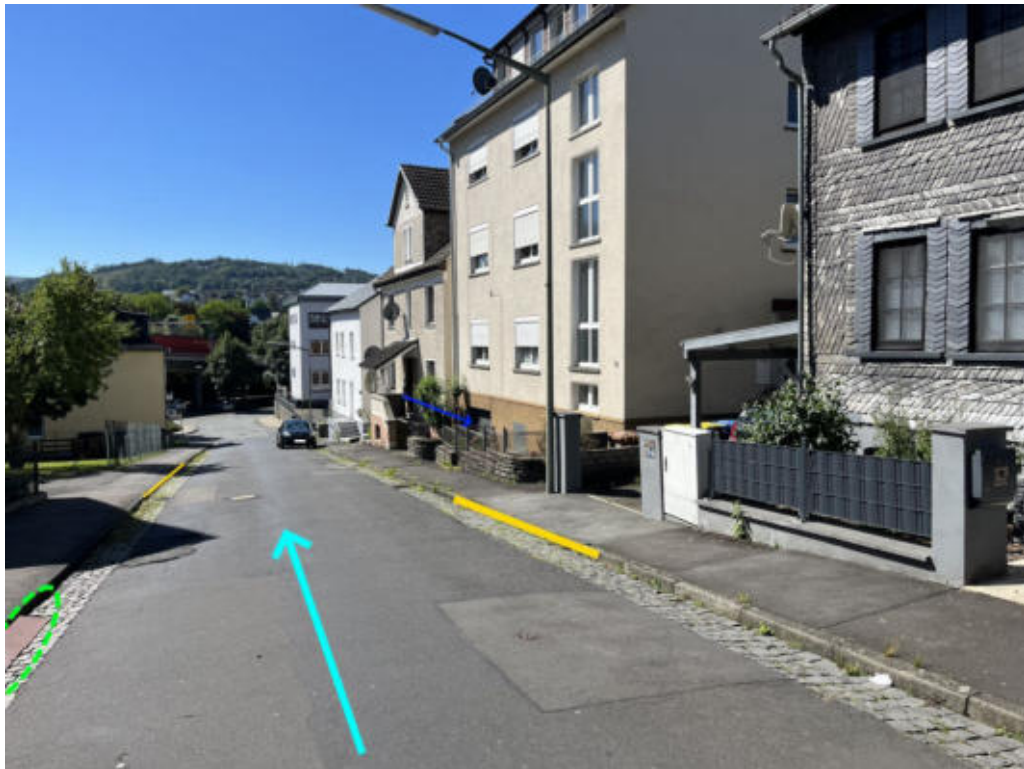
Abbildung 514: Notabflussweg „Bergstraße“ mit Fließweg (hellblau), Instandsetzung der Entwässerungseinrichtung (grün) und Bordanlage (gelb)
