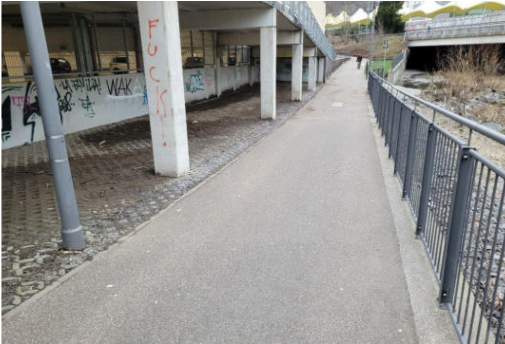
Abbildung 14: Betzdorf, Radweg an Tiefgarage
