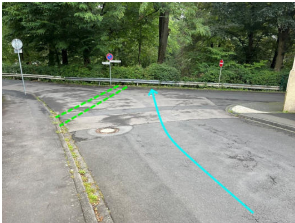
Abbildung 251: Notabflussweg „Birkenstraße“ mit Fließweg (hellblau), Querschlag (hellgrün) und Einleitung in den Eisweiherbach
