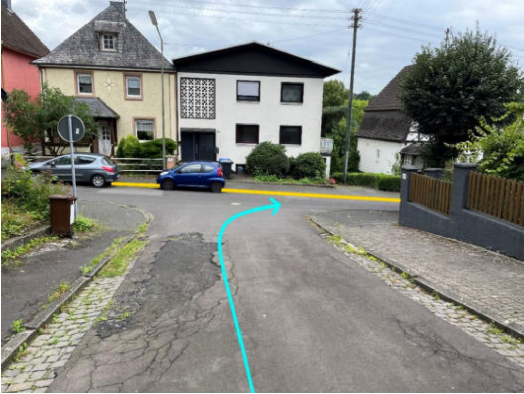
Abbildung 653: Notabflussweg „Martin-Luther-Straße“ mit Fließweg (hellblau) und Bordanlage (gelb)
