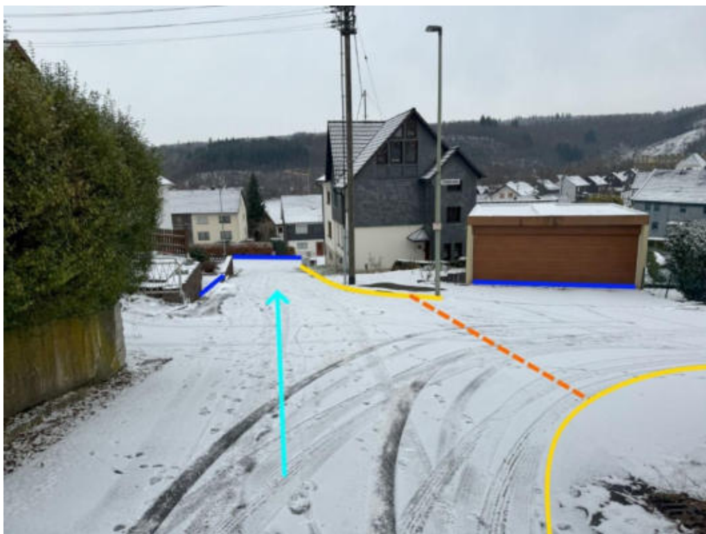
Abbildung 338: Notabflussweg „Kurze Straße“ mit Fließweg (hellblau), Objektschutzmaßnahmen (blau), Aufwällung (orange) und Bordanlage (gelb)
