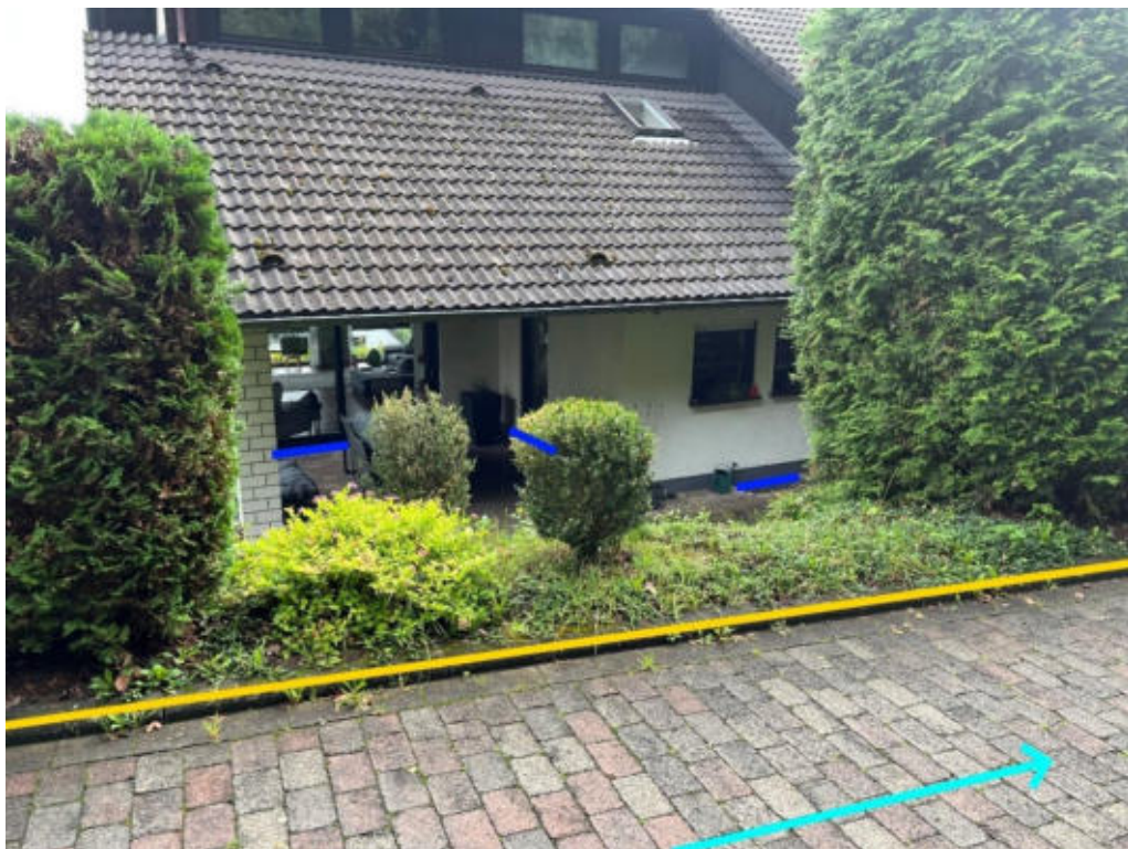
Abbildung 199: Notabflussweg „Pestalozzistraße“ mit Fließweg (hellblau), Objektschutzmaßnahmen (blau) und Bordanlage (gelb)
