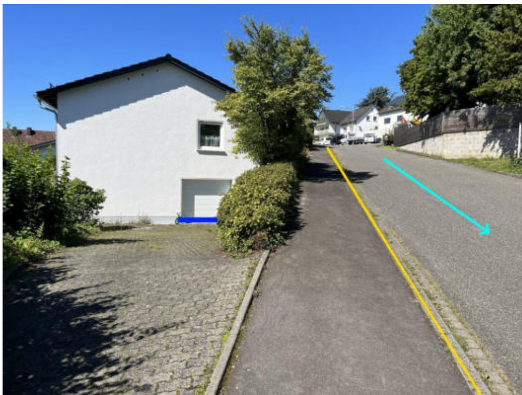
Abbildung 594: Notabflussweg „Breslauer Straße“ mit Fließweg (hellblau), Objektschutzmaßnahmen (blau) und Bordanlage (gelb)
