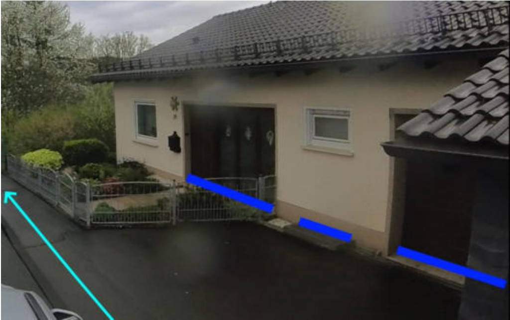
Abbildung 752: Notabflussweg „Ketteler Straße“ mit Fließweg (hellblau) und Objektschutzmaßnahmen (blau)
