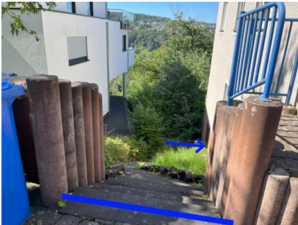
Abbildung 422: Notabflussweg „Nizzaweg“ mit Objektschutzmaßnahmen (blau)
