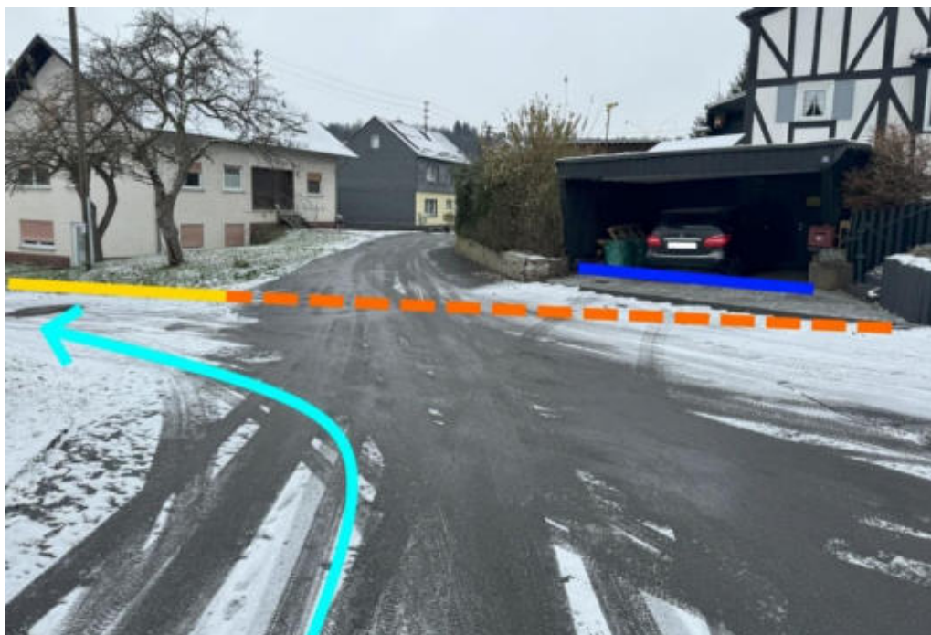
Abbildung 348: Notabflussweg „Dorfstraße“ mit Fließweg (hellblau), Objektschutzmaßnahmen (blau), Aufwallung (orange) und Bordanlage (gelb)
