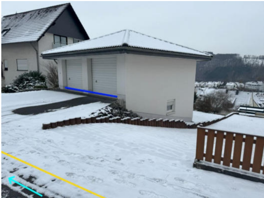
Abbildung 270: Notabflussweg „Lindenstraße“ mit Fließweg (hellblau), Objektschutzmaßnahmen (blau) und Bordanlage (gelb)
