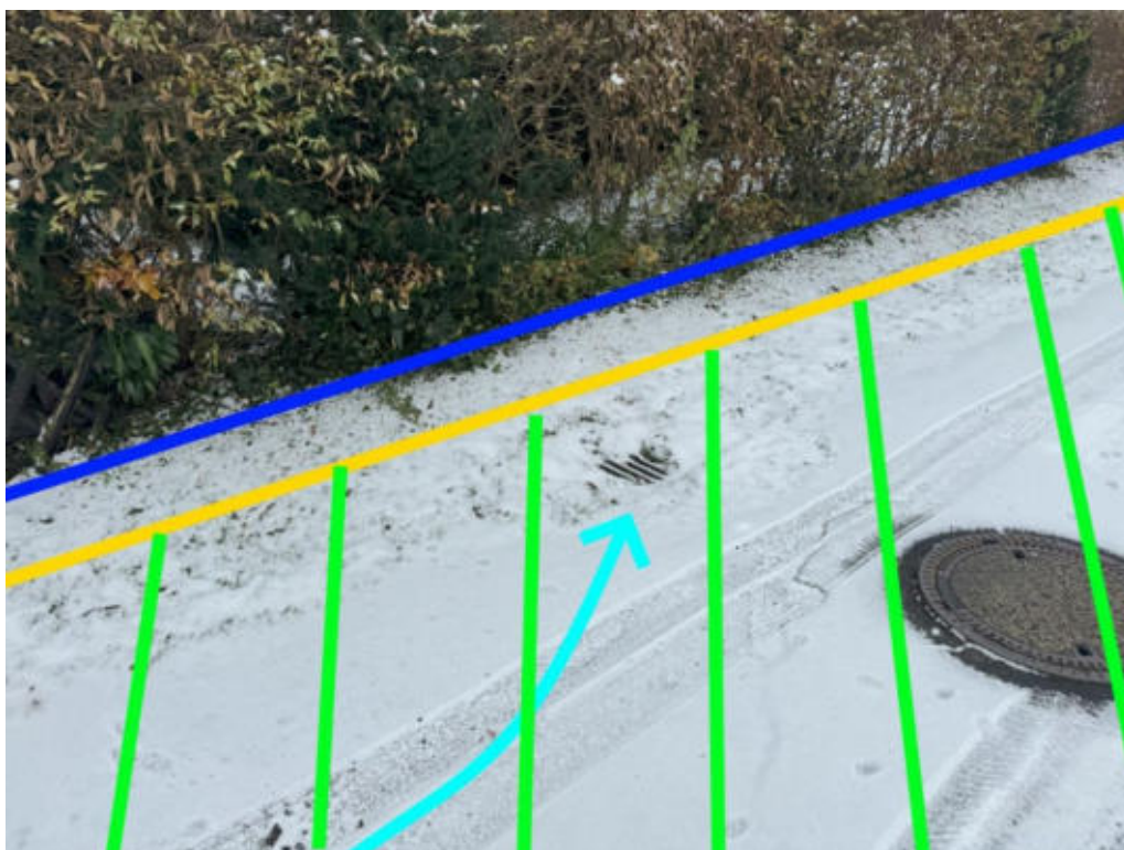
Abbildung 353: Notabflussweg „Wiesenstraße“ mit Fließweg (hellblau), Objektschutzmaßnahmen (blau), Bordanlage (gelb) und Senke (hellgrün)
