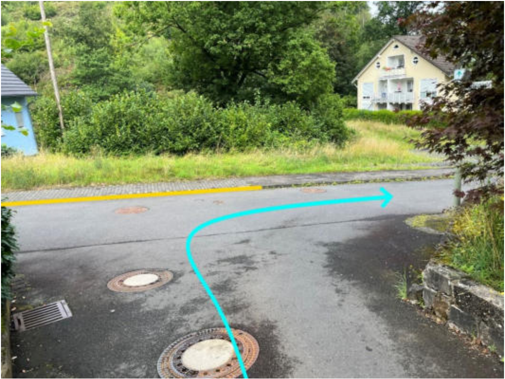
Abbildung 115: Notabflussweg "Schwalbenweg" mit Fließweg (hellblau) und Bordanlage (gelb)
