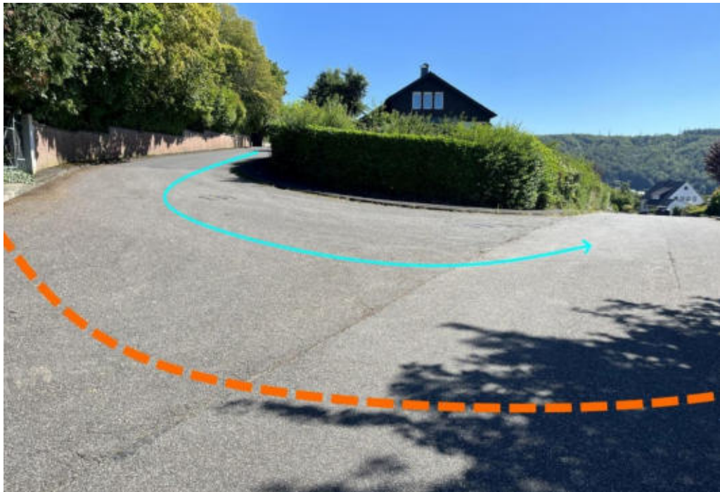
Abbildung 582: Notabflussweg „Bismarckstraße“ mit Fließweg (hellblau) und Aufwallung (orange)
