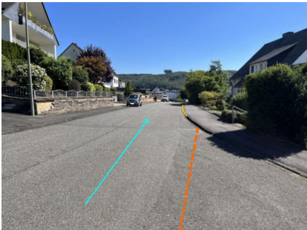
Abbildung 585: Notabflussweg „Breslauer Straße“ mit Fließweg (hellblau), Aufwallung (orange), (blau) und Bordanlage (gelb)
