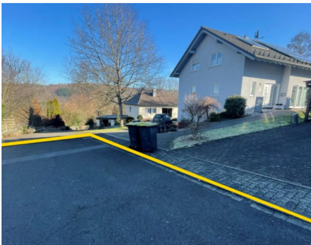
Abbildung 58: Notabflussweg "Am Arsberg" mit Bordanlagen (gelb)
