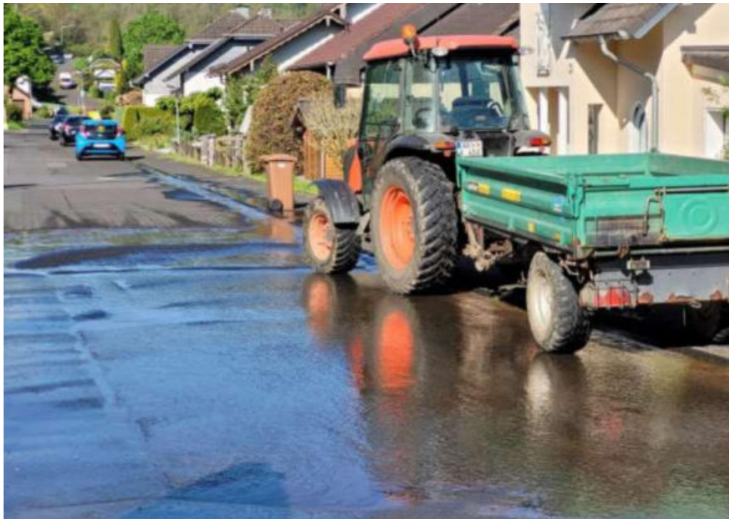
Abbildung 51: Überfluteter Straßenkörper Am Arsberg → Gefahrenpunkt 14.24
