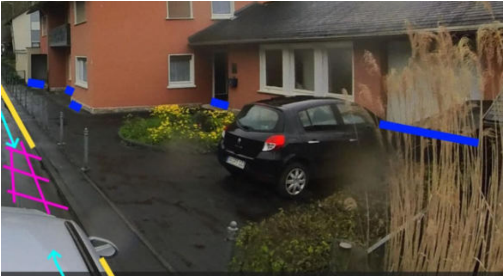
Abbildung 240: Notabflussweg "Mittelweg" mit Fließrichtung (hellblau), Bordanlagen (gelb), Senke (magenta) und Objektschutzmaßnahmen (blau)
