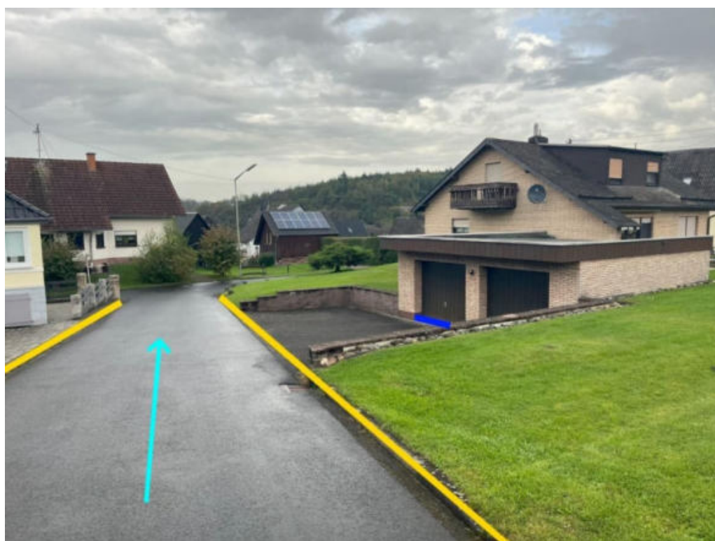
Abbildung 163: Notabflussweg "Dorfwiese" mit Fließrichtung (hellblau), Bordanlagen (gelb), Objektschutzmaßnahmen (blau) und Kreuzung mit Amselweg
