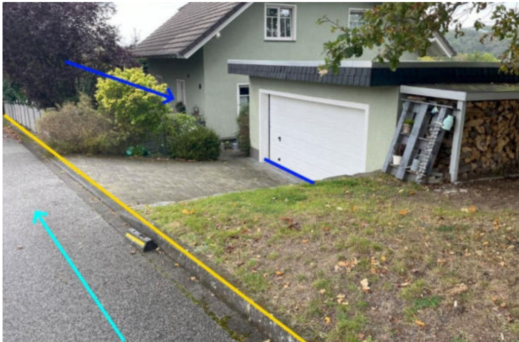
Abbildung 117: Notabflussweg "Schutzbacher Weg" mit Fließrichtung (hellblau), Bordanlagen (gelb) und Objektschutzmaßnahmen (blau)
