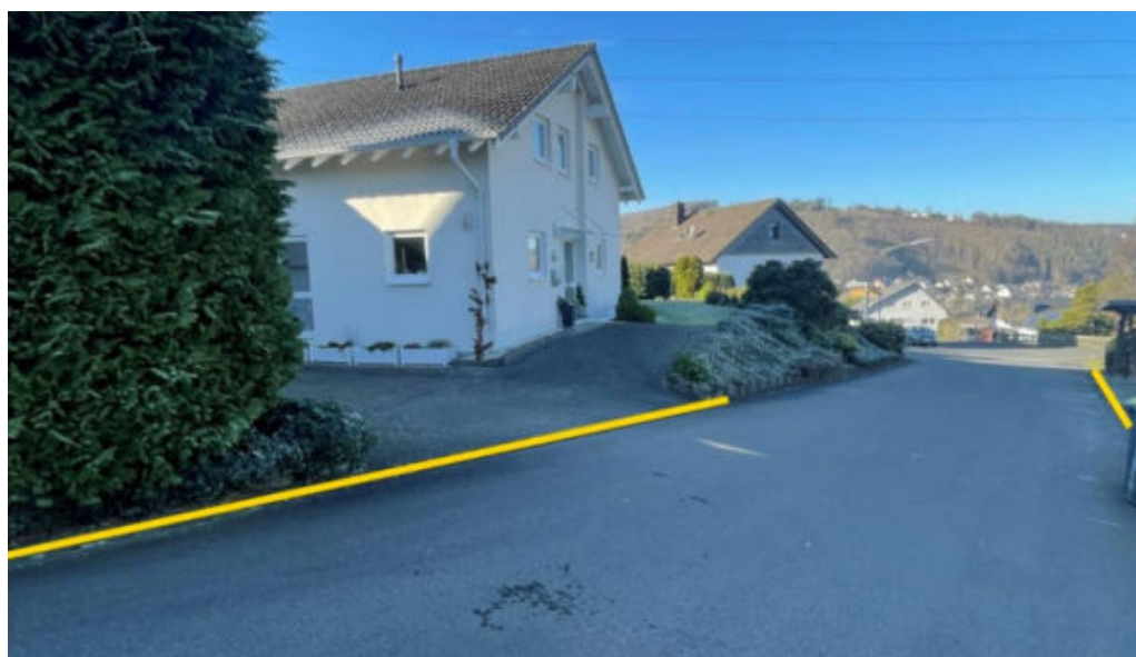
Abbildung 102: Notabflussweg "Am Krahnstück" mit Bordanlagen (gelb)
