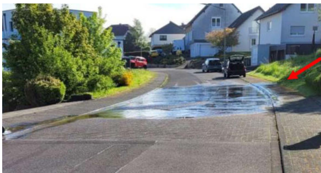
Abbildung 48: Zwischen Am Arsberg Nr. 26 und 30 tritt Hangwasser auf den Straßenkörper über → Gefahrenpunkt 14.24
