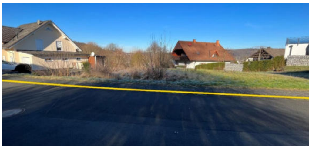
Abbildung 63: Notabflussweg "Am Arsberg" mit Bordanlagen (gelb)
