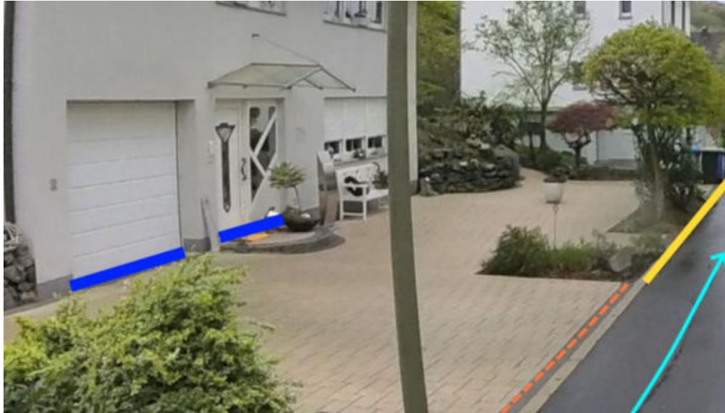
Abbildung 224: Notabflussweg "Imhäuserhof" mit Fließrichtung (hellblau), Aufwallung (orange) Bordanlagen (gelb) und Objektschutzmaßnahmen (blau)
