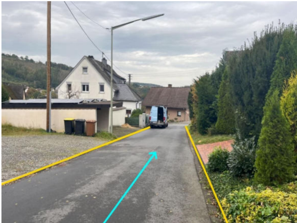
Abbildung 113: Notabflussweg "Im Heidchesgarten" mit Fließrichtung (hellblau), Bordanlagen (gelb) und Objektschutzmaßnahmen (blau)
