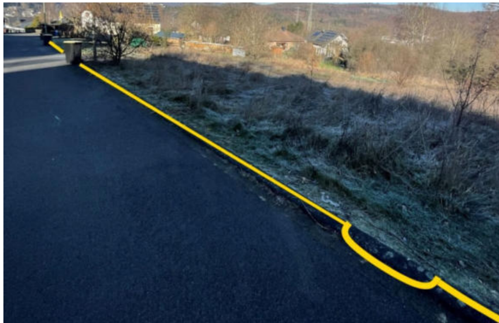
Abbildung 101: Notabflussweg "Am Krahnstück" mit Bordanlagen (gelb)
