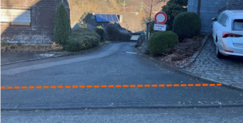
Abbildung 126: Notabflussweg "Schutzbacher Weg" mit Aufwallung (orange)
