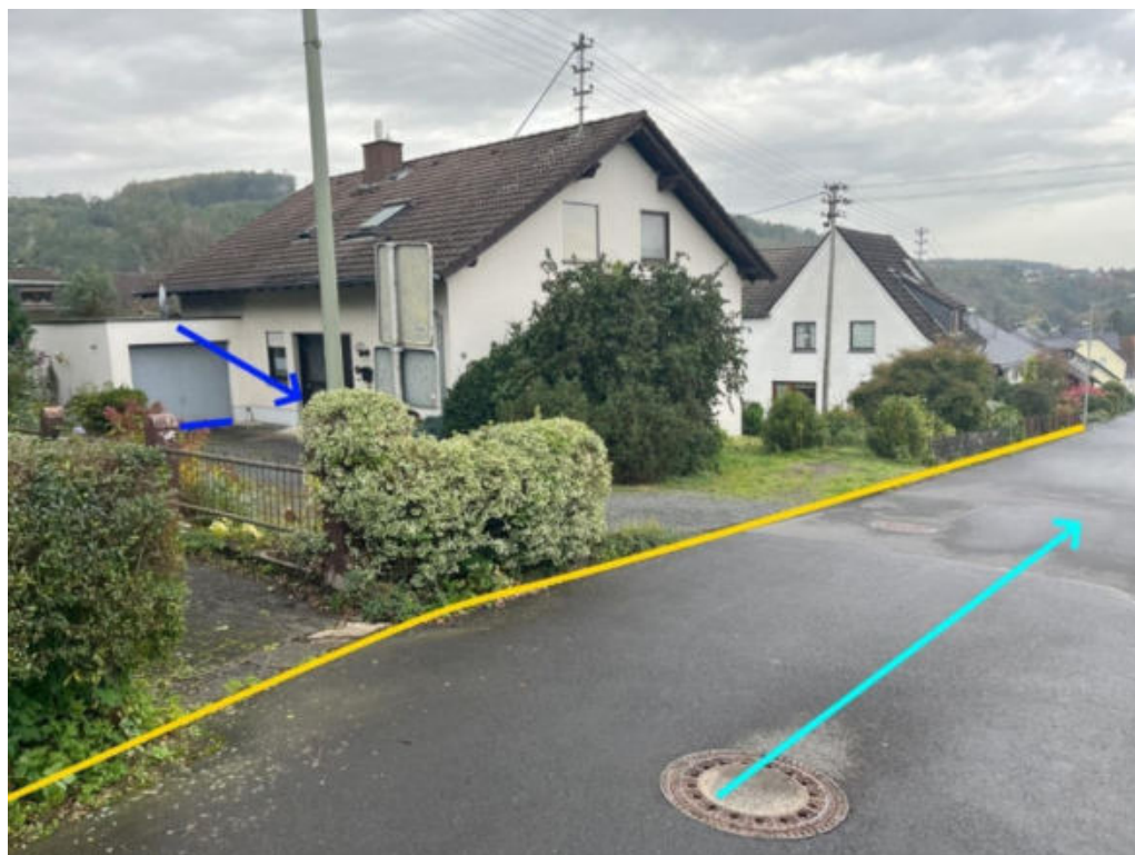
Abbildung 154: Notabflussweg "Dorfwiese" mit Fließrichtung (hellblau) und Bordanlagen (gelb)
