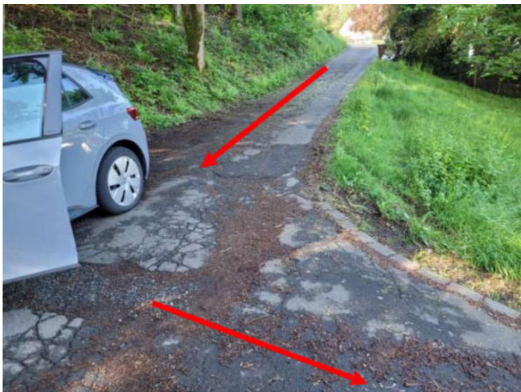
Abbildung 53: Oberflächenabfluss durch Hangwasser über die Waldstraße → Gefahrenpunkt 14.25
