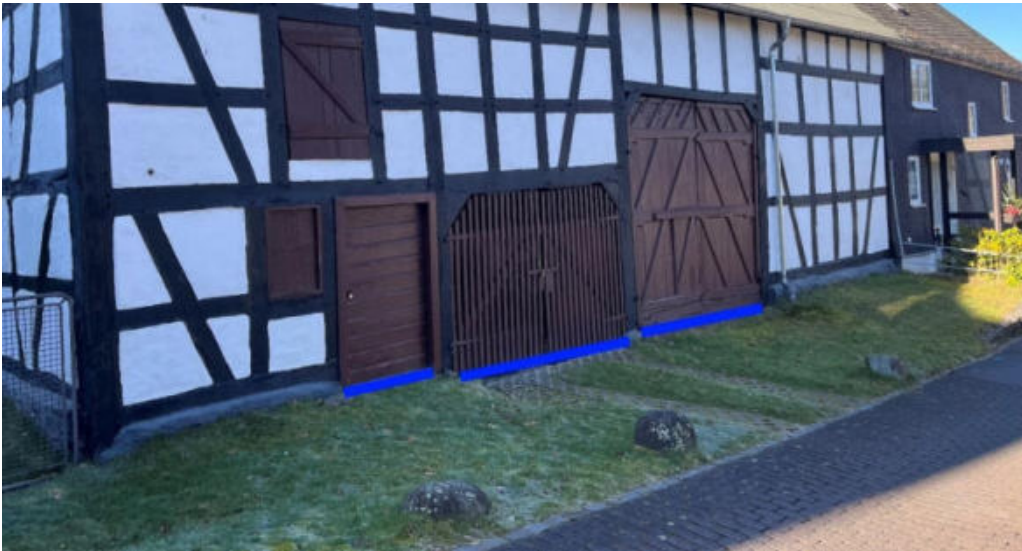
Abbildung 95: Notabflussweg "Schützenstraße" mit Objektschutzmaßnahmen (blau)
