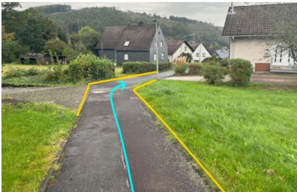
Abbildung 149: Notabflussweg "Dorfwiese" mit Fließrichtung (hellblau) und Bordanlagen (gelb)
