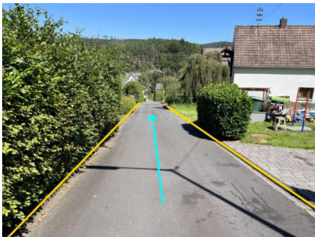
Abbildung 191: Notabflussweg "Hubertusweg" mit Fließrichtung (hellblau) und Bordanlagen (gelb)
