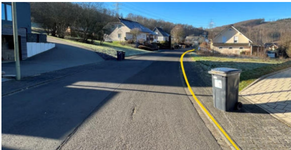
Abbildung 62: Notabflussweg "Am Arsberg" mit Bordanlagen (gelb)
