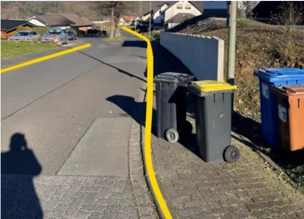
Abbildung 60: Notabflussweg "Am Arsberg" mit Bordanlagen (gelb)
