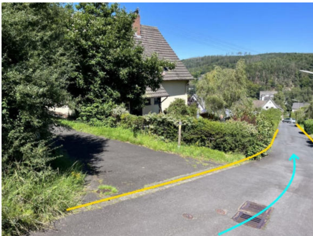
Abbildung 188: Notabflussweg "Hubertusweg" mit Fließrichtung (hellblau) und Bordanlagen (gelb)
