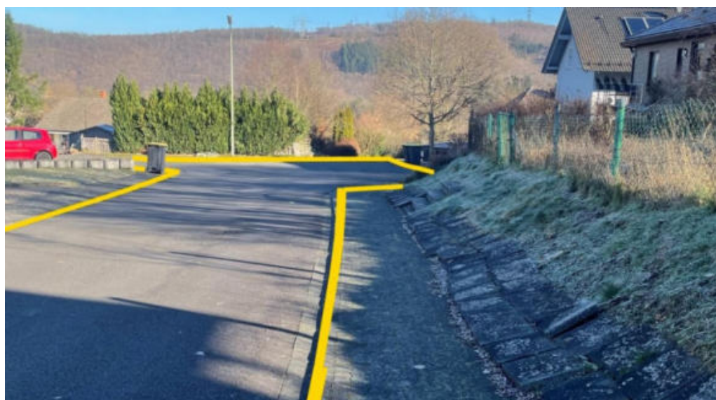
Abbildung 106: Notabflussweg "Am Krahstück" mit Bordanlagen (gelb)
