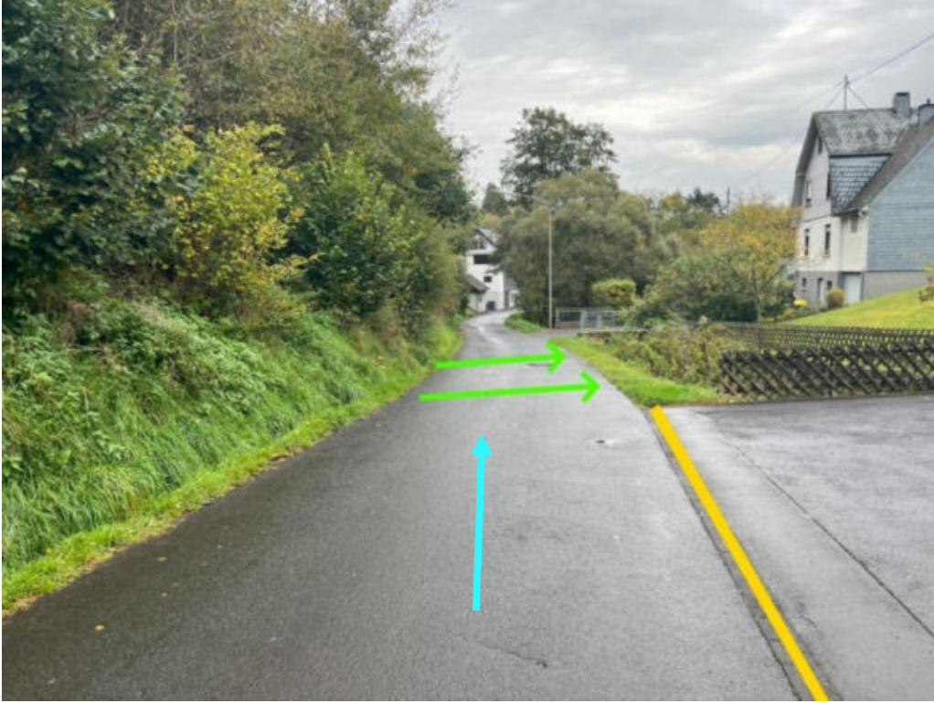
Abbildung 171: Notabflussweg "Lindenstraße" mit Fließrichtung (hellblau), Bordanlagen (gelb) und Neigungswechsel (grün)
