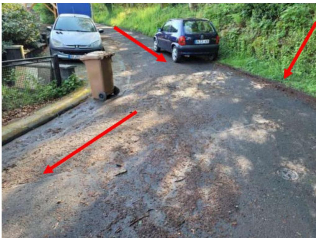
Abbildung 54: Oberflächenabfluss durch Hangwasser über die Waldstraße in den Tannenweg → Gefahrenpunkt 14.25
