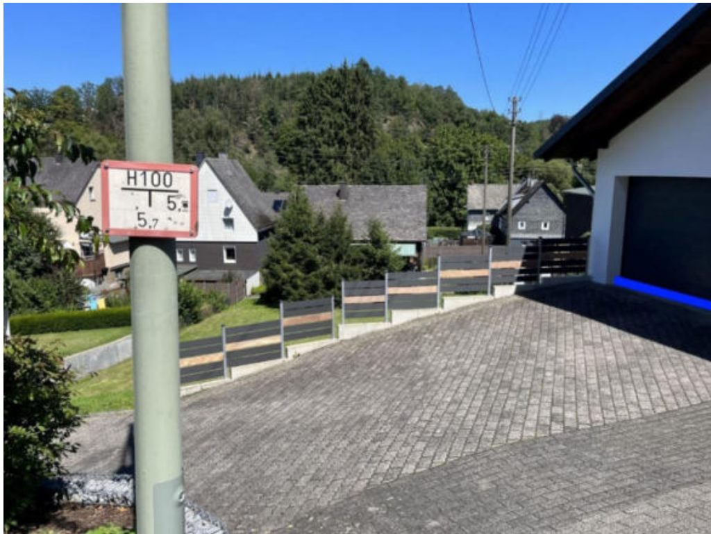
Abbildung 214: Notabflussweg "Birkenweg" mit Objektschutzmaßnahmen (blau)
