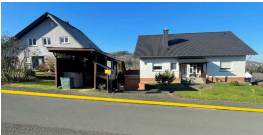
Abbildung 61: Notabflussweg "Am Arsberg" mit Bordanlagen (gelb)
