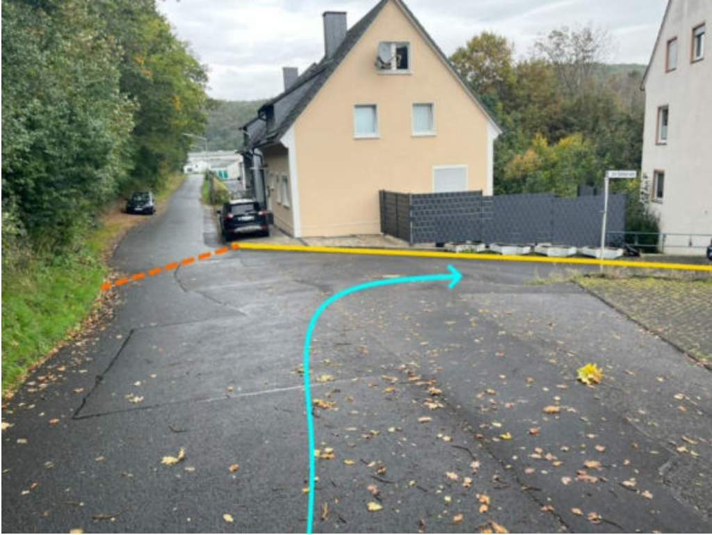
Abbildung 143: Notabflussweg "Im Sommer" mit Fließrichtung (hellblau), Bordanlagen (gelb), Aufwallung (orange) und Kreuzung mit „Im Dahlerain“
