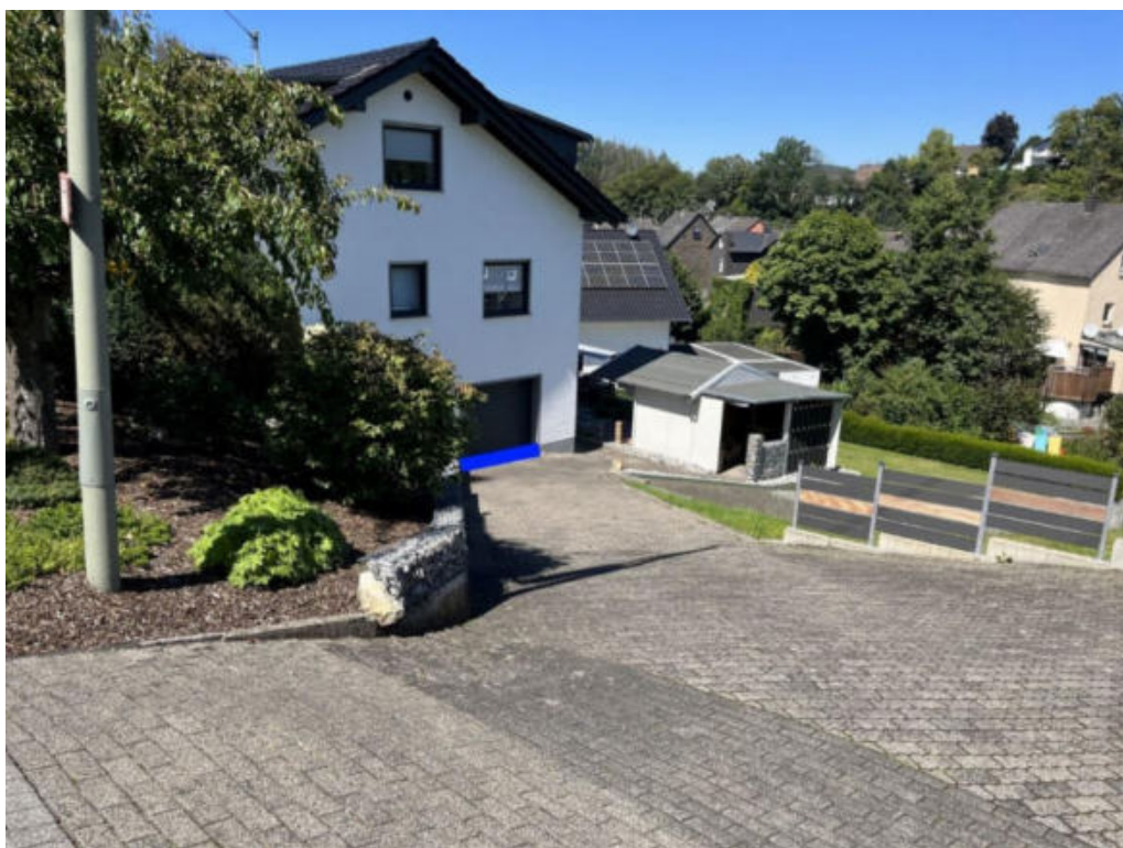
Abbildung 213: Notabflussweg "Birkenweg" mit Objektschutzmaßnahmen (blau)
