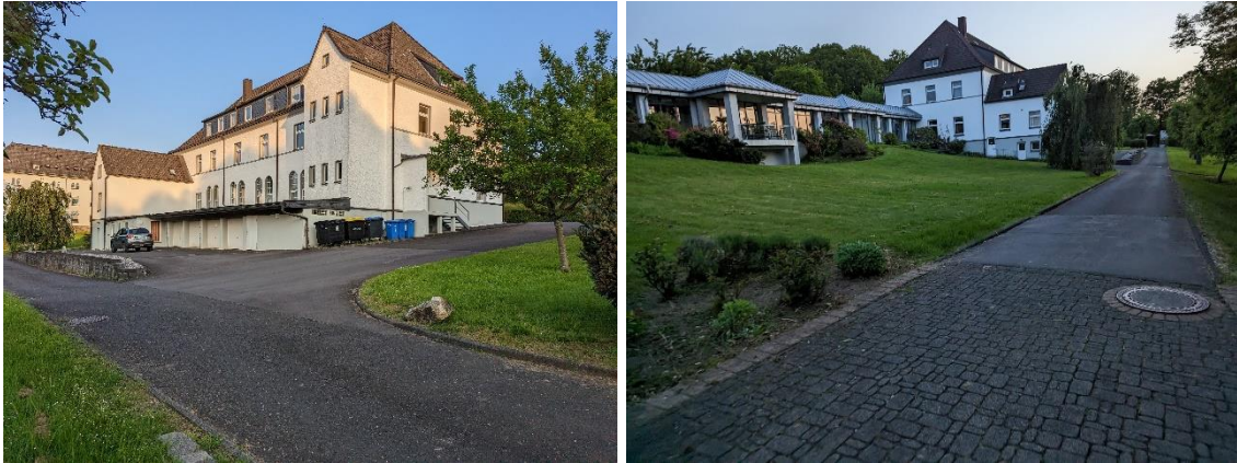
Abbildung 6: Blick auf die alten Klostergebäude im Planraum. Diese sind von Zuwegungen, Rasenflächen und Garten umgeben.
