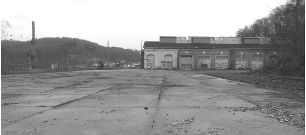
Blick aus westlicher Richtung auf das ehemalige ‚EAW‘ im mittleren Abschnitt
